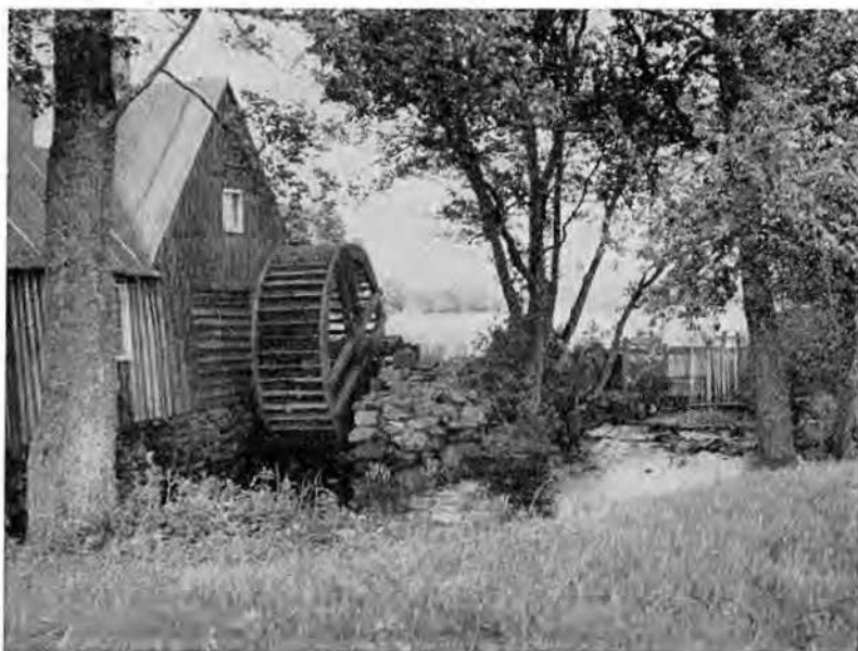
Bild 10. Lärka-Sjöhults kvarn i Örkelljunga sn. I bakgrunden synes dammen och till höger utsläppsrrännan. Kvarnhjulet är av nyare konstruktion, jfr bild 2. Efter Ek, Väderkvarnar och vattenmöllor.
