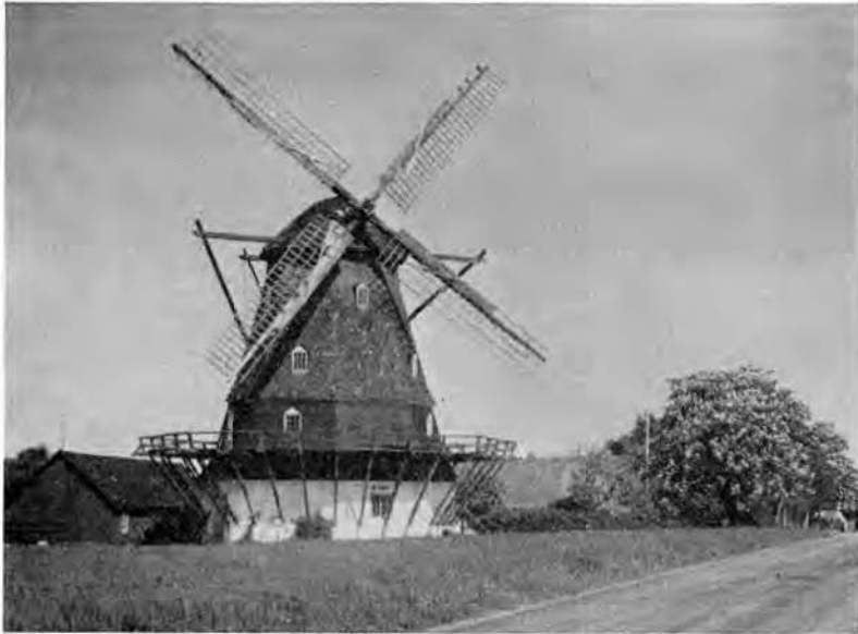
Bild 5. Kulla Gunnarstorps hättkvarn i Allerum sn. Byggt 1809 av Georg Soffel. Märk hättans form, i senare tid en ovanlig konstruktion i Skåne.
