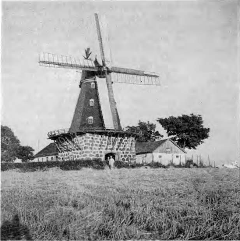
Bild 8. Övraby hättkvarn. Byggt 1887. Kvarnen är försedd med patentsegel. På hättans baksida skymtar vindrosen eller självdrejaren. Efter Ek, Väderkvarnar och vattenmöller.
