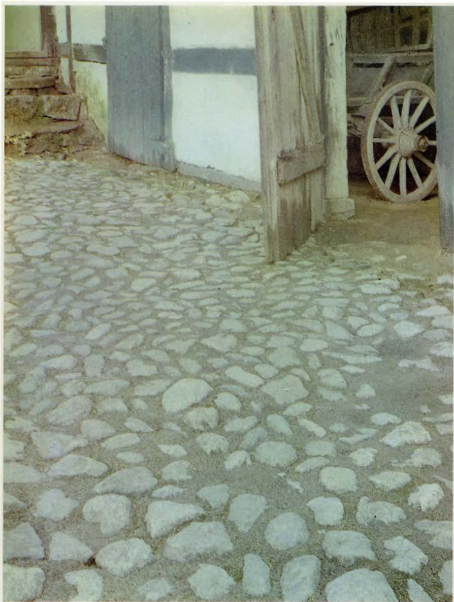
Gårdens beläggning av kullersten. I bakgrunden vagnboden.
