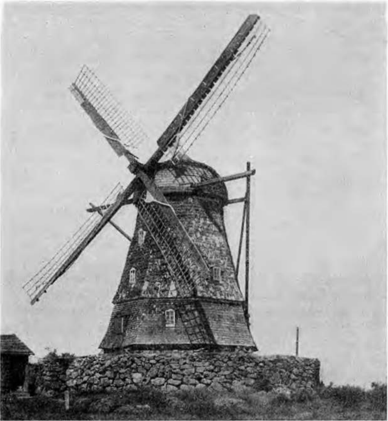
Bild 6. Tranekärns hättkvarn i Jonstorp sn, Skåne. Byggd 1841. De nordvästskånska hättkvarnarna hade som regel detta utseende, med gesims, spänklädsel, krökverk (ifrågavarande vidningssystem) och rundad lökkupol. Efter Ek, Väderkvarnar och vattenmöllor.
