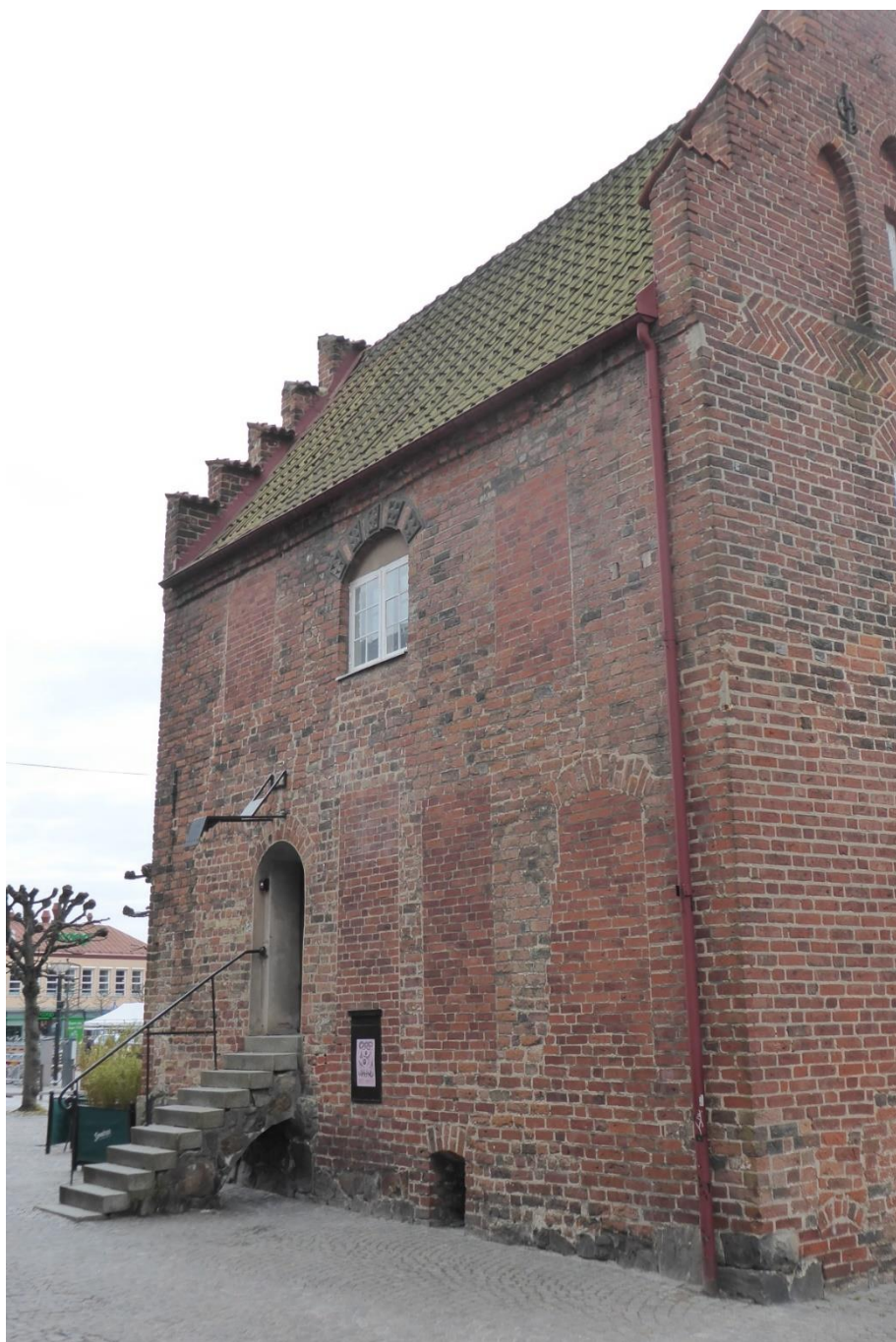
Före åtgärden. Norra fasaden med aktuell trappa och räcke.
