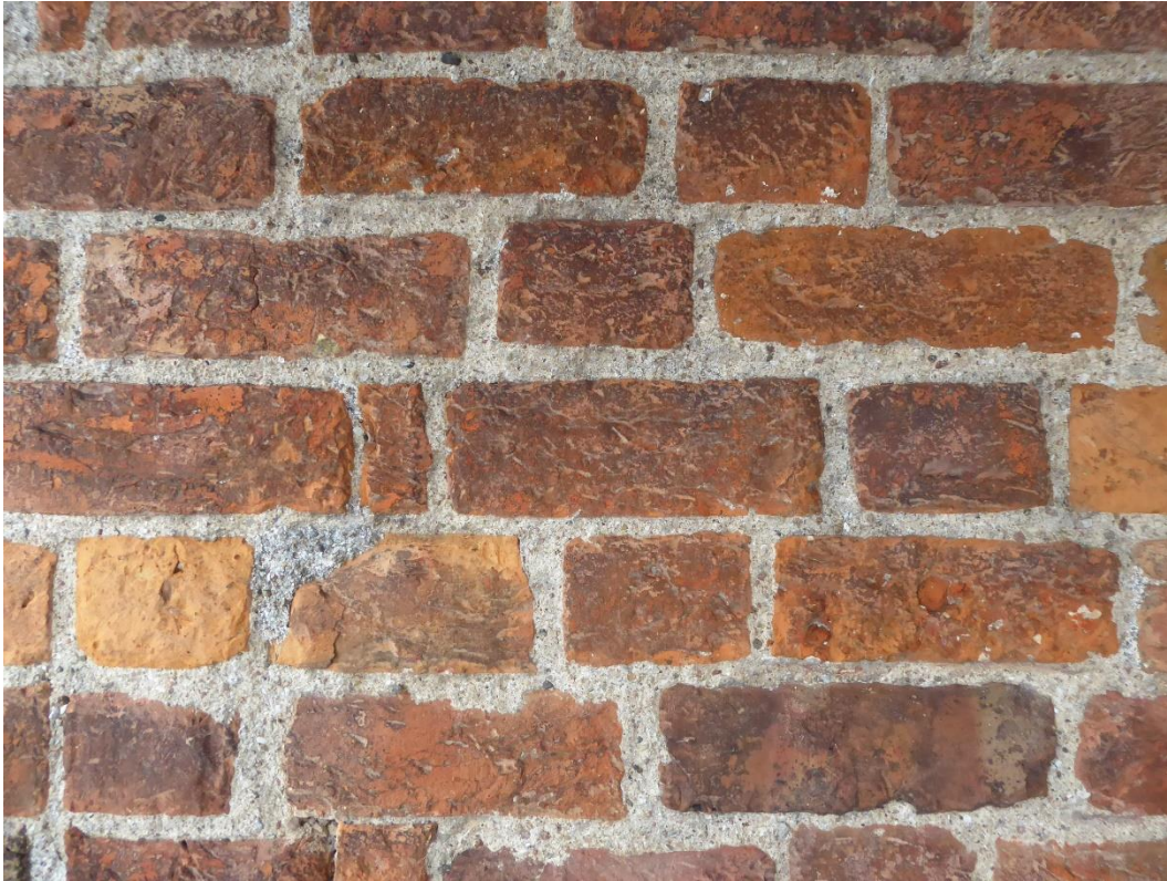
Östra gavelfasaden, exempel på fog och tegel i gott skick som inte åtgärdats.
