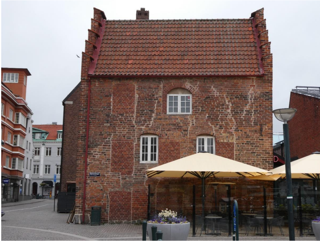
Efter åtgärder. Södra fasaden. I övre högra hörnet kan man ana en tegelsten som är ersatt
