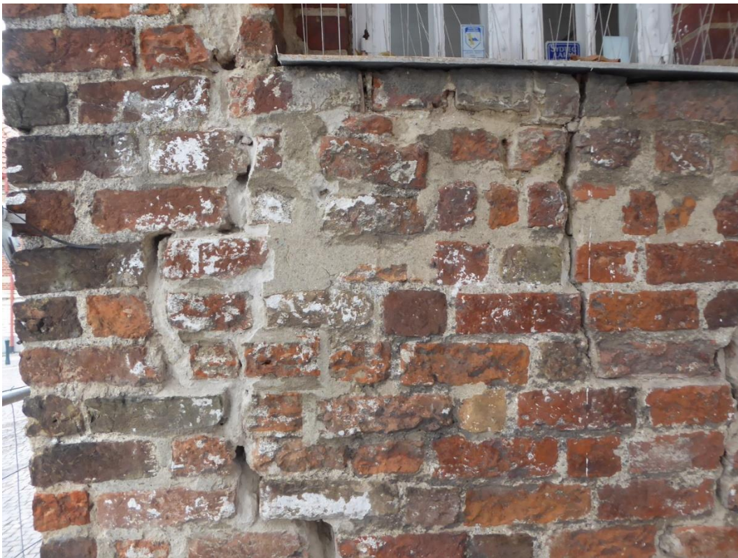
Östra gavelfasaden, exempel på fog och tegel i gott skick som inte åtgärdats.
