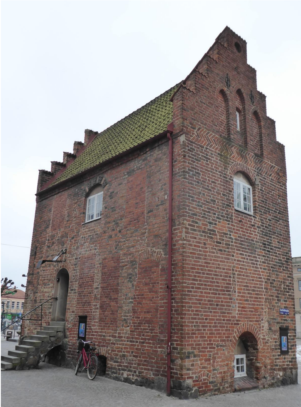
Före åtgärder. Norra fasaden och västra gaveln.
