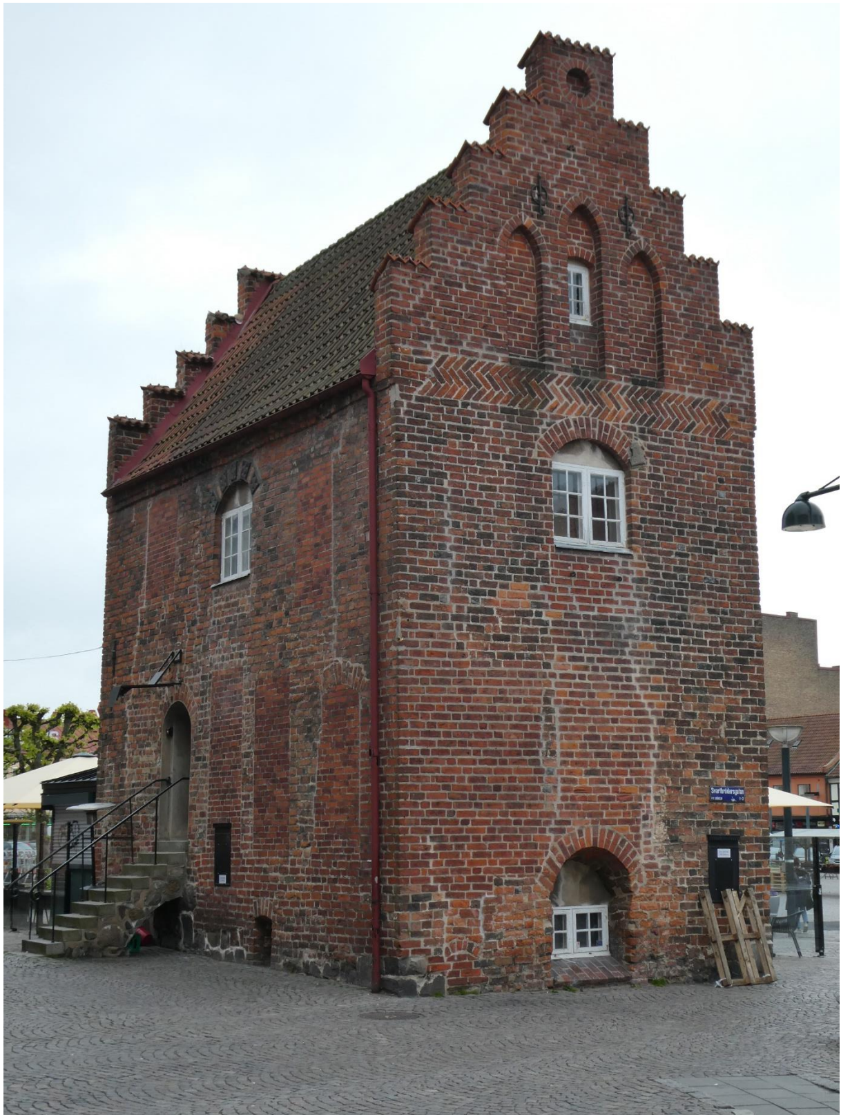
Efter åtgärder. Norra och västra fasaderna.
