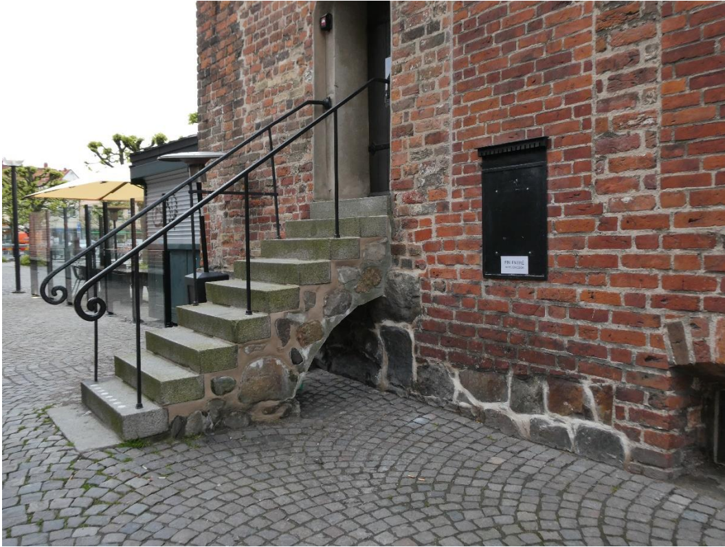
Trappan och sockel efter åtgärder.
