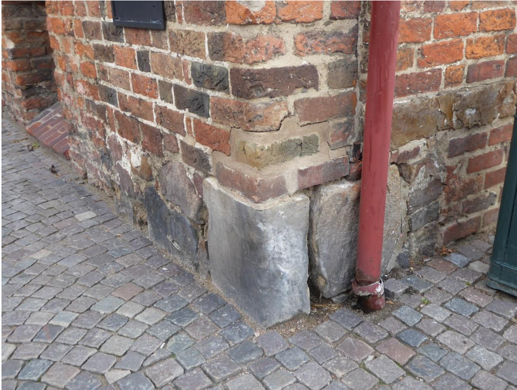
Före åtgärder, sydvästra hörnet.
