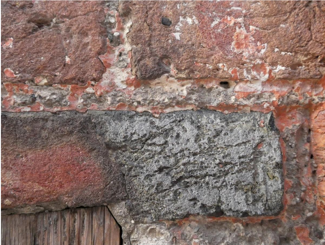
Norra fasaden, rödfärgad fog och vit kalkfärg.
