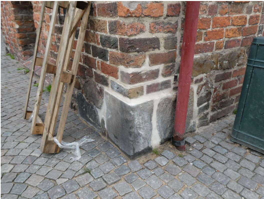
Efter åtgärder. Sydvästra hörnet.
