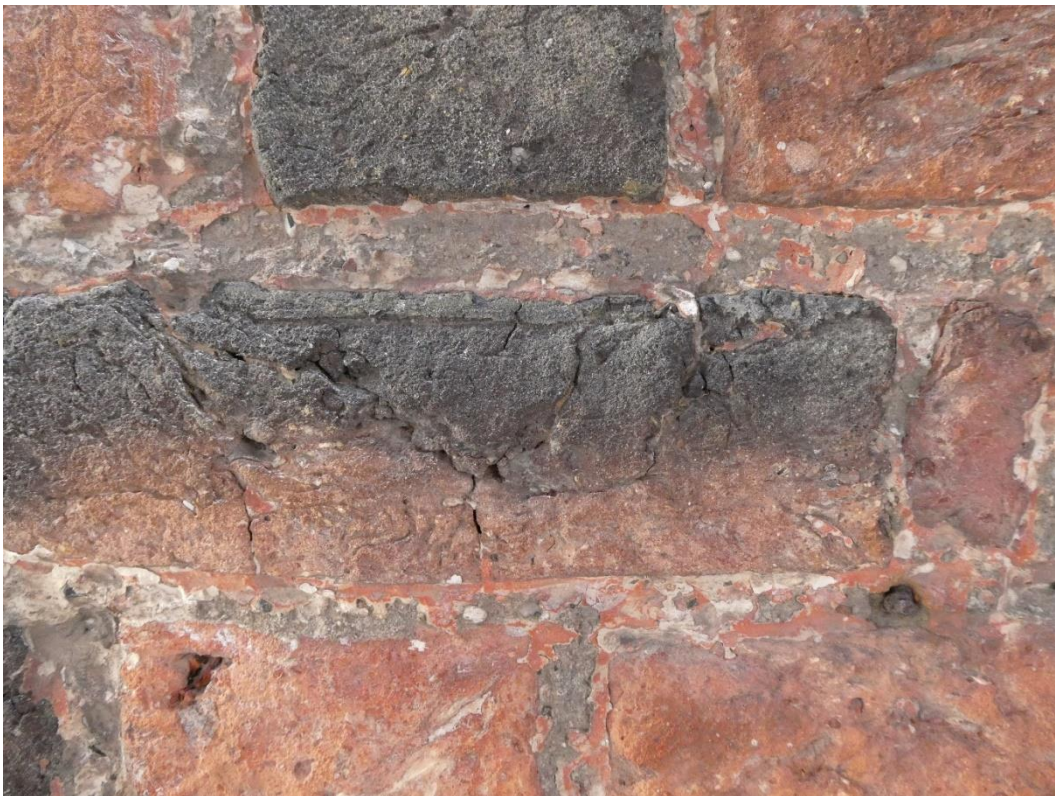
Norra fasaden, vid västra hörnet, rödfärgad fog.
