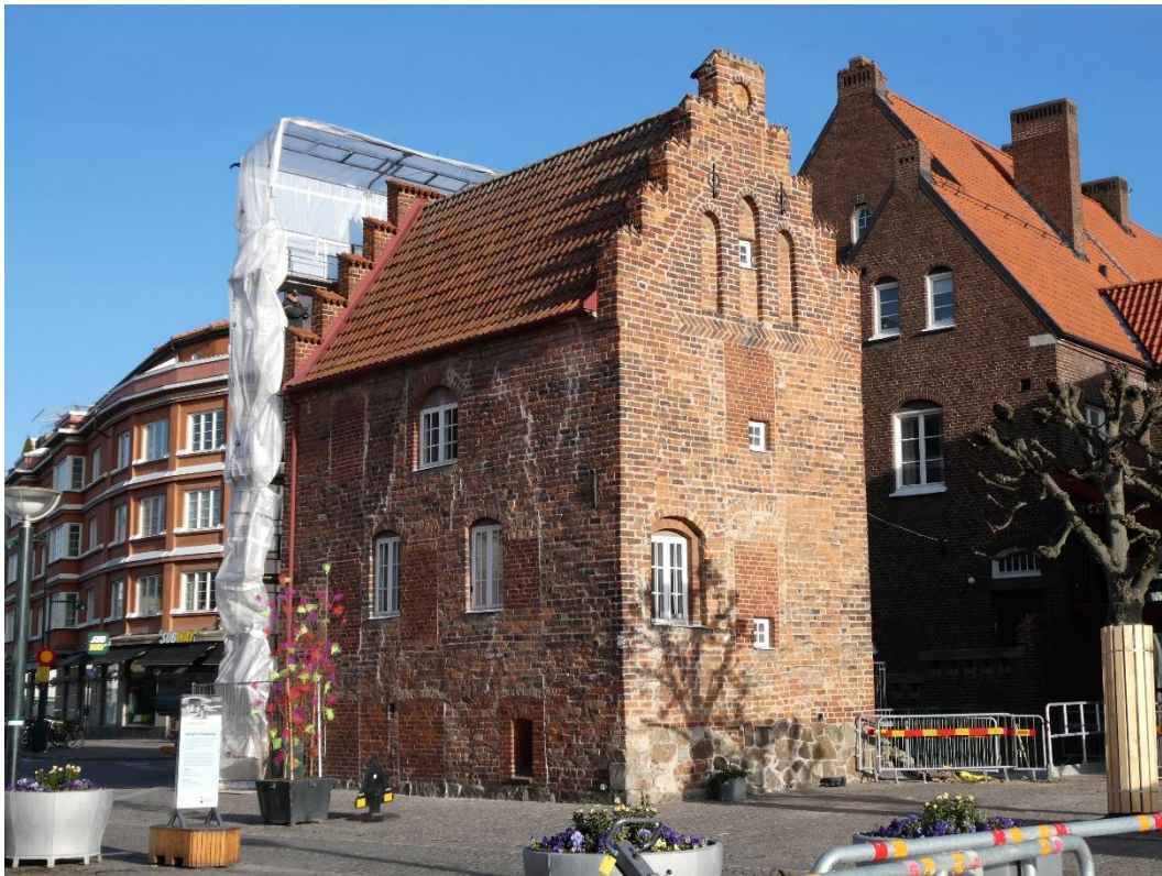
Efter åtgärder. Södra och östra fasaderna.
