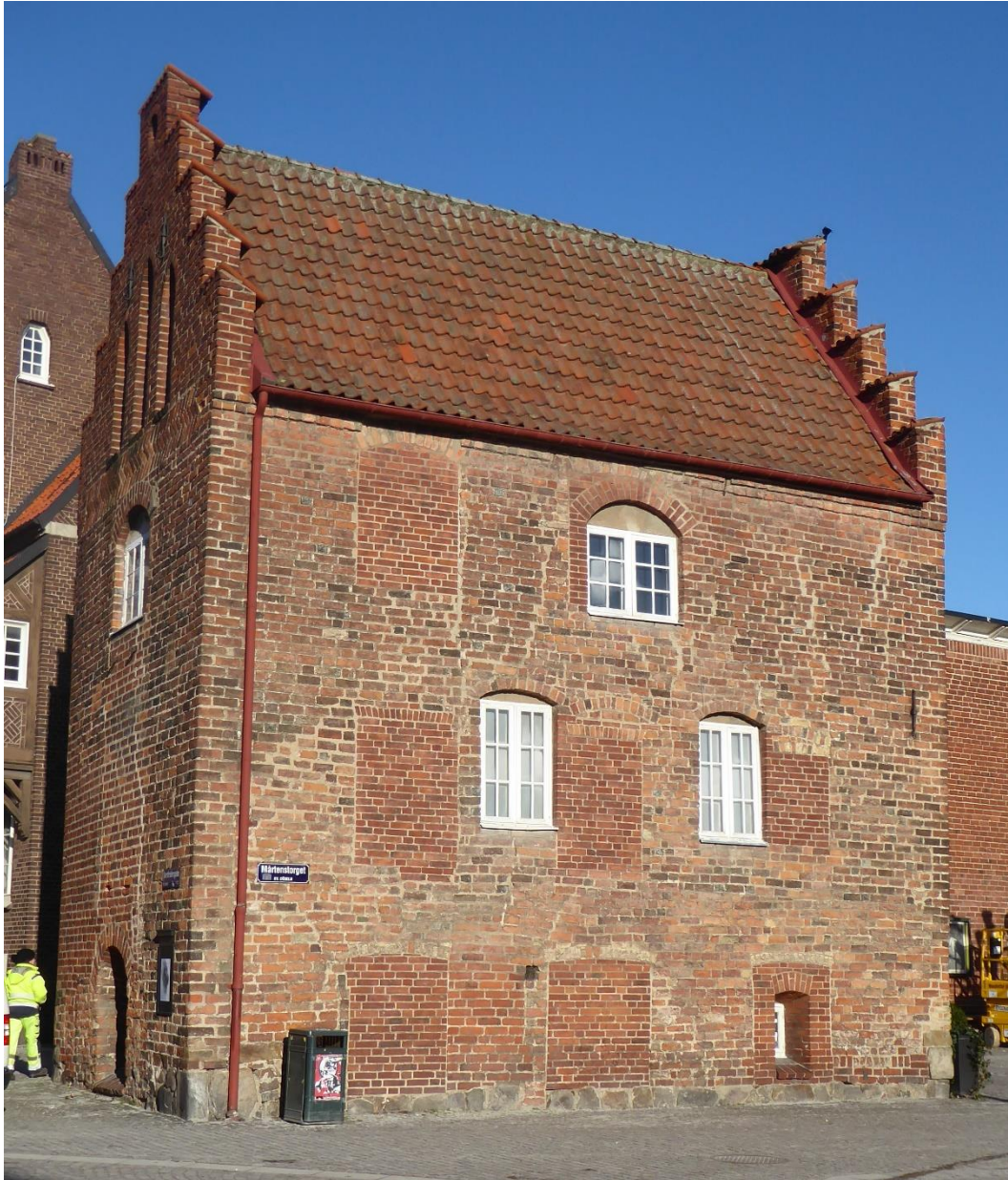
Före åtgärder. Västra gaveln och södra fasaden.
