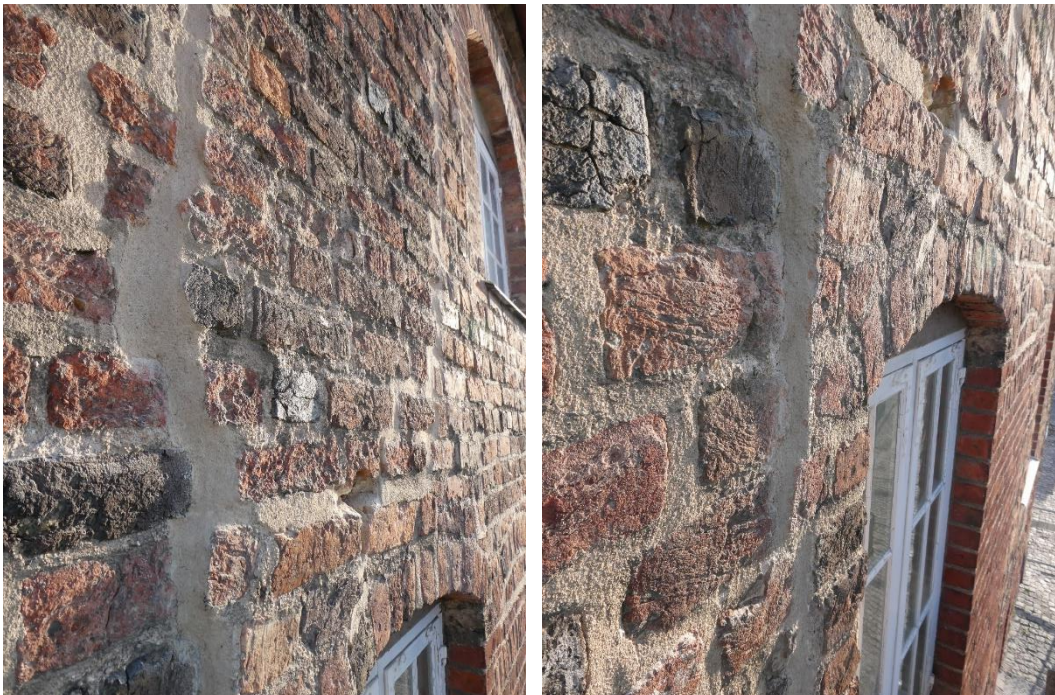
Efter åtgärder. Vägparti som kalvar ut i södra fasaden, fogen är lagad.
