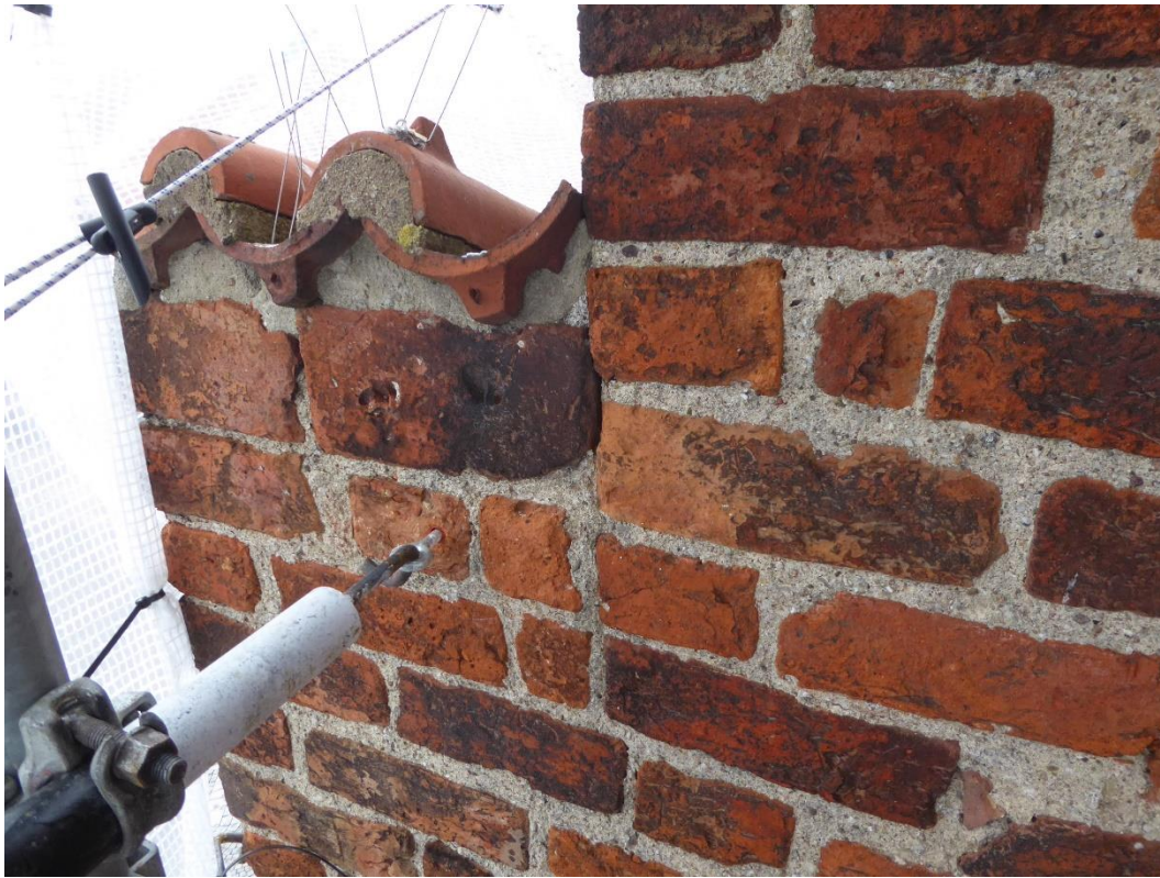
Ställningar fästa i tegelsten.
