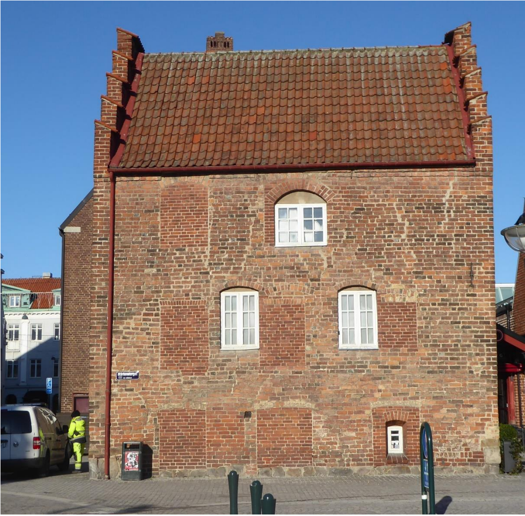
Före åtgärder. Södra fasaden.
