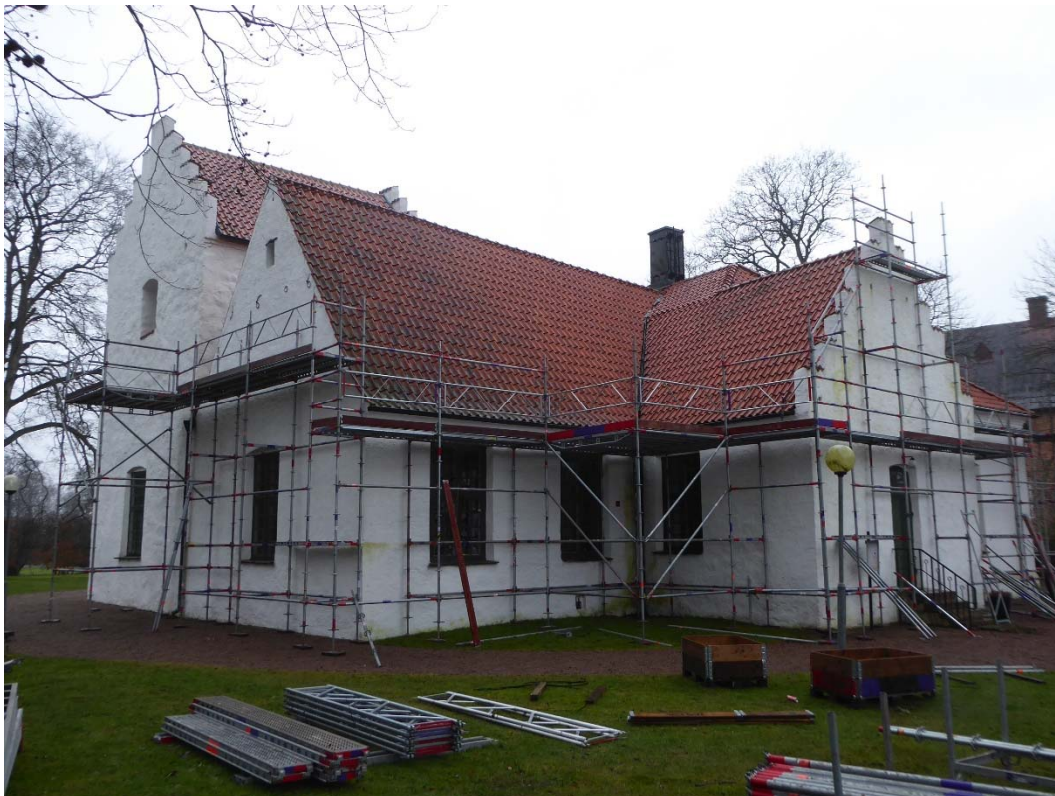
Figur 4-5. Före åtgärder. Kyrkan sedd från söder och öster.
