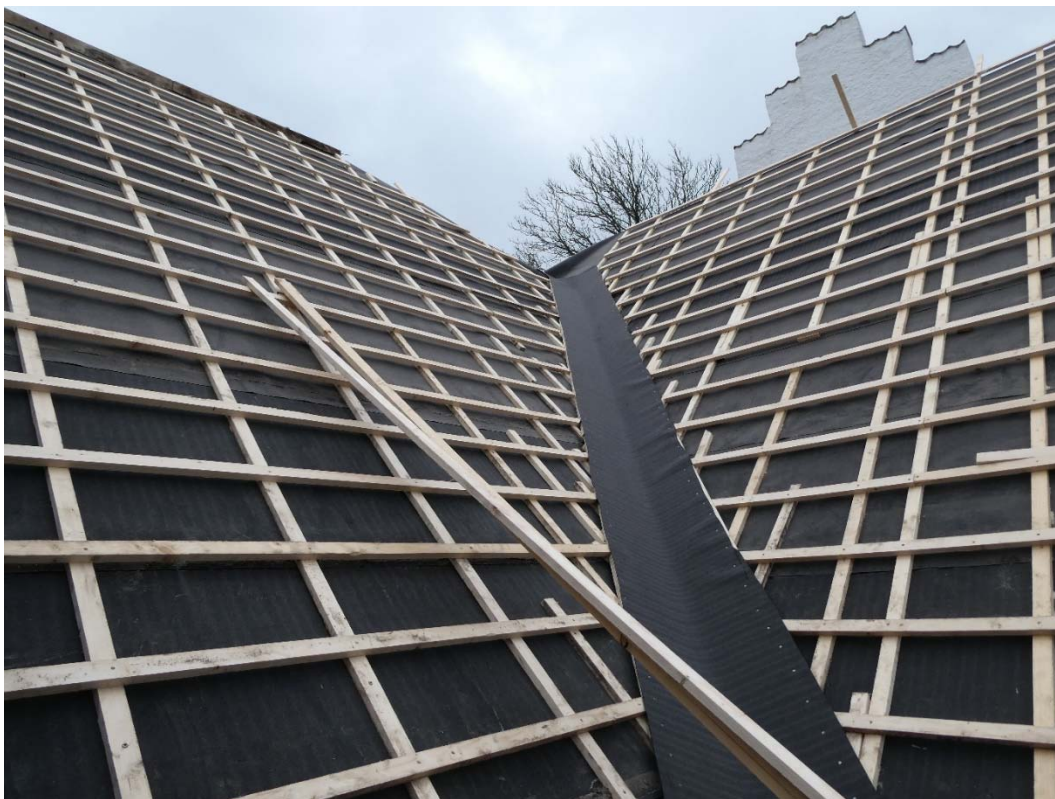
Figur 18. Under arbete. Exempel ny papp och läkt.
