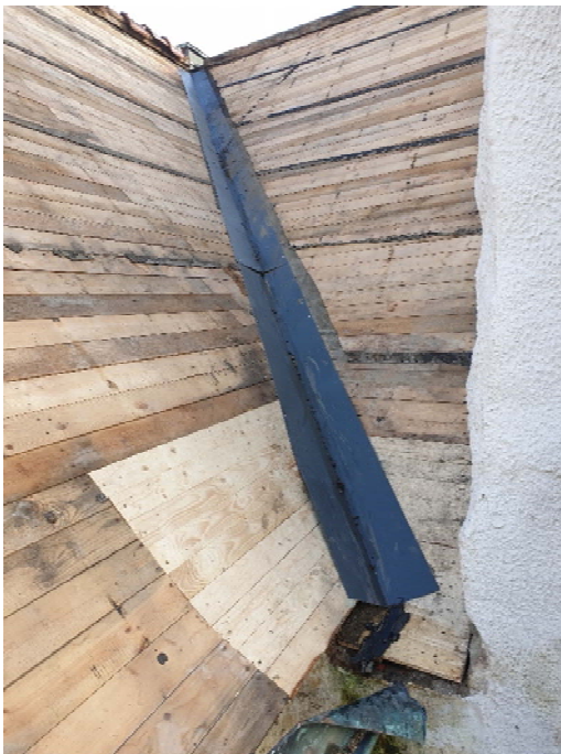
Figur 14-15. Under arbete. Exempel på lagning av brädbotten, ny papp och läkt .
