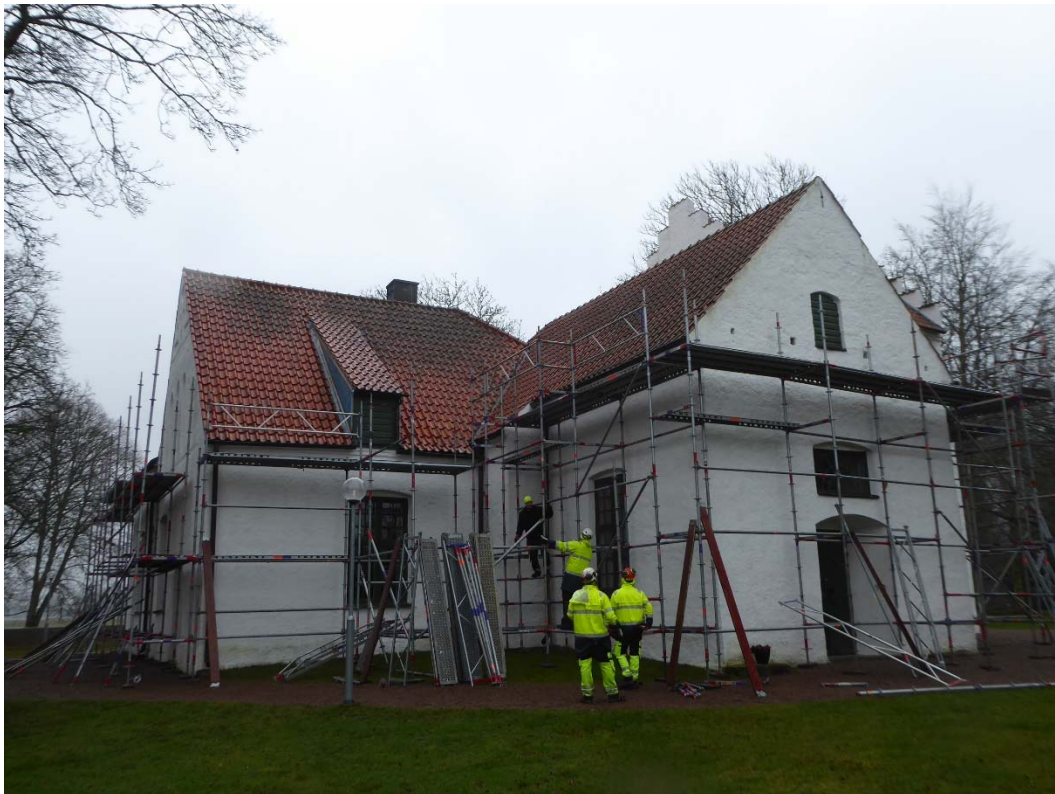
Figur 2-3. Före åtgärder. Kyrkan sedd från nordost och sydväst.
