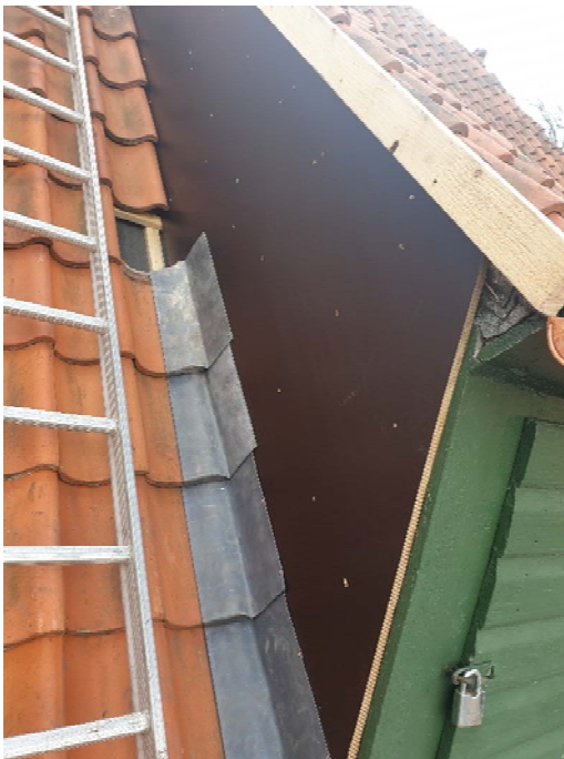
Figur 21-22. Under arbete med takkupan, blyplåt i vinkel, plywoodskiva och ny vit plåt.
