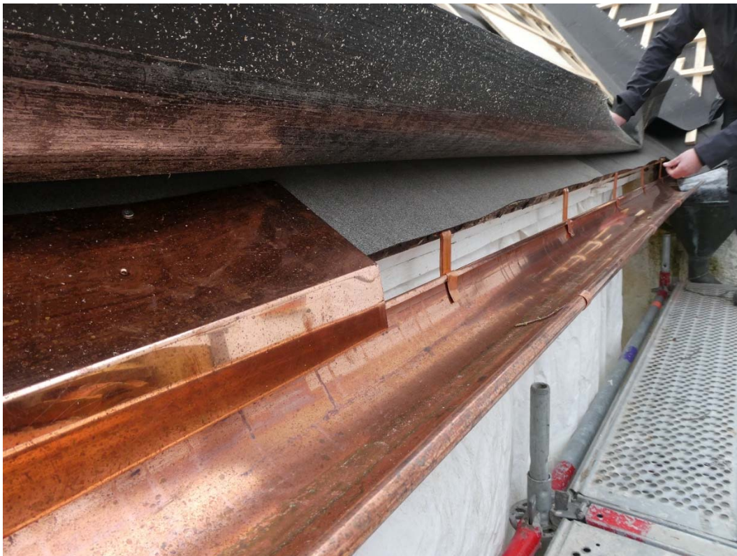
Figur 11. Under arbete med fotplåt, papp och nya hängrännor.
