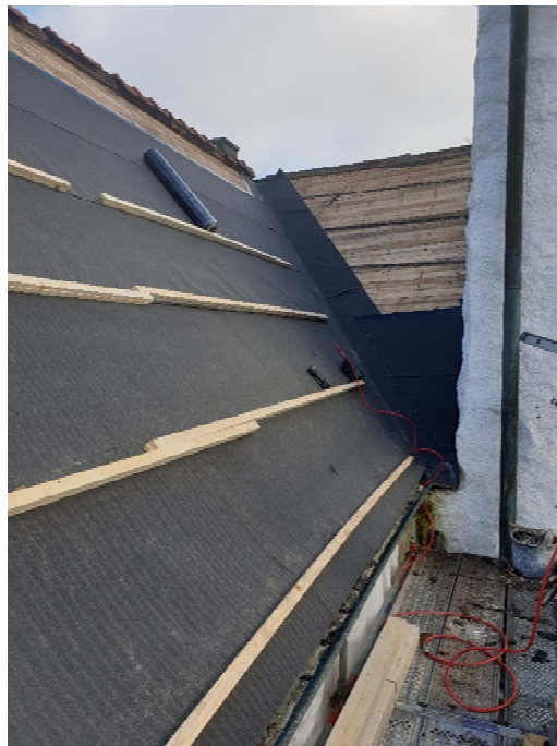
Figur 14-15. Under arbete. Exempel på lagning av brädbotten, ny papp och läkt .
