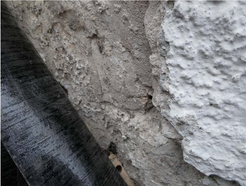
Figur 29. När takpannorna tagits ner på nordvästra tillbyggnadens västra takfall syns en liten del av vapenhusets norra mur. På muren verkar finnas ett underliggande äldre skikt med vitkalkad spritputs, vilket syns längst till vänster i bild mot takpappen.
