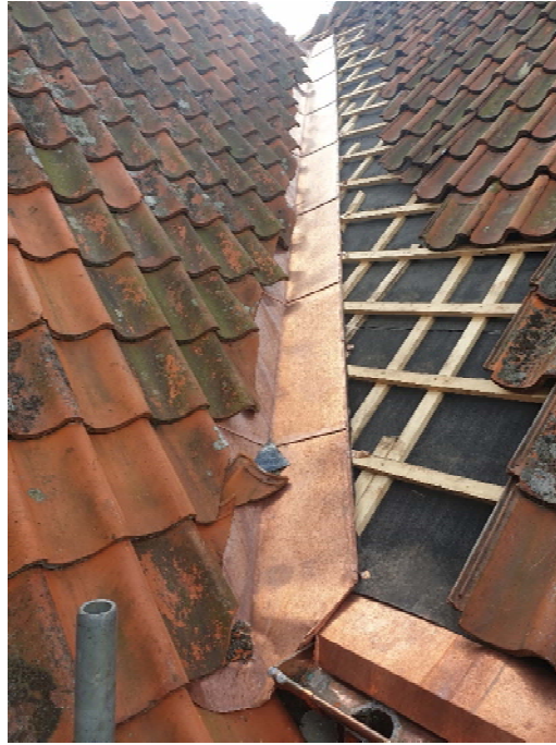
Figur 19-20. Under arbete. Takpannorna återläggs, ny kopparplåt i ränn dal mot sydväst.
