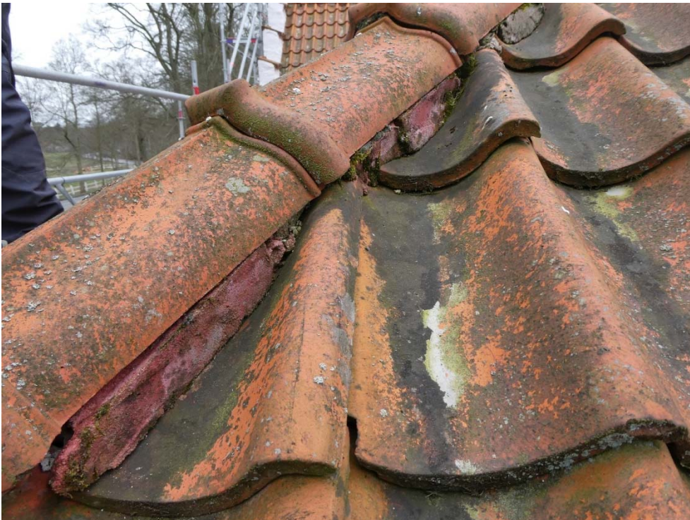
Figur 29. När takpannorna tagits ner på nordvästra tillbyggnadens västra takfall syns en liten del av vapenhusets norra mur. På muren verkar finnas ett underliggande äldre skikt med vitkalkad spritputs, vilket syns längst till vänster i bild mot takpappen.
