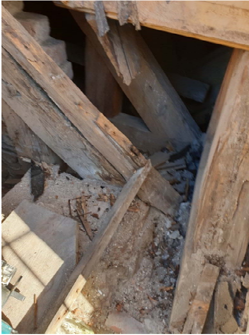
Figur 12-13. Under arbete. Rötskadad brädbotten i takvinkel ersätts.
