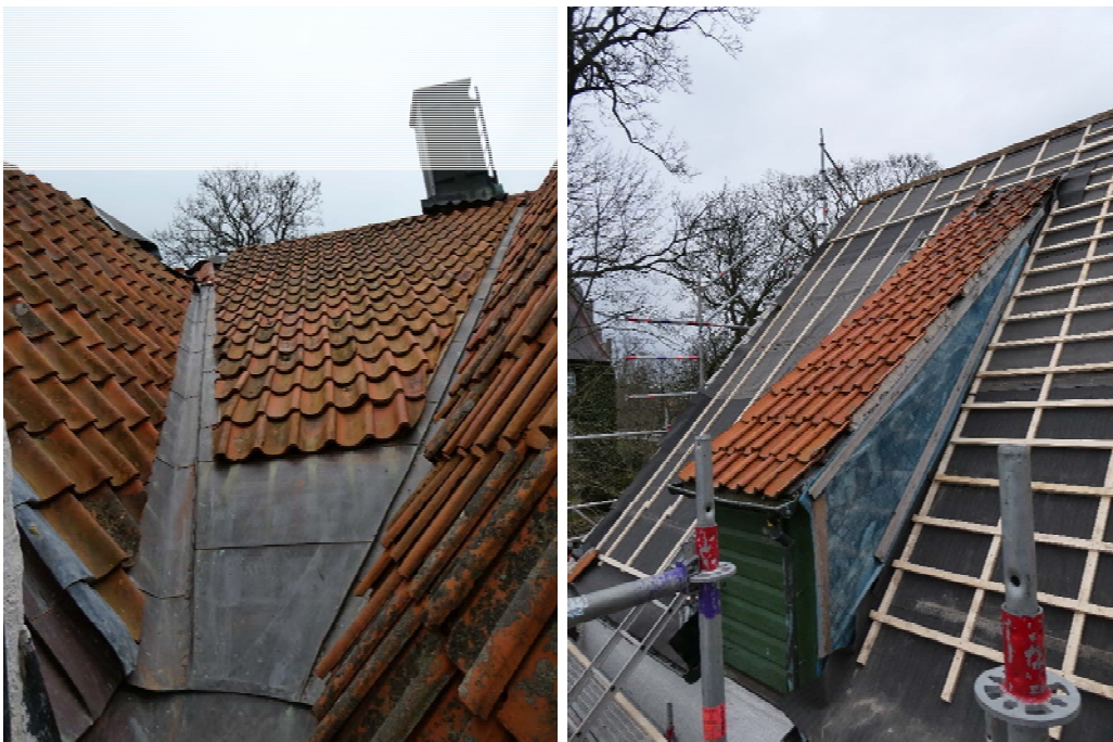
Figur 8-9. Plåt bevarades, taktäckningen har lagts om. Komlicerade takfall mot söder där pannor har skurits för att sitta tätt. Höger: Takkupan före åtgärder.
