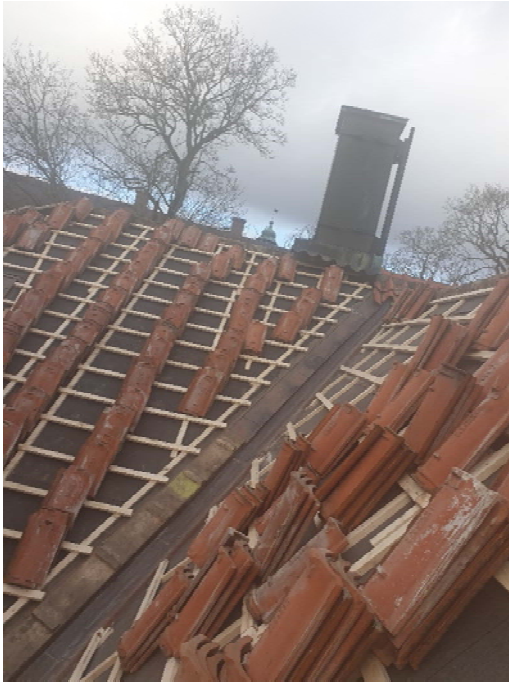
Figur 19-20. Under arbete. Takpannorna återläggs, ny kopparplåt i ränn dal mot sydväst.
