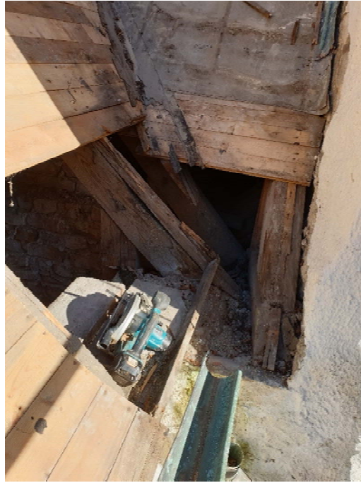
Figur 12-13. Under arbete. Rötskadad brädbotten i takvinkel ersätts.
