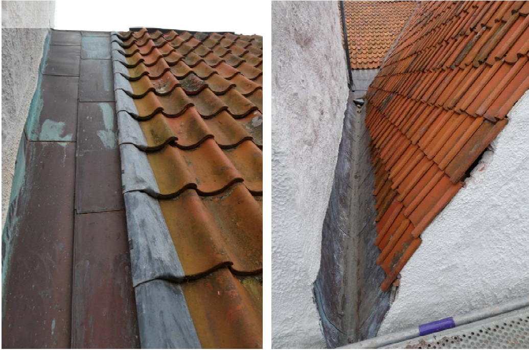
Figur 6-7. Före åtgärder. Ränndal och blyplåt mot klocktornets norra fasad. Ränndal mellan klocktorn och södra tillbyggnaden bevarades.
