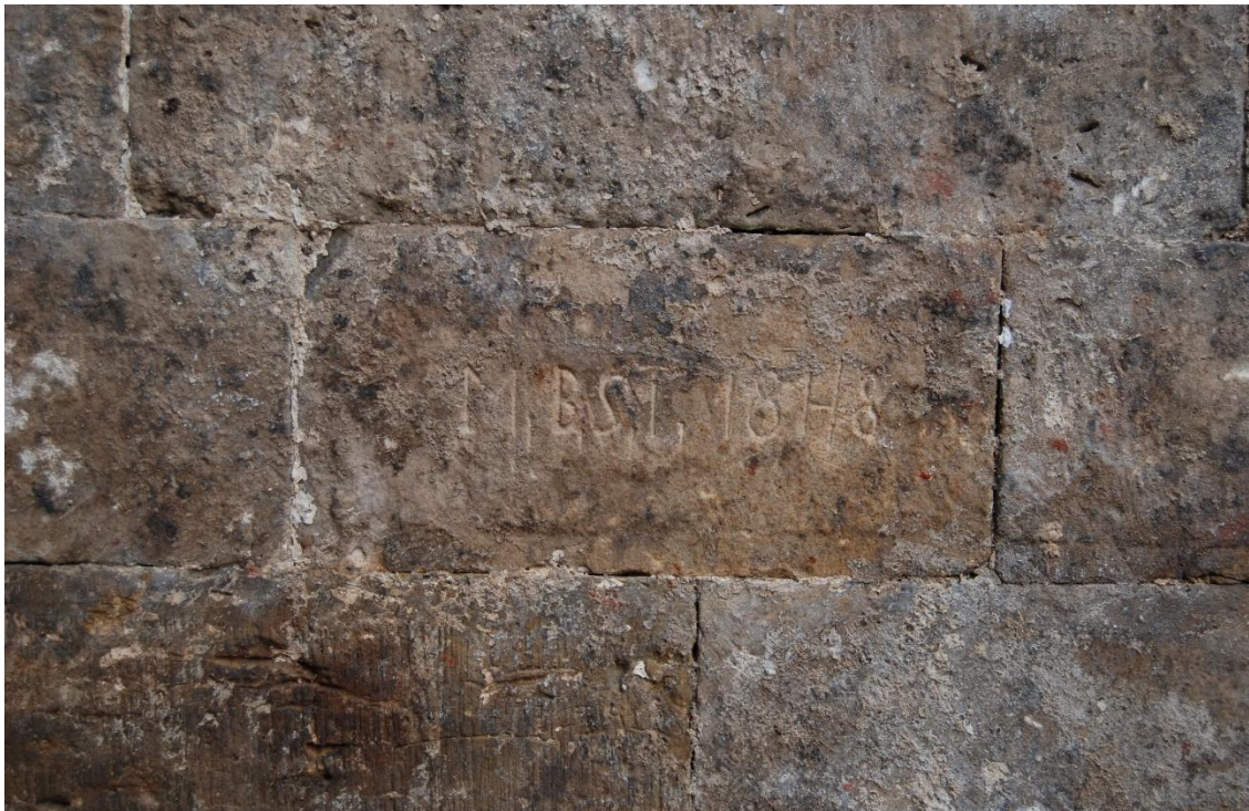
Figur 12. I den södra fasaden finns en kvadersten som bär en inristning, vilken kan tydas som "M, B, S, T, 1848". Tolkningen är att detta är året för den senaste ombyggnationen av trappan, samt möjligtvis arbetarnas initialer. Foto från söder.
