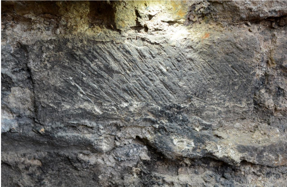
Figur 11. Detaljbild med släpljus visande sandsten i grundmuren under den södra fasaden. Endast en sten i grunden visade tydliga spår av ytbehandling. Foto från söder.
