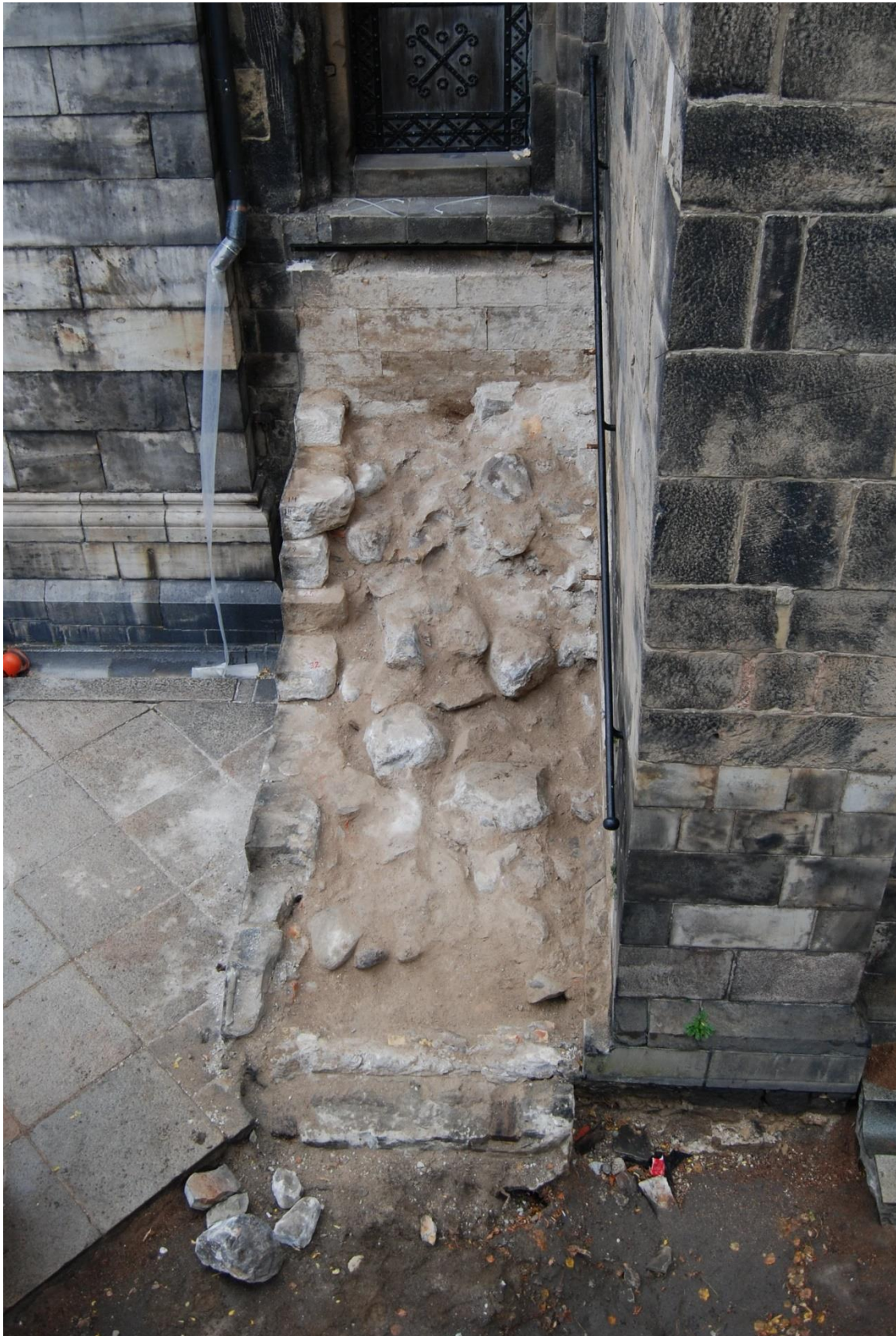
Figur 5. Djupare konstruktionen övergick materialet till att huvudsakligen bestå av större fältstenar, med en diameter på upp till en meter. På bilden ses också den östra kvaderstensfasaden som börjar framträda direkt under portalen. Foto från öster.
