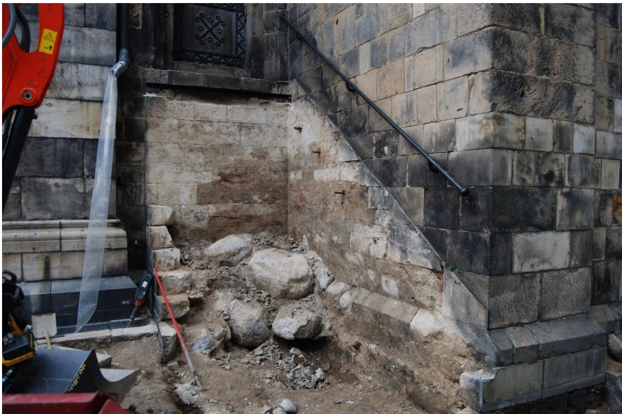
Figur 6. Platsen för trappan, sedd från sydöst. Under korportalen framträder de äldre fasadmurarna tydligt.
