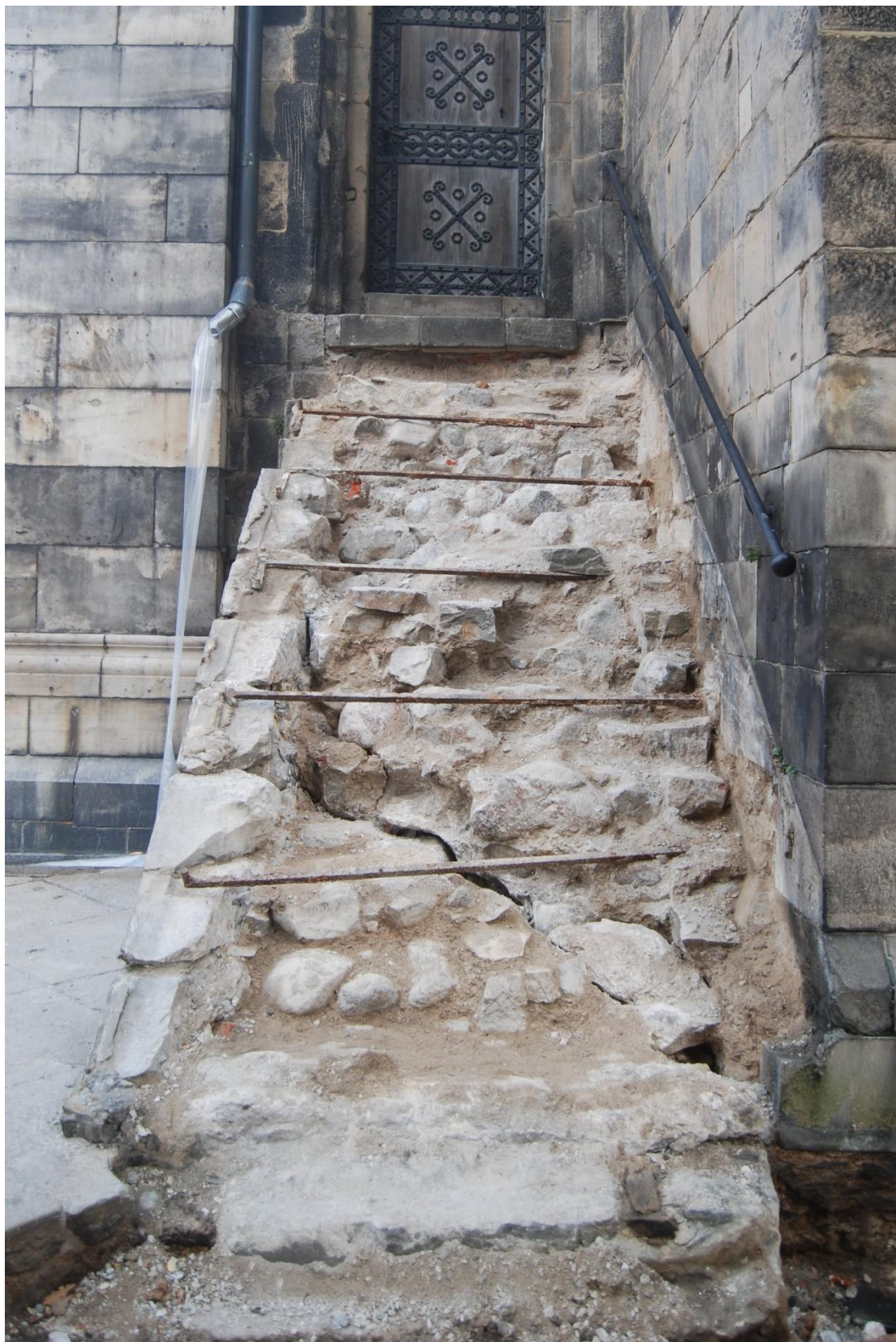
Figur 4. Trappkonstruktionen efter att vangstycke och plansteg tagits bort. Konstruktionen bestod i denna nivå av stora mängder löst material i form av grus och uppblandat murbruk. Därunder var lagt spräckt eller obearbetad sten, i vilken kunde ses en antydning till avjämnade nivåer. Högt upp i konstruktionen kunde konstateras en större spricka som tolkas vara huvudorsaken till att stenarna i trappans fasad börjat röra på sig. Foto från öster.
