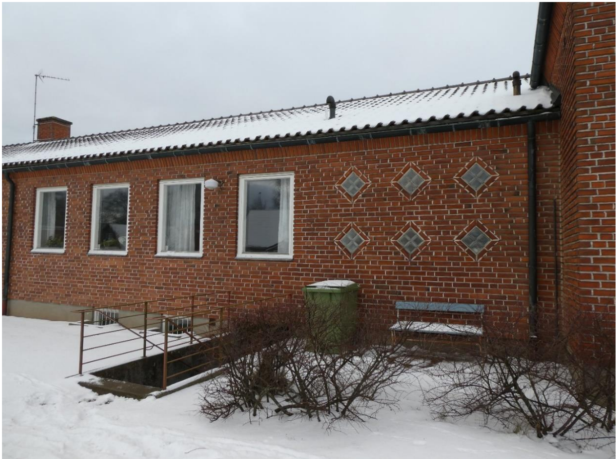
Byggnadsdel B östra fasaden, de kvadratiska gluggarna ger ljus åt toaletter.
