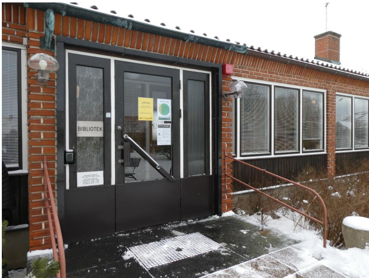
Huvudentré med senare färgsättning, sentida panelpartier under fönstren.
