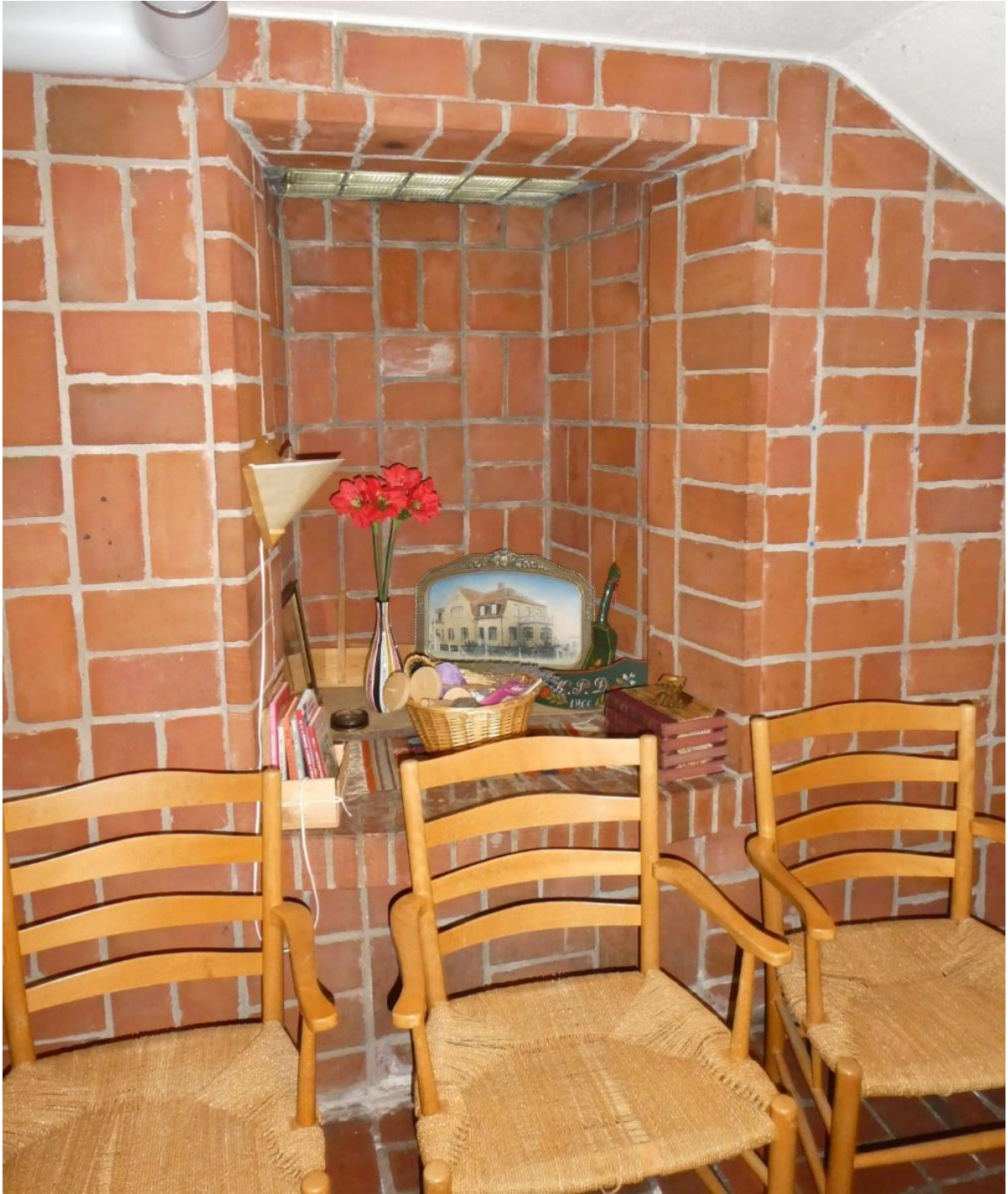
Detalj källarvåningen Ljusbrunn formad som öppen spis.
