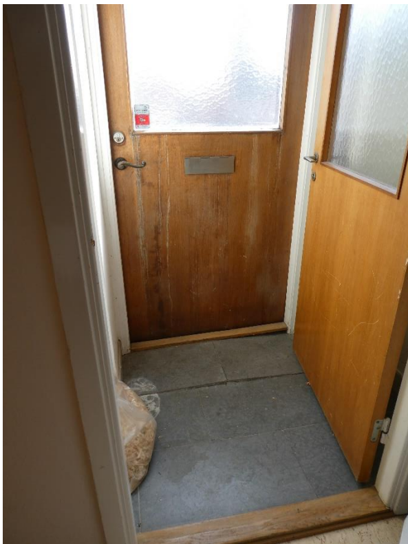
Vindfång, kalksten och ursprungliga dörrblad
