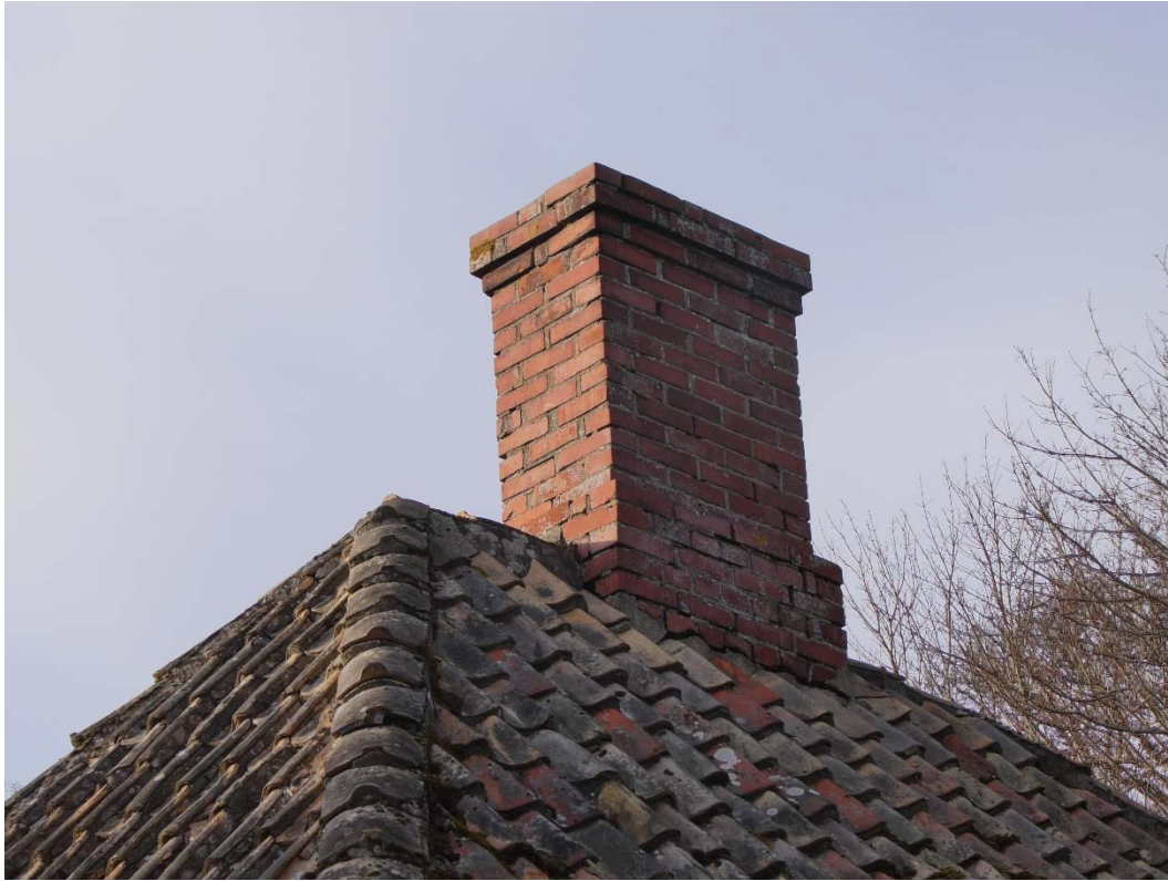
Före åtgärder, skorstenen sedd från öster från Stuterivägen.
