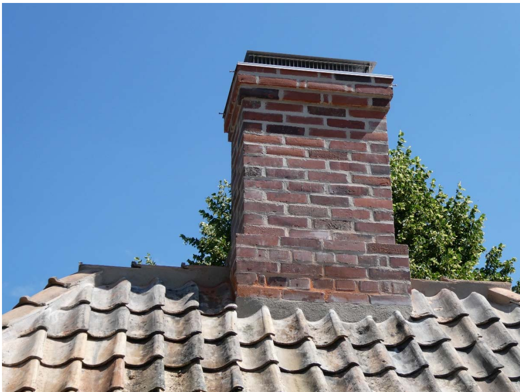
Skorstenen håller på att återuppmuras. Bräda är monterad i takfallens möte, pannorna skruvades i brädan.
