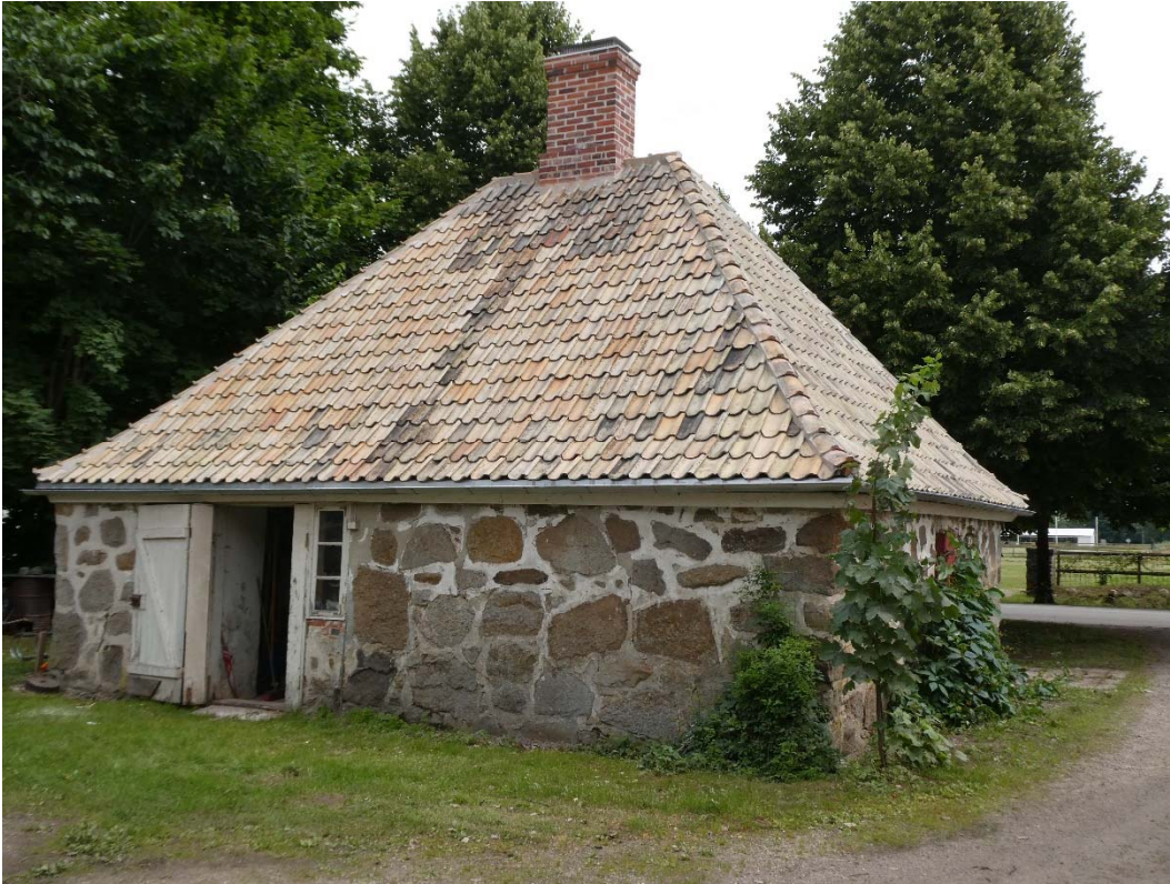
Efter åtgärder. Västra och södra sidan.
