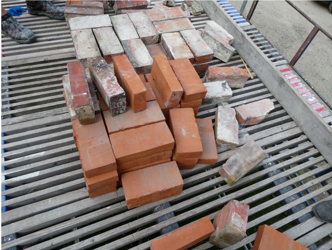
Skorstenens befintliga tegelstenar jämförs med kompletteringstegel.
