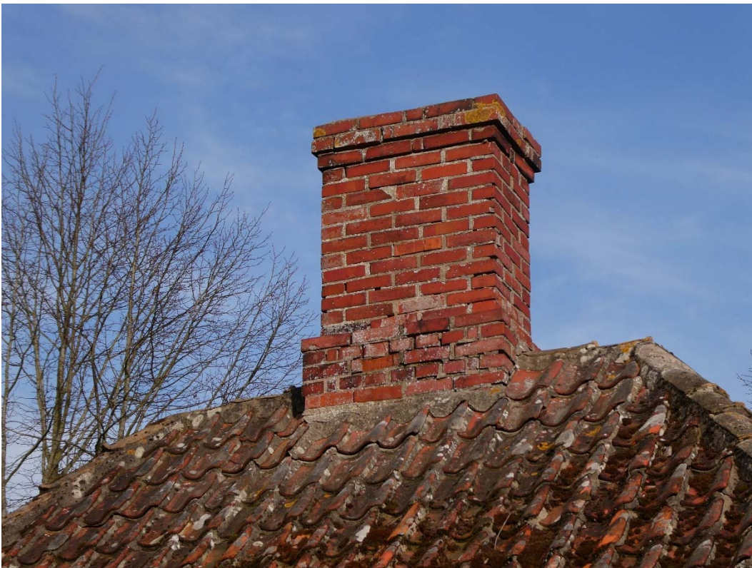
Före åtgärder, skorstenen sedd från väster från gårdsplan.
