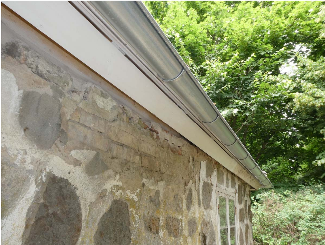
Efter åtgärder. Östra sidan med ersatt takfotsbräda.
