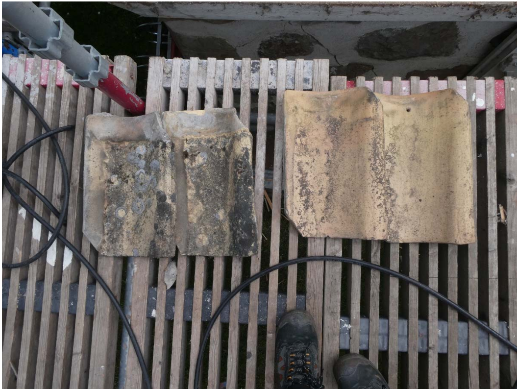
Befintliga gula tegelpannor till vänster i bild och kompletteringspannor till höger i bild.
