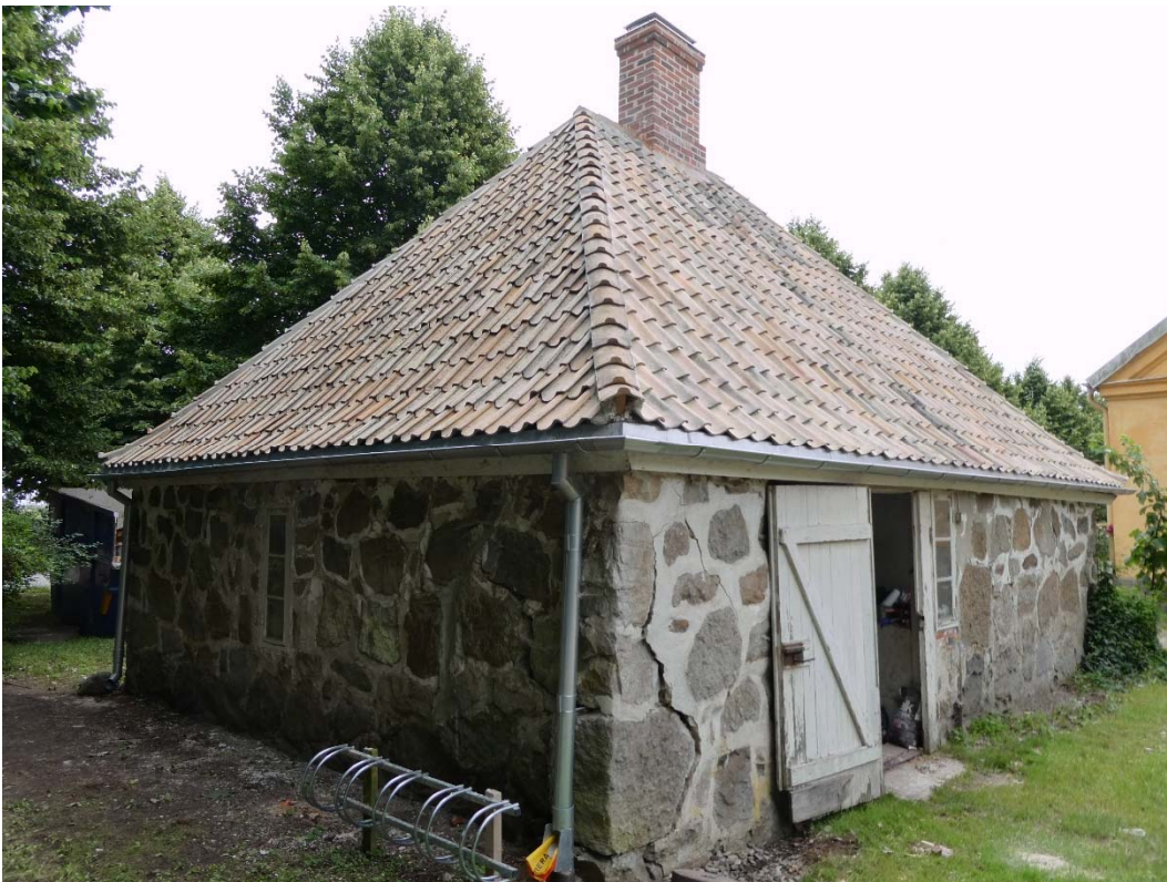
Efter åtgärder. Norra och västra sidan.
