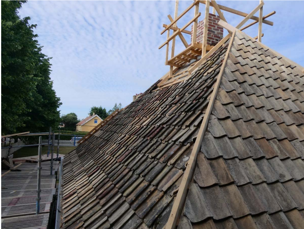
Skorstenen håller på att återuppmuras. Bräda är monterad i takfallens möte, pannorna skruvades i brädan.
