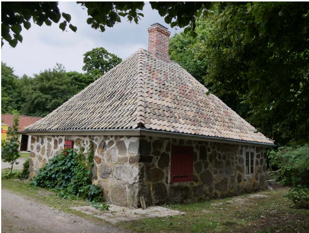
Efter åtgärder. Södra och östra sidan (återstår att mura igen alla nockavslutningar vid takfot).
