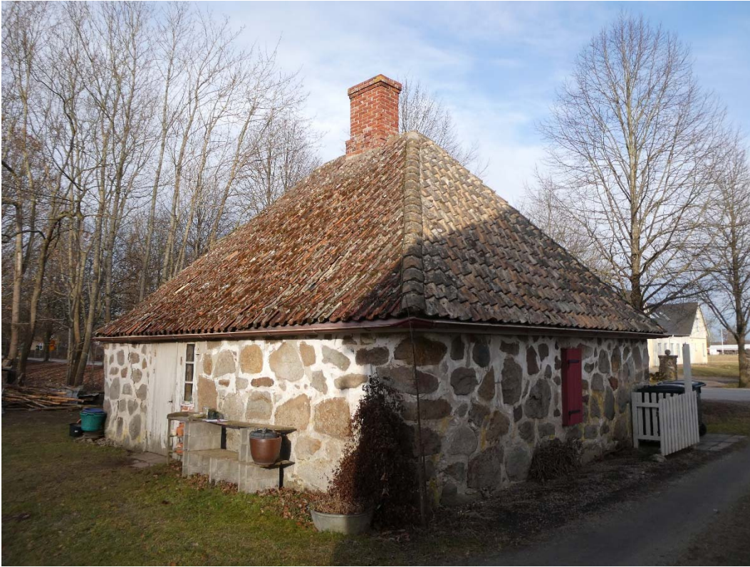
Före åtgärder. Västra och södra takfallen.
