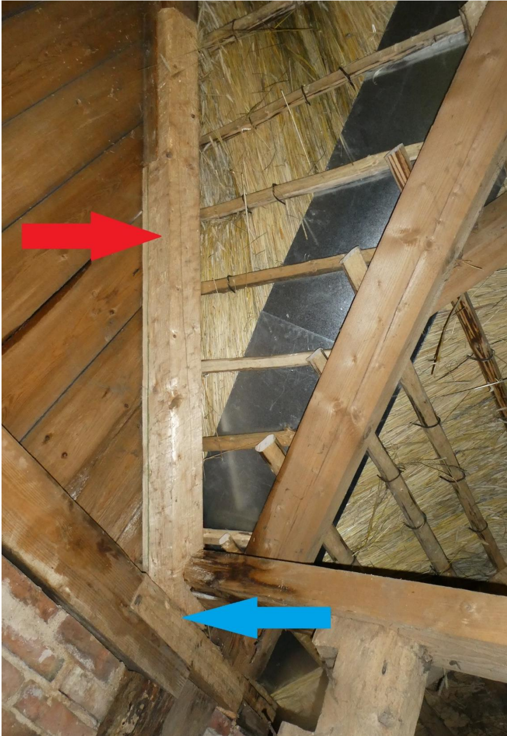
Ränn dalen med ilagning av lejd med ekvirke vid blå pil och ilagning av sparre vid röd pil.
