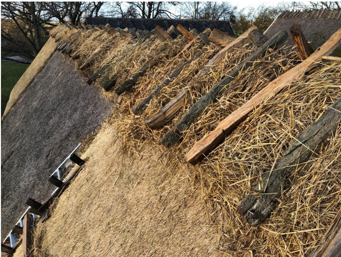
Detalj av kompletterade ryggträn, dymlade i topp, ny löshalm till ryggningen. En del av ryggträna är återanvända från den samling som förvarades inne på loftet i östra längan andra är nyhuggna i ek.
