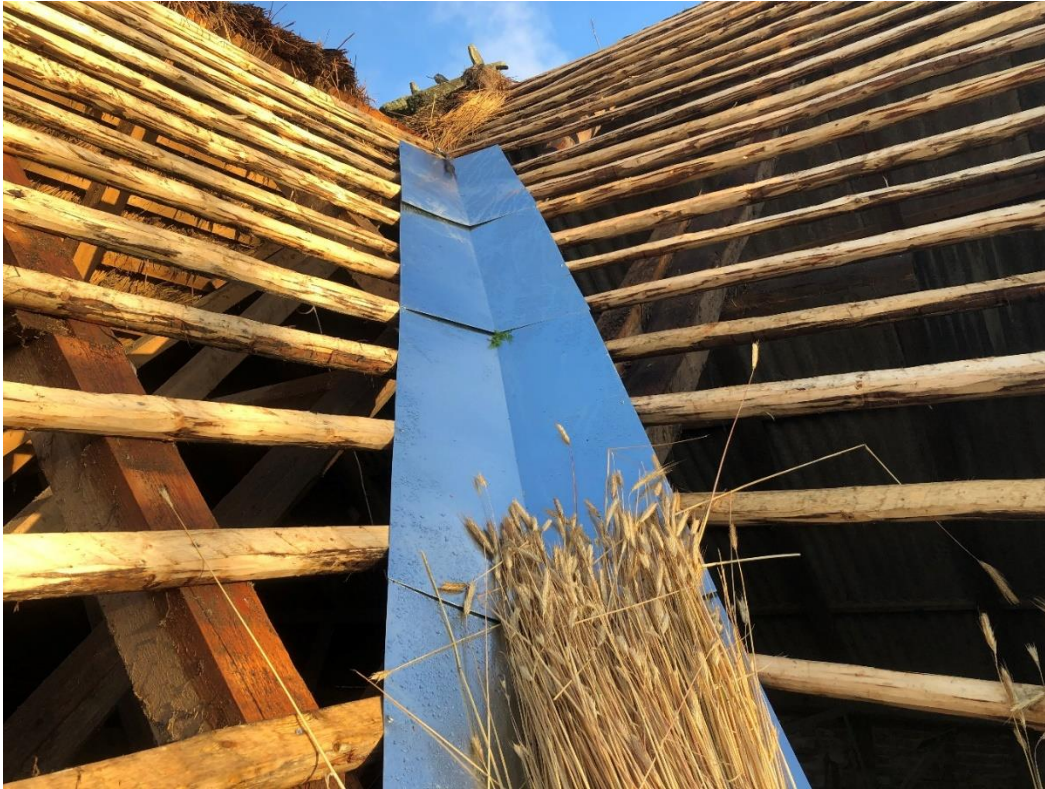
Ränndal i plåt som lades med utgångspunkt från äldre fotografi samt konstaterandet att rännalens vinkel är alltför skarp för att klara en ränndal av endast halm.
