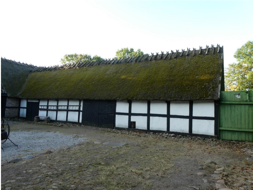
Foto från gårdssidan av logen före åtgärd.
