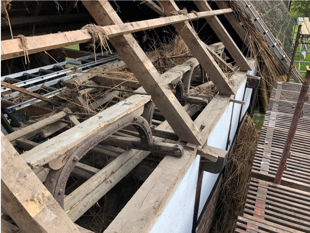
Den sentida takstolen med lejd och läkt frilagd efter rivning av vasstaket.
