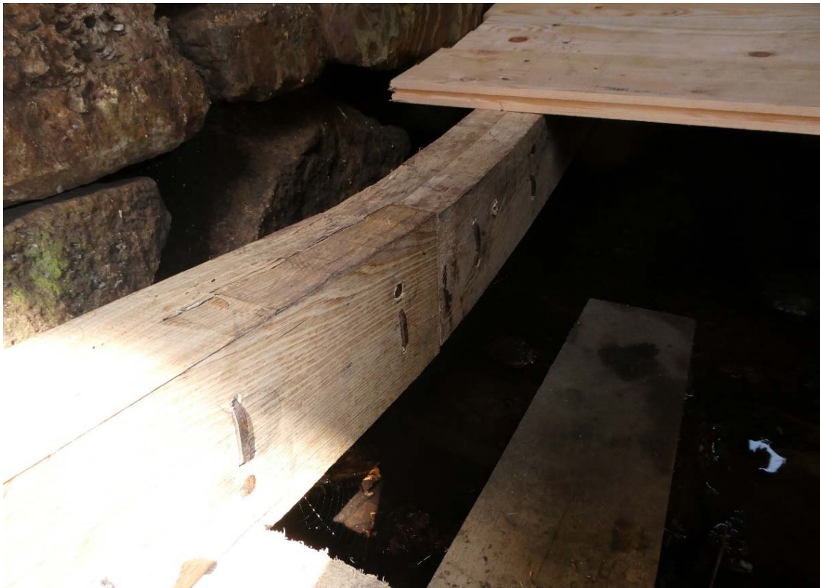
Ny skullbro och vattenhjul under uppbyggnad. Foto vattenhjul: Gunnar Zackrisson.
