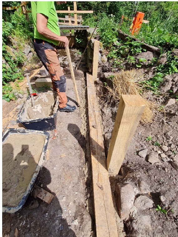
Vänster: Rännan efter att den gamla plankväggen har rivits, på bilden ligger ännu det gamla bottenstycket kvar. Höger: Nytt bottenstycke med olika tätningmetoder. Foto: Gunnar Zackrisson.
