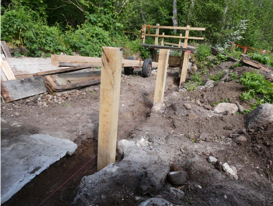
Rännans plankvägg under uppbyggnad, nya stolpar.
