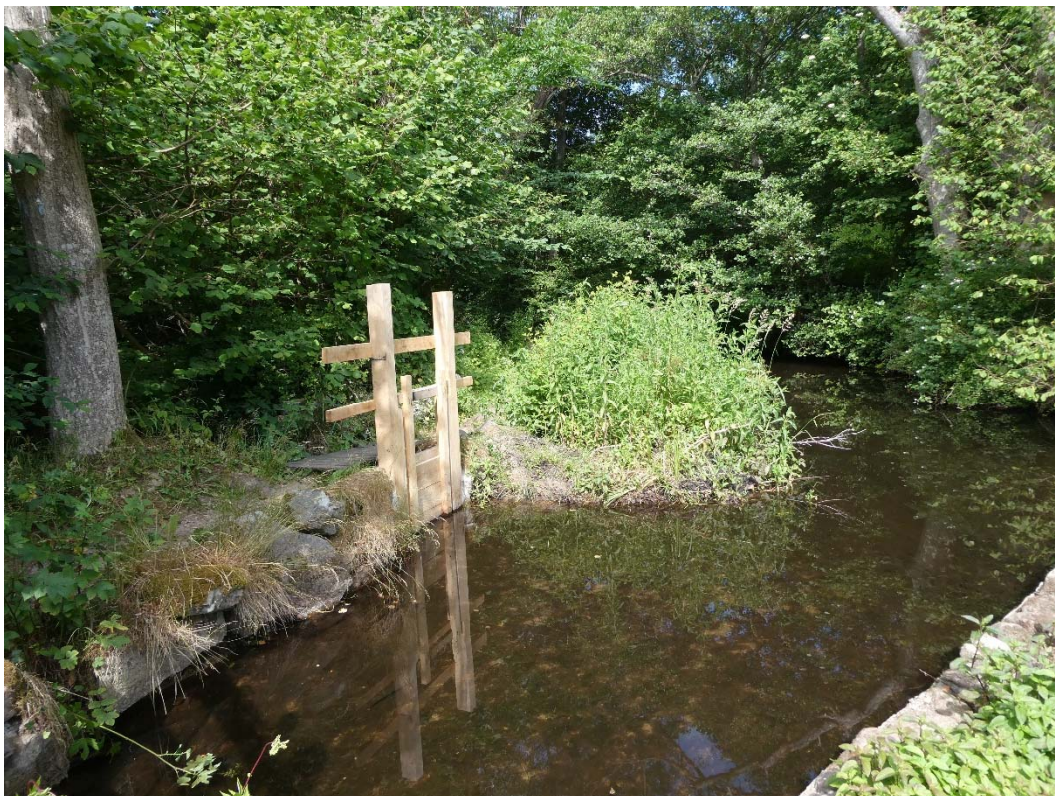
Den nya tilloppsluckan när vattenflödet är åter påsläppt i dammen. På bilden Gunnar Zackrisson och Ingmar Melin.
