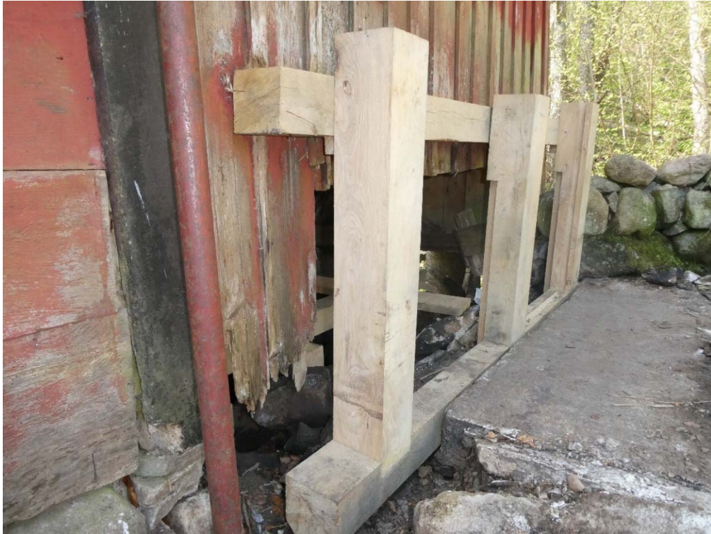
Den nya ramen till pådragsluckan under uppbyggnad.
