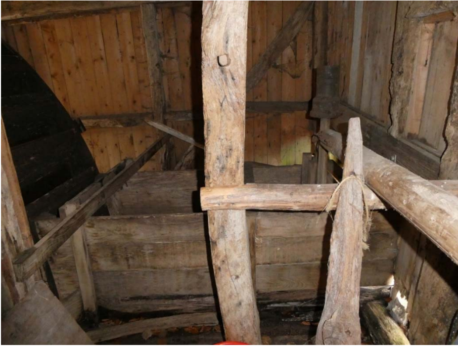
Invändig ränna med lucka till höger i bild samt pådragsarm.
