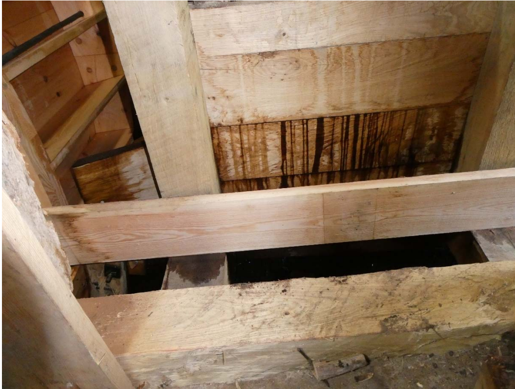
Ny invändig ränna (vattenhjulet till vänster i bild).
