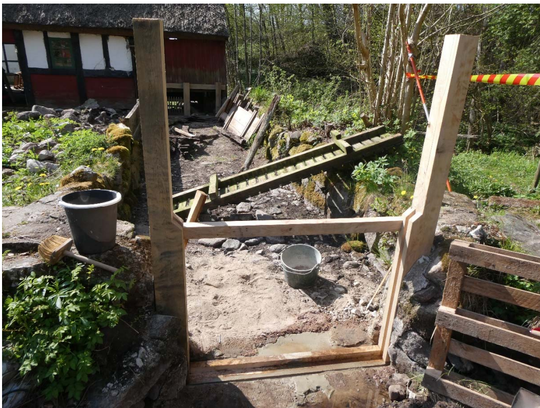
Tilloppsluckan. Ny ram och bottenstycke med gjutning.
