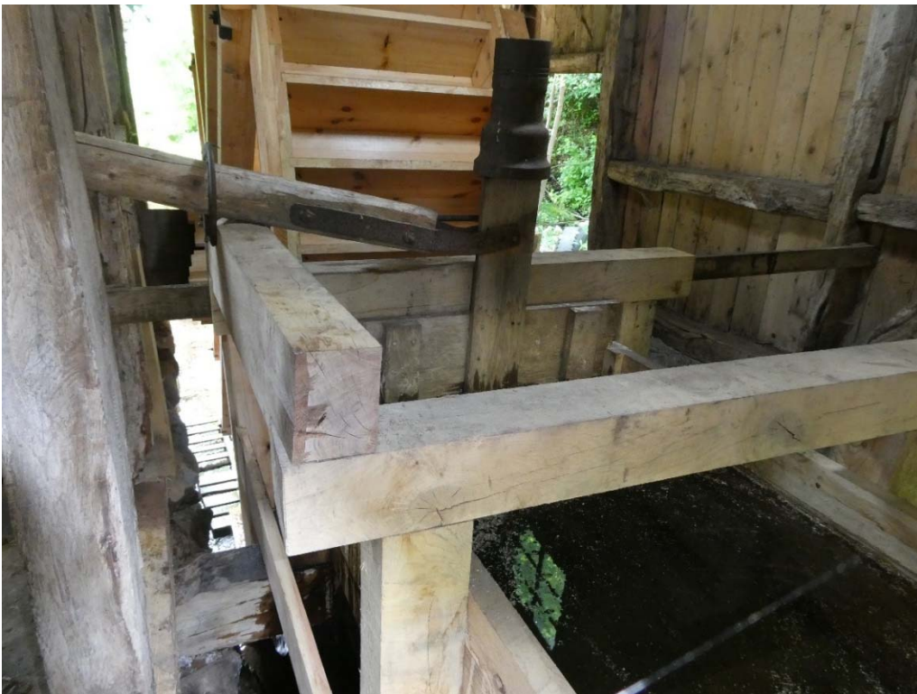
Pådragarmens nya placering invid vattenhjulet och den invändiga pådragssluckan.
