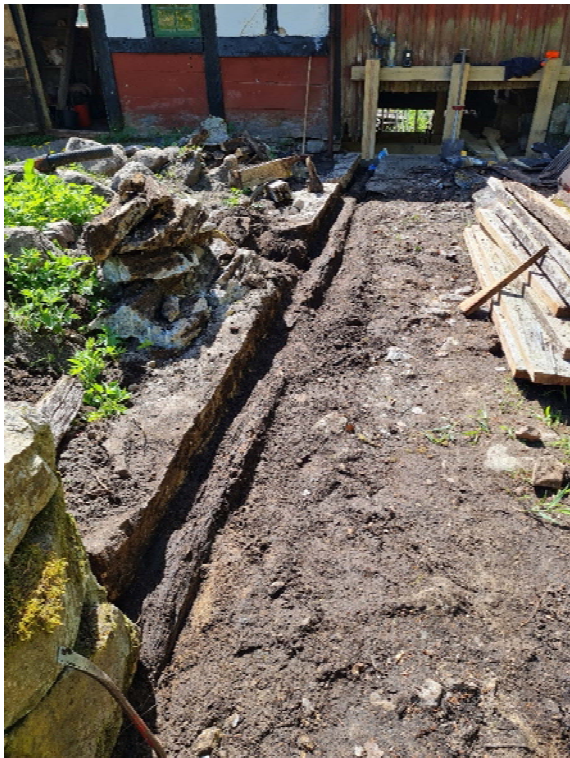
Vänster: Rännan efter att den gamla plankväggen har rivits, på bilden ligger ännu det gamla bottenstycket kvar. Höger: Nytt bottenstycke med olika tätningmetoder. Foto: Gunnar Zackrisson.
