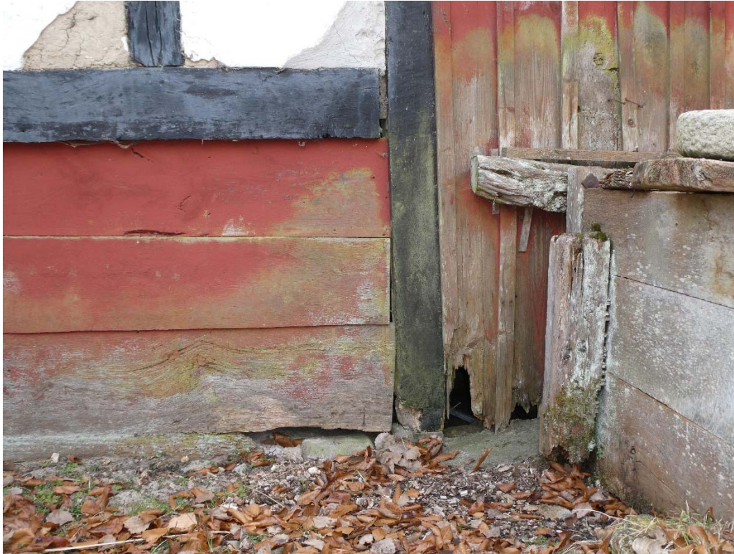
Skadat fotträ och panelbrädor invid rännan i norr.
