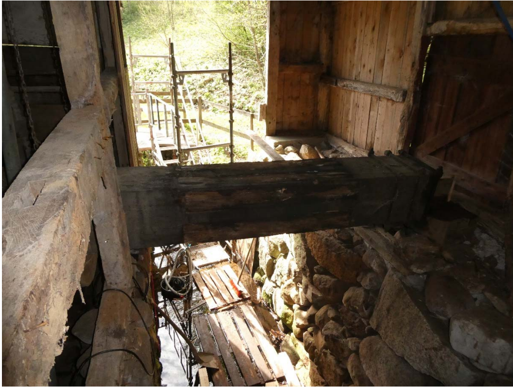
Vattenhjulet är bortrivet, kvarnaxeln ligger kvar och bevarades.
