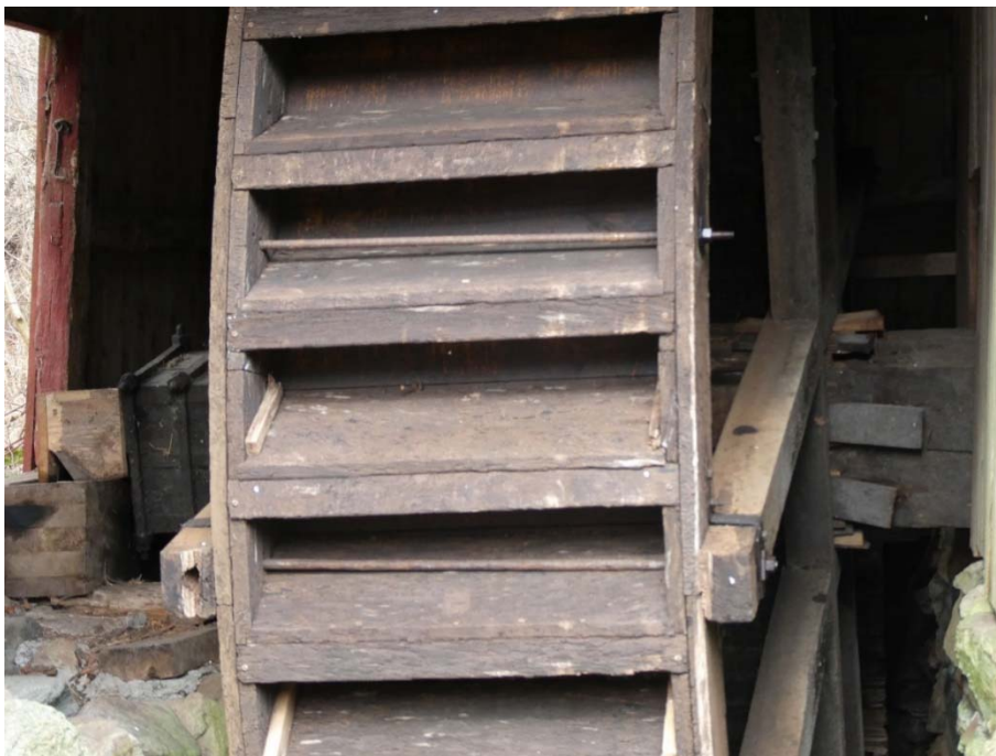
Vattenhjulet och skullbron under hjulet, dessa revs och ersattes.
