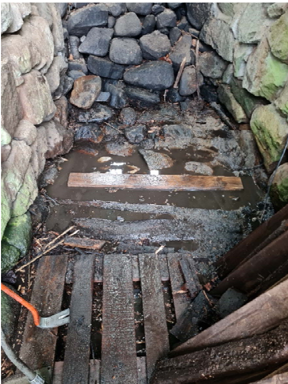
Under vattenhjulet när hjulet och skullbro rivits ut. Del av det gamla och nya hjulet. Foto: Gunnar Zackrisson.
