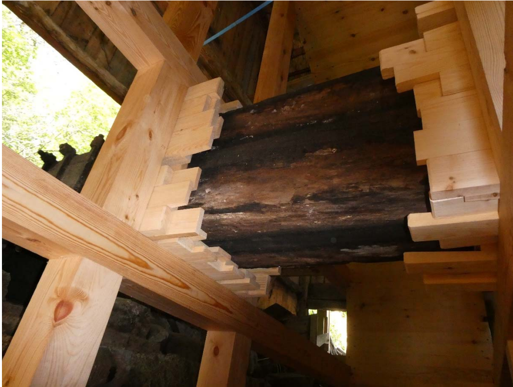
Vattenhjulet kilat mot kvarnaxeln.
