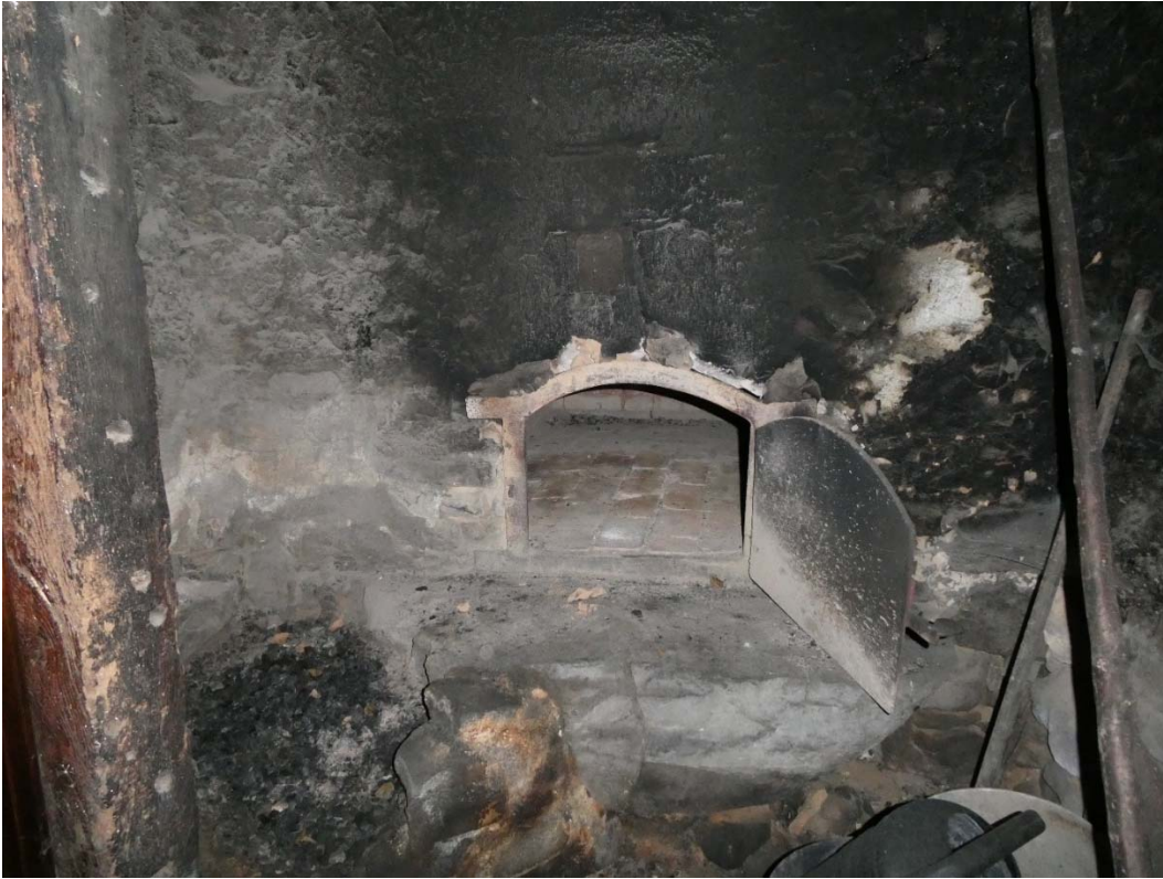
Före åtgärder, bakugnens lucka.
