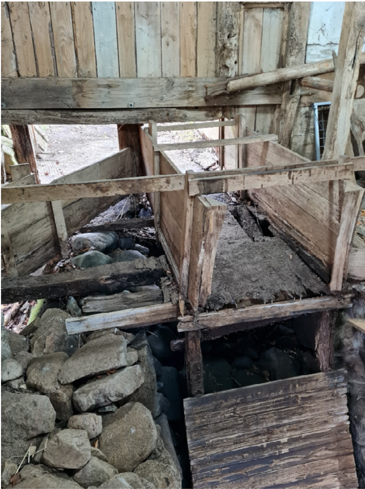
Invändig ränna med lucka till höger i bild samt pådragsarm.
