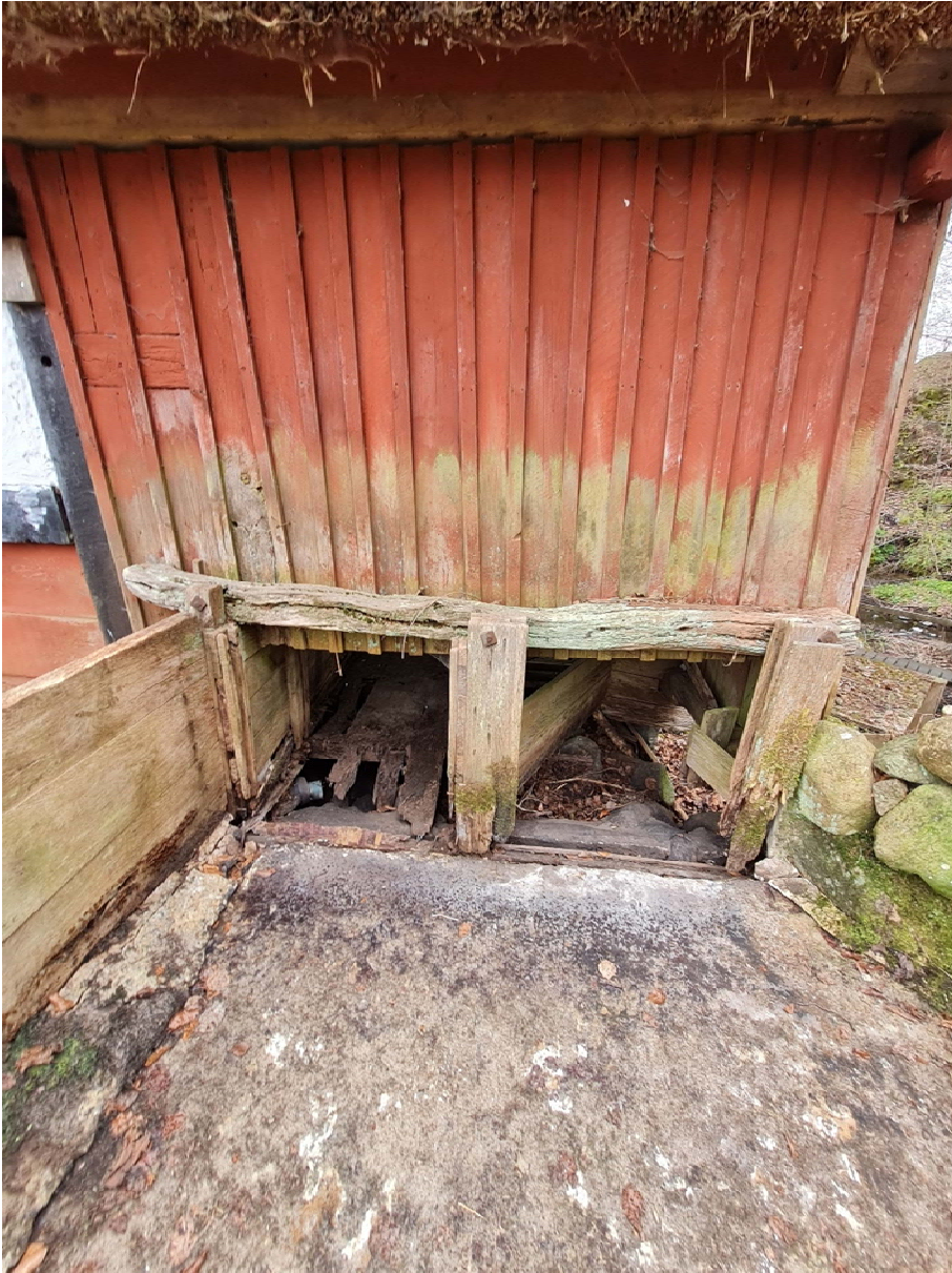
Den gamla konstruktionen vid inflödet till möllan. Foto: Gunnar Zackrisson.
