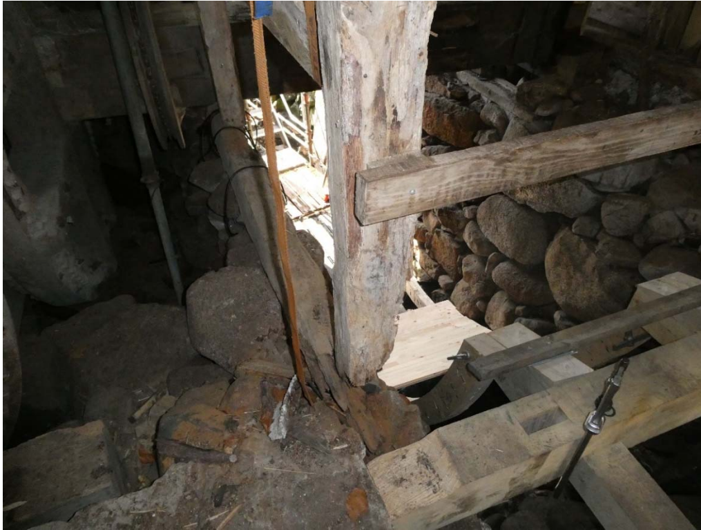
Stolpe och liggande bjälke i dåligt skick ska skarvas i. På bilden syns ny skullbro och den nya bottenramen till invändiga rännan.
