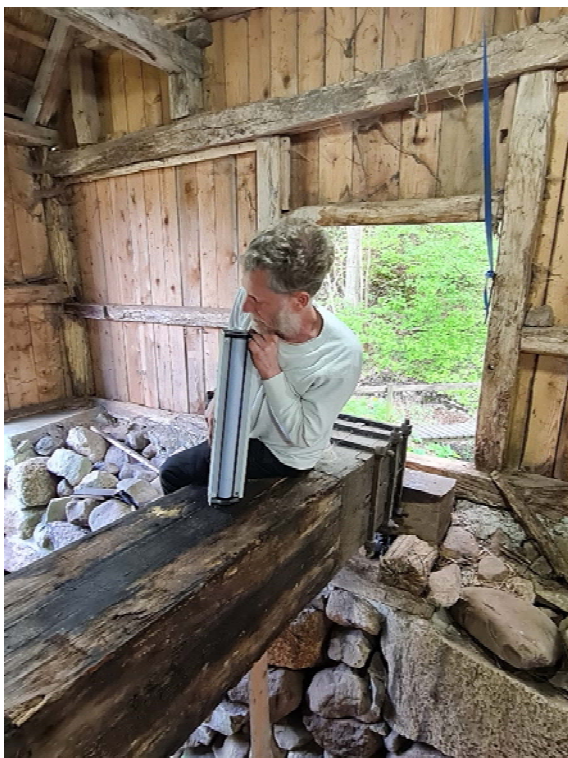
Stolpe och liggande bjälke i dåligt skick ska skarvas i. På bilden syns ny skullbro och den nya bottenramen till invändiga rännan.
