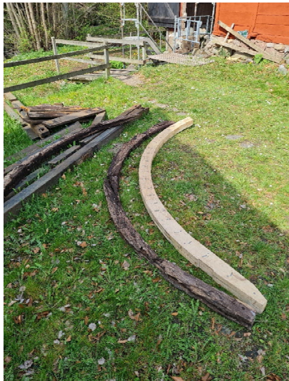
Under vattenhjulet när hjulet och skullbro rivits ut. Del av det gamla och nya hjulet. Foto: Gunnar Zackrisson.
