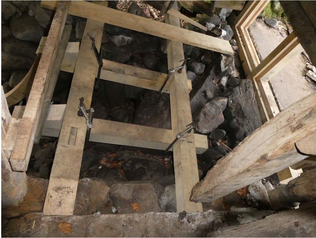
Den nya bärande stommen till invändig ränna, här tillfälligt fäst med tving (vattenhjulet kommer att placeras till vänster i bild). Observera urtag för tappning.
