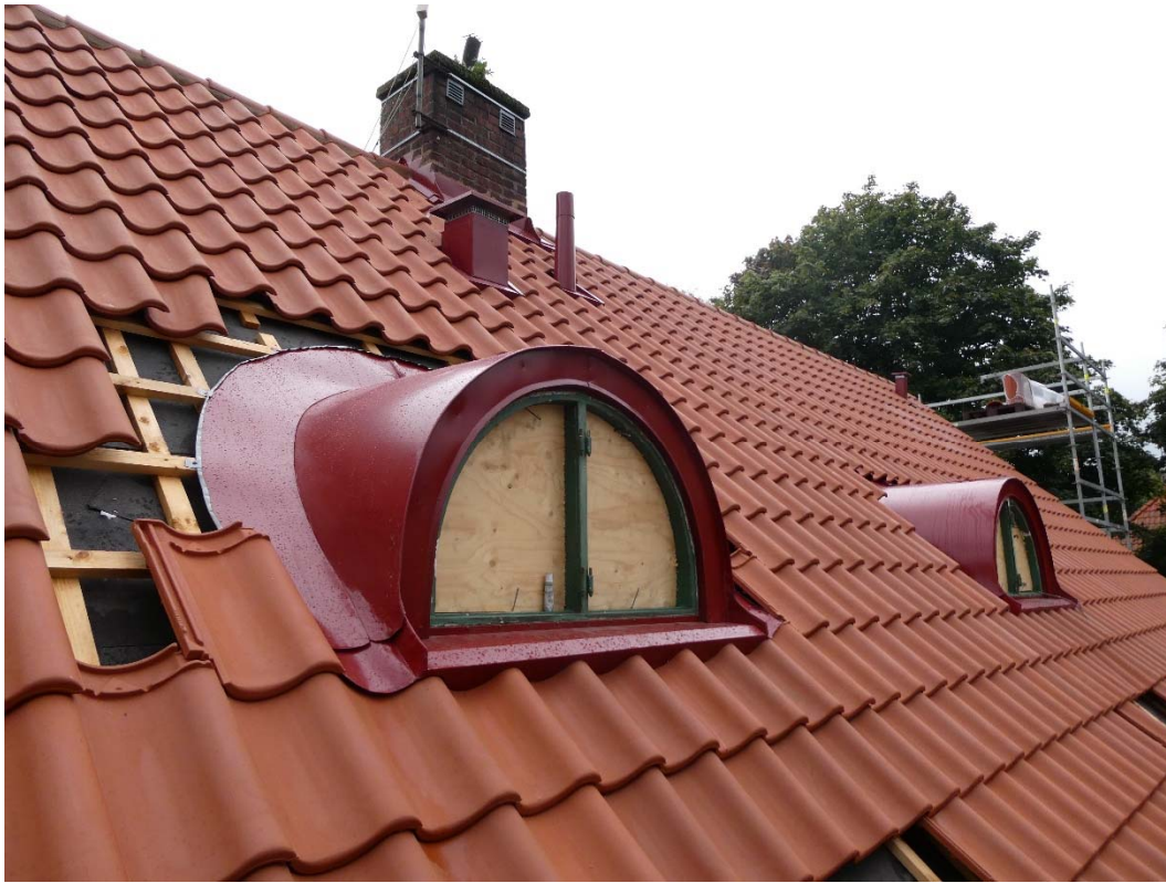
Under arbete, norra takfallet.
