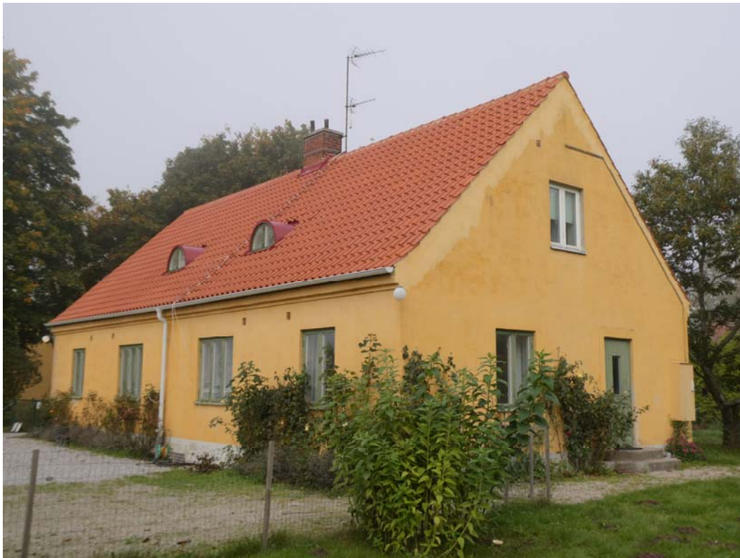
Efter åtgärder. Södra takfallet och östra gaveln.
