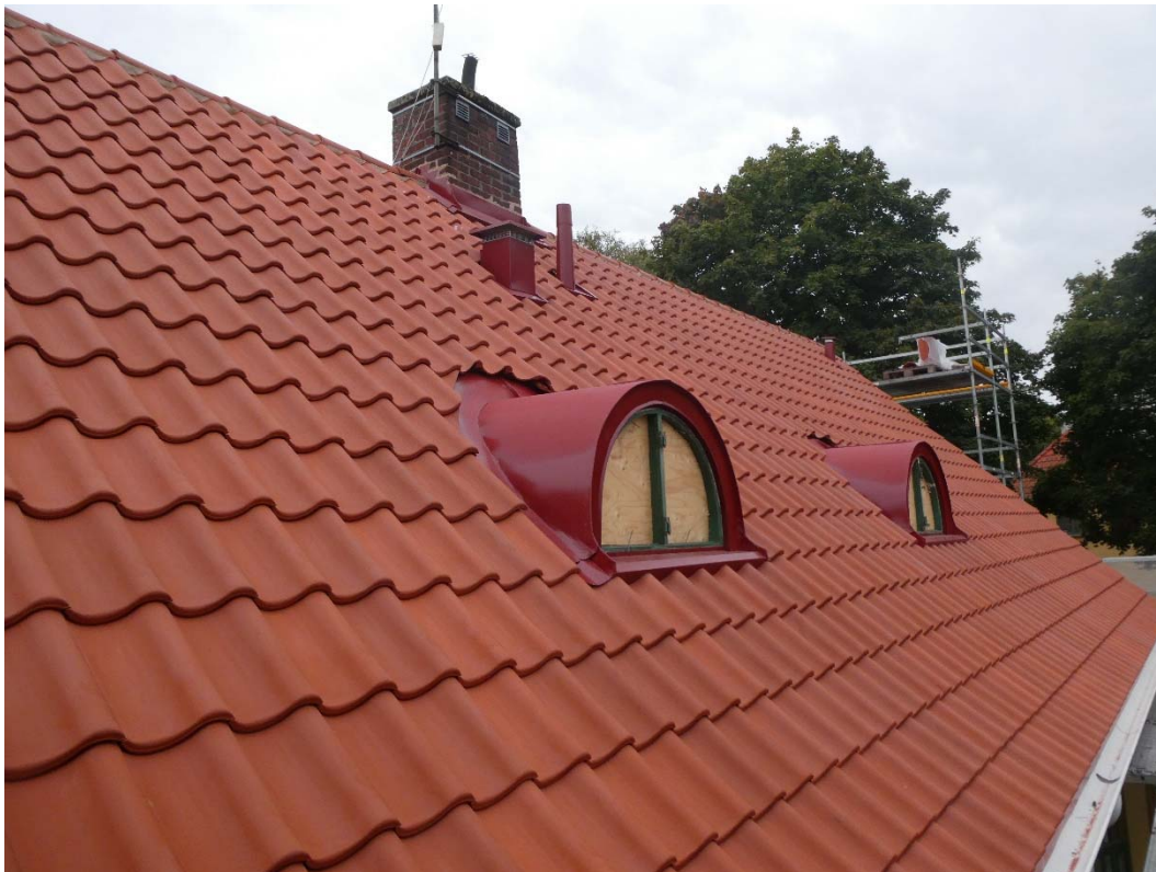
Under arbete. Norra takfallet.
