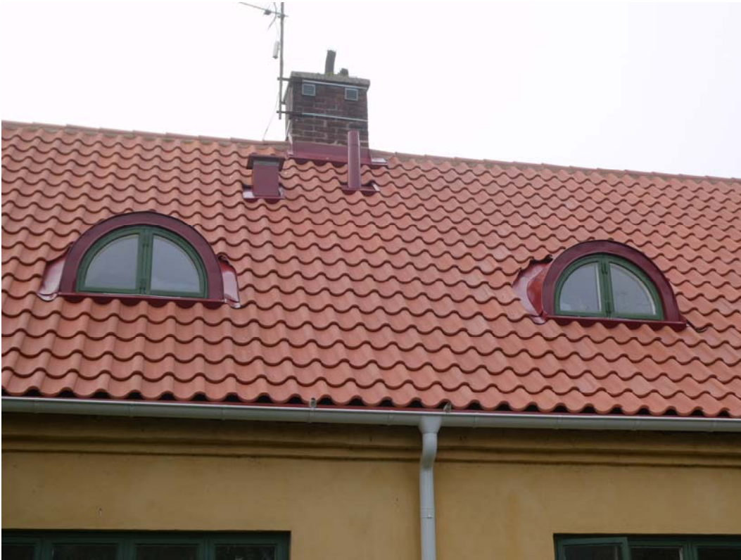
Efter åtgärder. Norra takfallet.
