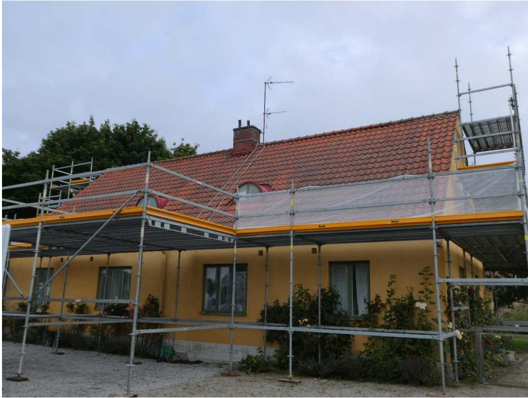
Före åtgärder södra takfallet.
