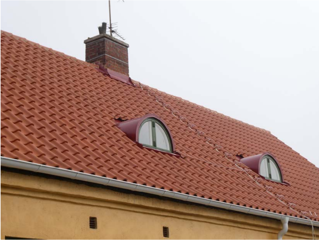
Efter åtgärder. Södra takfallet.
