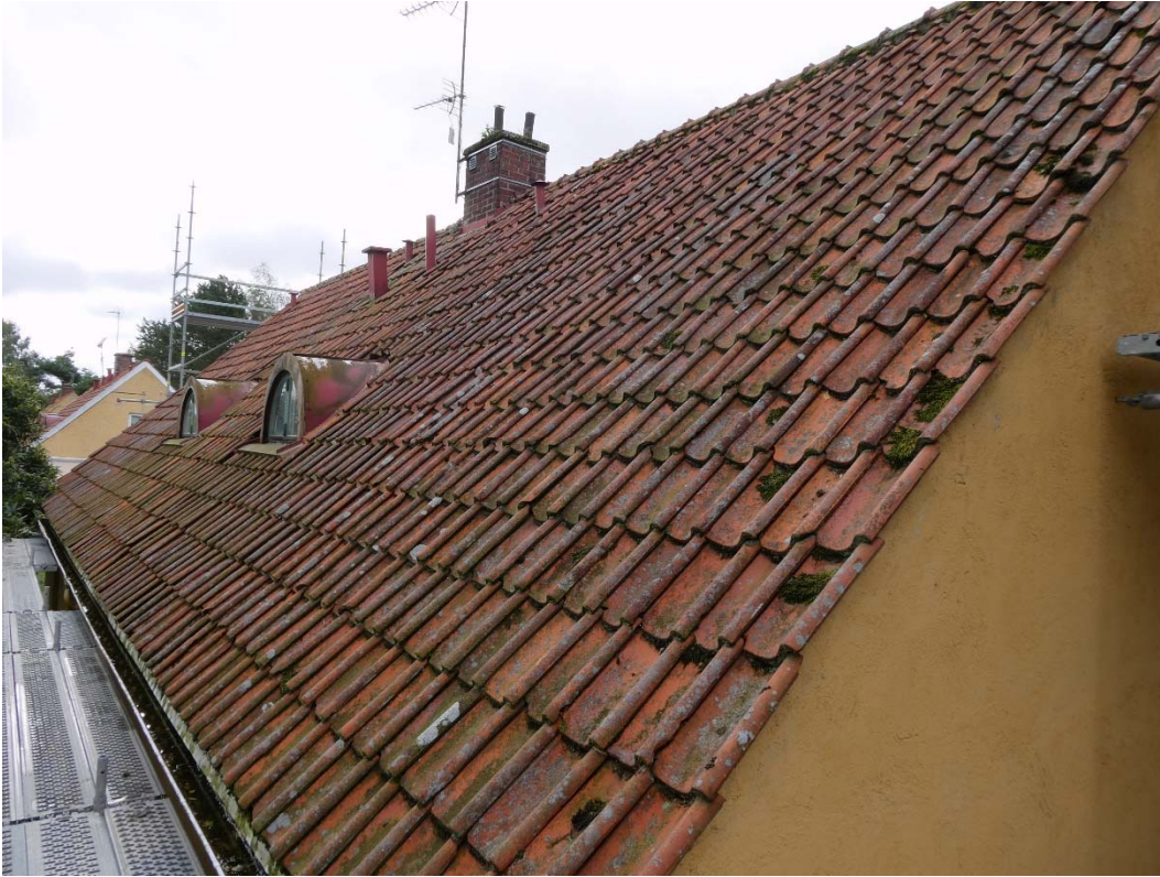
Före åtgärder norra takfallet.
