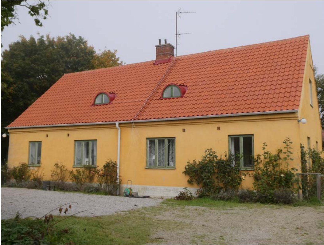
Efter åtgärder. Södra takfallet.
