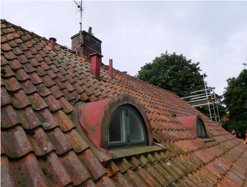
Före åtgärder norra takfallet.
