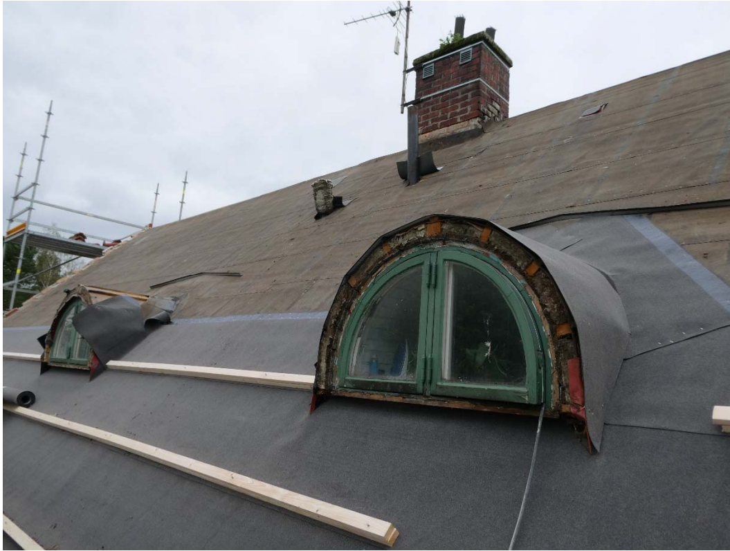
Norra takfallet. Ny papp och läkt läggs på befintligt underlag.
