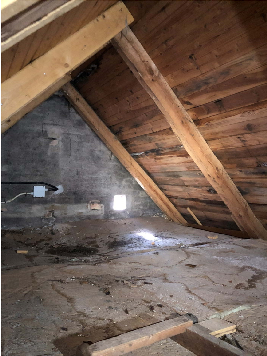
Vinden. Till vänster i bild norra takfallet där råspont är bytt vid tidigare tillfälle, möjligen 1980/90-talet och takstolen är påsalad.
