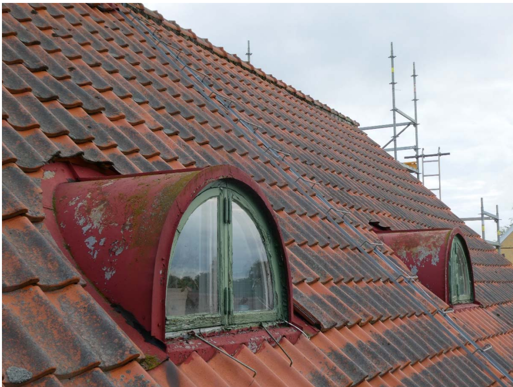
Före åtgärder södra takfallet.
