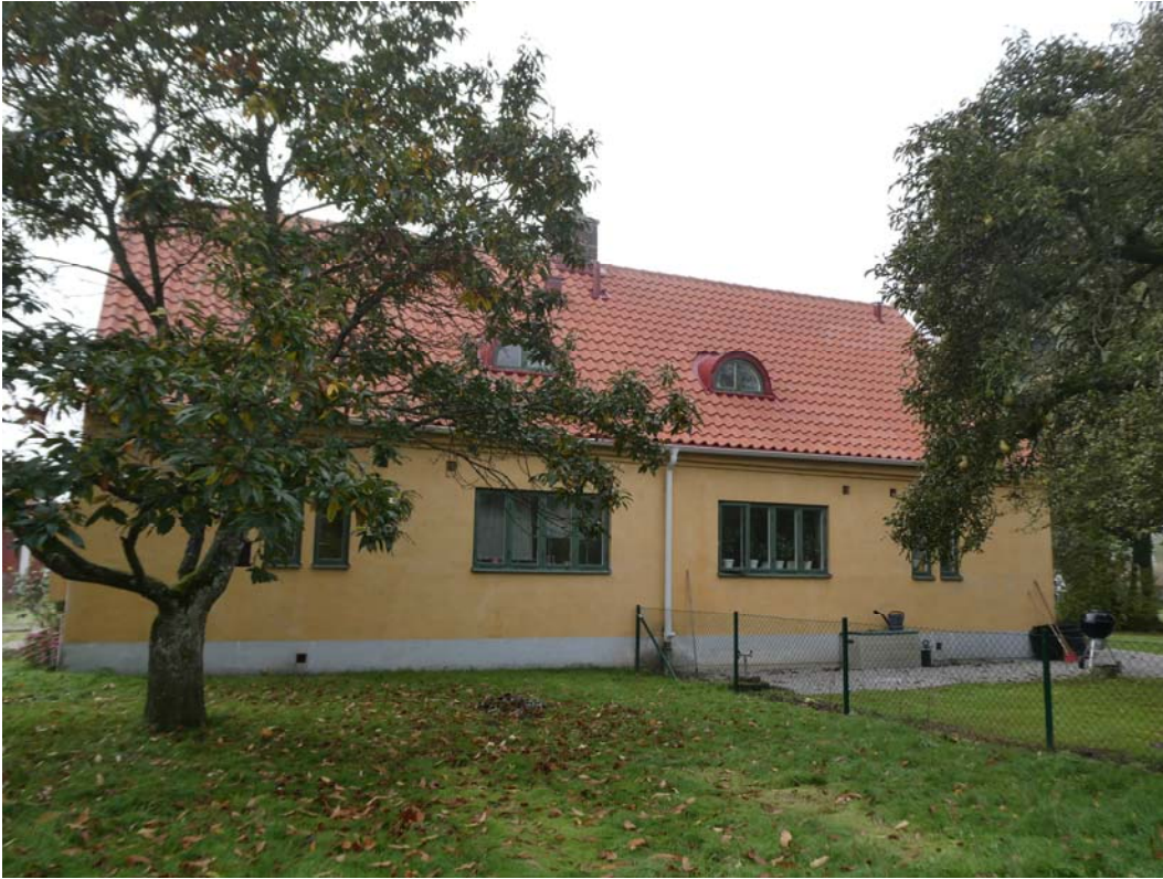
Efter åtgärder. Norra takfallet.
