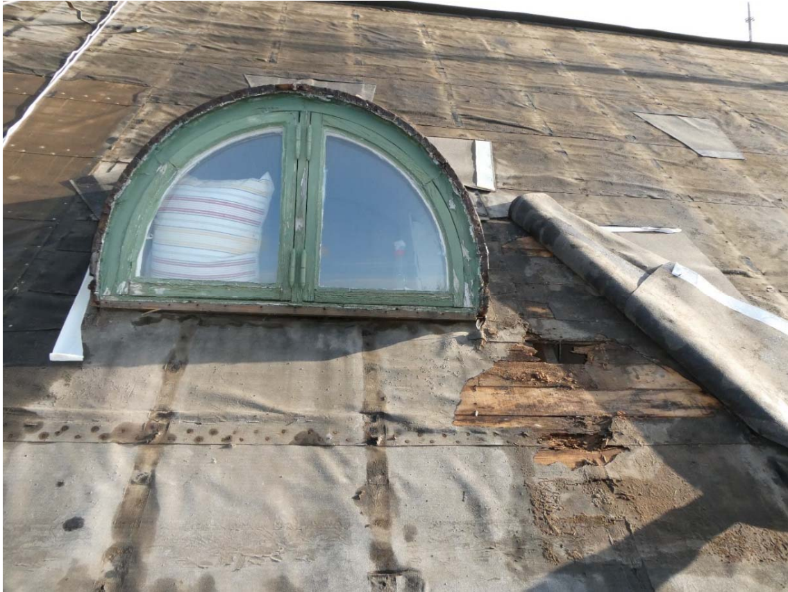
Under arbete. Södra takfallet, råsponten var rötskadad.
