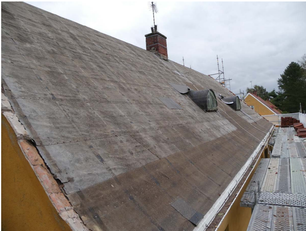
Norra takfallet. Ny papp och läkt läggs på befintligt underlag.
