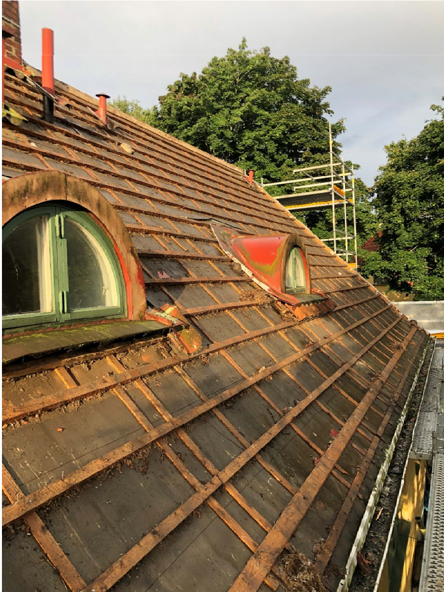
Under arbete, norra takfallet.
