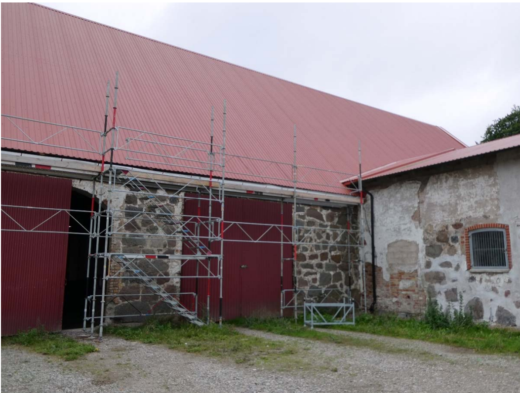
Efter åtgärder, västra takfallet (avvattning återstår att montera).
