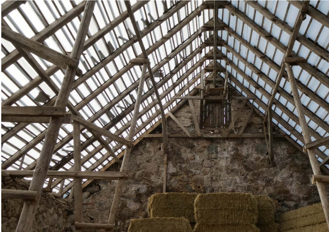
Under arbete. Den nord-sydliga längan, sparren dikt an gavelväggen till vänster i bild är förstärkt med nytt virke.
