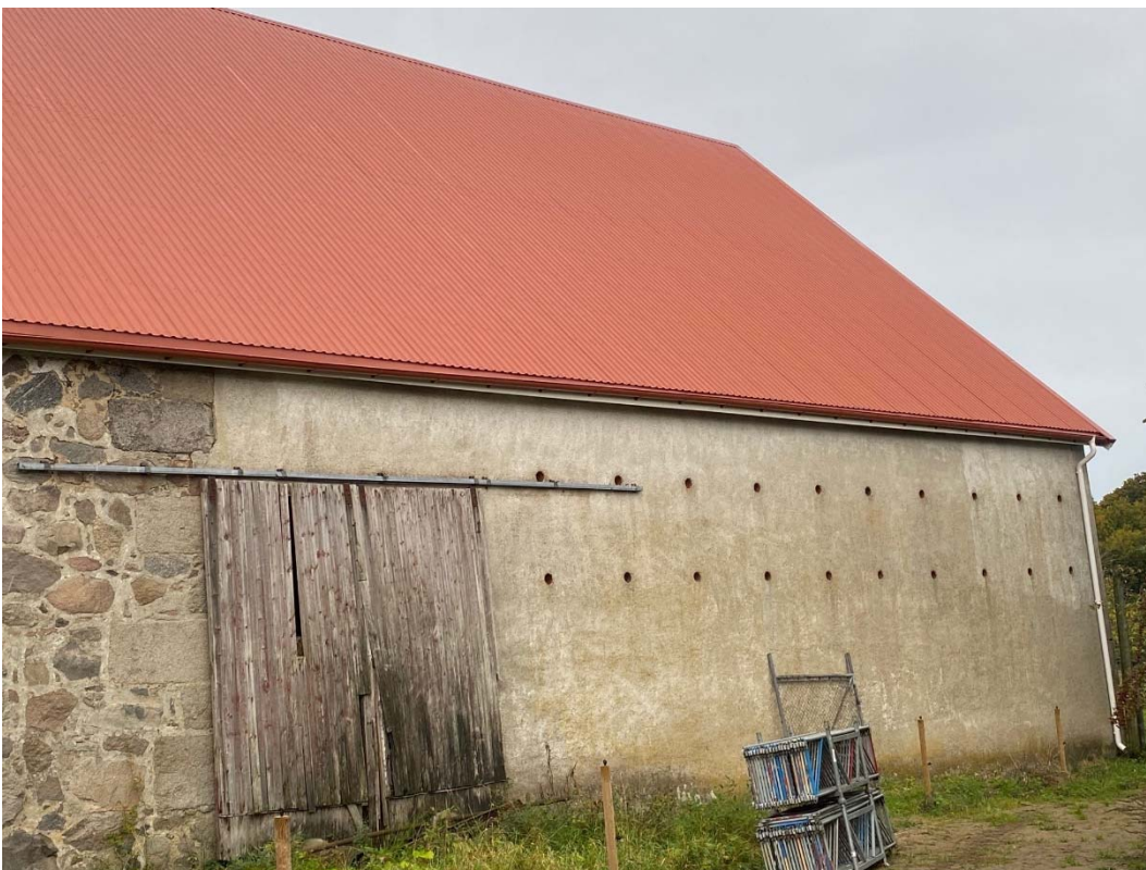
Efter åtgärder. Norra längan.
