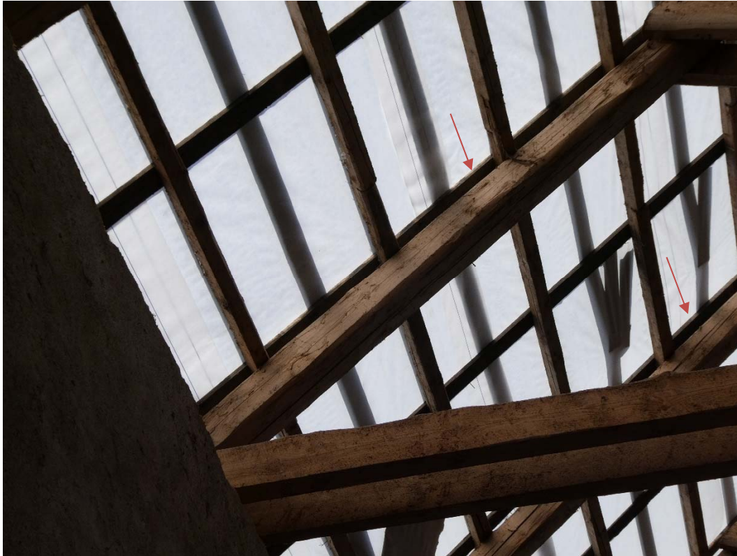
Under arbete. Öst-västliga vinkellängan. På bilden ser man läkt som läggs från nock till takfot under duken (röd pil), samt strö- och bärläkt som ligger ovanpå duken.
