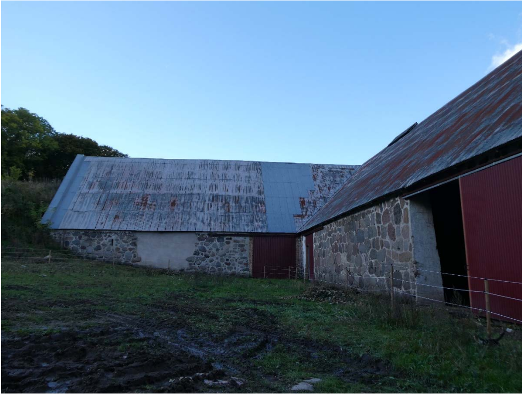
Före åtgärder. Till vänster i bild södra delen av logen, till höger östra vinkellängan.
