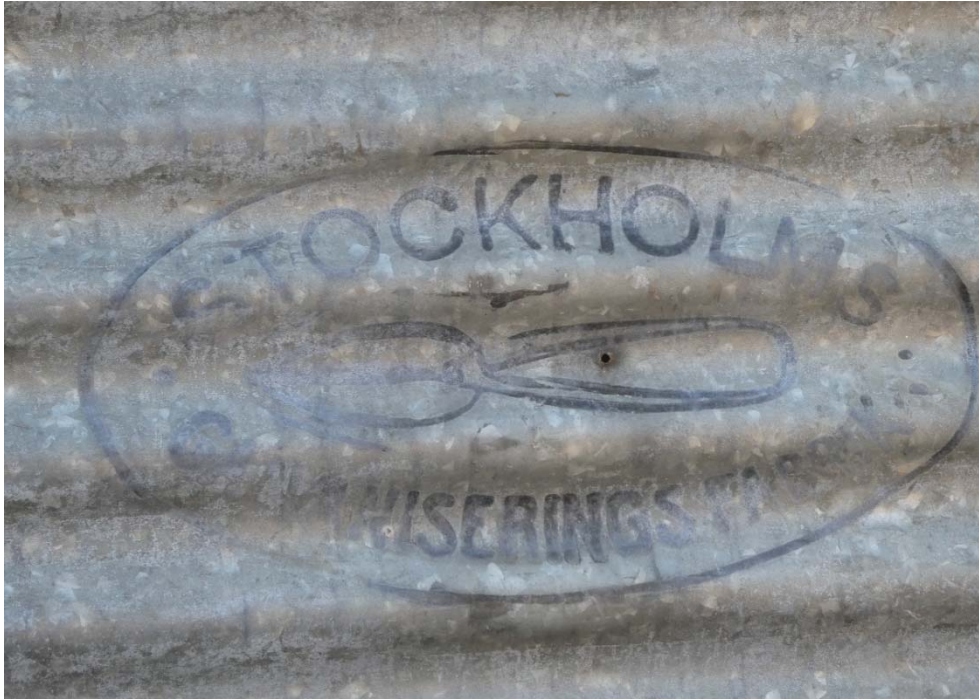
Stämpel som fanns under den gamla plåten som revs. Stockholms galvaniseringsfabrik.
