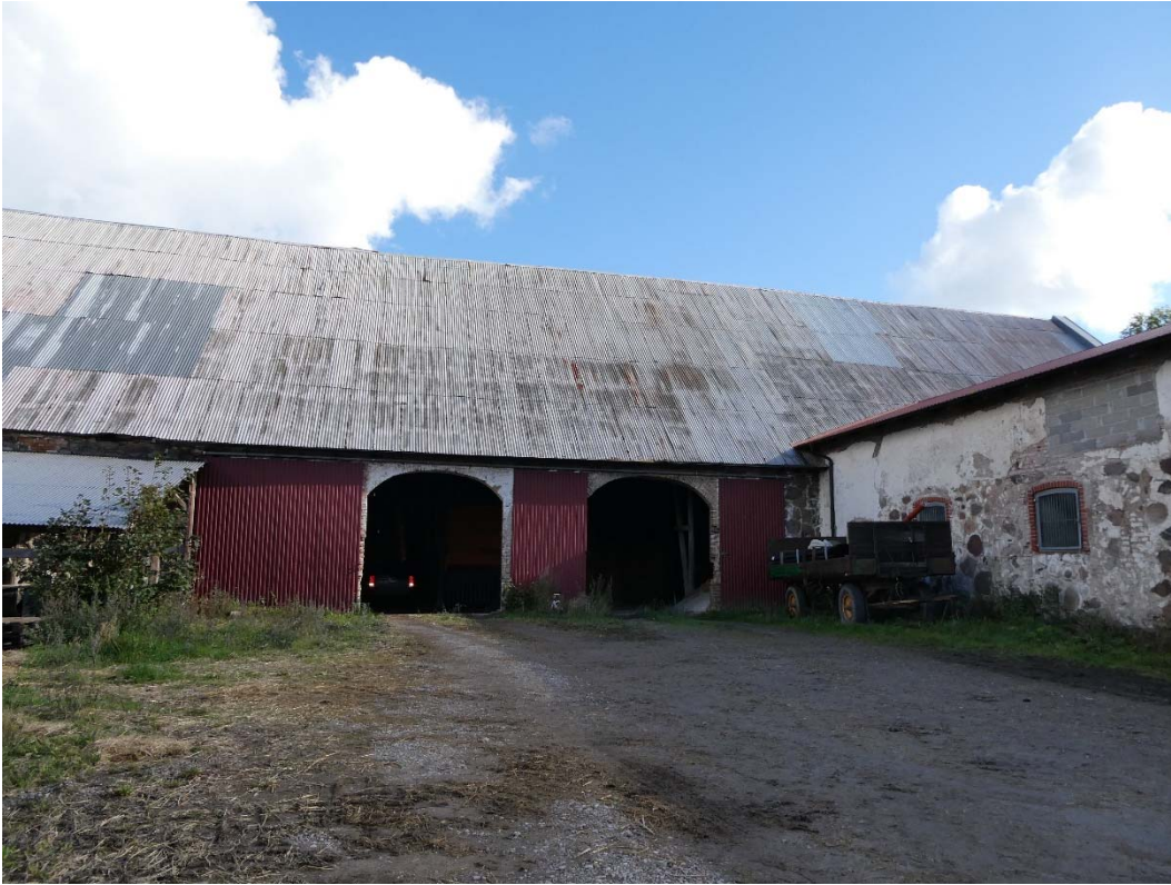
Före åtgärder. Logens västra takfall.
