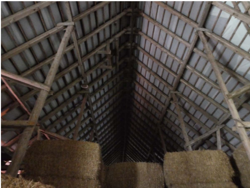
Efter åtgärder, nord-sydliga längan vy mot norr.
