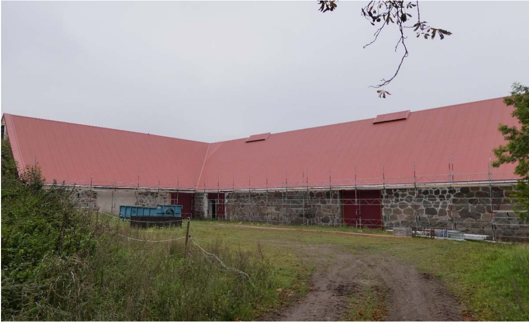
Efter åtgärder, östra och södra takfallen (avvattning återstår att montera).
