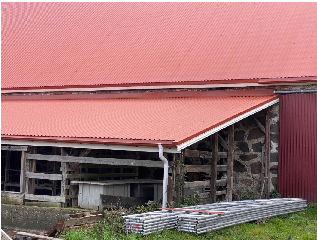
Efter åtgärder västra takfallet.
