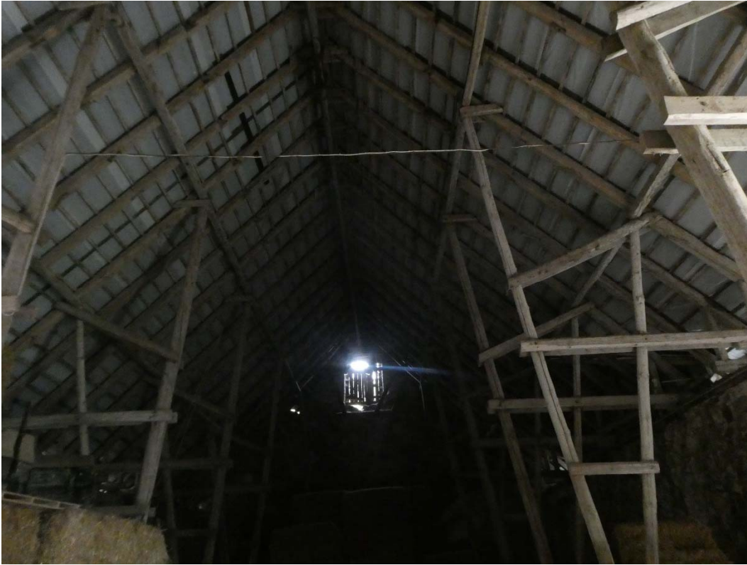
Efter åtgärder nord-sydliga längan vy mot söder.
