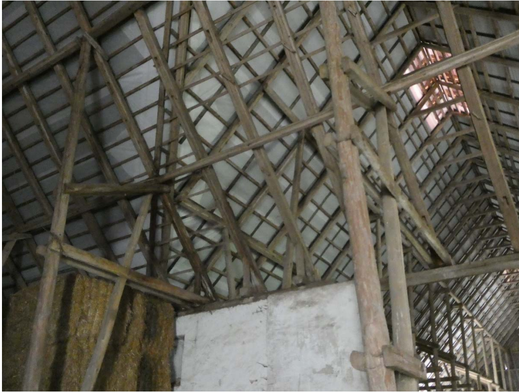
Efter åtgärder, takmötet av de två längorna.
