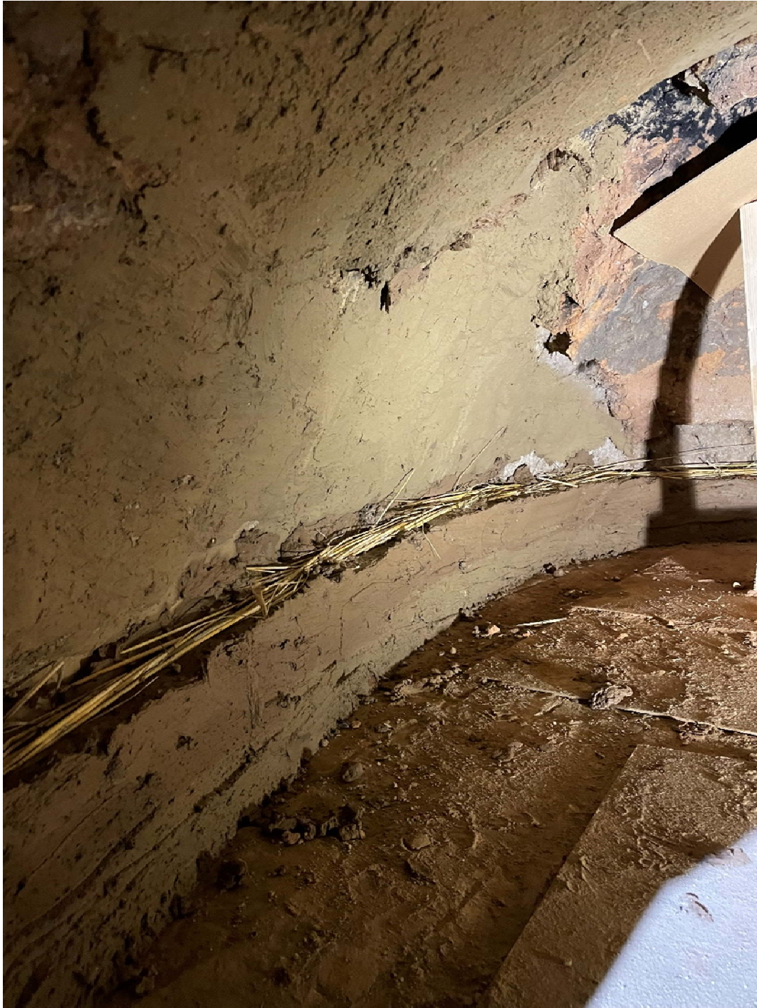
Leran läggs i varv inne i ugnen med vriden halm som ett armeringslager.
