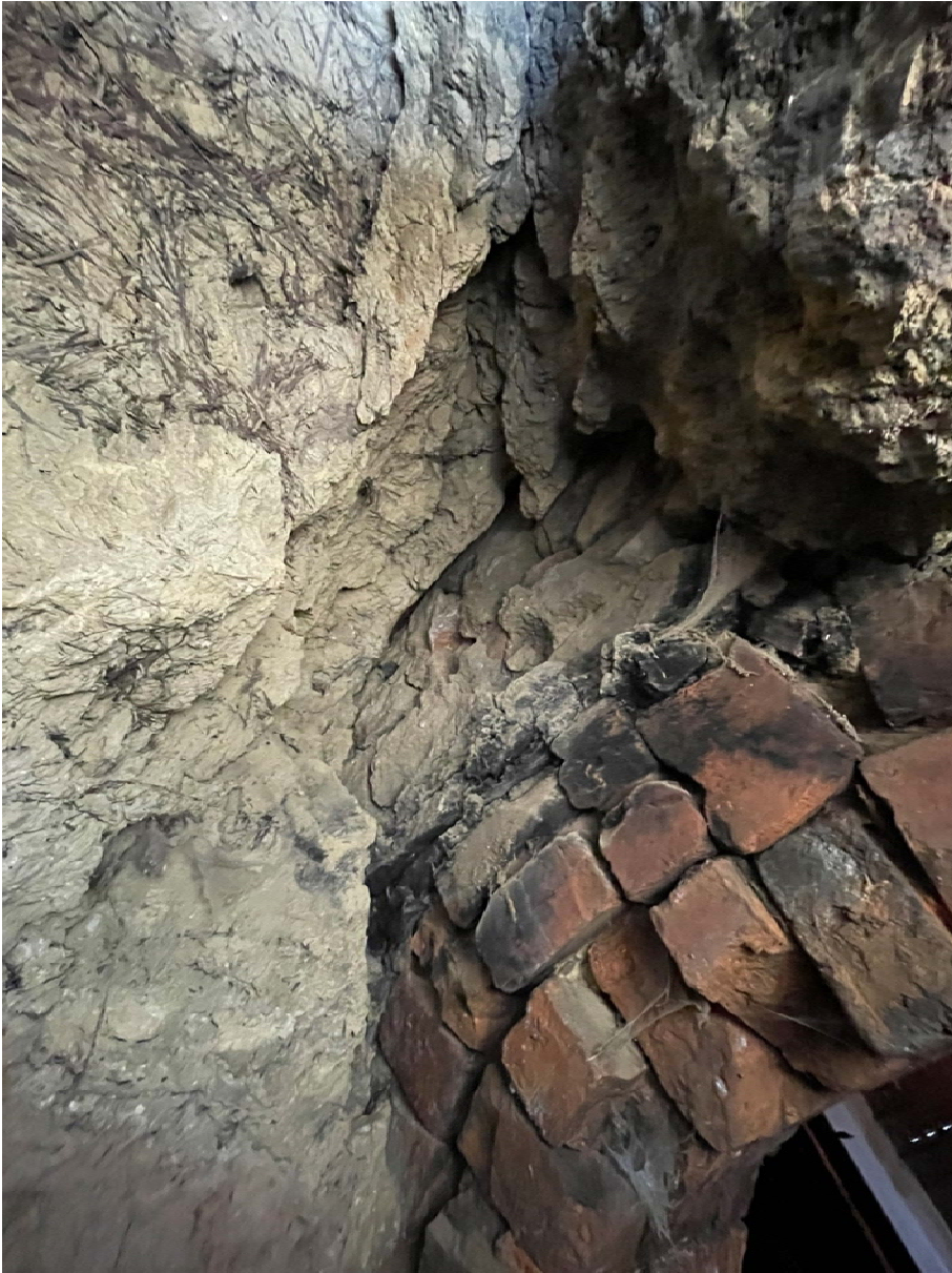
Ugnstaket innan påbörjade arbeten. Notera den intryckta halmen som är synlig i leran.
