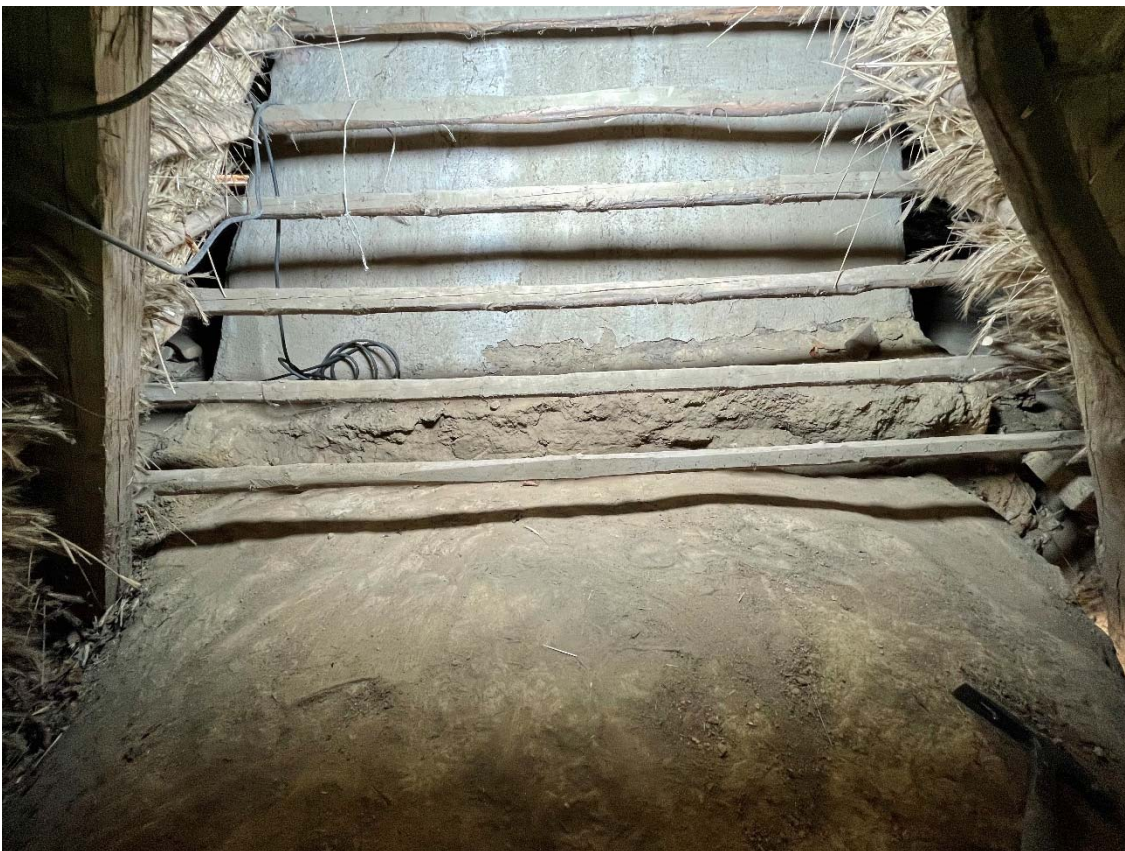
Bakugnskroppen och anslutning till murstocken.
