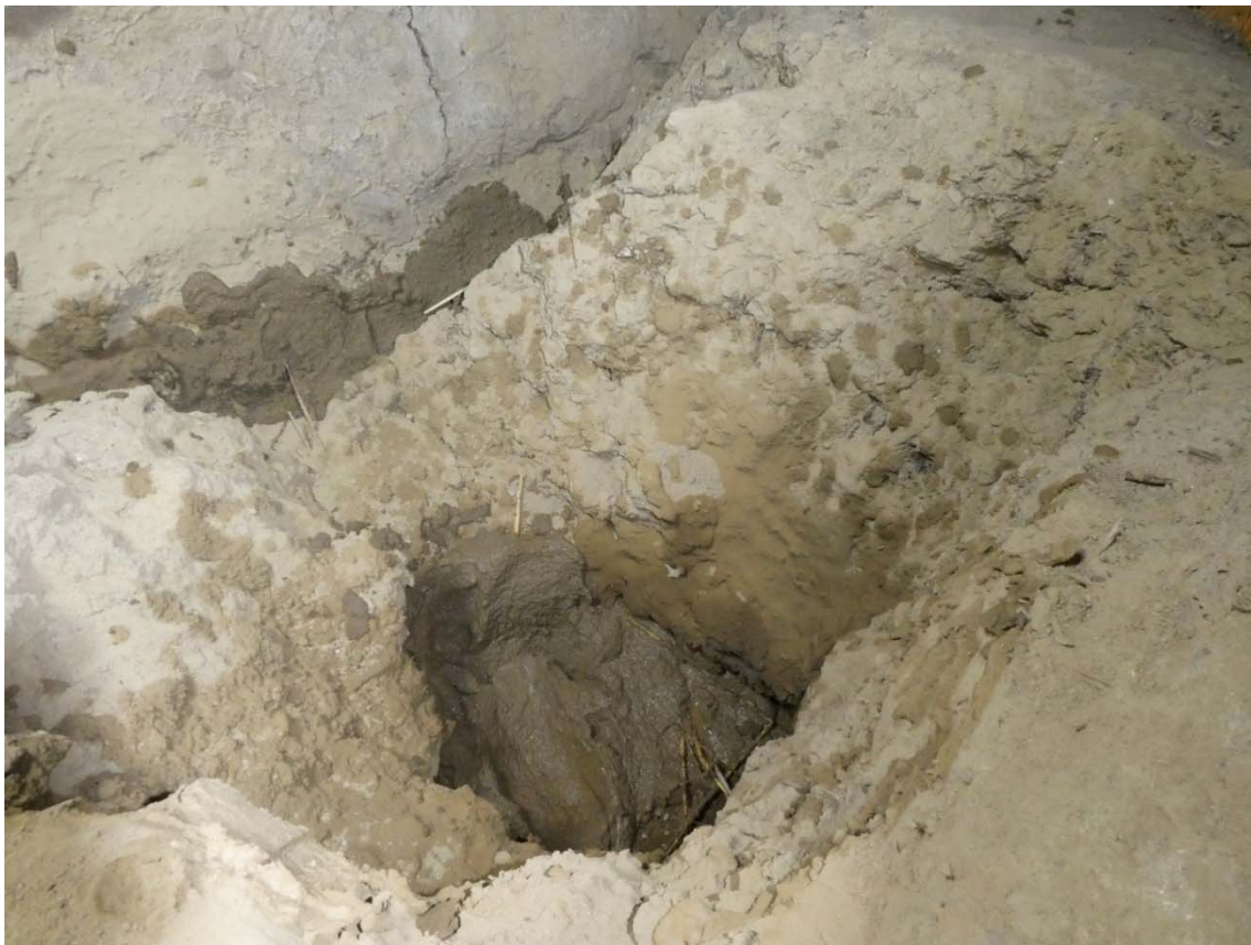
Lera med halminblandning läggs i lager om ca 10 cm. Däremellan ska lerlagret torka.
