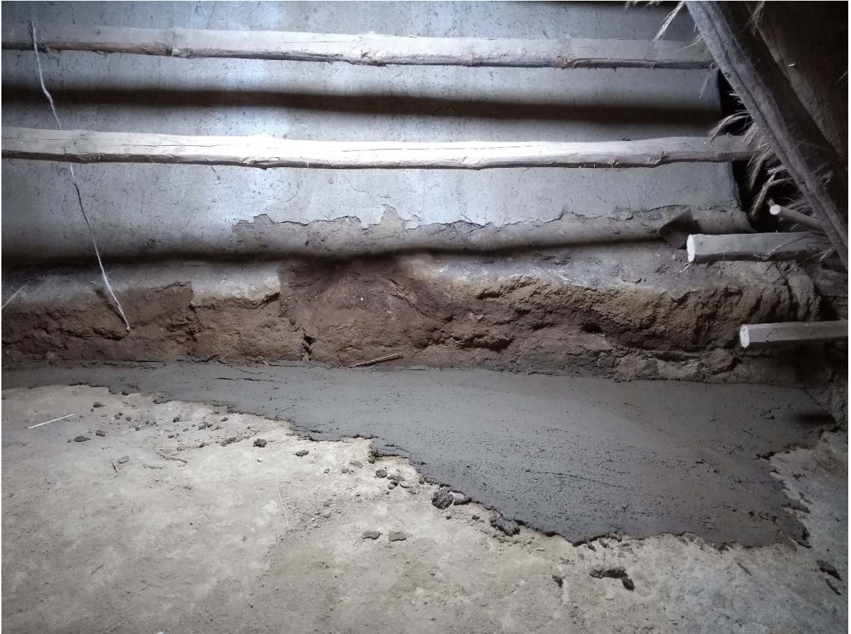
Håltagningen uppe på kupolen är ifylld med lera och halm.
