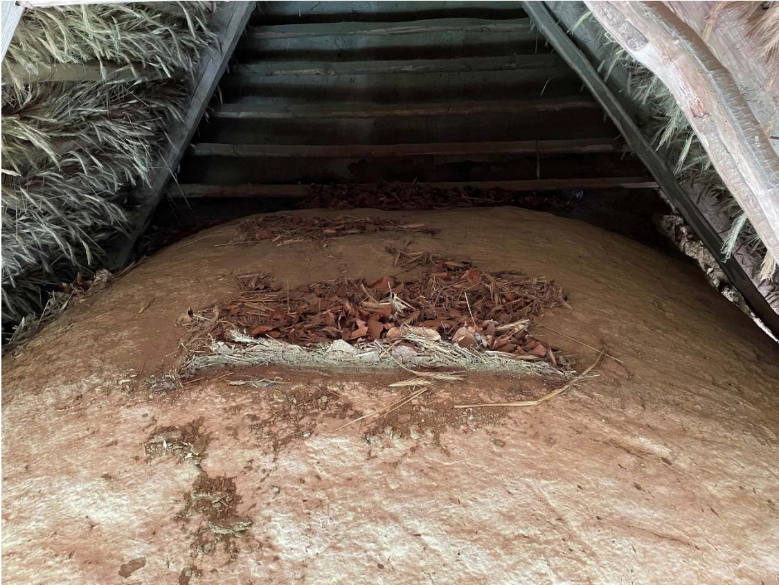
Den utvändiga kupolkroppen innan påbörjade arbeten.
