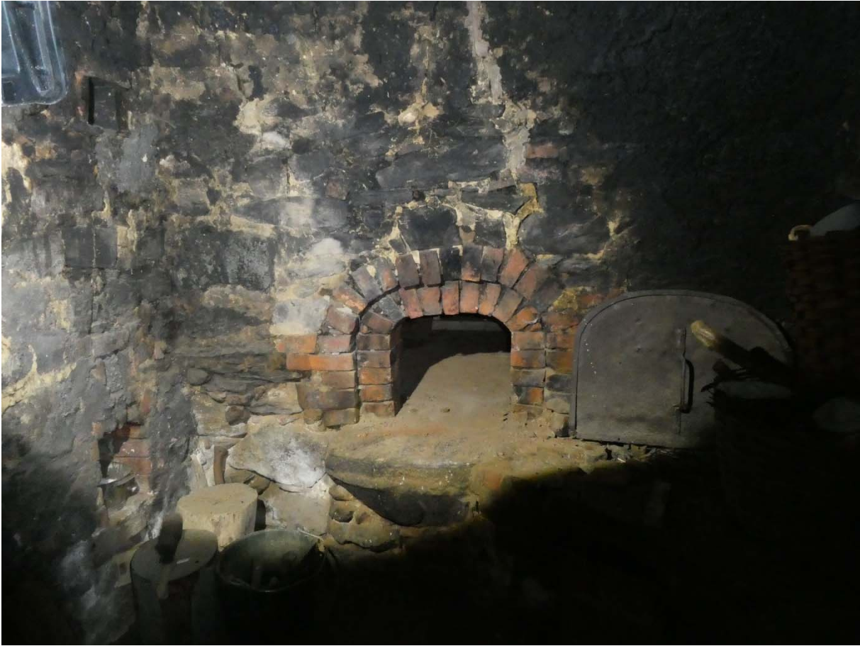
Bakugnsöppningen inne i illaren (skorstenen).
