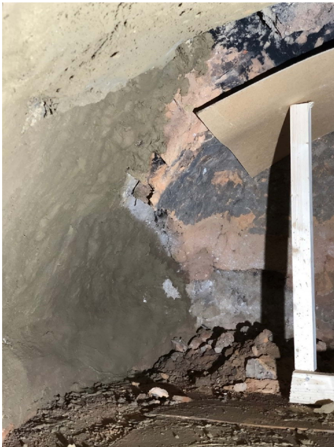
Ugnens vägg under uppbyggnad.
