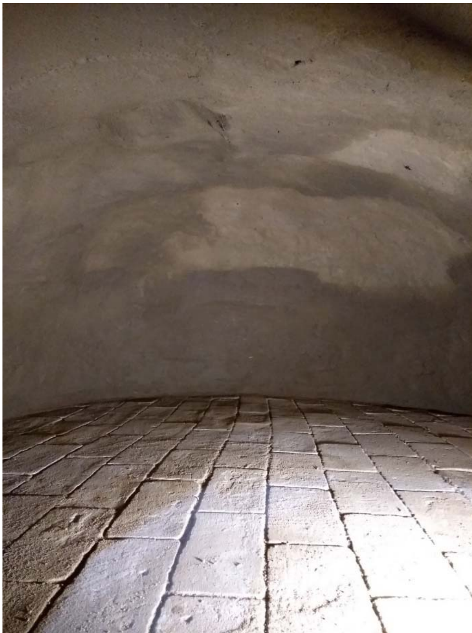
Bakugnen med tegelgolvet och den slammade väggen.
