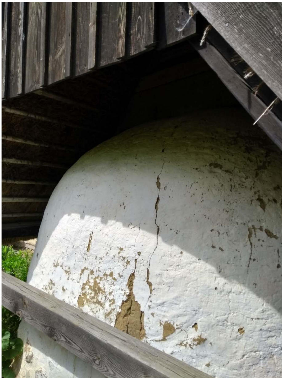
Den utvändiga kupolkroppen innan påbörjade arbeten.
