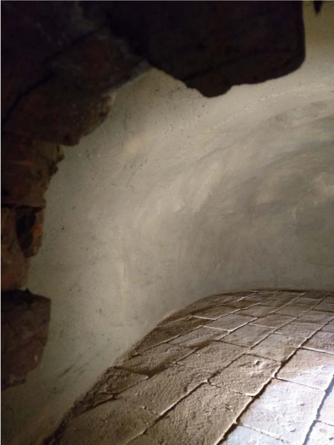
Bakugnen efter färdigställandet.
