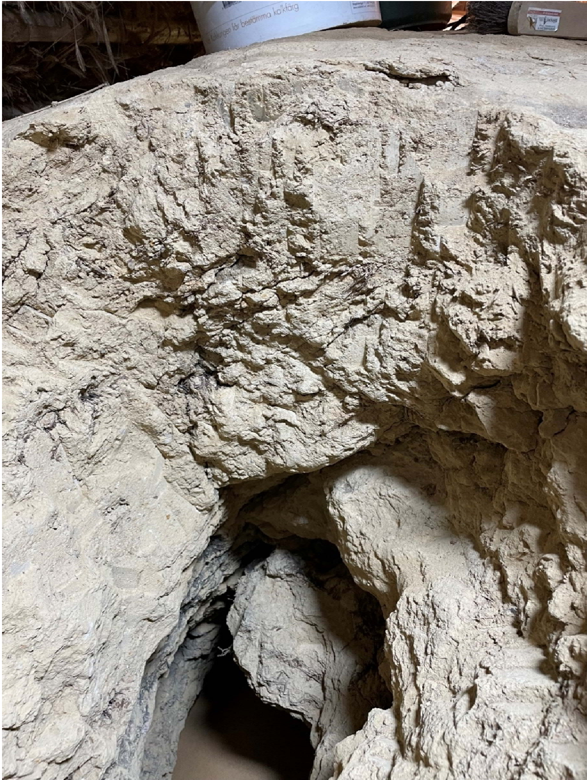
Håltagning genom bakugnen. Formen som används inne i ugnsutrymmet är synlig i botten av hålet. I genomskärningen syns att leran är skiktad med halm.
