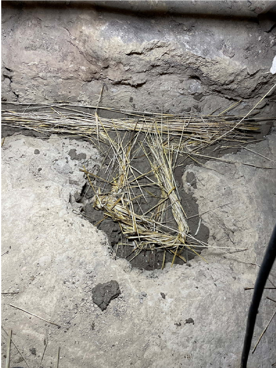
Leran armeras med halm i övergången mellan kupolen och murstocken.
