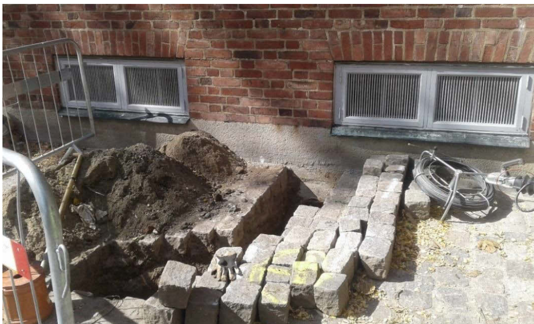
Figur 47. Vy över schaktet från sydöst, Kiliansgatan 5.
