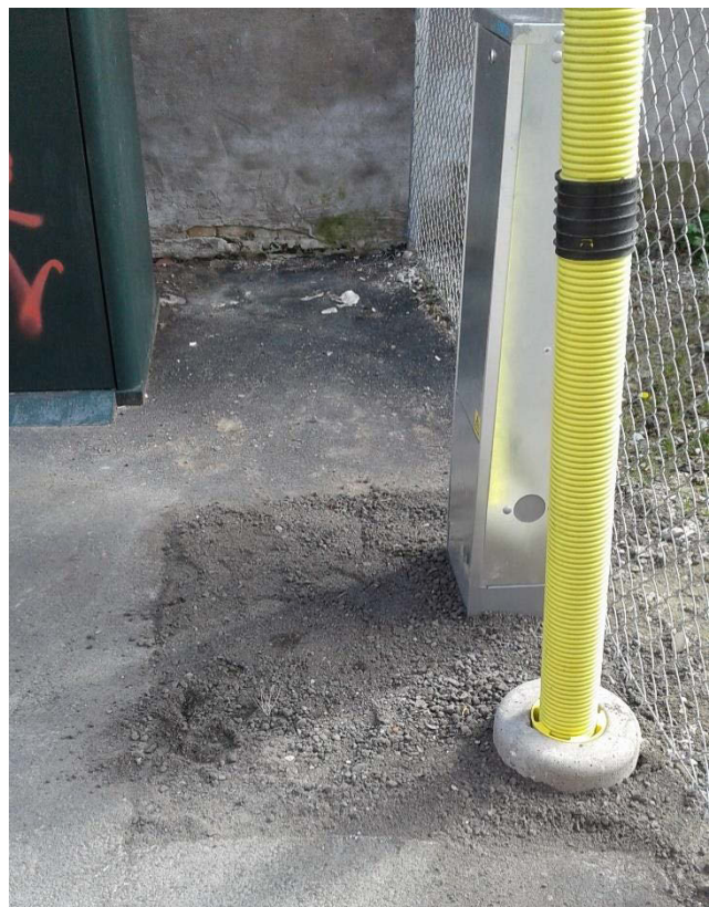
Figur 15. Foto på schaktad yta med kabelskåp och stolpe på plats.
