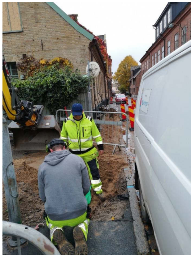
Figur 10. Vy över schaktet från öster. Personal från Krafringen har precis kopplat samman ledningar.
