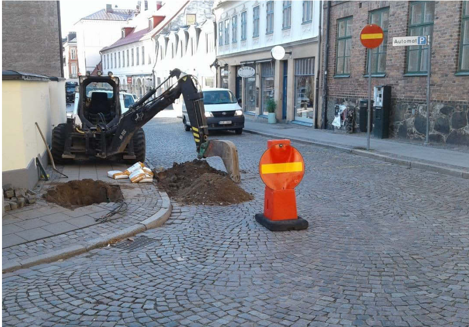
Figur 54. Vy över schaktningsarbetet från norr.
