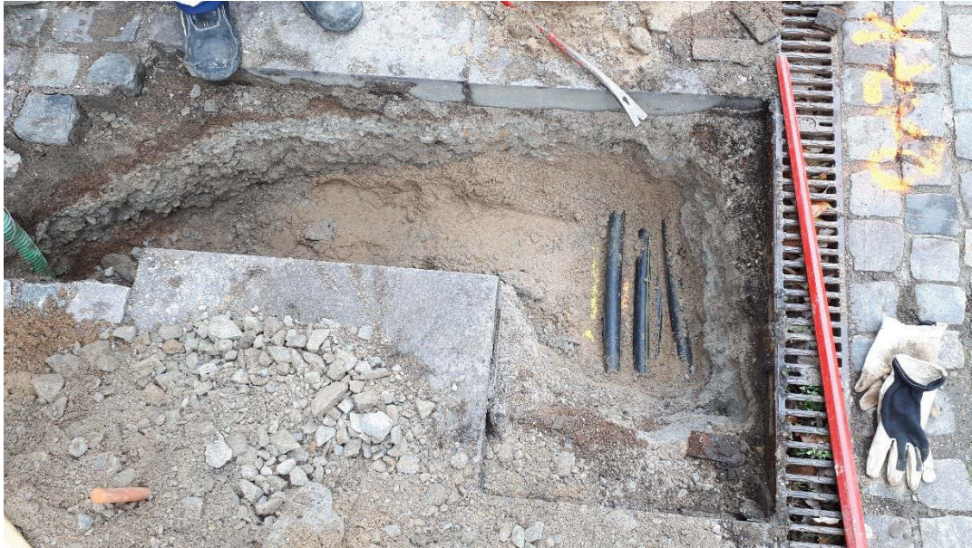
Figur 20. Schaktet sett från öster/plan med fiberkablarna till höger i bild. Kablarna ligger på ett djup av 0,50 m.
