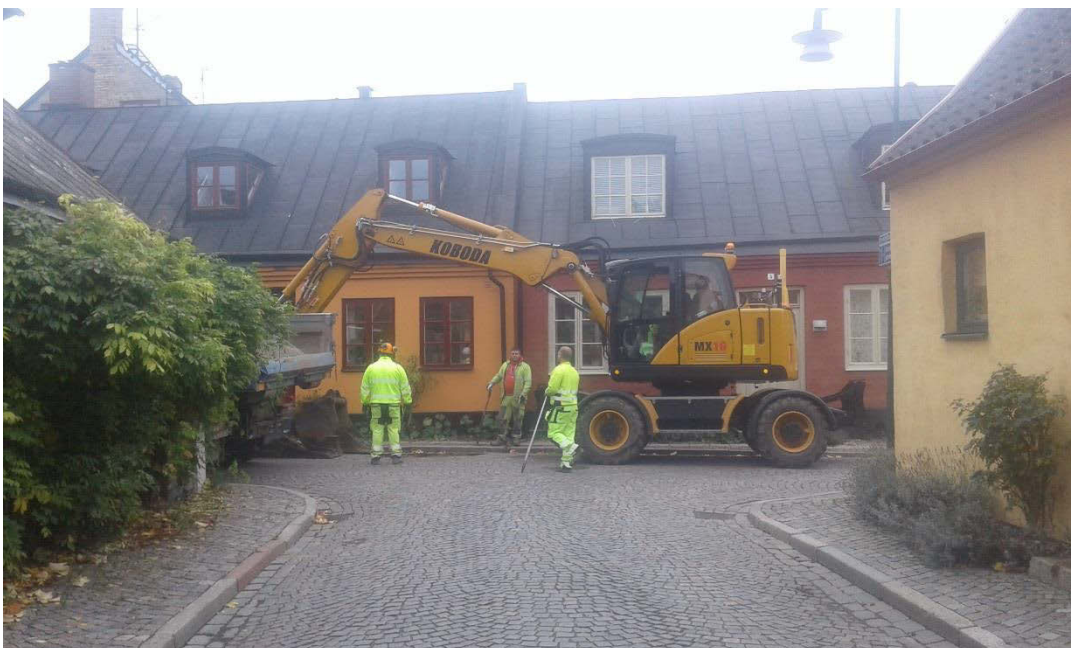
Figur 16. Översiktsbild för schakt 2 vid korsningen Stålbrogatan/Västergatan. Fotografiet taget från väster.
