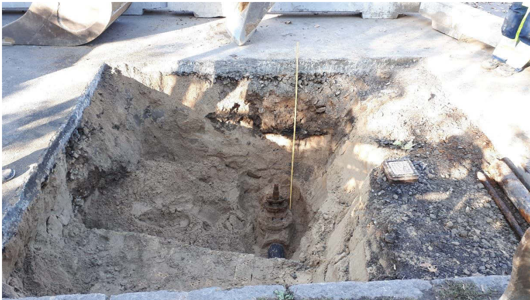
Figur 10. Vy över schaktet, fotografiet taget från söder.
