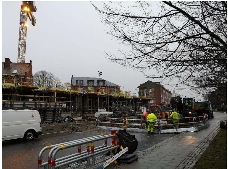
Figur 17. Översiktsfoto över schaktningsarbetet i gatan.
