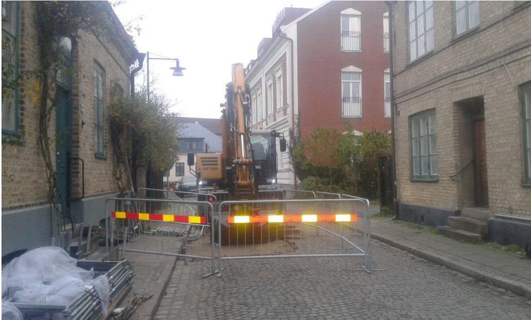
Figur 15. Översiktsbild för schakt 1 vid Stålbrogatan 4. Fotografiet taget från väster.
