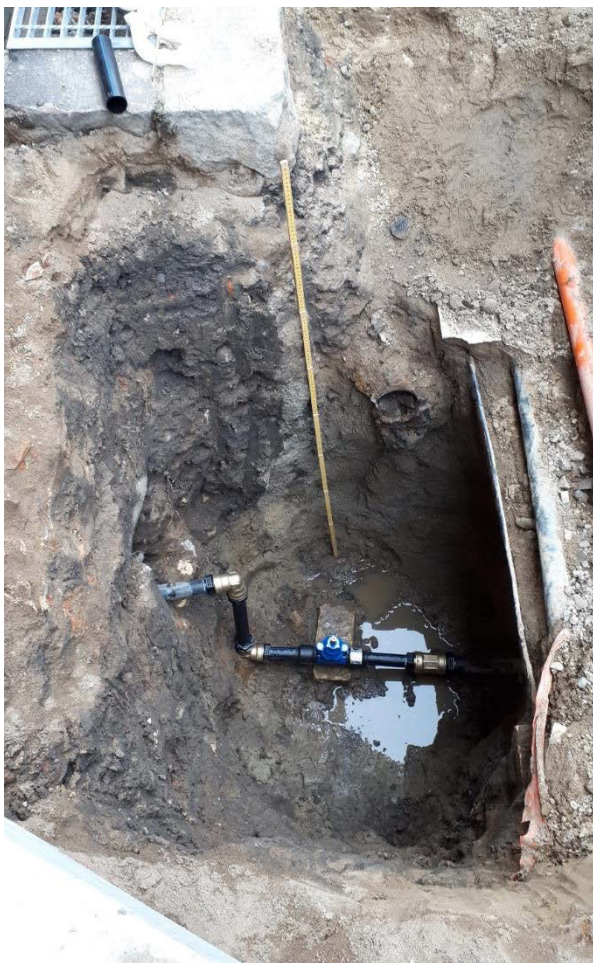
Figur 8. Vy över schaktet. Fotografiet taget ovanifrån/ från väster.
