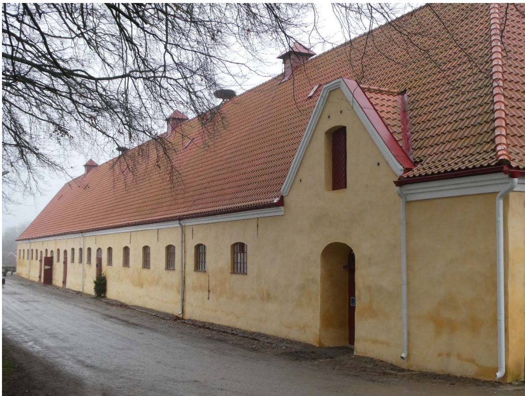
Efter åtgärder. December 2021.
