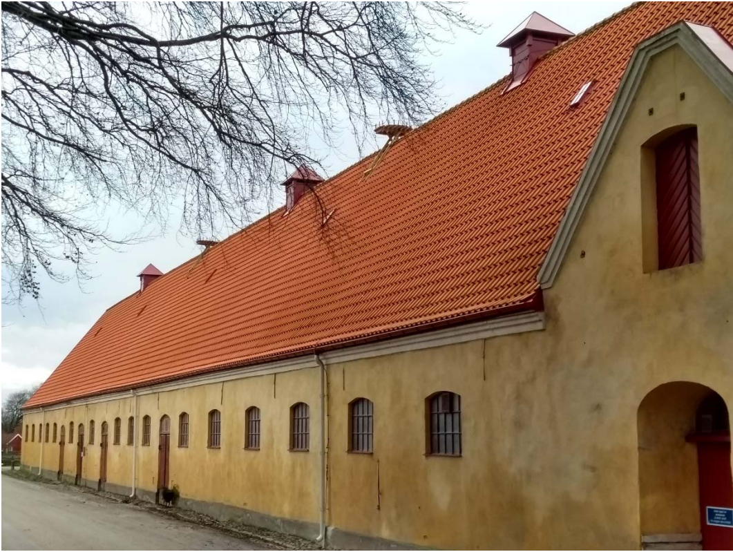
Norra fasaden före åtgärder.
