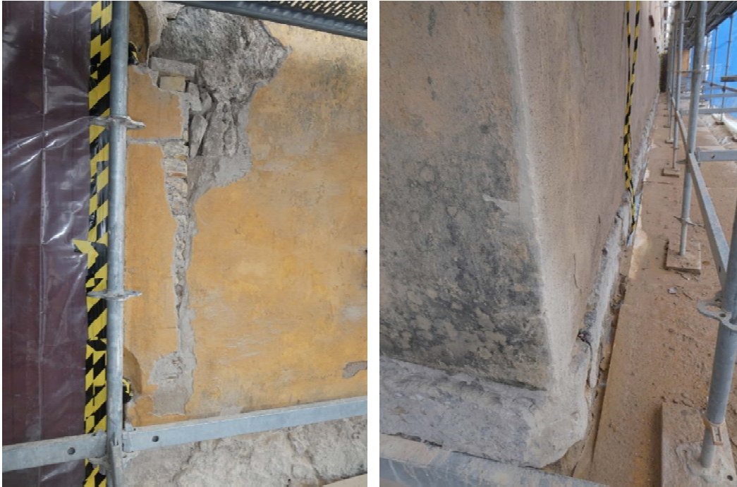
Vänster: Under arbete. Tegelomfattning kring östra porten. Höger: Putsen är nedknackad från sockeln i nordöstra hörnet.
