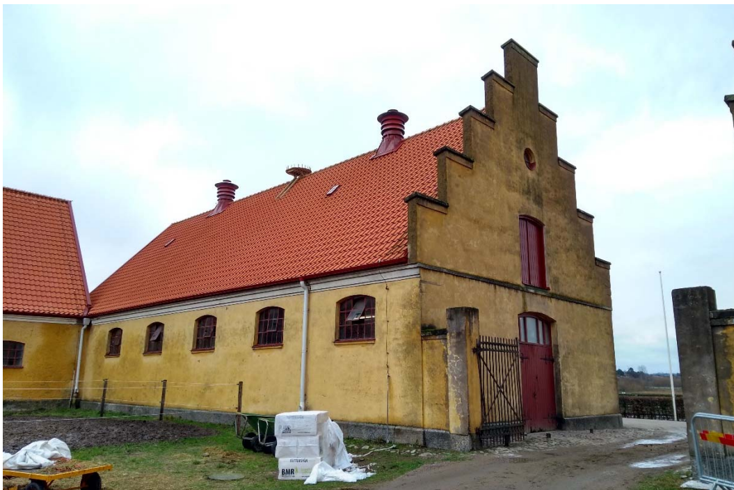
Norra kommenderingsstallet före åtgärder. Södra gavelfasaden är aktuell fasad.
