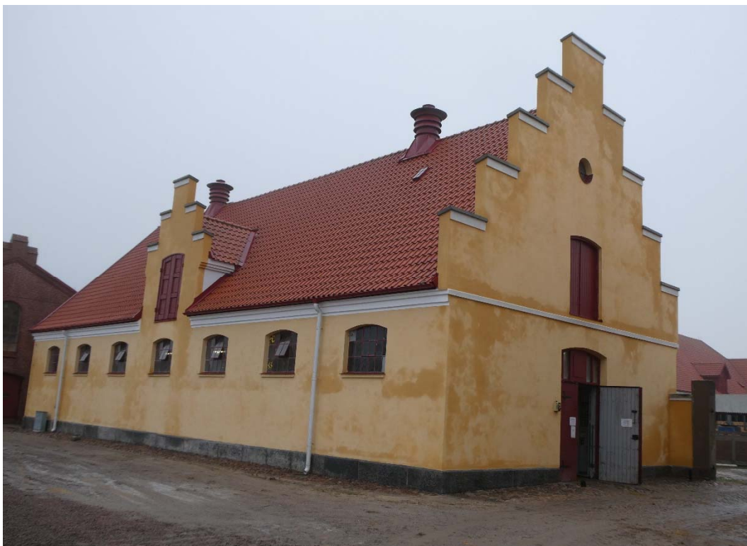
Efter åtgärder. Södra kommenderingsstallet (vid fotograferingstillfället var det mycket hög luftfuktighet december 2021).
