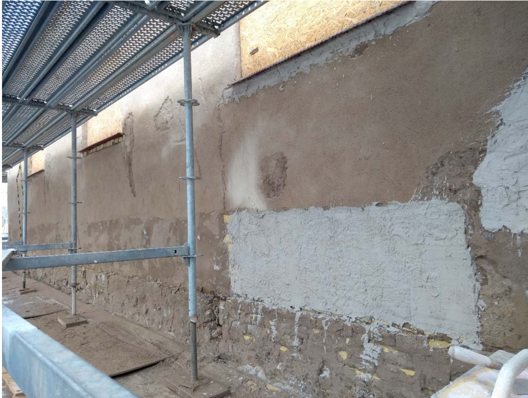
Lagningar av puts och sprickor. I fasaden syns tidigare ändrade öppningar genom igensättning med tegel. Dessa ändringar av öppningar är dokumenterade på 1980-talet.
