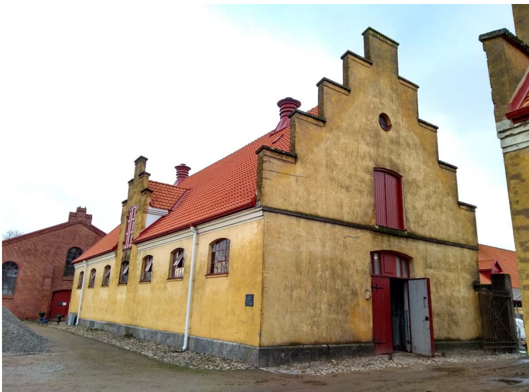
Södra kommenderingsstallet före åtgärder. Norra gavelfasaden och östra fasaden.
