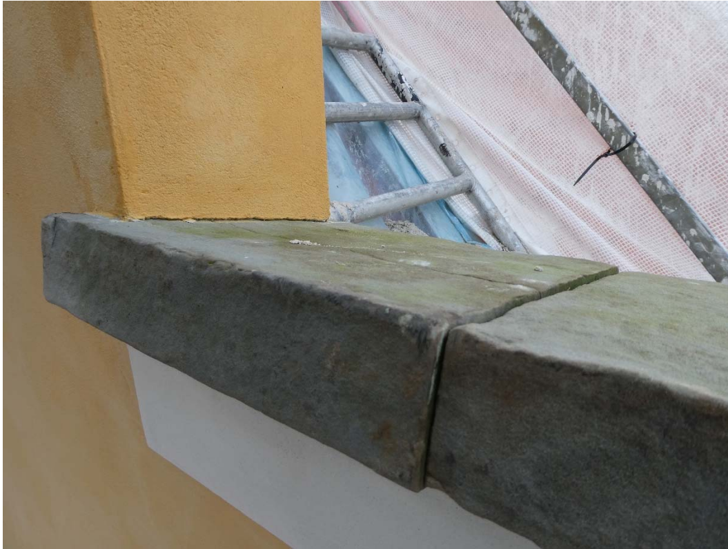
Efter att fasaden målats. På bilden täckplattorna och den underliggande vitmålade listen.
