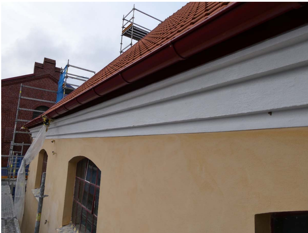
Efter att fasaden målats. På bilden täckplattorna och den underliggande vitmålade listen.
