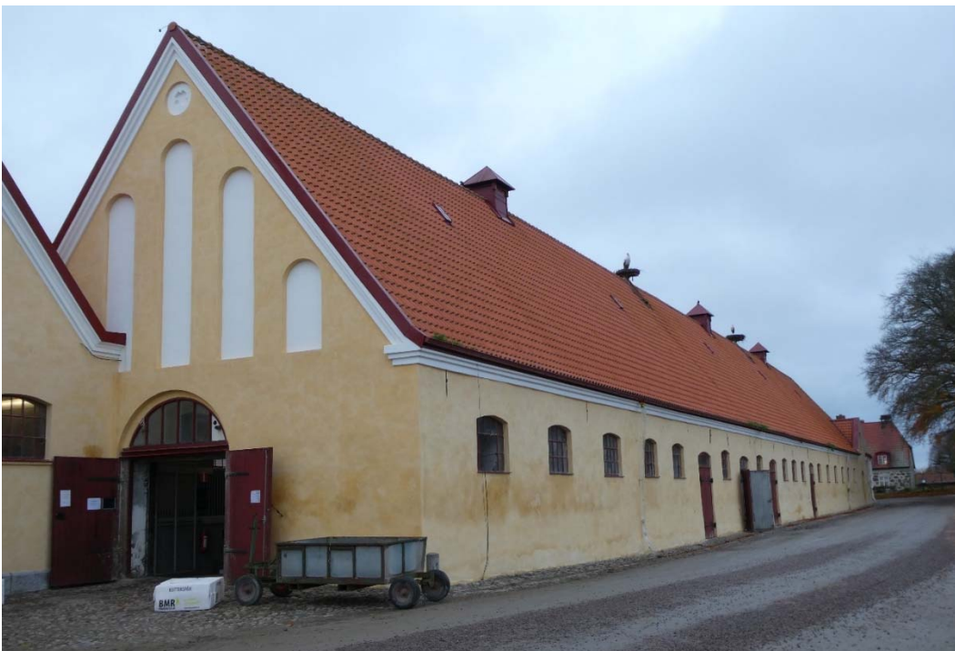
Efter åtgärder (vid fotograferingstillfället återstod att återmontera stuprören).
