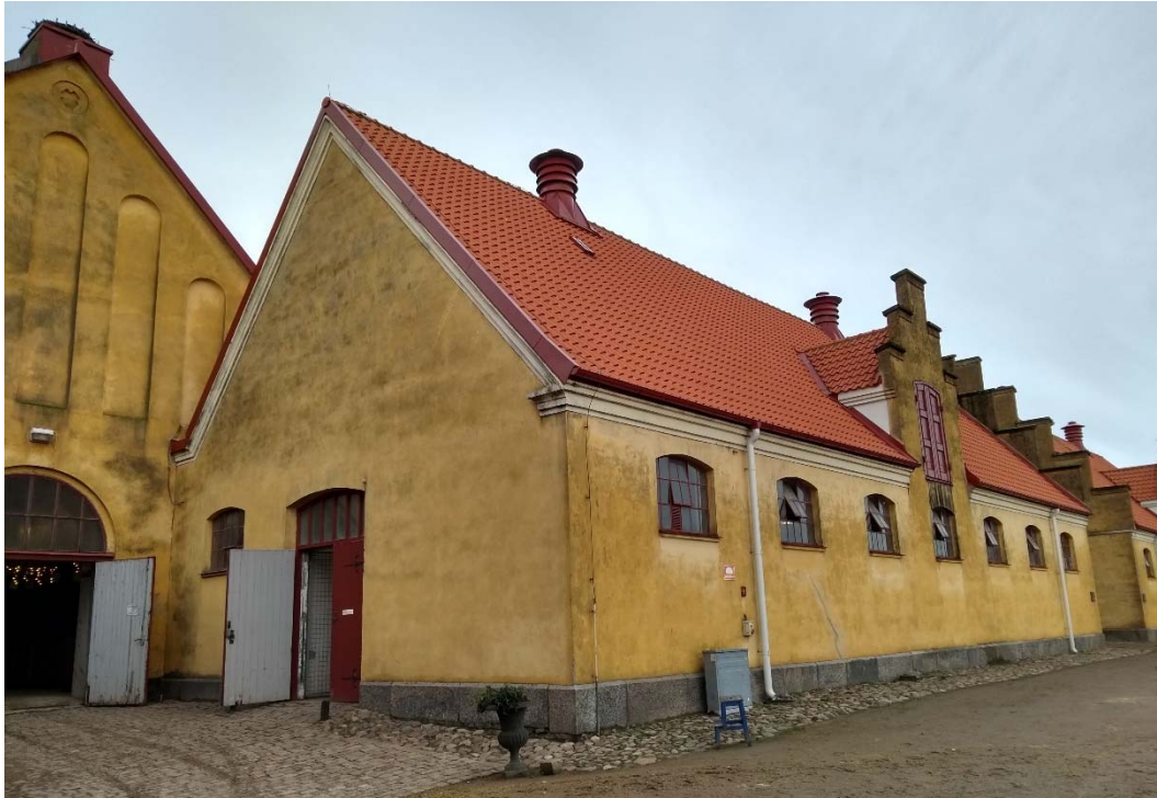
Södra kommenderingsstallet före åtgärder. Södra gavelfasaden och östra fasaden.
