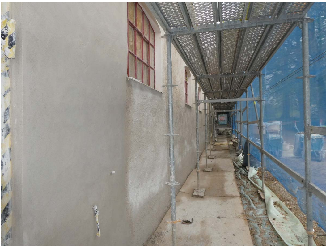
Lagningar av puts och sprickor. I fasaden syns tidigare ändrade öppningar genom igensättning med tegel. Dessa ändringar av öppningar är dokumenterade på 1980-talet.
