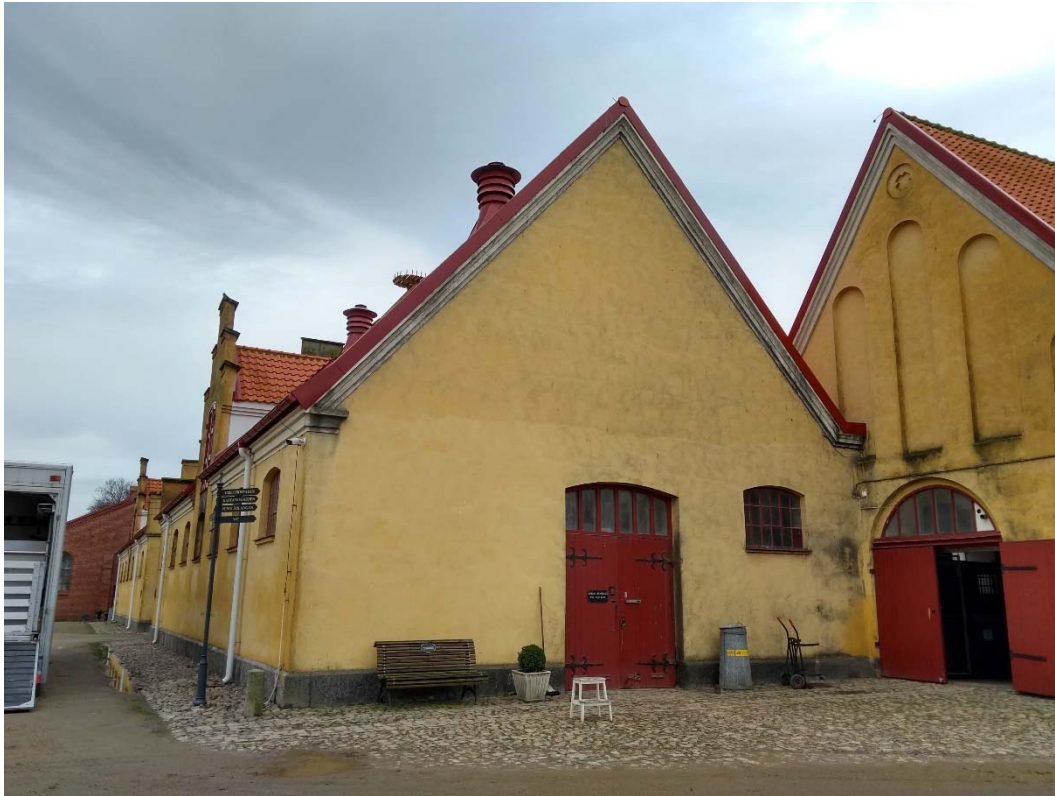
Norra kommenderingsstallet före åtgärder. Norra gavelfasaden är aktuell fasad.
