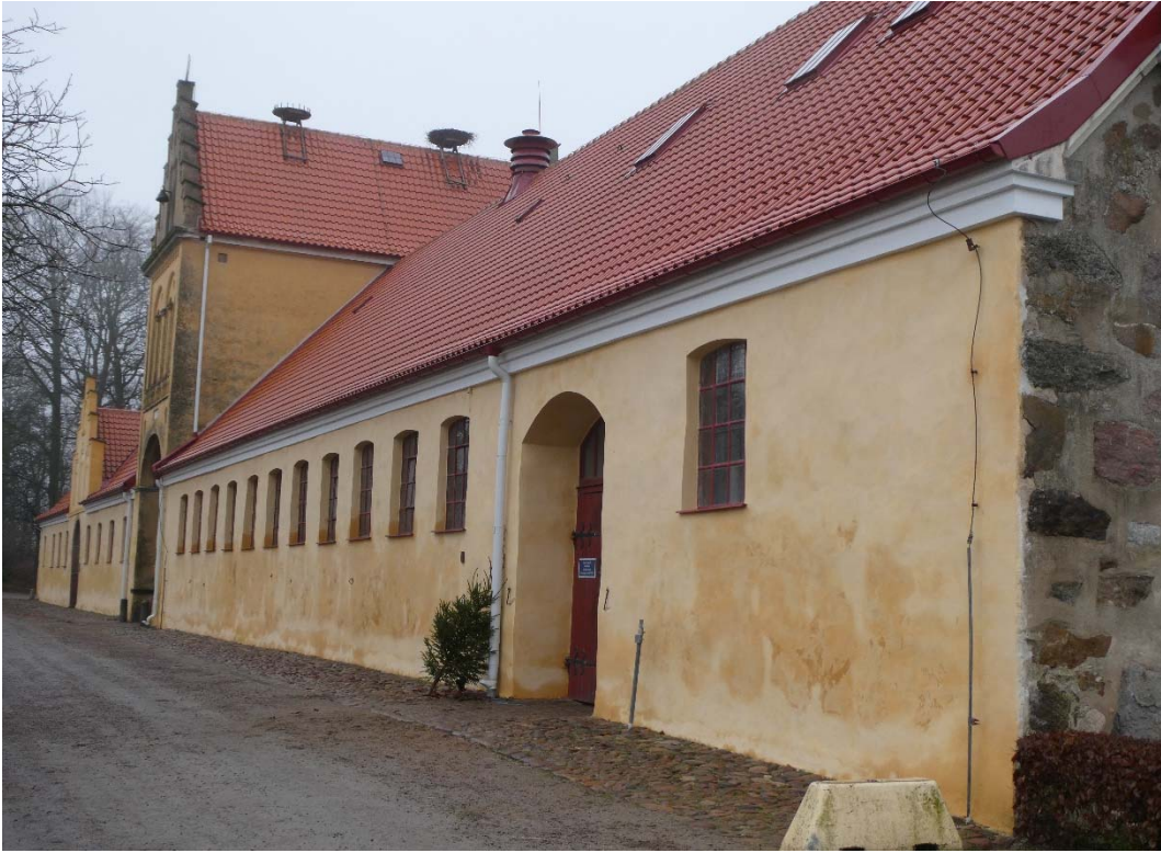
Efter åtgärder december 2021.
