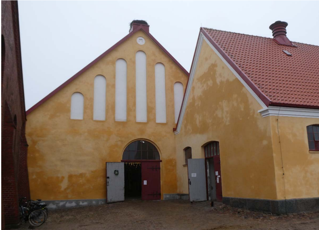
Efter åtgärder östra gavelfasaden (vid fotograferingstillfället 2021-12-13 var det mycket hög luftfuktighet).
