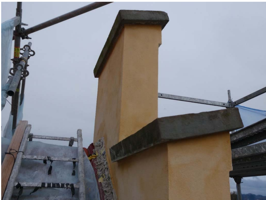
Södra kommenderingsstallet frontespis efter åtgärder.
