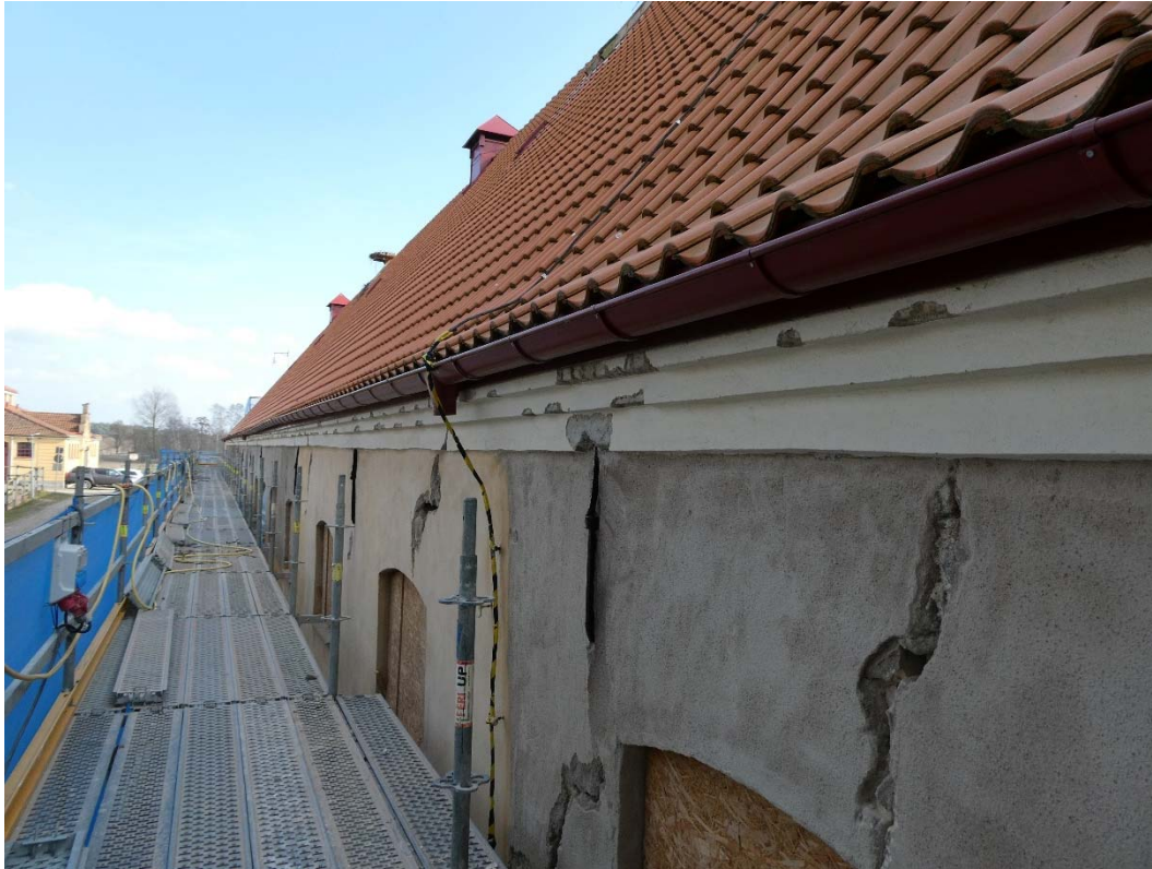
Under arbete, blästring och uppknackning av sprickor pågår.
