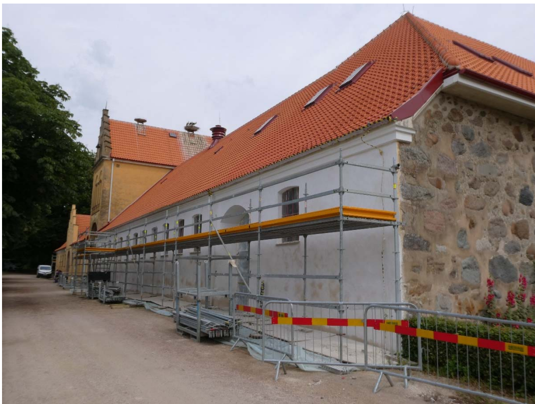
Fasaden har strukits med opigmenterad Kungskalk.
