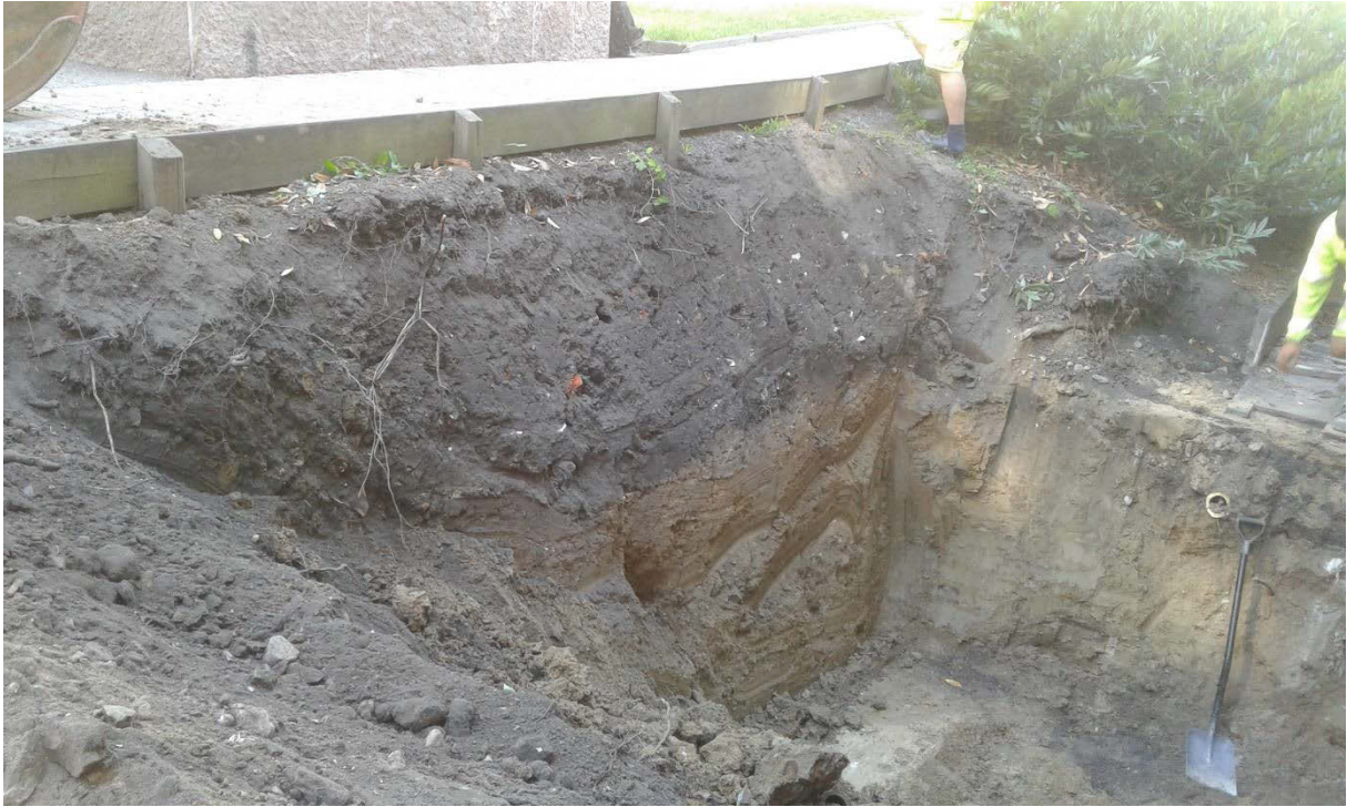
Figur 7. Den påförda växtbäddsjorden i schaktets västra kant.
