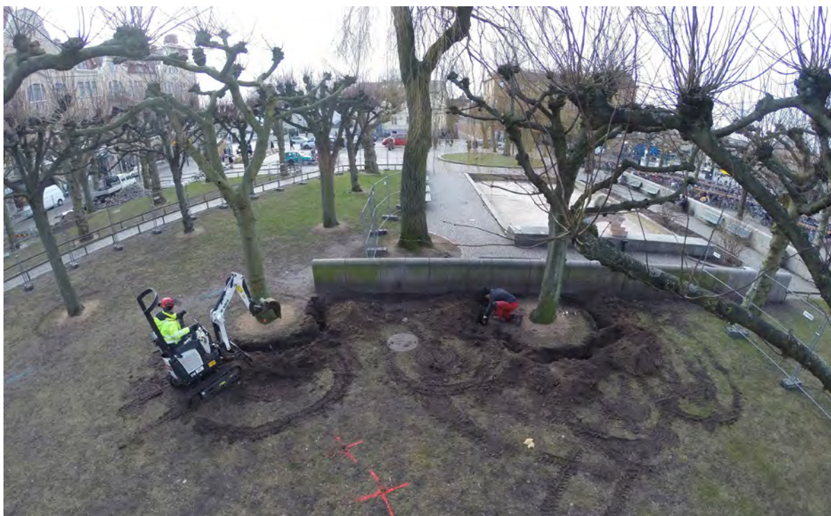
Clemenstorgets nordöstra del mot söder. Liten grävmaskin förbereder flyttning av träd.
