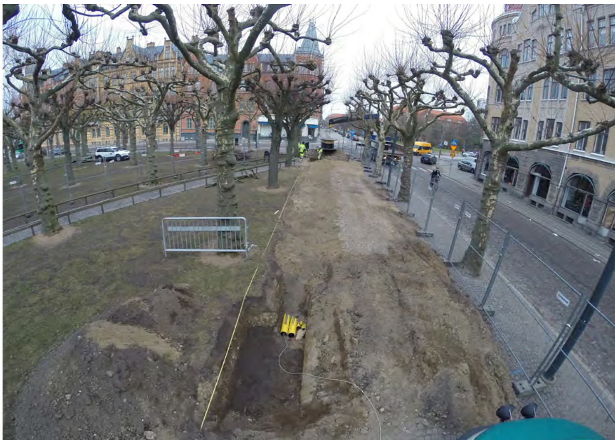
Clemenstorgets östra sida mot norr. Ledningsschakt i N-S riktning.
