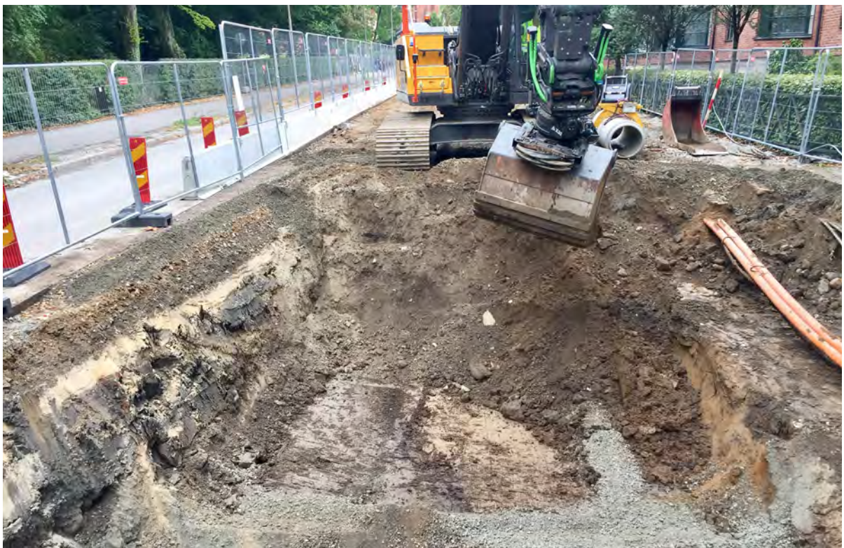
Schakt i mellersta delen av S:t Laurentiigatan. I botten av schaktet avtecknar sig den inre och södra nedgrävningskanten för stadens vallgrav.
