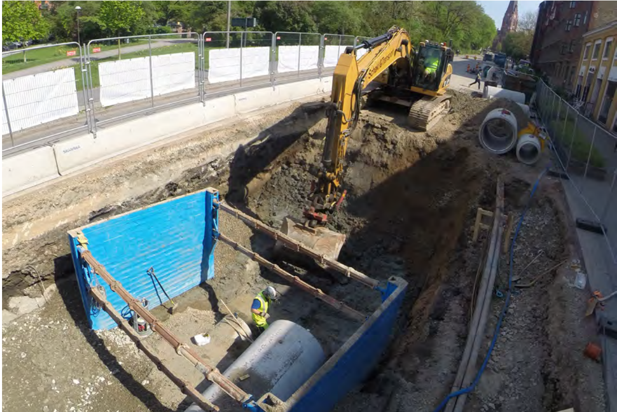
Schakt i södra delen av S:t Laurentiigatan. Schaktningarna genomfördes till ett betydande djup. Av säkerhetsskäl användes en tillfällig spontlåda i det nygrävda schaktet. Bra för säkerheten men samtidigt ett hinder i den arkeologiska dokumentationen.
