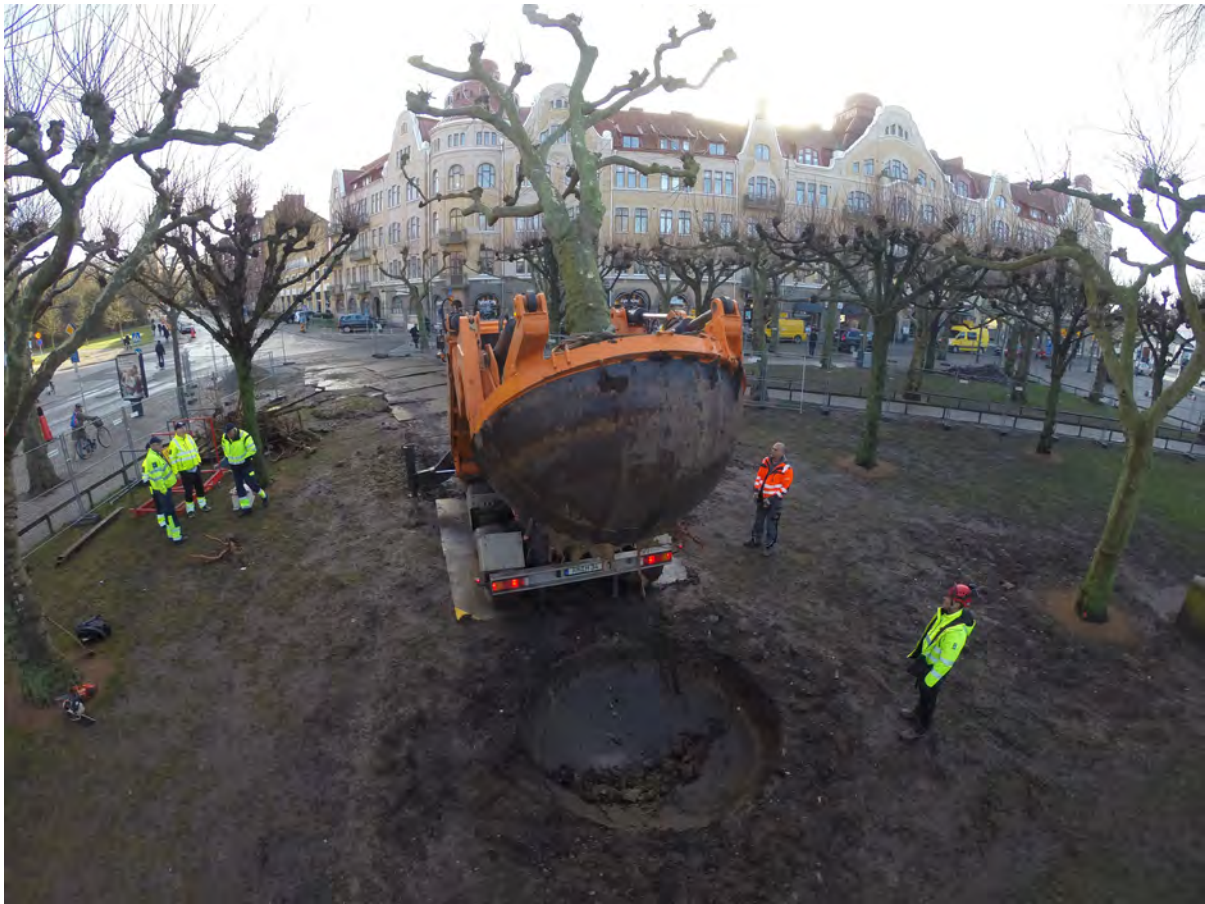
Clemenstorgets nordöstra del mot öster. Den speciella trädflyttningsskopen har lyft upp ett träd.
