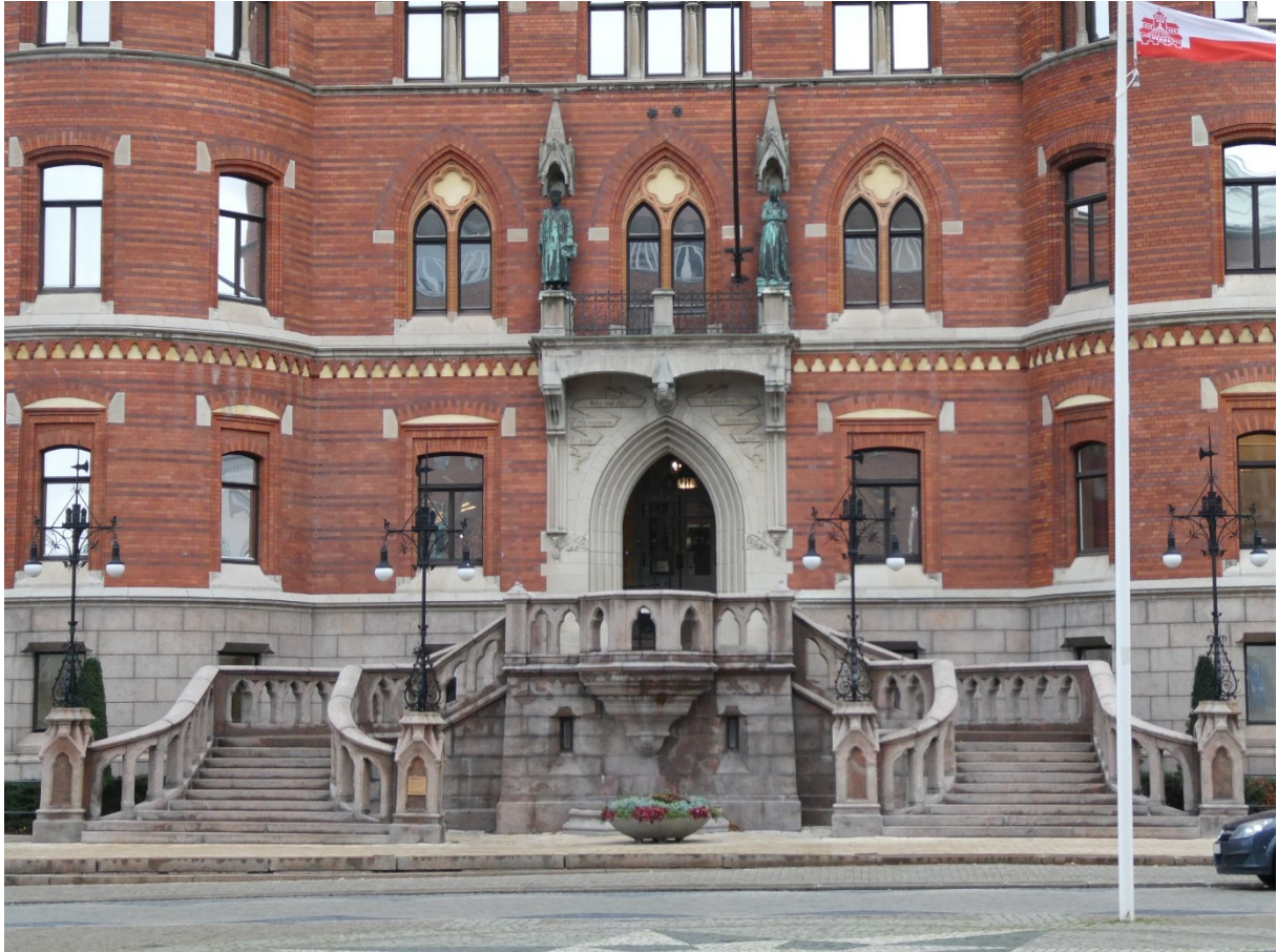
Trappa och portal med balkong och fasadskulpturer.
