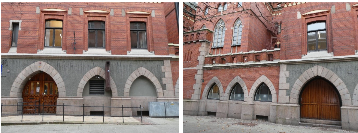
Vänster: Södra flygelns port. Höger: Norra flygelns port samt fönster i parterrvåningen som är utbytta. På bilden ser man även de stora masverksfönstren med glasmålningar i trapphuset.
