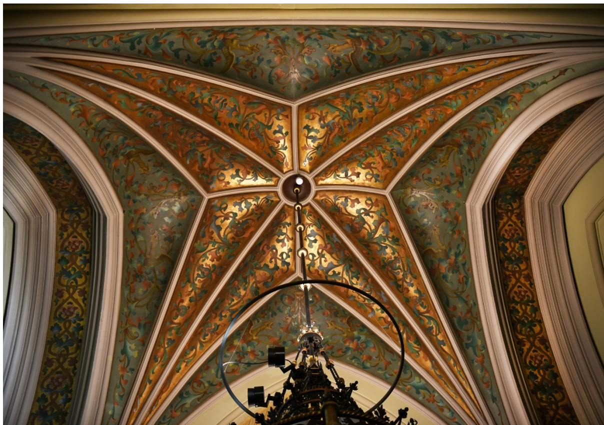
Taket i Vigselrummet.
