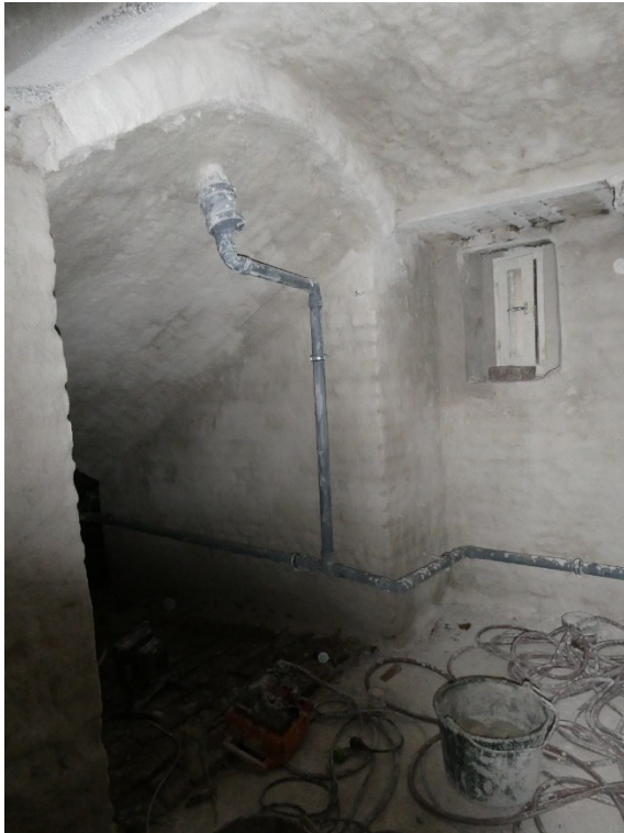
Utrymme under den utvändiga södra trappan. Renoverades 2020.
