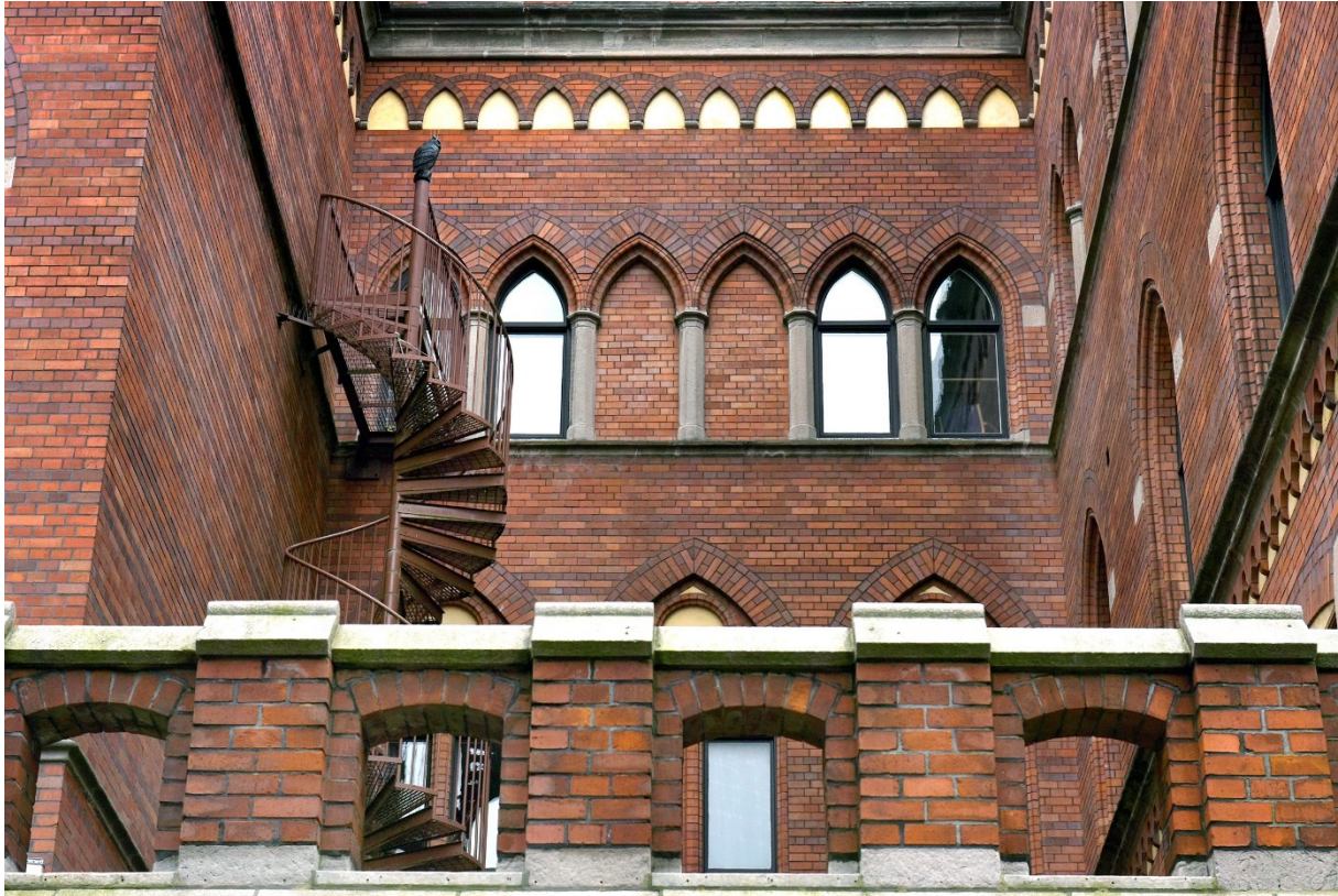
Fasadparti mellan norra och mittersta flyglarna, sentida brandtrappa.
