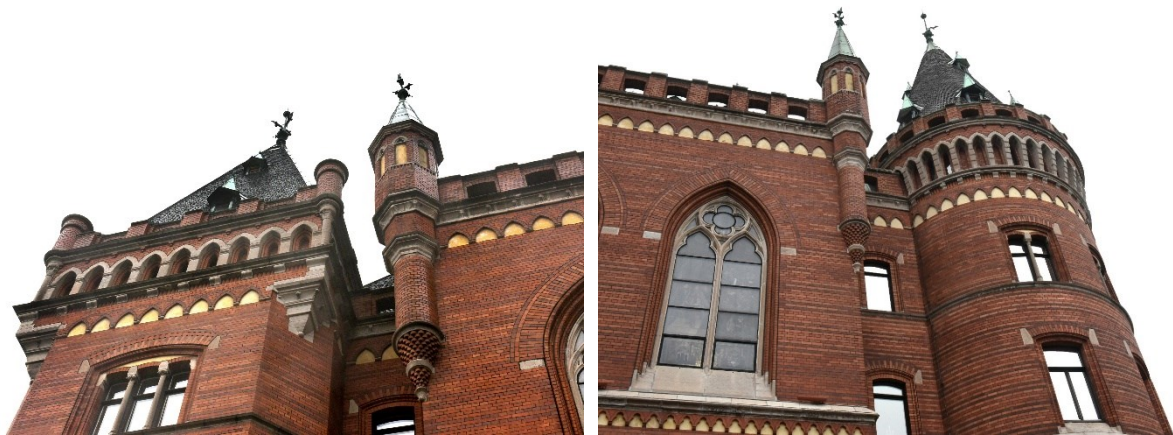
Västra fasaden, takfot och turell vid övergång mot nordvästra respektive sydvästra tornet.
