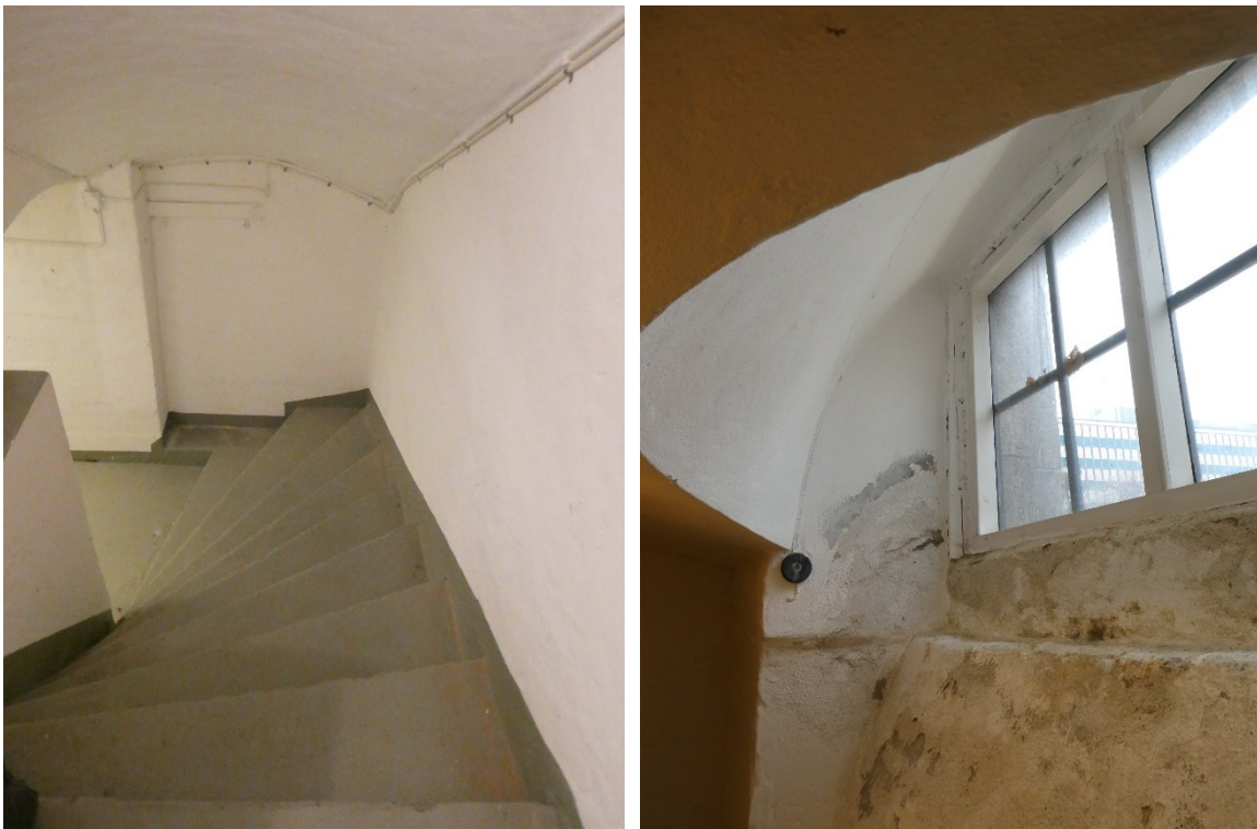
Trappa i norra delen av rådhuset till källaren samt exempel på valv i källaren.
