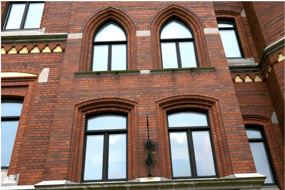
Fasadteglets mönsterverkan och listverk i natursten samt olika fönstertyper, norra fasaden.
