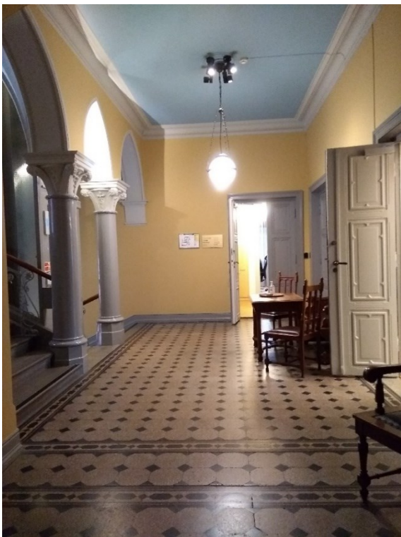
Trappa och trapphall våning 3. Terrazzogolv och gjutjärnspelare. Notera hisschaktet mitt i trappan.
