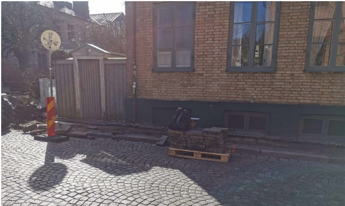
Figur 4. Översiktsfoto av schakt för el i trottoaren till Magle Stora Kyrkogata, kv Maria Magle 6 i bakgrunden. Foto taget från norr.
