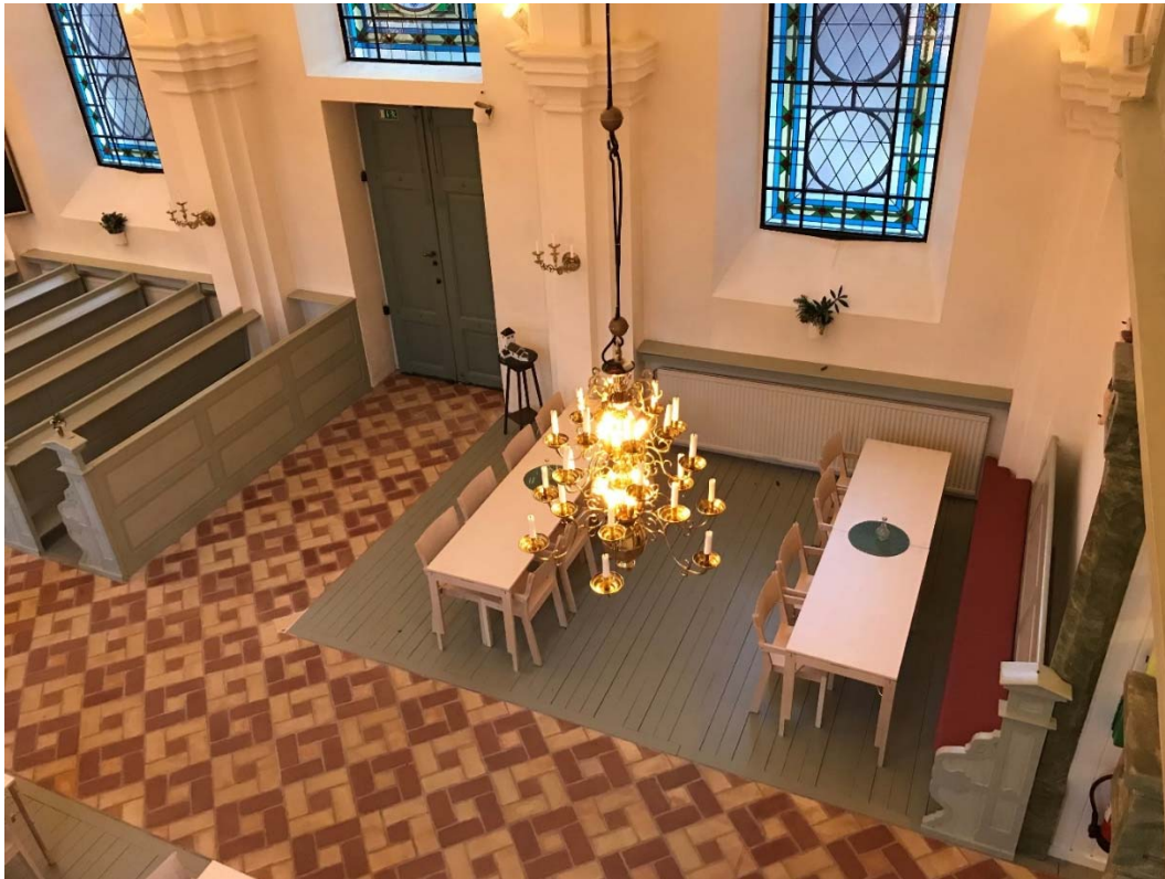
Efter åtgärder långhuset.
