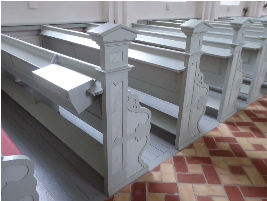
Före åtgärder. Norra bänkradens som tagits bort och det gamla tekniskåpet.
