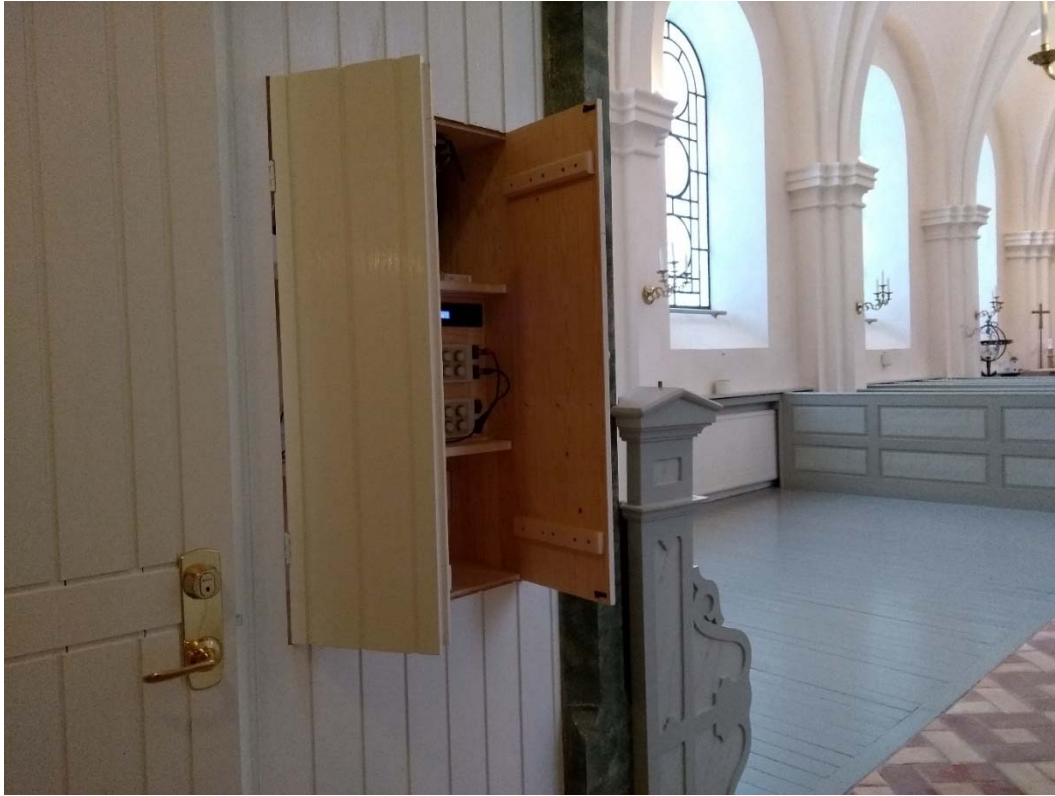
Efter åtgärder. Nytt infällt teknikskåp i korridoren.
