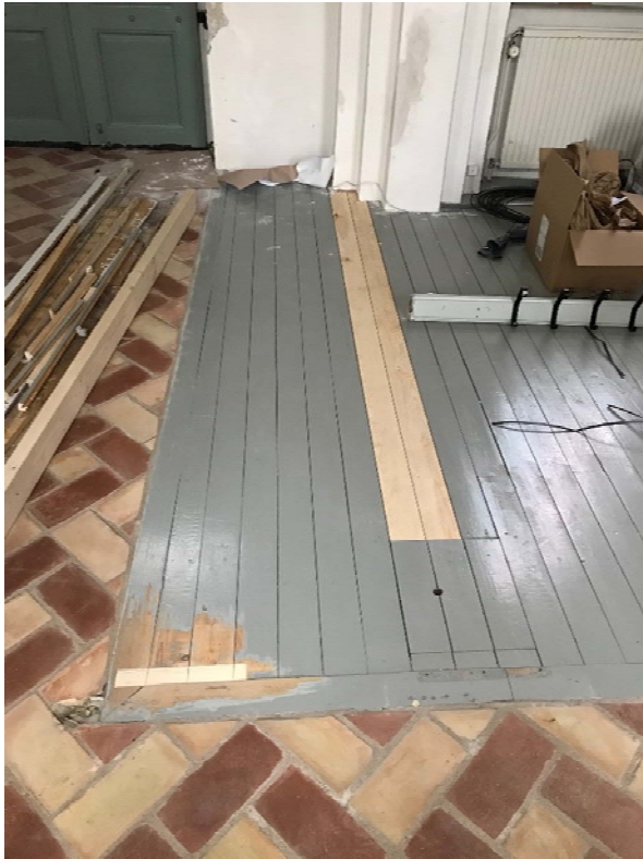
Under arbete. Vänster: Lagning av trägolv och en tegelsten i hörnet. Höger: nytt teknikskåp under byggnation.
