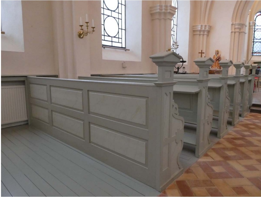
Efter åtgärder. Bänkfront som flyttats till bakre kanten av norra bänkraden.
