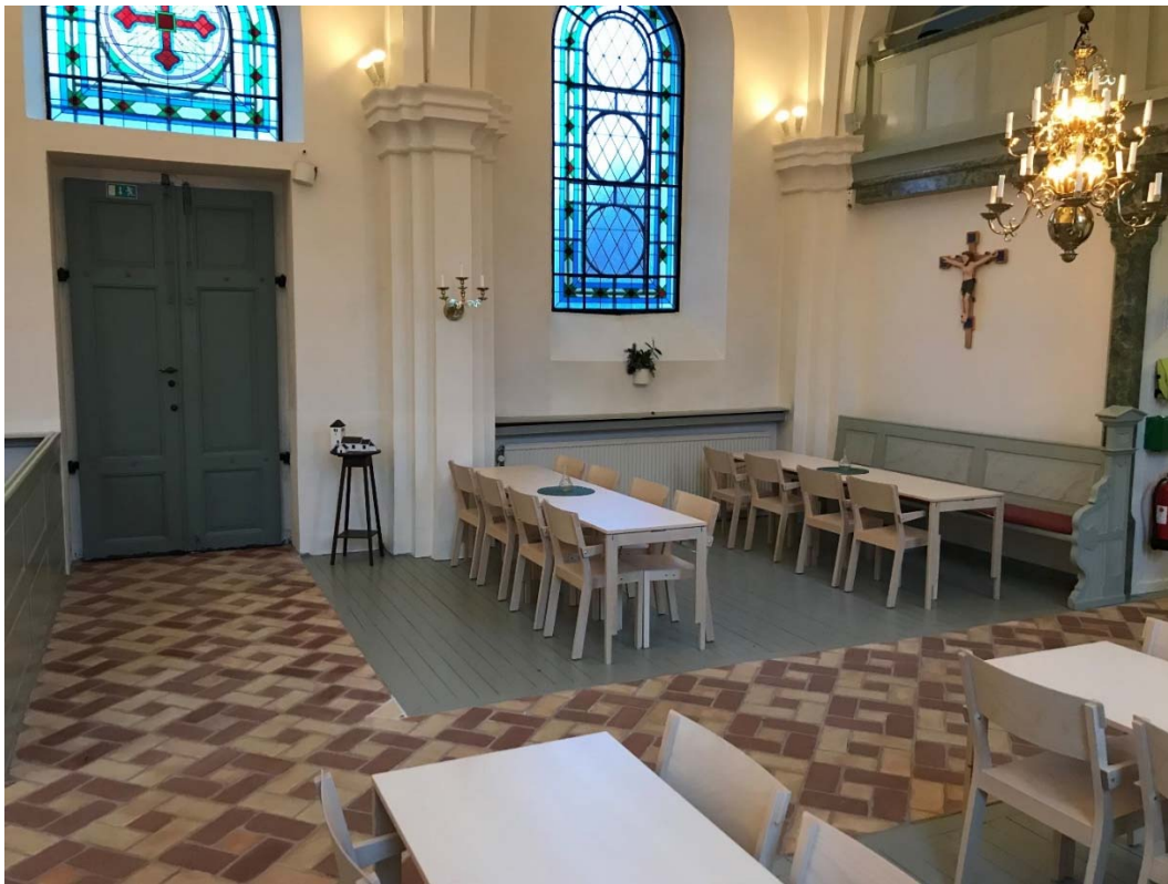
Efter åtgärder långhuset.
