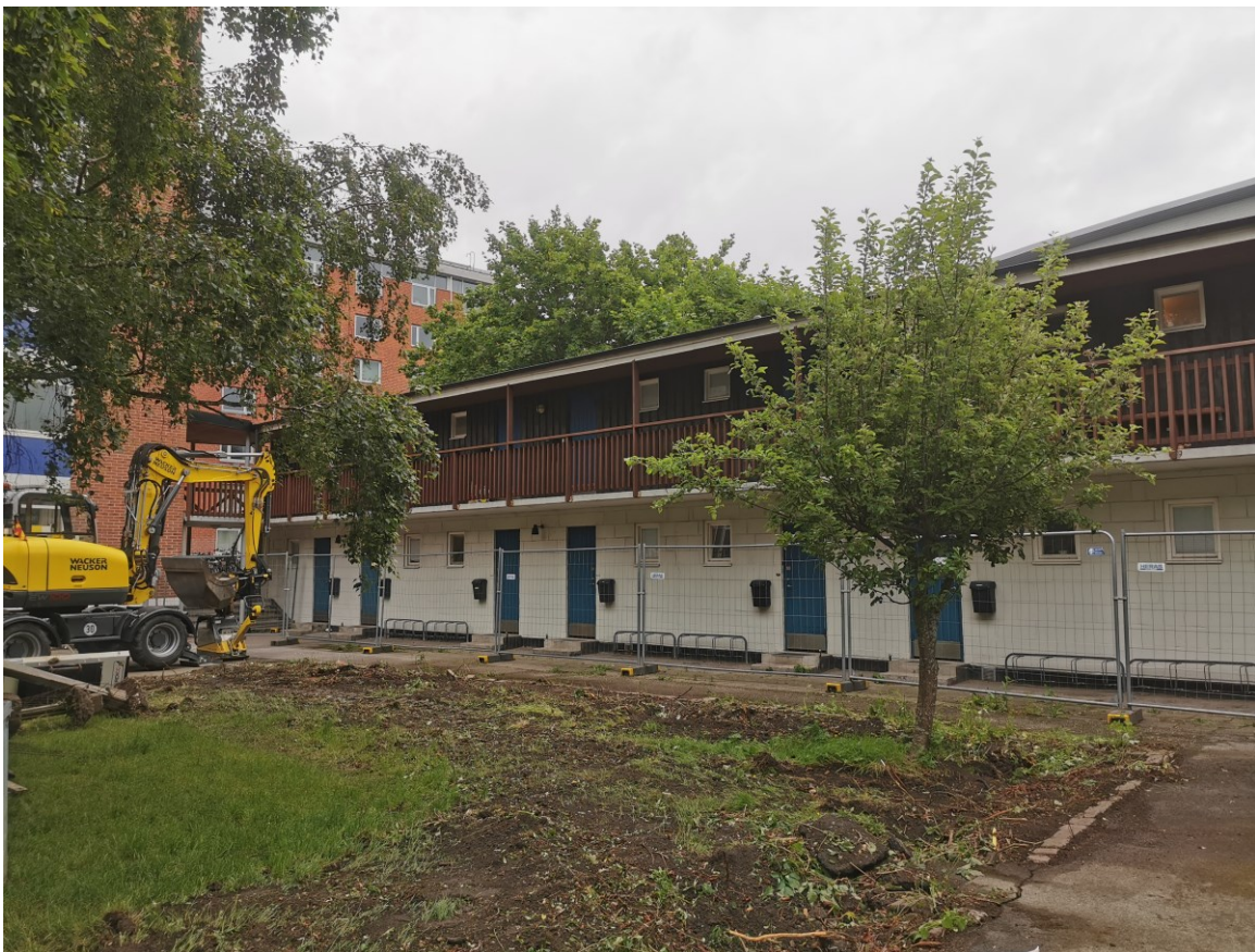
Figur 6. Översikt på innergårdens nordöstra del i kv Gylleholm 15. Fotografiet sett från sydväst.
