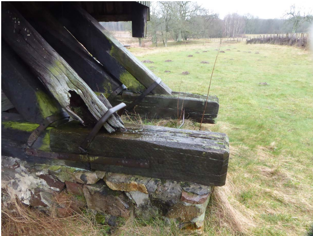
Rötskadade fotträn och fotstivor på den södra fotpallen. Vy mot norr.
