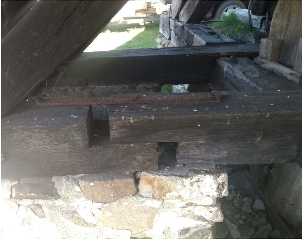
Skarvat fotträ som hålls ihop av järn.
