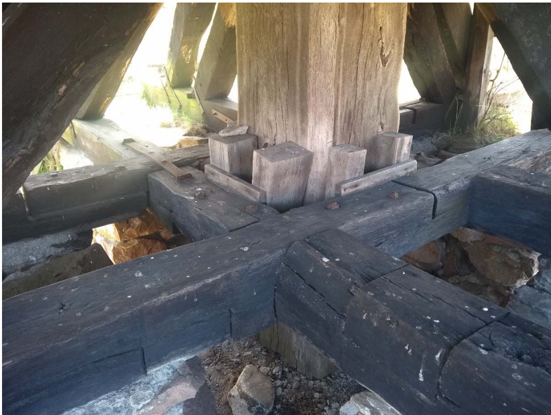
Fotstivor och kryssfot med foträn. Östra och västra fotpallen. Vy mot väster.
