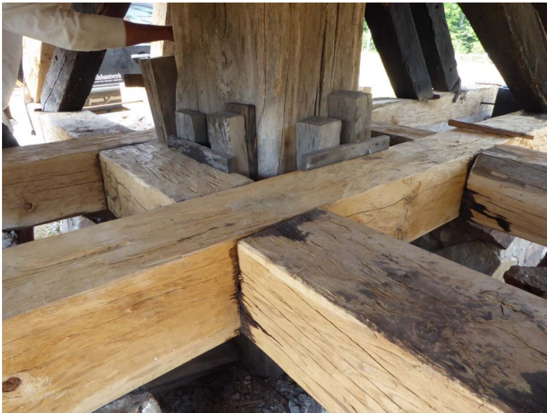
Kryssfoten lagd halvt i halvt. Kilarna mot stubben har återanvänts.
