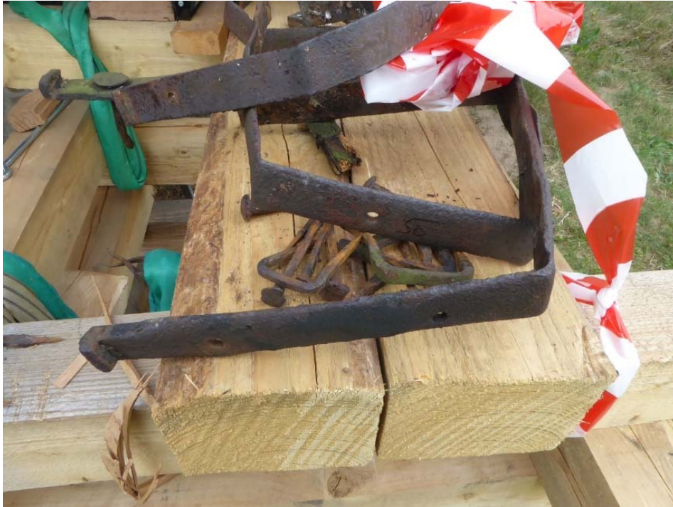
Hillor tillverkade av vagnsjärn, märlor och smidd spik. Dessa återanvändes.
