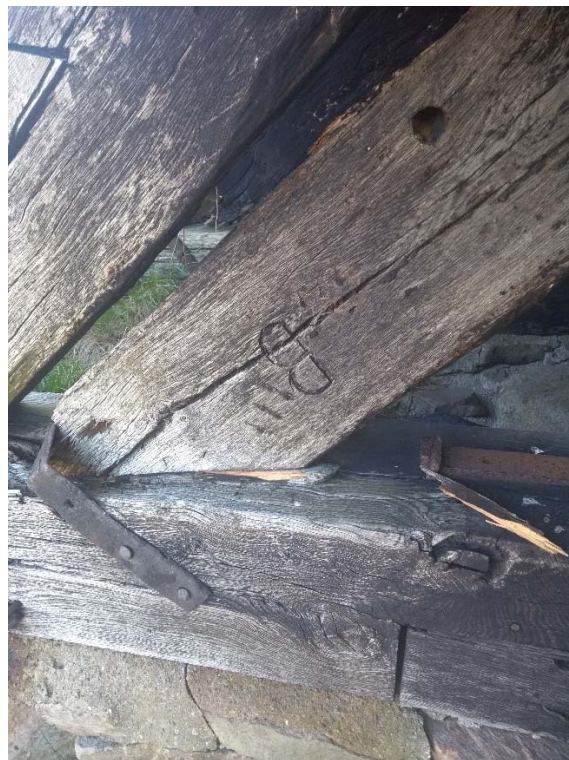
Kraftigt rötskadad fotstiva på den västra fotpallen. Vy mot öster.
