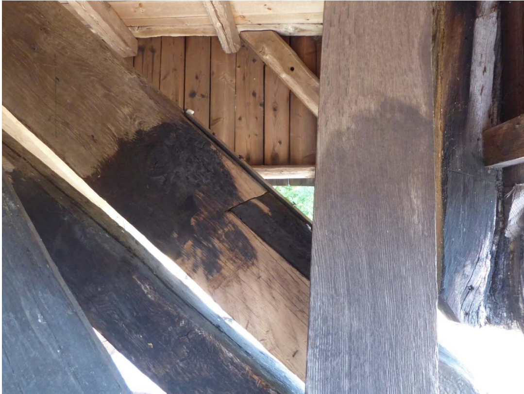
Längdskarvning av en av de södra fotstivorna där virket återanvänts.
