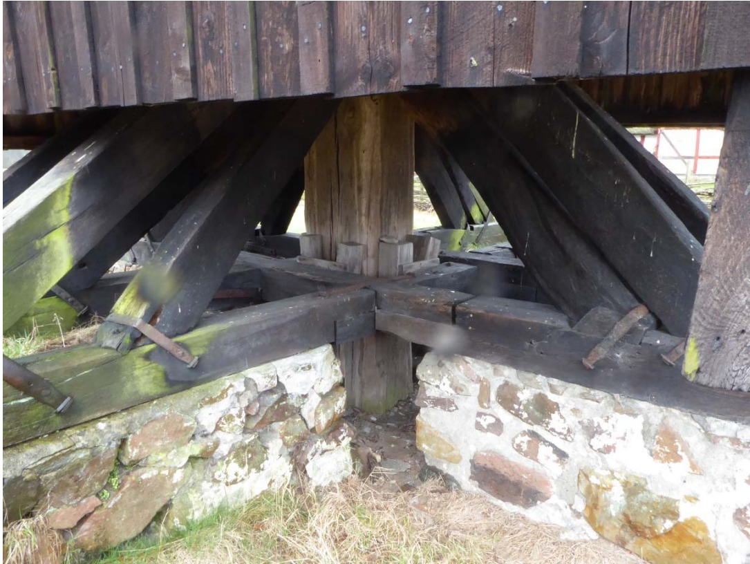
Fotstivor och kryssfot med foträn. Östra och västra fotpallen. Vy mot väster.
