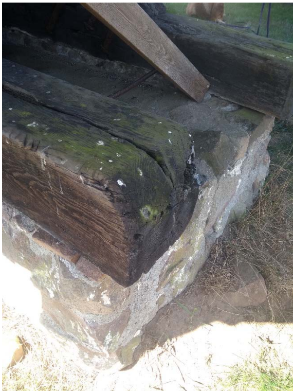
Kraftigt rötskadad fotstiva på den västra fotpallen. Vy mot öster.
