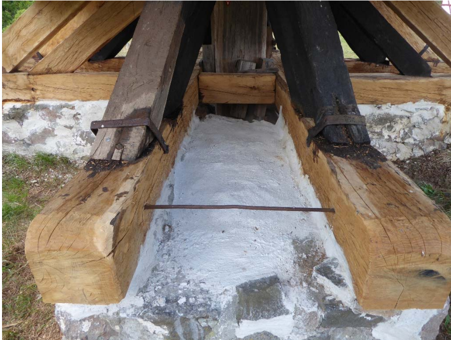
Fotträn med avfasade ändar. Stenfoten kalkad.
