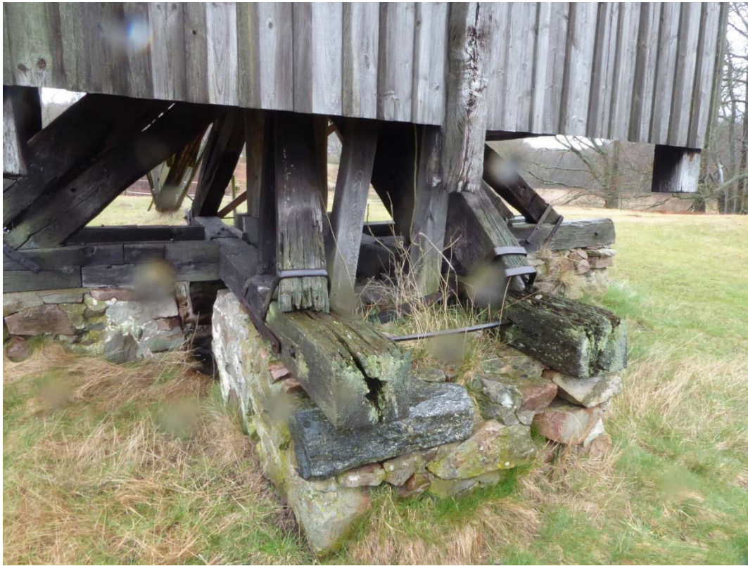
Rötskadade fotträn och fotstivor på den södra fotpallen. Vy mot norr.
