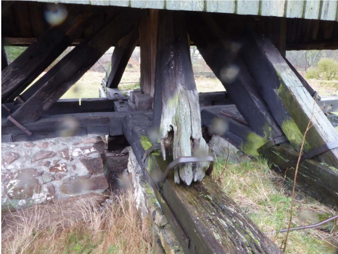
Kraftigt rötskadad fotstiva på den västra fotpallen. Vy mot öster.
