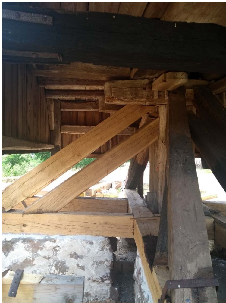
Fotträn med avfasade ändar. Stenfoten kalkad.
