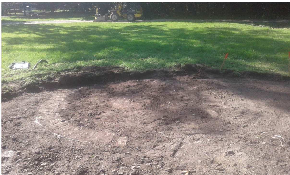
Figur 8. Fotografi från norr med tegelstensfundamentet till södra instrumenthuset exponerat i schakt 1.
