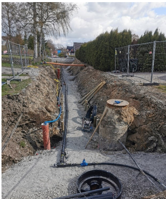
Figur 10. Schakt i Håstad skolväg, fotografiet taget från söder.
