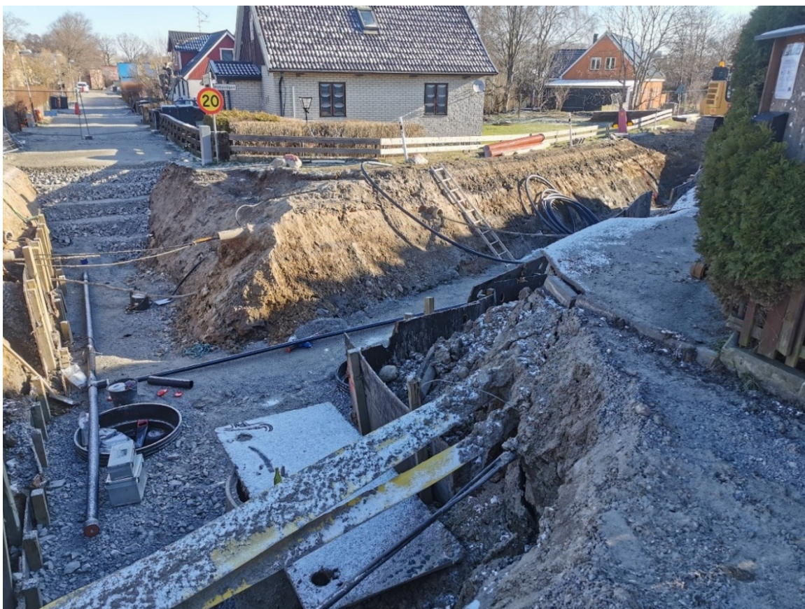
Figur 9. Korsningen där Håstadmöllvägen, Hobyvägen och Håstad skolväg möts. Schakt i Hobyvägen syns till höger i bild. Fotografiet taget ifrån söder.
