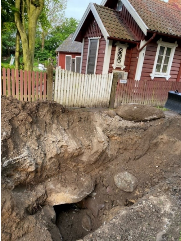
Figur 13. Håstad bygata 1. Kulvert för bäcken påträffades vid 0,60 till 1 m djup under markytan. I bakgrunden ses Banvaktstugan. Fotografiet taget från nordost.
