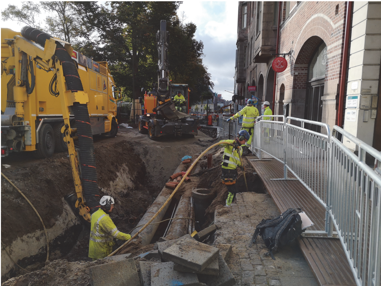
Figur 6. I området för schakt 2/3 fick jordsug tillämpas där moderna fyllningsmassor förekom rikligt kring rör. Fotografiet taget från norr.
