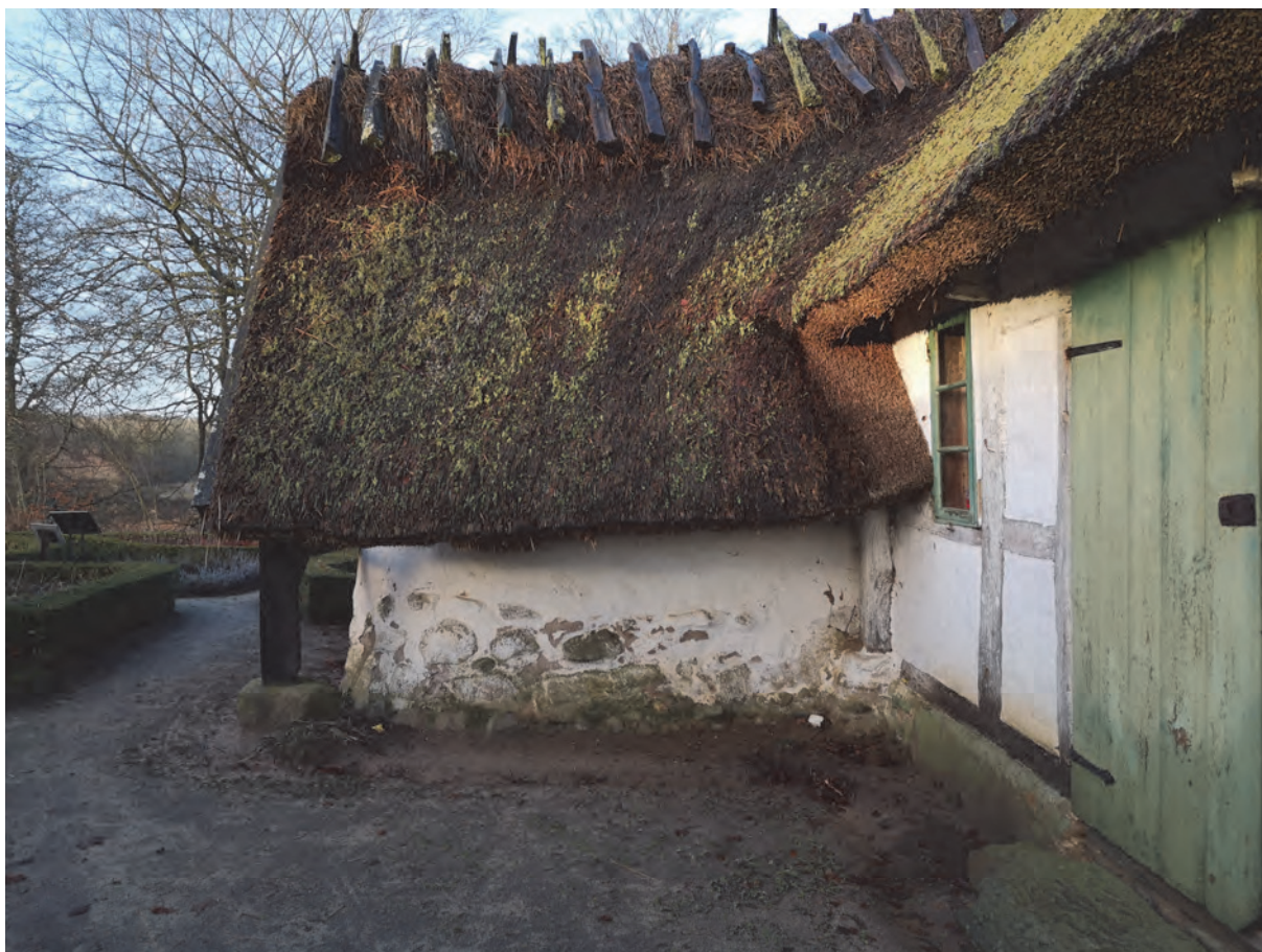
Figur 14. Illarens utbyggnad på byggnaden med ett stolpburet tak. Stolparna vilar på större syllsten. Fotografi mot väster på utsidan av Gamlegård
