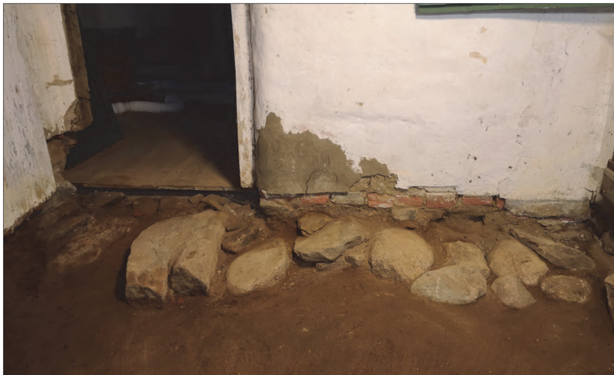
Figur 8. En stensyll i nord-sydlig orientering dokumenterades i nordvästra delen av UO. Stensyllen har ej med befintlig byggnads vägg att göra, utan stammar snarare från en äldre bebyggelse. Fotografi åt väster.
