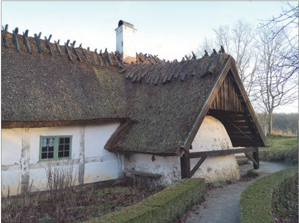
Figur 7. I utrymmet innanför den utskjutande delen Illaren på Gamlegård genomfördes den arkeologiska schaktningsövervakningen år 2021–2023. Fotografi från sydväst i januari 2023.
