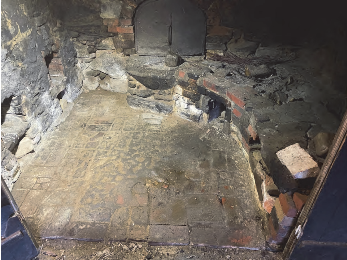
Figur 10. Illaren före borttagning av befintligt golv och sanering i december 2022, Etapp II. Fotografi taget mot söder, Lars Salminen.
