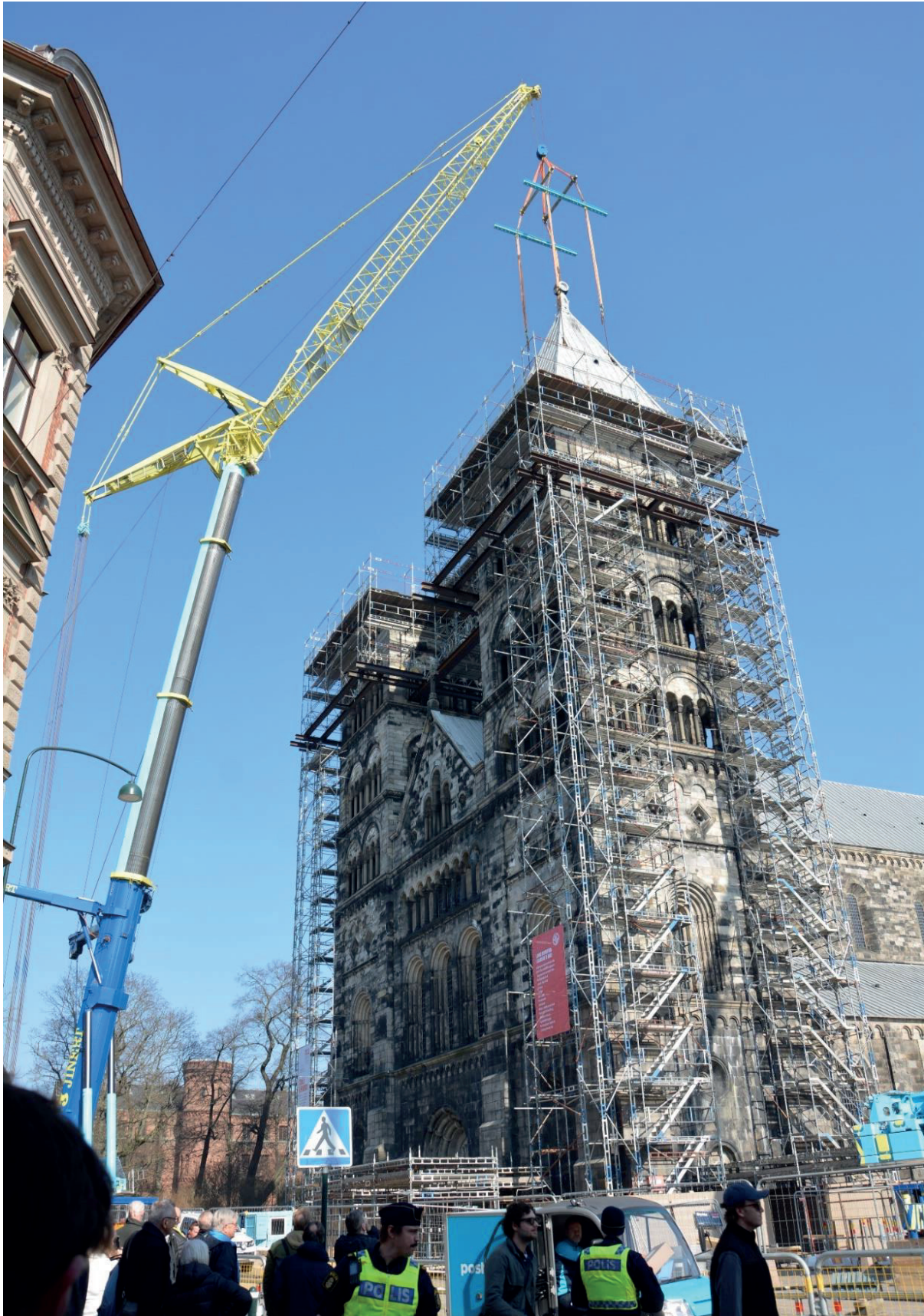
Figur 32. Kran förbereds för lyftet av den södra tornhuv. Fotografi från sydväst.
