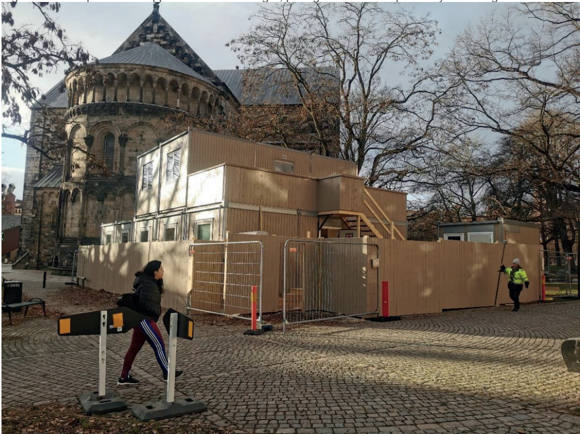
Figur 3. Manskapsbodarna uppställdes i två våningar, på regler som vilade på markytan. Fotografi från nordöst.
