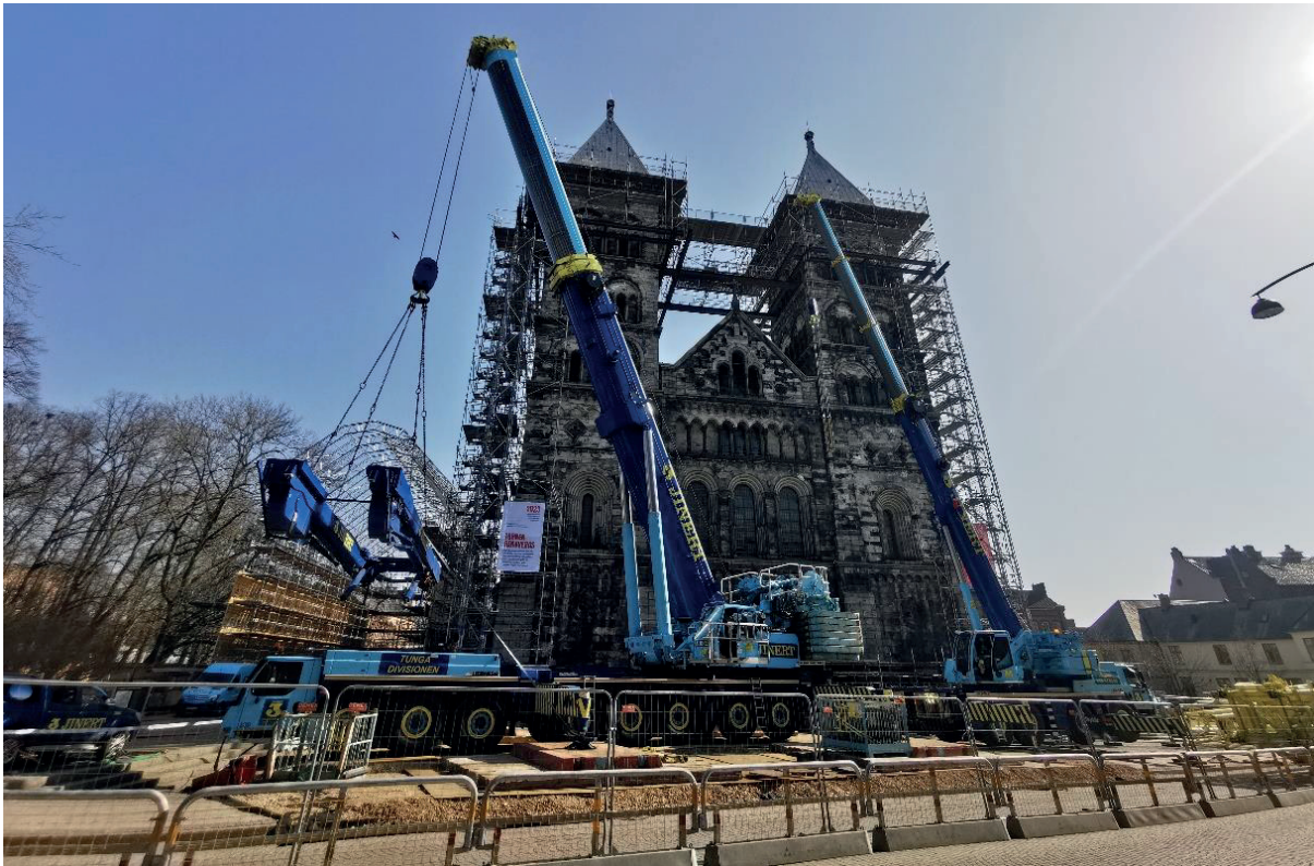
Figur 23. Domkyrkans västparti, det västra arbetsområdet, samt kranarna. Fotografi från väster.
