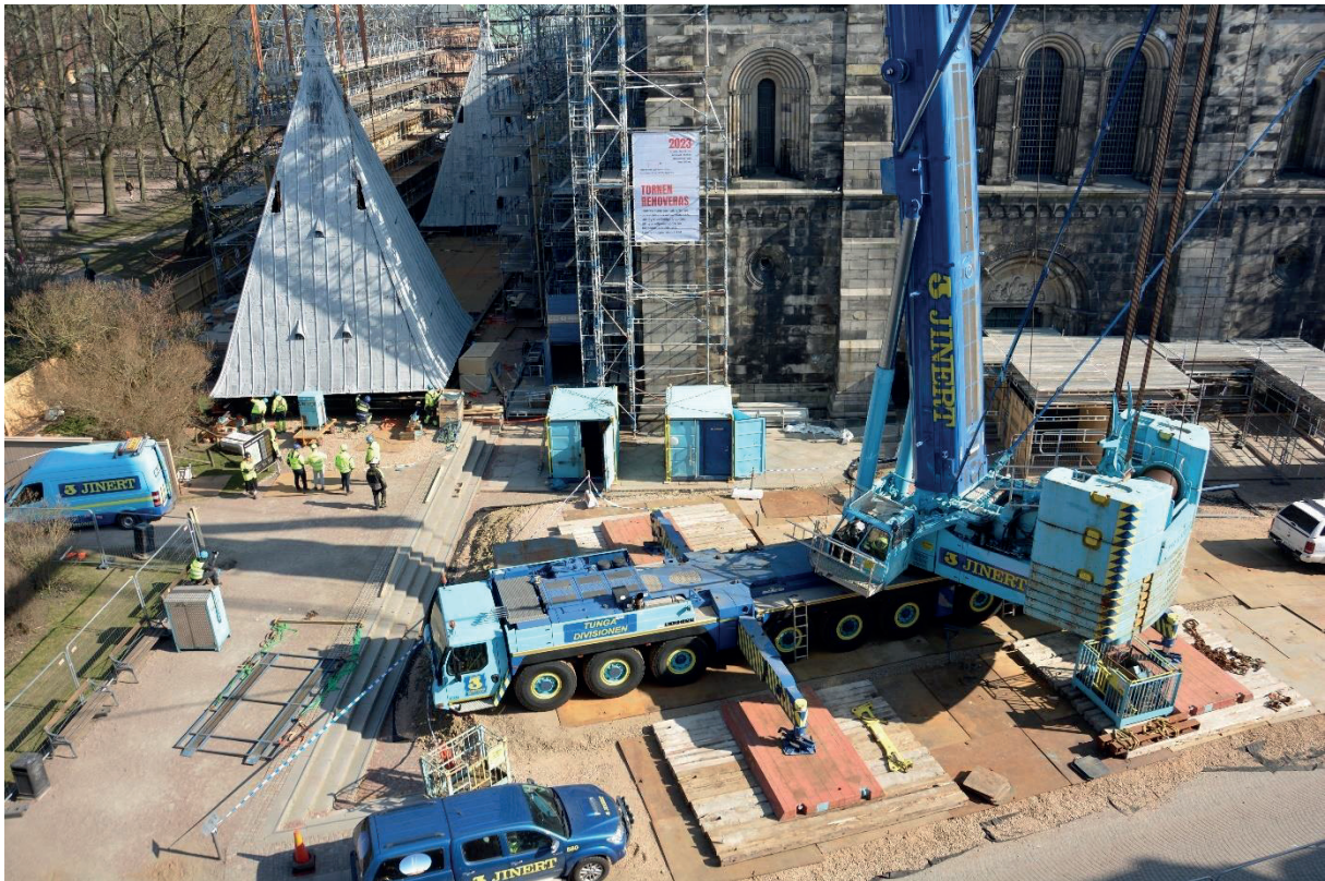
Figur 38. Huvarna, kranen och den västra delen av arbetsplatsen. Fotografi från väster.
