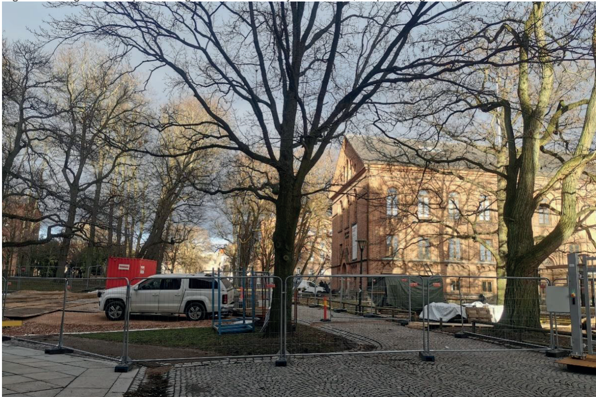
Figur 10. Arbetsområdet nordöst om domkyrkan. Fotografi från söder.
