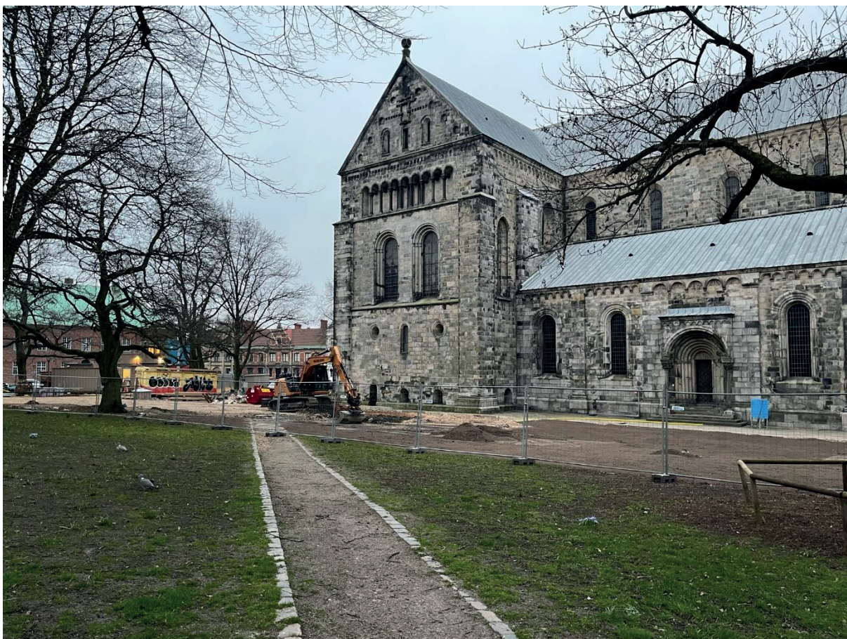
Figur 45. Avetablering av arbetsplatsen, de påförda massorna tas bort tillsammans med fiberduk och körplåtar. Fotografi från nordväst.
