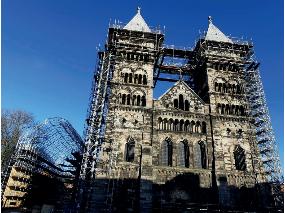
Figur 22. Domkyrkans västparti samt upplaget där tornhuvorna kom att förvaras och reoveras. Fotografi från väster.
