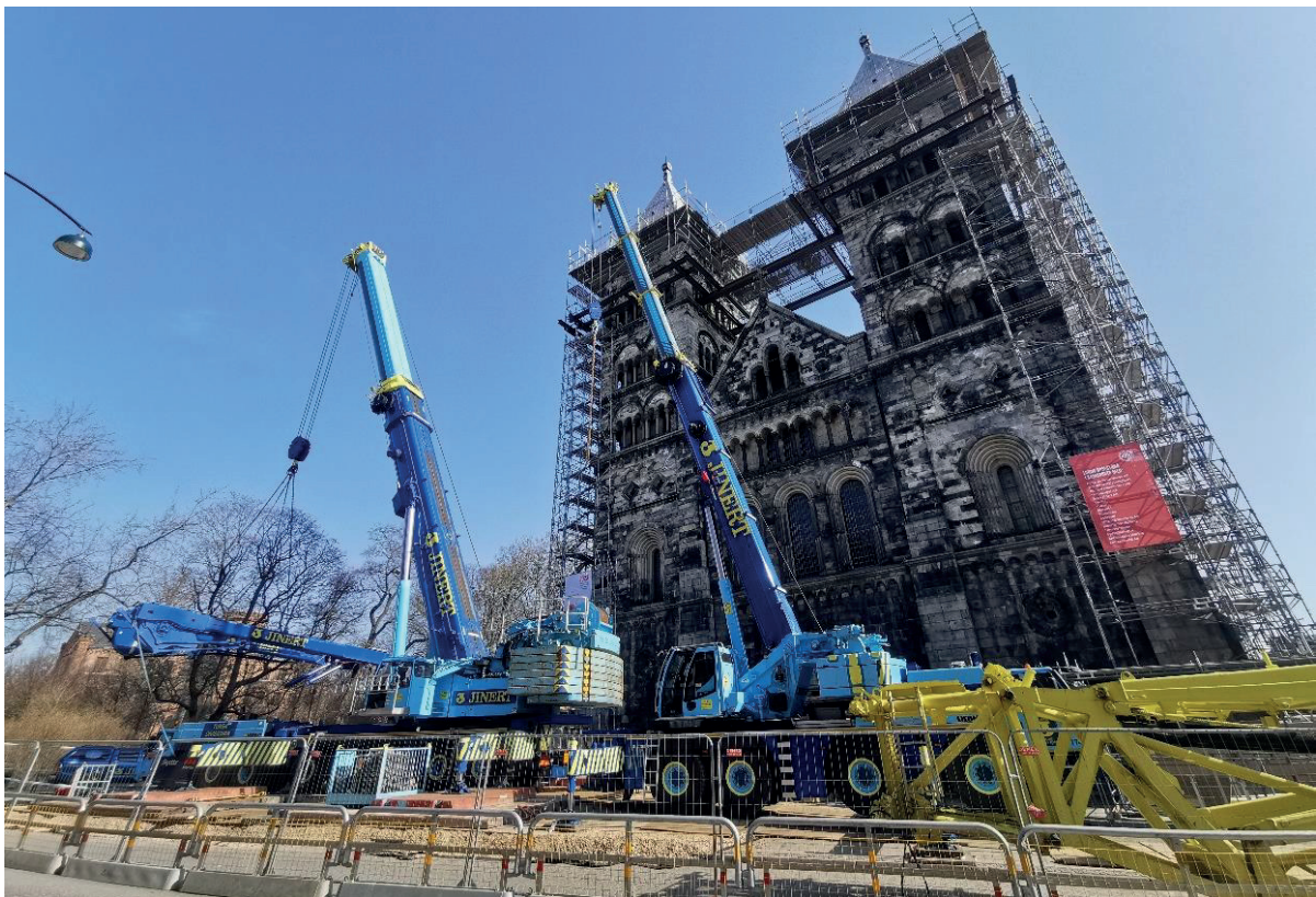
Figur 25. Den stora kranen till vänster i bild, får hjälp med pålyft och montering av en mindre kran. Fotografi från sydväst.
