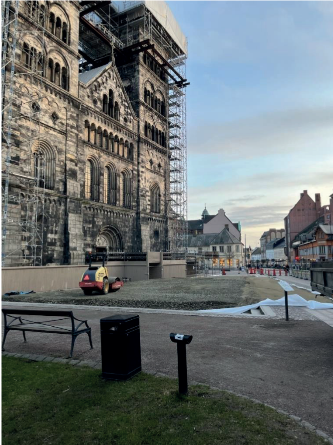
Figur 41. Bärlager och fiberduk läggs ut väster om domkyrkan, för att fördela lasterna från den stora kranen. Fotografi från nordväst.
