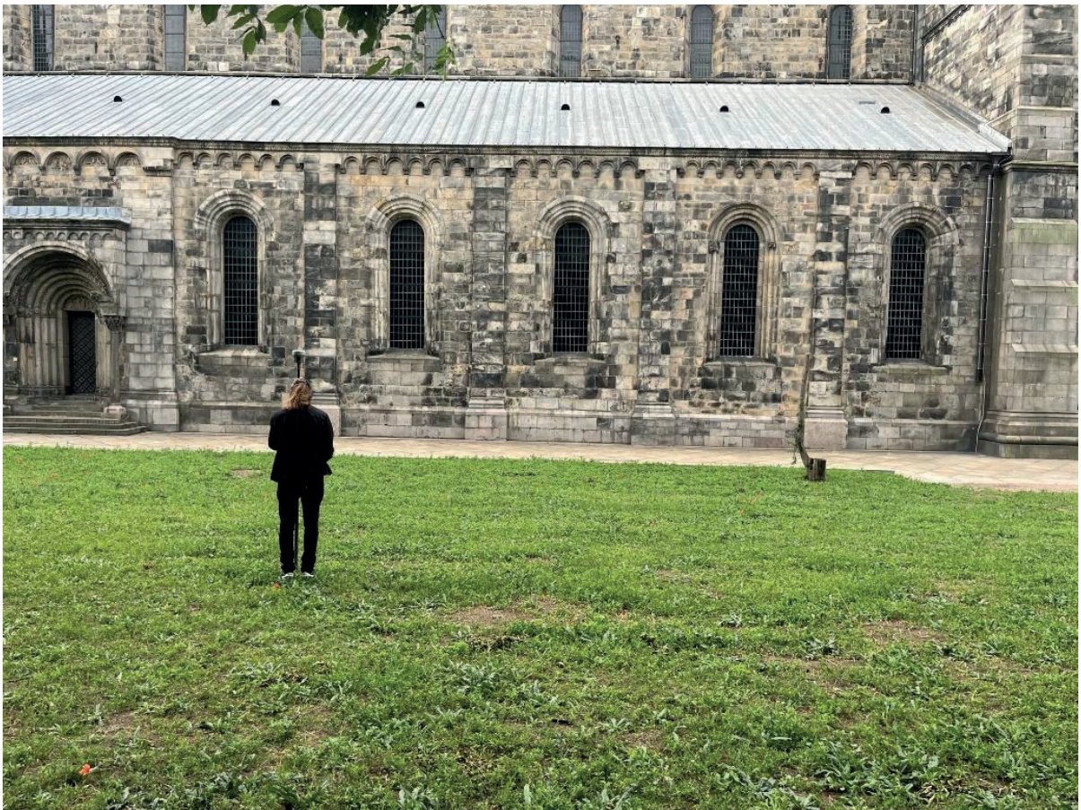
Figur 50. En andra inmätning av kontrollpunkter, efter arbetsplatsens avetablering. Fotografi från norr.
