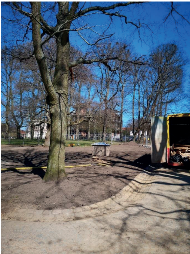
Figur 49. Ett litet hus med en nedgrävd kabel fotograferades 19 april 2023 norr om absiden. Den lilla stugan har enligt entreprenören Thages satts upp för att skydda en äldre brandpost. Fotografi från söder.
