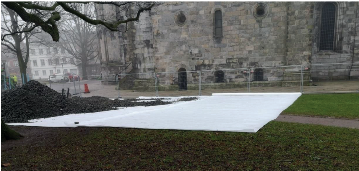
Figur 6. Avlastningsområdet norr om domkyrkan där inkommande massor transporterades in på lastbilar. Körplåtar placerades på marktäckande geotextil för att undvika körskador. Fotografi från norr.
