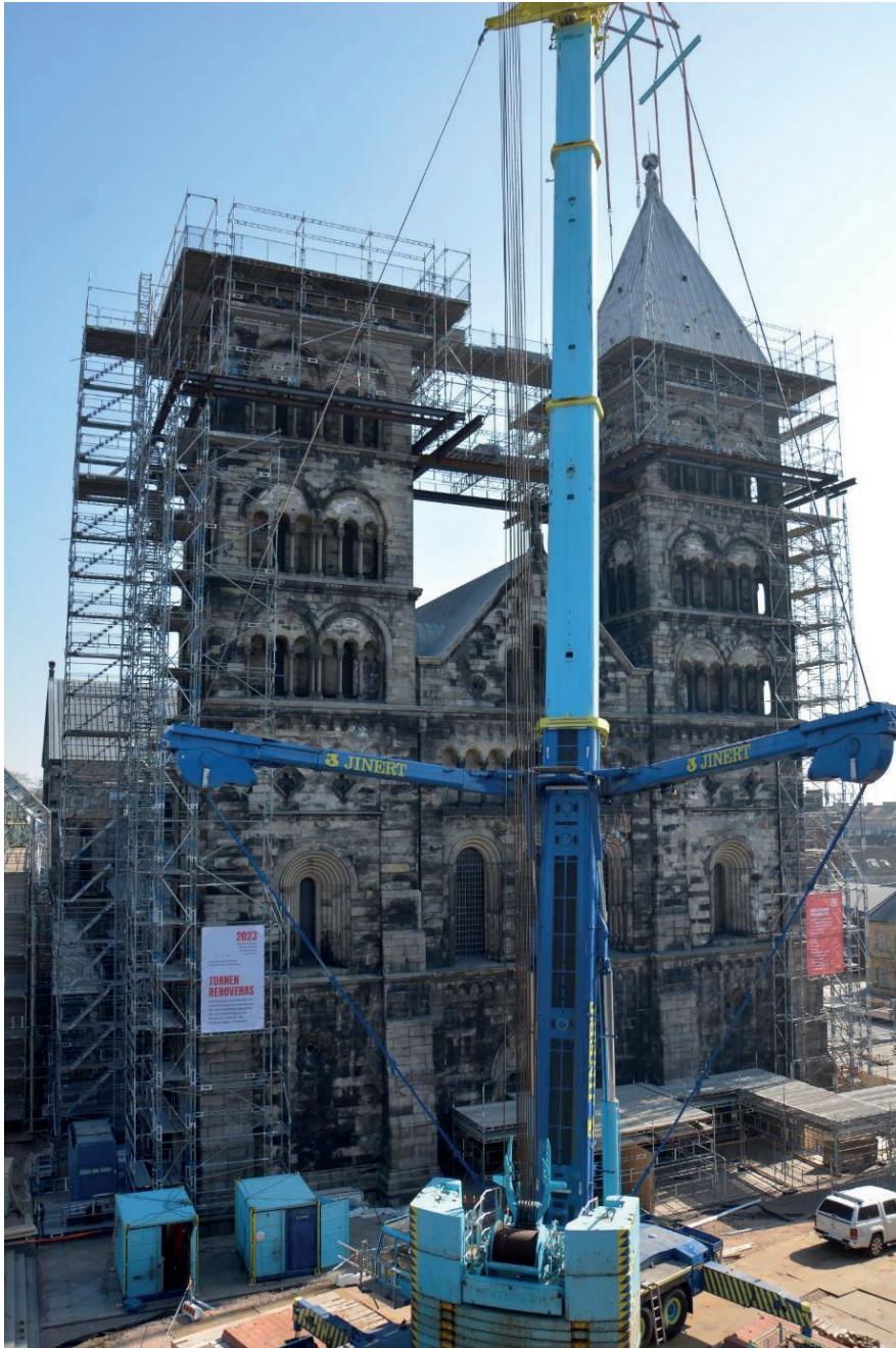
Figur 30. Den södra tornhuven säkras inför nedlyft. Fotografi från väster.
