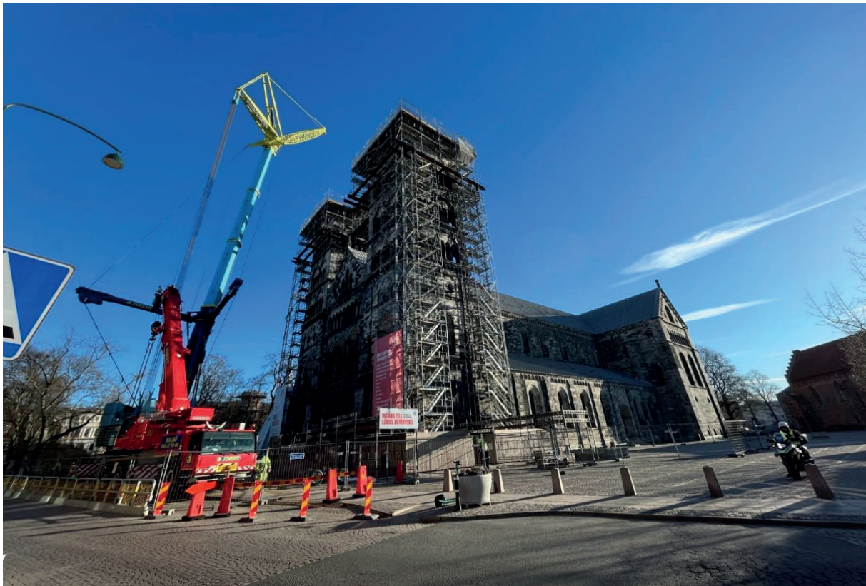
Figur 42. Kranen monteras. Fotografi från sydväst.
