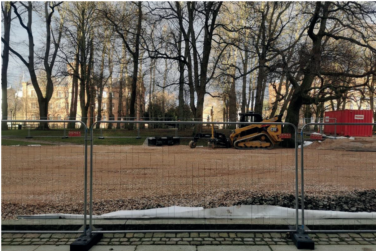
Figur 11. Arbetsområdet norr om domkyrkan, geotextil samt bärlager har packats för att bättre fördela lasterna från tornhuvarna som skulle placeras på ytan. Fotografi från söder.
