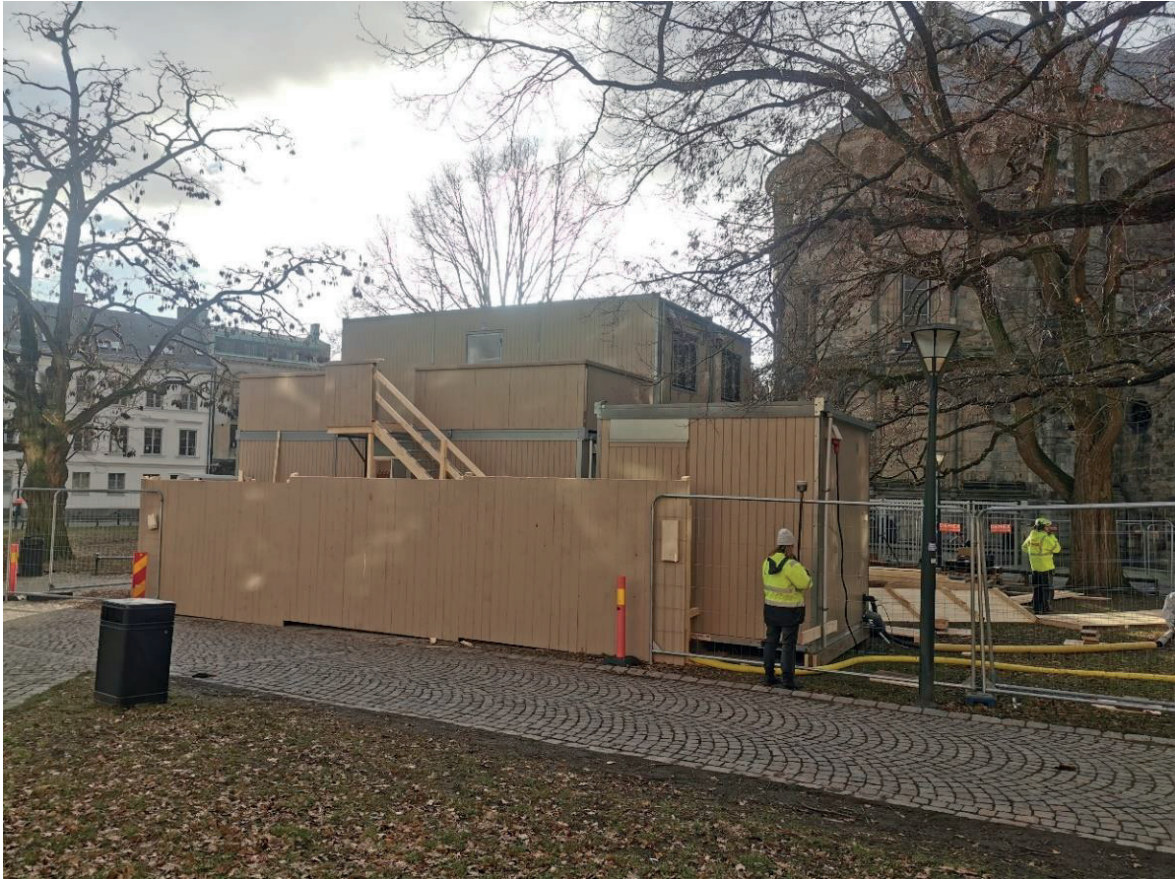
Figur 2. Manskapsbodarna uppställdes i två våningar, på regler som vilade på markytan. Fotografi från nordöst.
