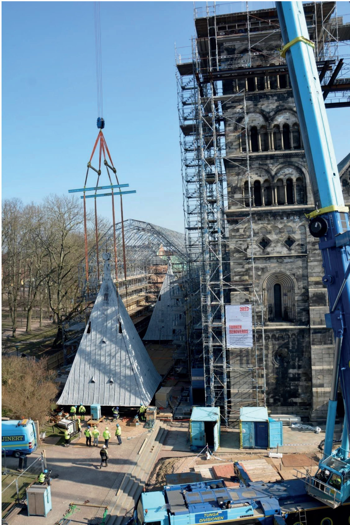
Figur 37. Huvarna, kranen och den västra delen av arbetsplatsen. Fotografi från väster.
