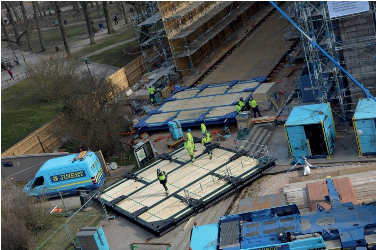
Figur 26. De plattformar tornhuvorna skulle lyftas ner på, blå för det norra och svart för det södra. Den blå plattformen har ställts på rälsen för att norra tornhuvorna ska kunna lyftas ner och rullas in. Fotografi från söder.
