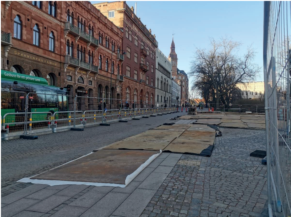
Figur 21. Avspärrning, fiberduk och körplåtar, väster om domkyrkans torn. Fotografi från söder.
