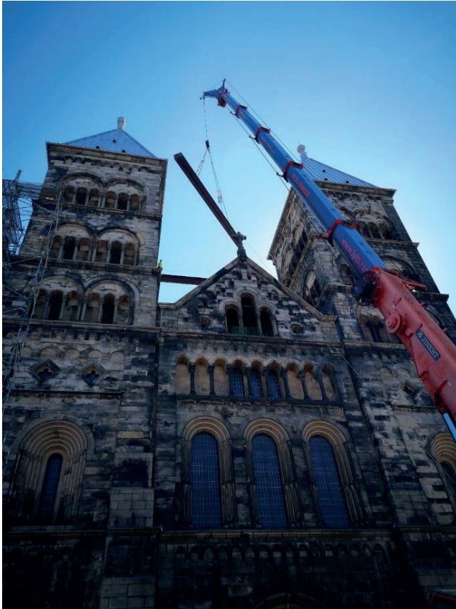
Figur 48. Balkarna mellan tornen, där det funnits en gångväg, lyfts ner. Fotografi från väster.
