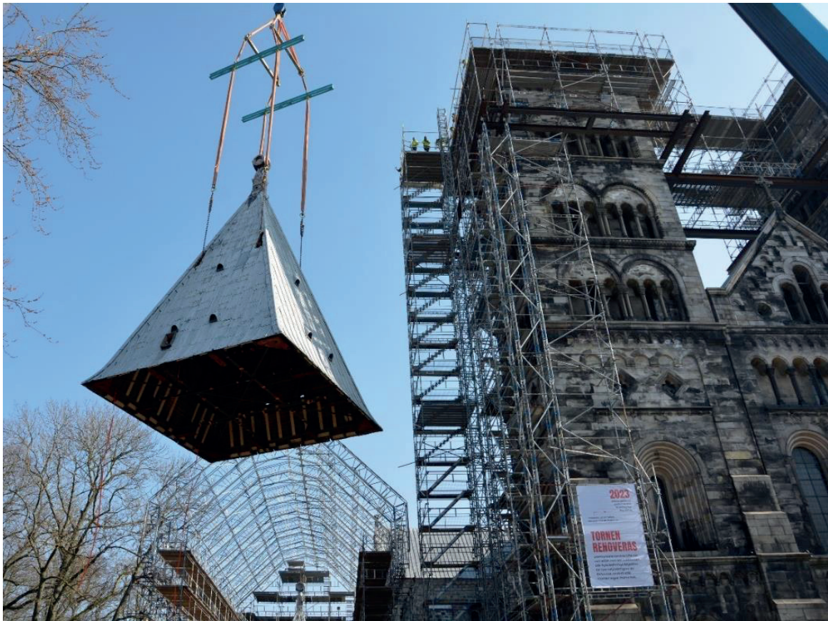
Figur 35. Den södra tornhuvn på väg ner. Fotografi från sydväst.
