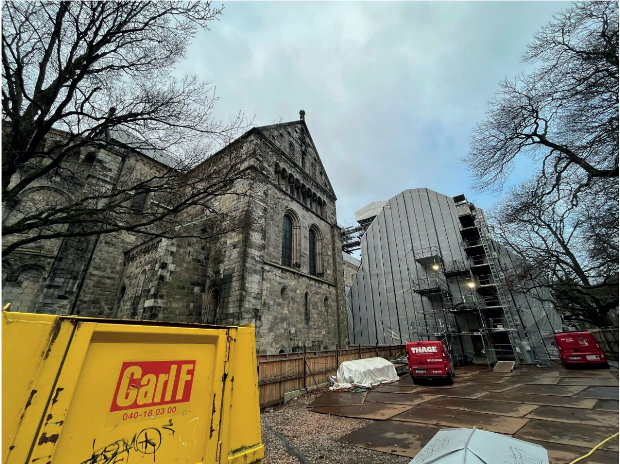
Figur 40. Tältet, eller upplaget, där tornhuvarna var placerade under restaureringsarbetena. Fotografi från nordöst.
