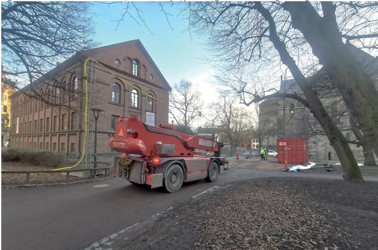
Figur 14. Norra passagen med bärlager och körplåtar fanns inte med i den ursprungliga ansökningshandlingen och beslutet. Fotografi från nordöst.
