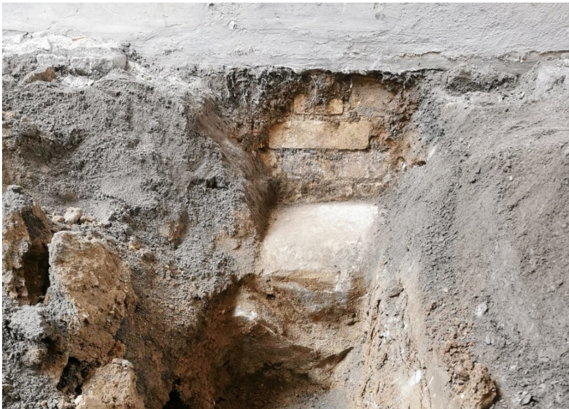
Figur 16. Anslutningsschaktet till östra fasaden av portgången. Stenen tolkades ha tillhört grundsulan till byggnaden. Fotografi från väster.
