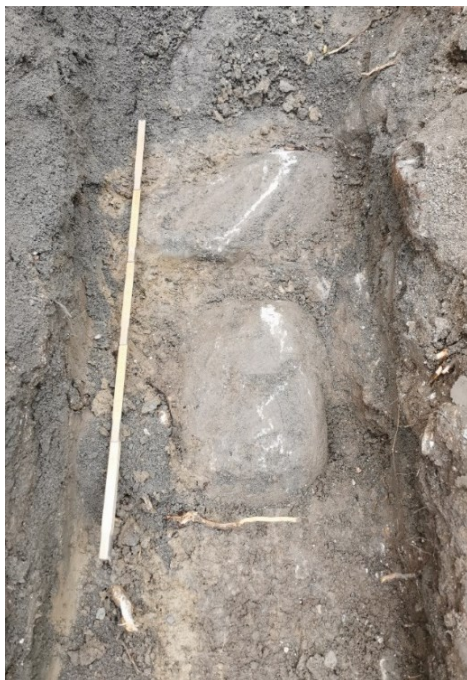
Figur 19. Stora stenar i moränleran påträffades i södra schaktdelen av schakt 3. Som referens på stenarnas storlek, är tumstocken på bild förlängd till omkring 1 m. Fotografiet taget från norr.
