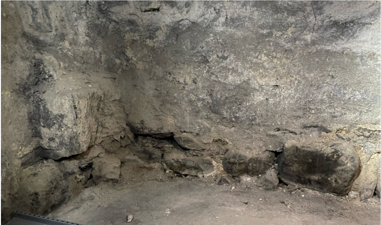
Figur 23. Syllstenar till den byggnad som uppfördes år 1863 är inmurade i befintlig konstruktion. Stenarna är belägna i nuvarande källare till befintlig byggand.
