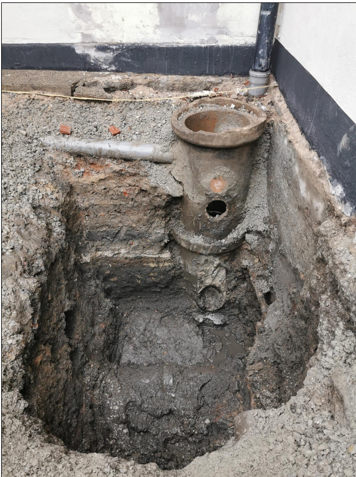
Figur 6. Översikt fotografi över schaktet. En sekvens av kulturlager är synlig i schaktets norra vägg till vänster om brunnen. Foto taget från söder.
