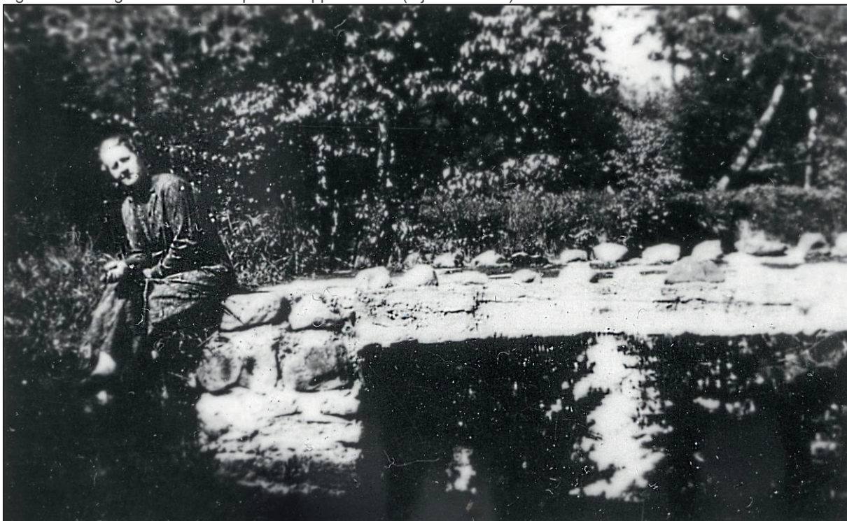
Figur 12. Bild tagen omkring år 1950–1955 på en person sittandes på en av broarna över vattendragen i trädgården. Bron är uppbyggd av cement och sten och ovasidans kanter dekorerad med mindre sten. Vegetationen kan uppfattas som frodig (Mjøsamuseet)
