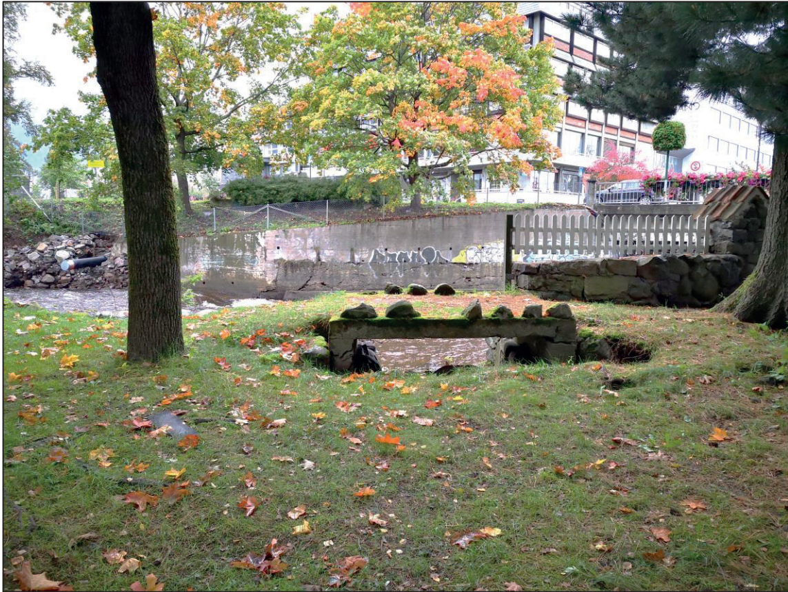
Figur 19. Utlopp i nordöst. En stenuppbyggd kanal med en bro av cement eller betong finns fortfarande vid kanten till Hunnselva.
