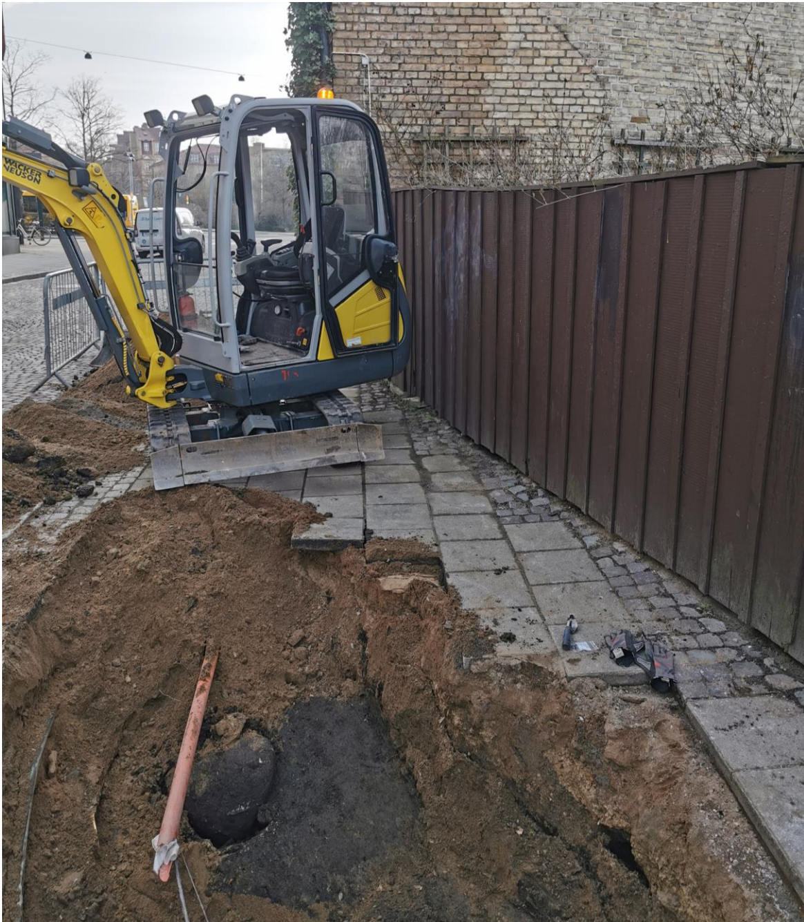
Figur 12. Foto taget under breddningen av schakt 1. Den västligaste stenen i syll K107 framtoogs. Söder om den är odlingsjord (K108). Schaktet var till stor del fyllt med moderna fyllnadslager, vilka kan ses både i schaktkanten och botten runt odlingsjorden. Foto taget från väst.
