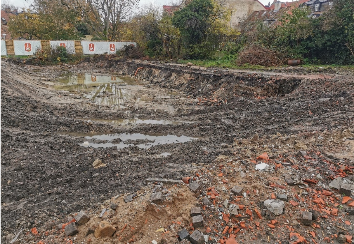
Figur 72. Rivningsarbete avslutat av den västra byggnaden. Sett från norr.
