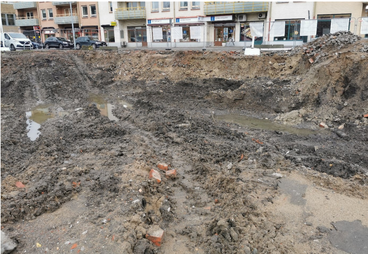
Figur 73. Rivningsarbete avslutat av den norra byggnaden. Körsador ses till vänster i bild. Sett från sydöst.
