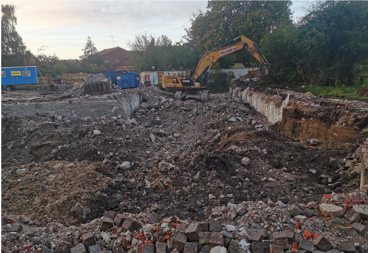
Figur 70. Rivningsarbete pågår av den västra byggnadens källare. Sett från norr.
