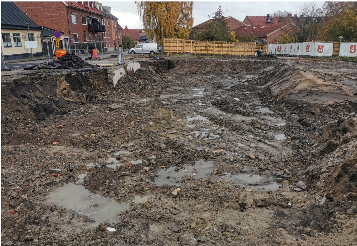
Figur 71. Rivningsarbete avslutat av den östra byggnaden. Sett från norr.
