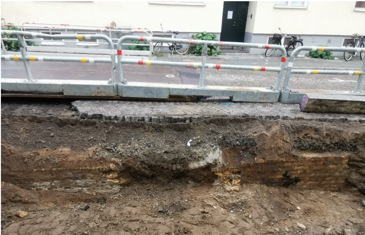
Figur 7. Tegelmuren från år 1899 (K120) sett från öster.
