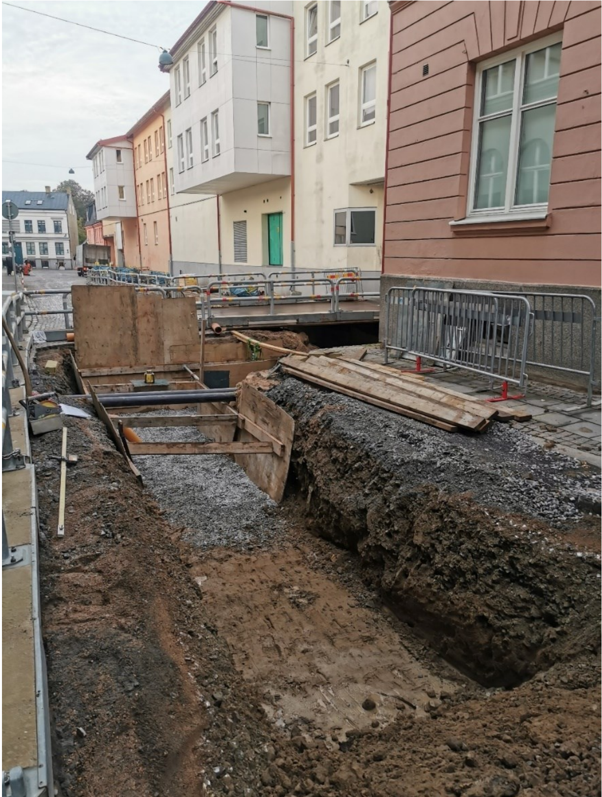
Figur 8. Schaktet längst Laborriegatan sett från nordöst. I botten av schaktet ses det äldre ledningsschaktet som var återfyllt med kulturlager uppblandat med moränlera.
