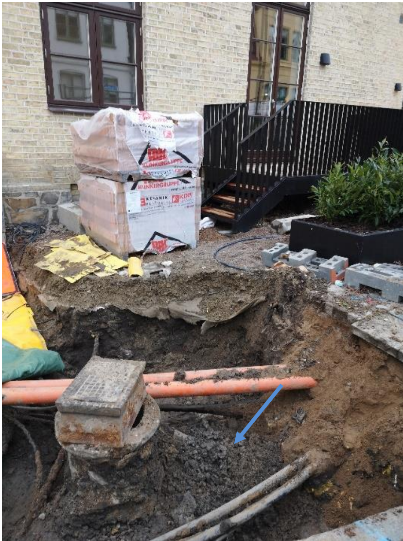
Figur 10. Koncentrationer av humanben påträffades under rörkluster i ett schakt på Magle Lilla Kyrkogata 12 i Lund. På bilden är benen övertäckta med geotextil och lera (blå pil). Området var fram till 1800-talet en del av Sankta Maria Magles kyrkogård. Byggnaden i bild konstruerades under 1860-talet efter att kyrkogården lagts ner. Fotografiet taget från sydöst.
