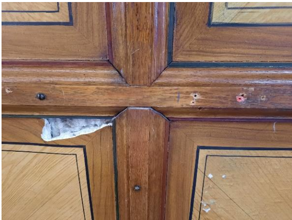
Puttskada i kassett som lagades i med hydrauliskt kalkbruk.
