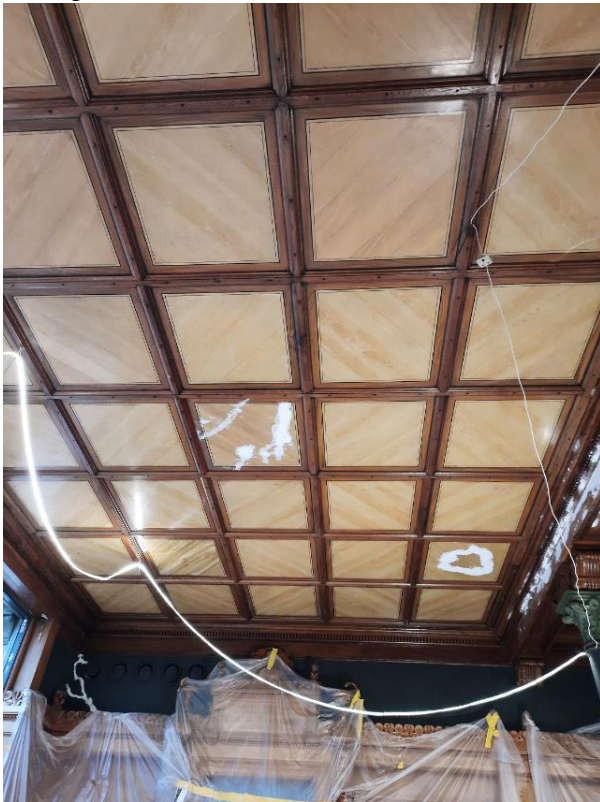
I området mot fönstersidan gjordes 6 av 45 kassetter om.
