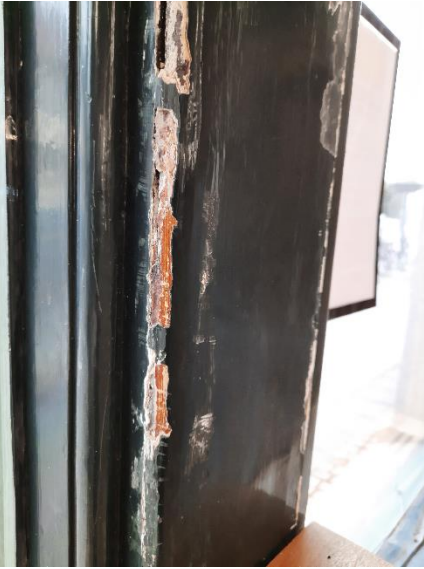
Framskrapat område med äldre ådringsmåleri i fönsterna
