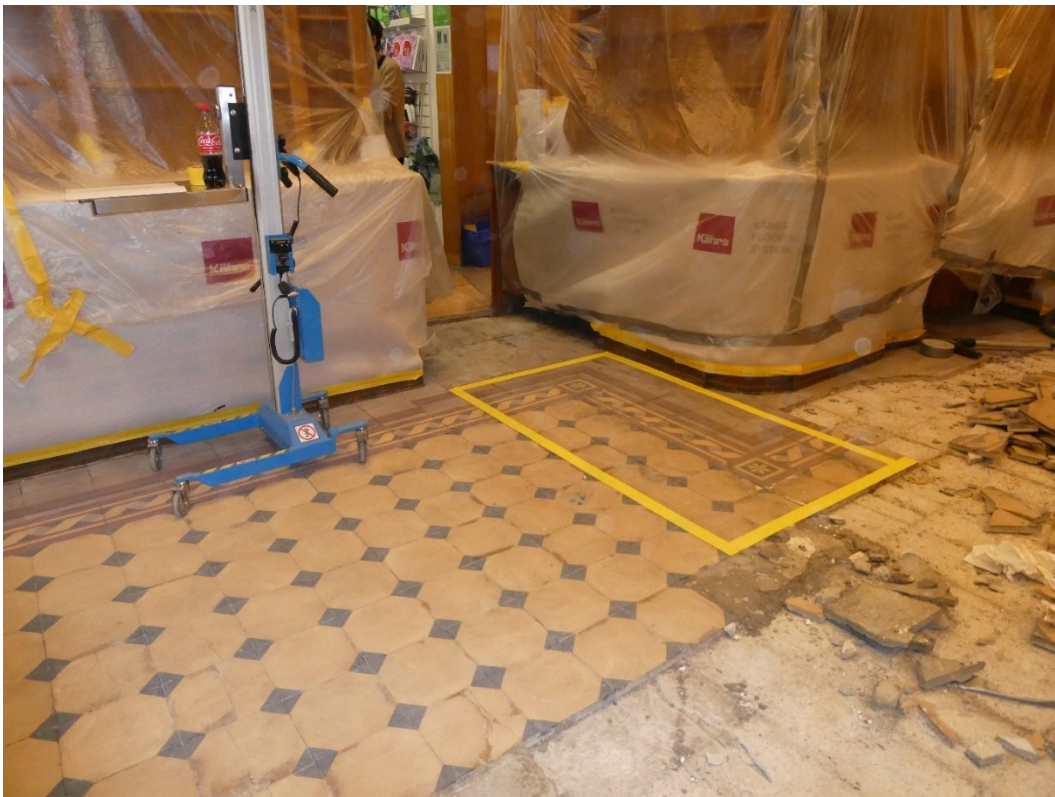
Arbete med golvet i officinen, golv som inte var möjligt att spara och ta fram (ingår inte i bidraget).
