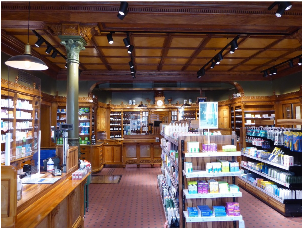
Vy mot öster och den del som tidigare var bakom kunddisk. Ny svängdörr med återvänt intarsia syns ungefär mitt i bild. Satin valnötsskivor i nya hyllor.
