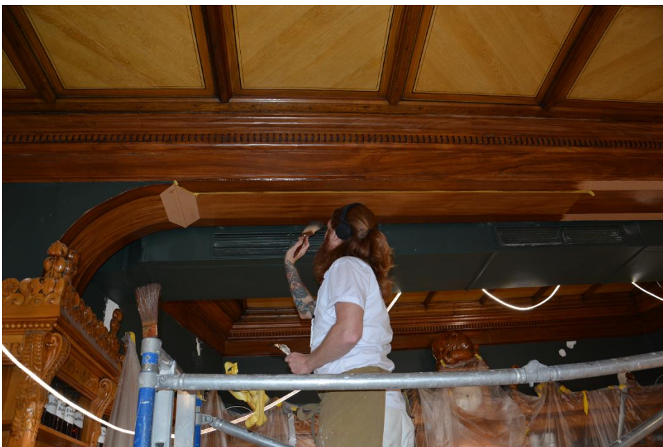
Undersidan ådringsmålas av Magnus från Decor & Co.
