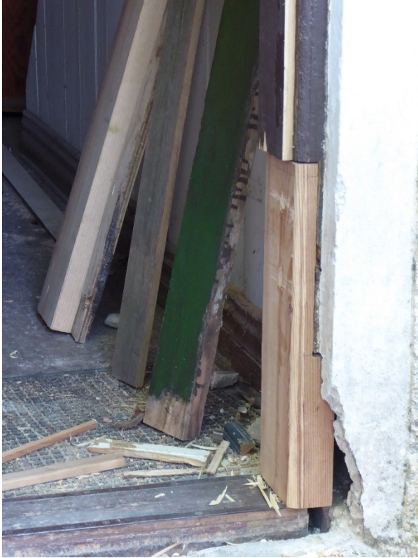
4. Vänster: Rötskadat virke i dörrkarm mot gården ersätts. Höger: Dörr fixerad i öppet läge i trappan.
