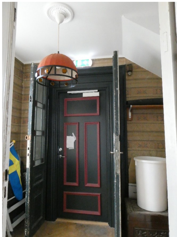
2. Rum 008 före och efter åtgärder. Till höger befintlig glasad dörr i uppställt läge och ny branddörr.
