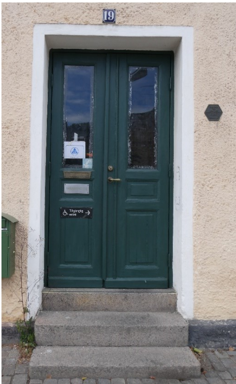
1. Huvudentré. Före åtgärder, under arbete och efter åtgärder.
