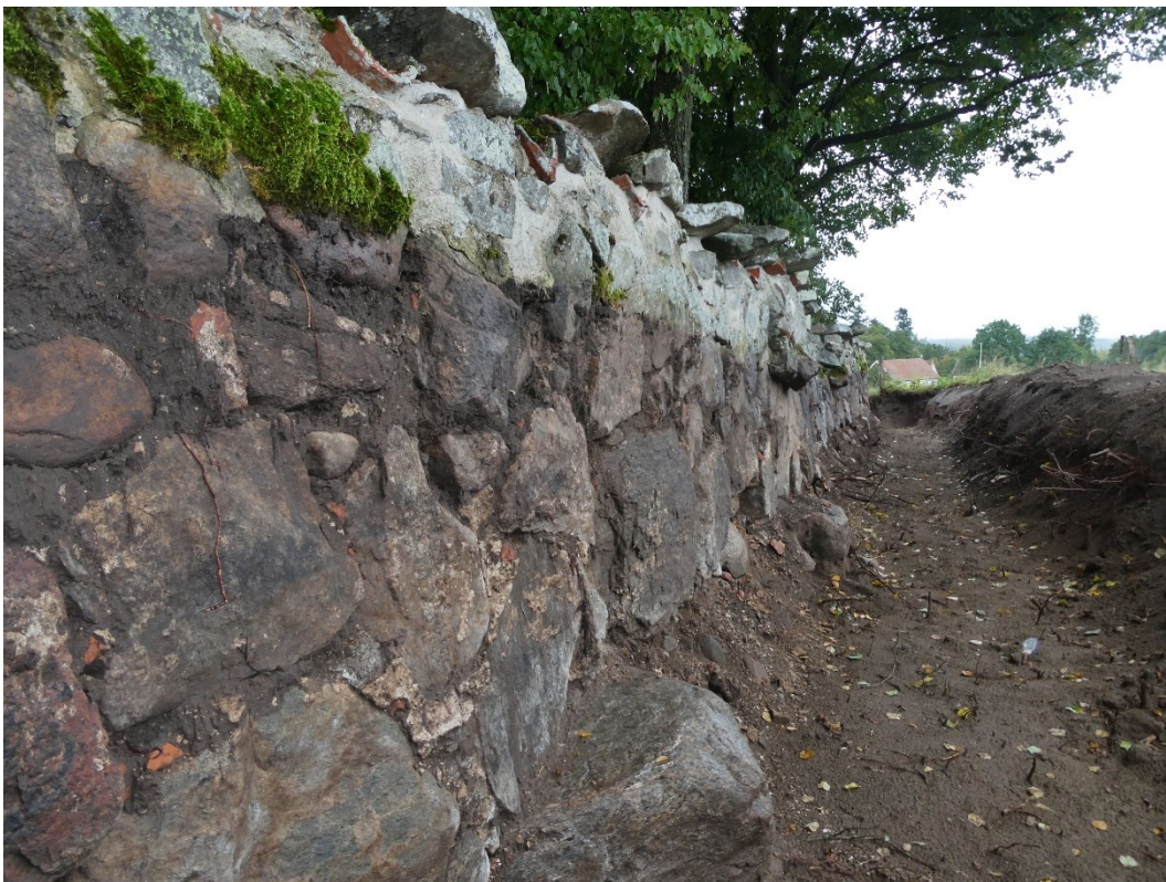
Detaljbilder av murens utsida, norra delen.
