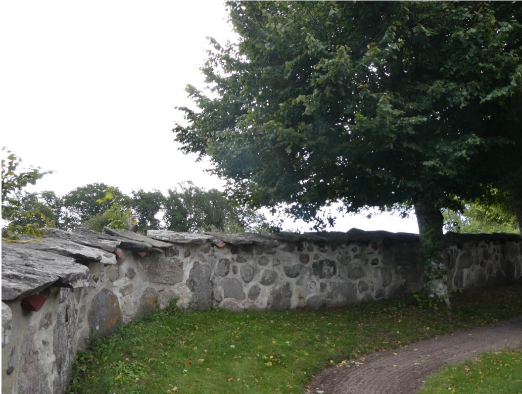
Före åtgärder insidan av östra muren vid nordöstra hörnet, exempel på täckhällar som behövde muras fast.
