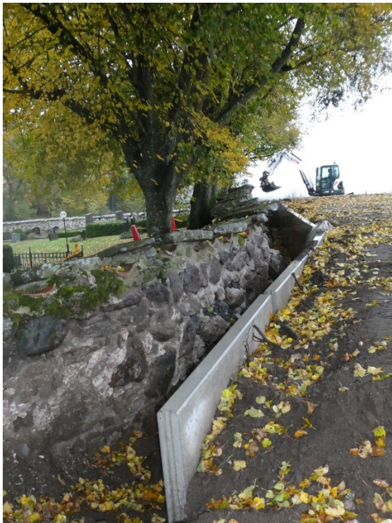
L-stöd har monterats och jordmassor återlagts. Vy mot söder. På bilden ses den tidigare lagade muren där de understa stenarna kragar utåt jordbruksmarken.
