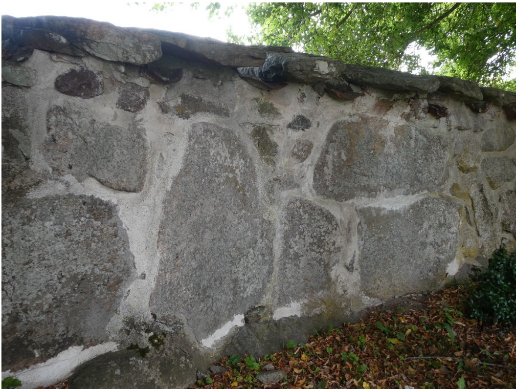
Före åtgärder. Det södra partiet som behövde muras om.
