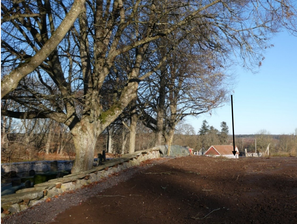
Utsidan vy mot norr, 2021. Marken sluttar från muren och dräneringsdike anas i markstrukturen vid pil.
