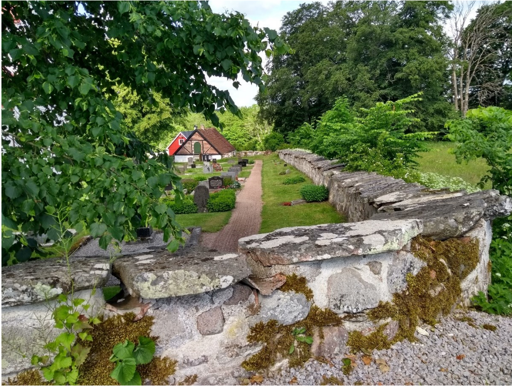
Exempel på täckhällar som murats fast på befintlig plats, nordöstra hörnet av kyrkogården.
