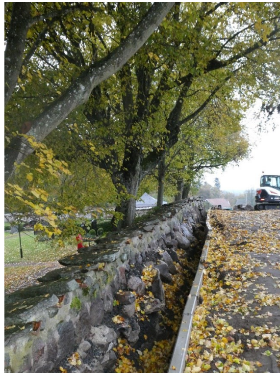
L-stöd har monterats och jordmassor återlagts. Vy mot söder. På bilden ses den tidigare lagade muren där de understa stenarna kragar utåt jordbruksmarken.
