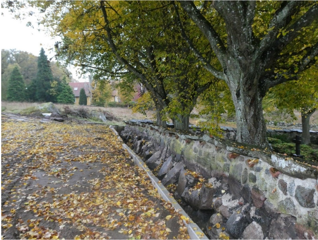
L-stöd har monterats och jordmassor återlagts. Vy mot söder. På bilden ses den tidigare lagade muren där de understa stenarna kragar utåt jordbruksmarken.
