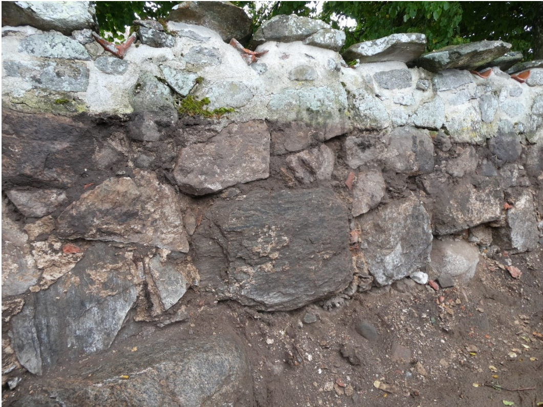
Den äldre delen av muren (längs med kvarter K).
