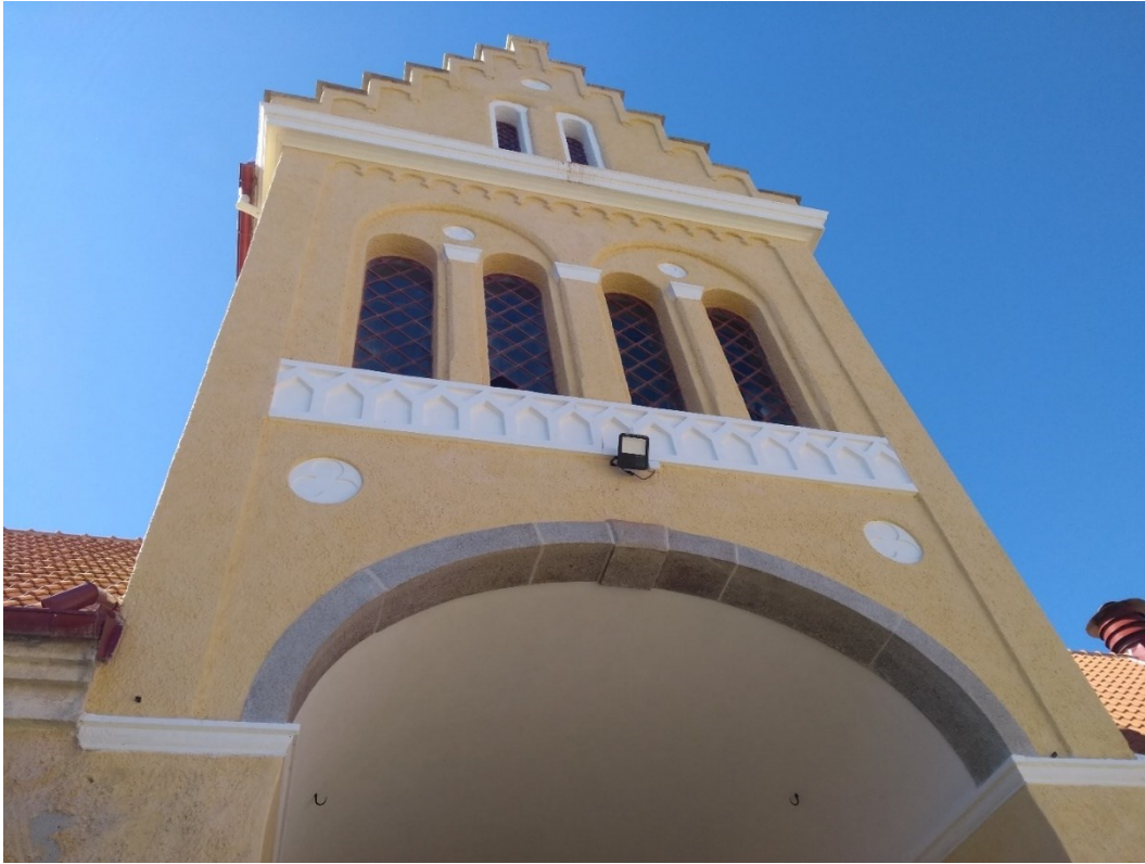
Östra fasaden med gul spritputs samt spritputs kring de övre fönstren, slätputsade vita detaljer.
