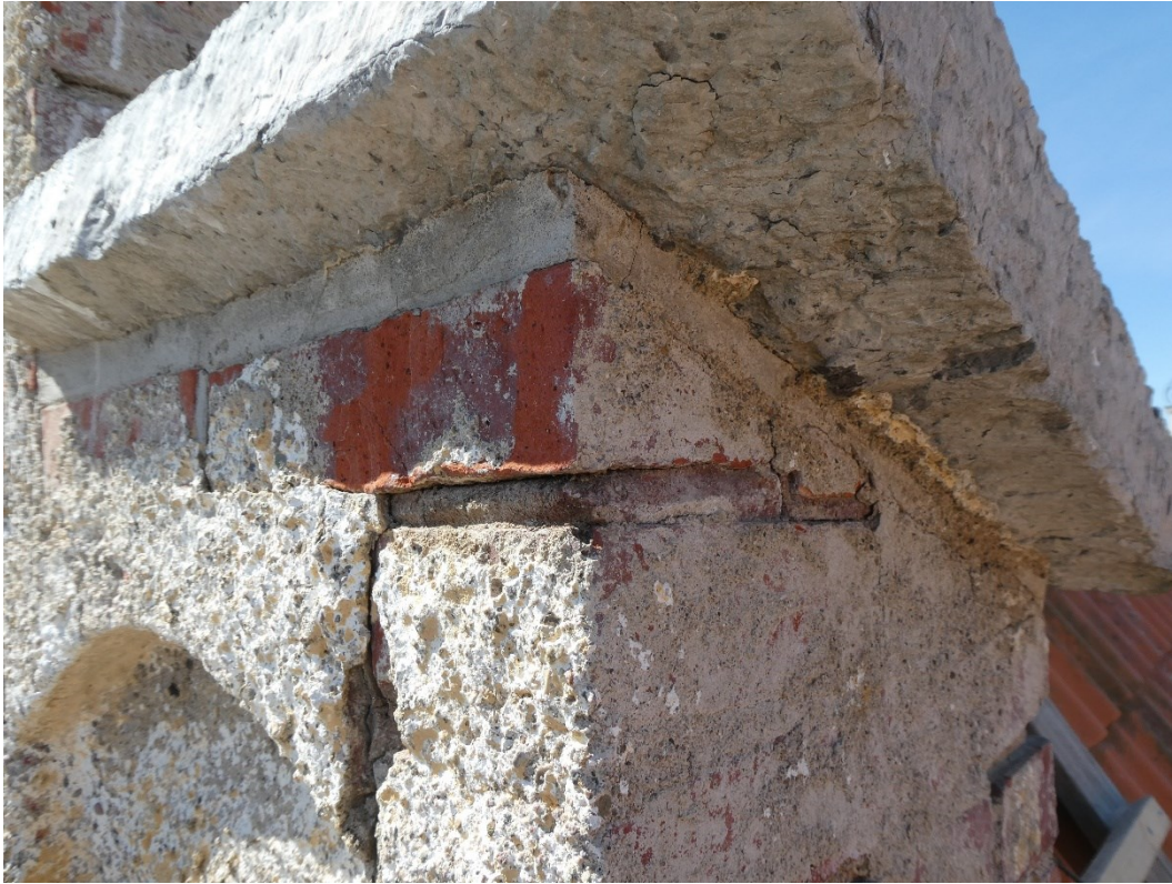
Kalkstensplatta och rödpigmenterad åsfog under tegelstenen. Nordöstra hörnet.
