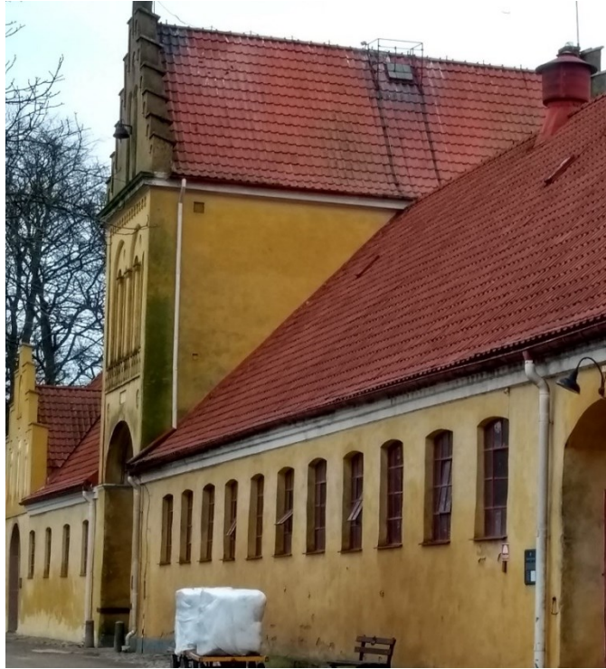
Västra fasaderna (foto 2020). Notera valvöppningen som är putsad på befintlig naturstensomfattning.
