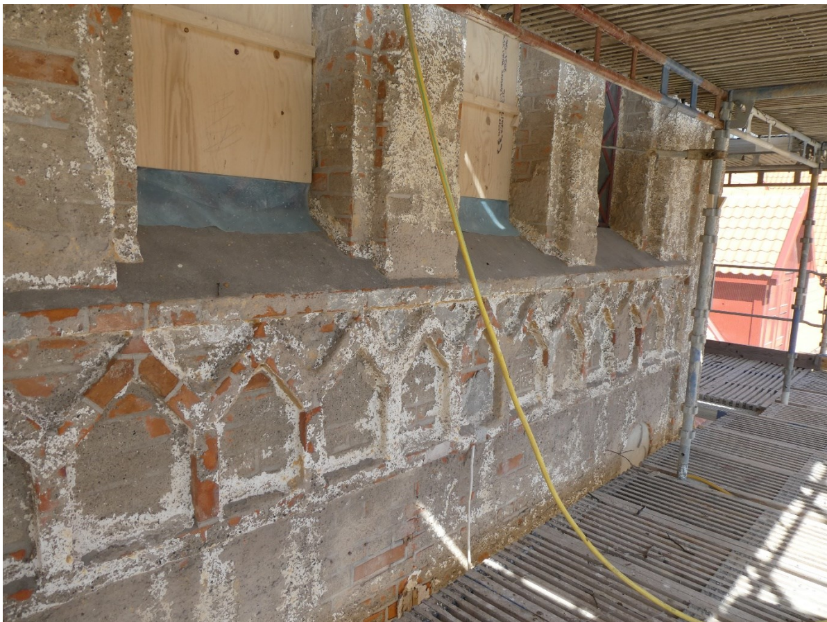
Detaljer i östra fasaden. Rosetter och kapitäl är i cement.
