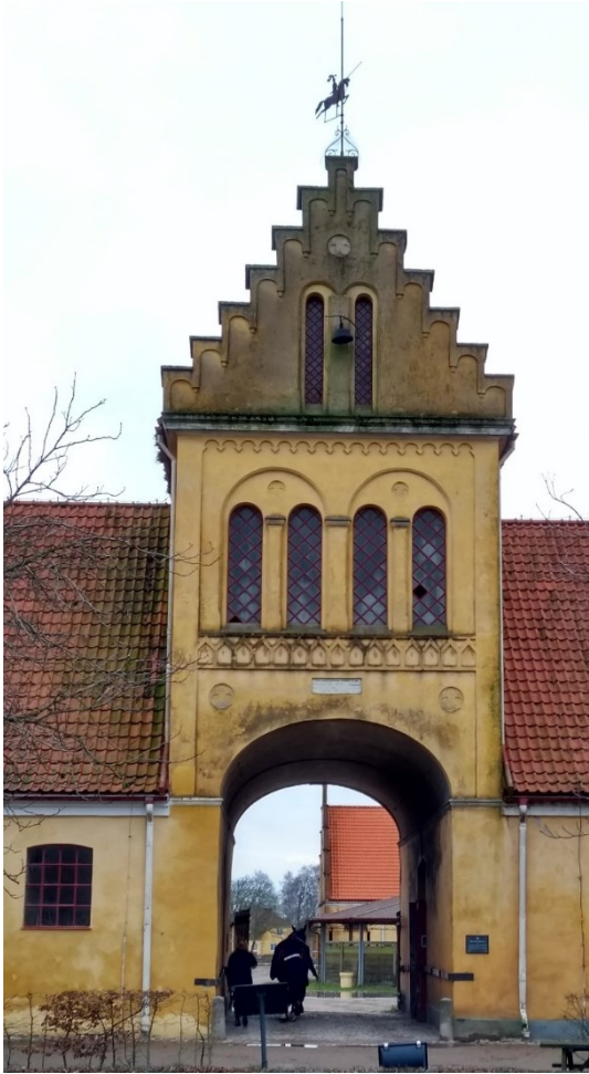
Västra fasaderna (foto 2020). Notera valvöppningen som är putsad på befintlig naturstensomfattning.
