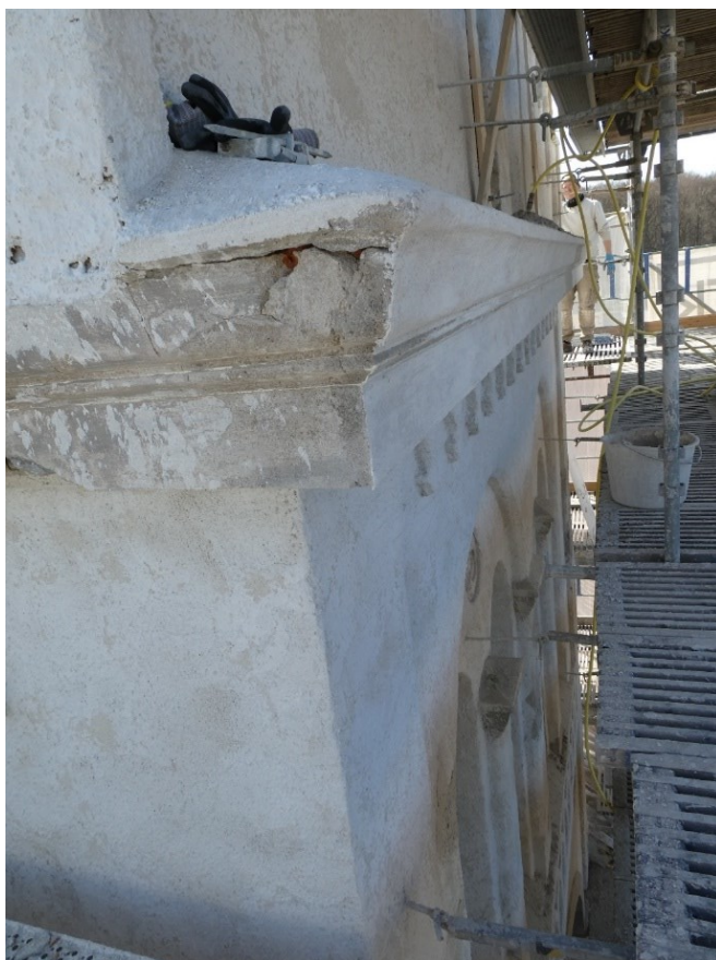
Takfotsgesims behålls och lagas, ny grundning på sydvästra fasaden.
