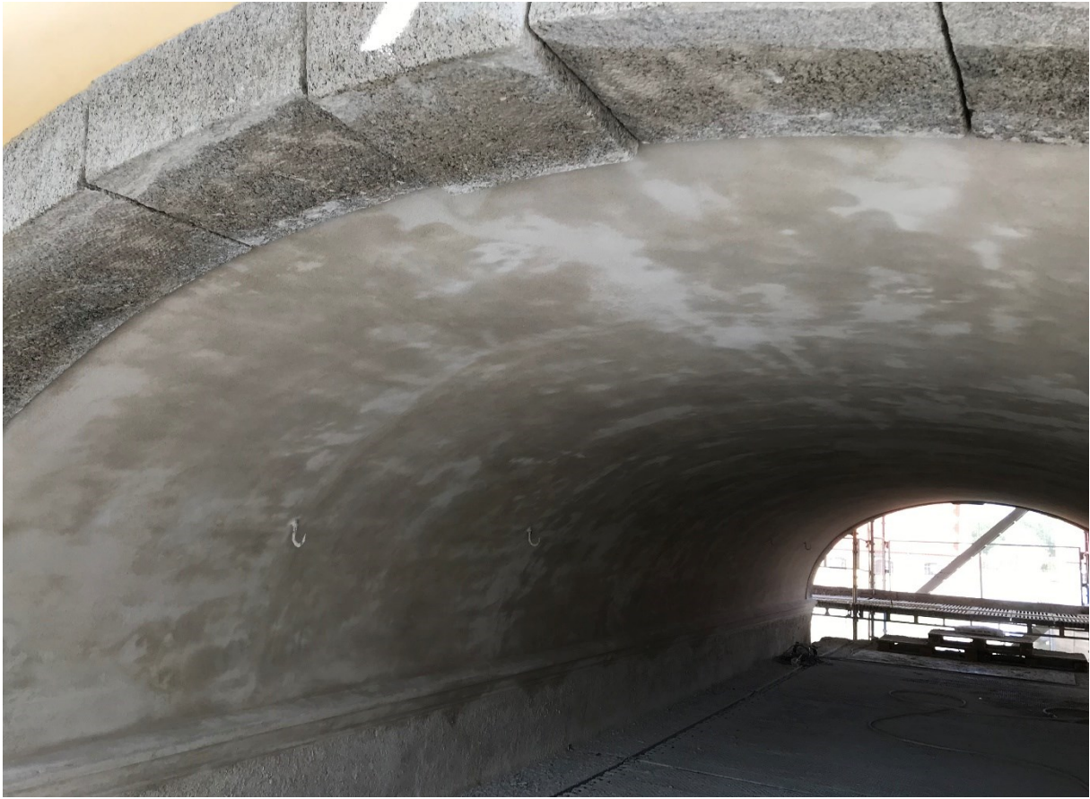
Tunnvalvet är putsat. Notera detaljer i putsfasaden på bilderna nedan.
