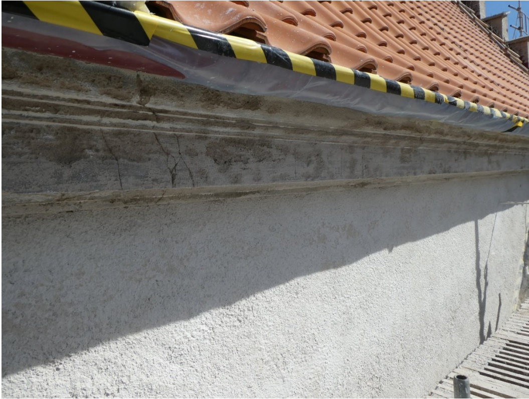
Takfotsgesims behålls och lagas, ny grundning på sydvästra fasaden.
