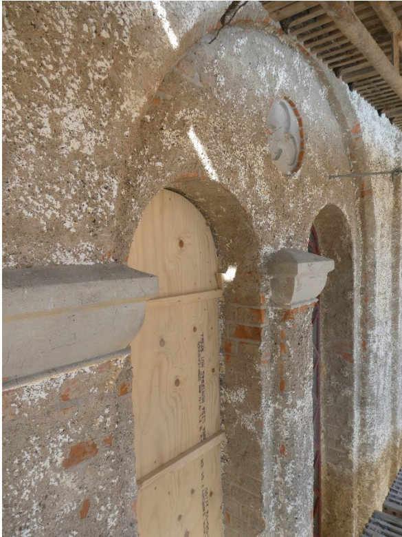
Detaljer i östra fasaden. Rosetter och kapitäl är i cement.
