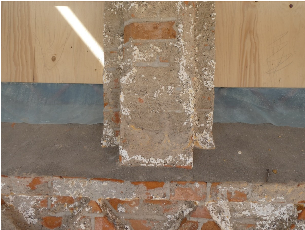
Östra fasaden, viss vit färg finns kvar det är möjligen grundfärg. Notera det formade teglet i basen på pilastern på nedre bilden. Denna form syns även när fasaderna är nyputsade, se foton under arbete och efter åtgärder.
