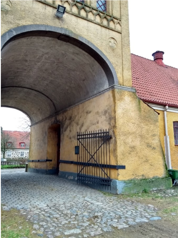
Portvalvet sett från öster och från väster. Notera naturstensvalvet som är överputsat på den högra bilden (mot väster) samt att detaljer är gulmålade.
