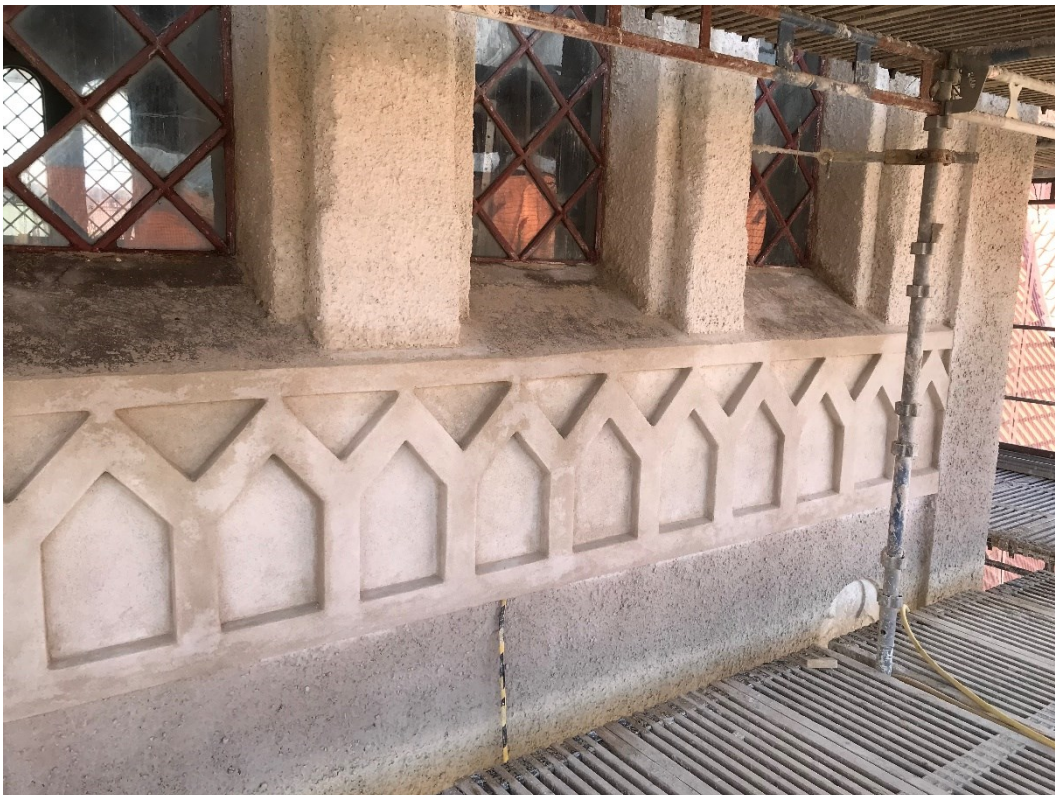
Östra fasaden, notera grå cementfog. Solbänkar är i cement, mönstermurning i tegel.
