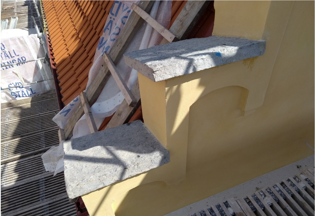
Täckplattor västra sidan.
