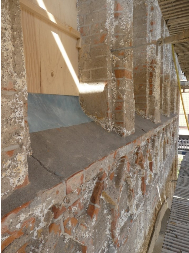
Östra fasaden, notera grå cementfog. Solbänkar är i cement, mönstermurning i tegel.
