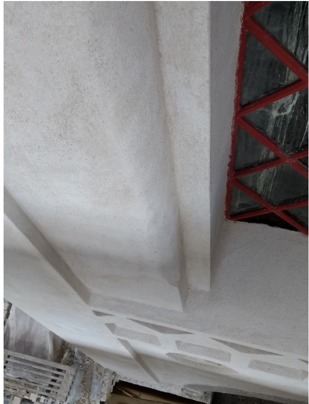
Tunnvalvet är putsat. Notera detaljer i putsfasaden på bilderna nedan.
