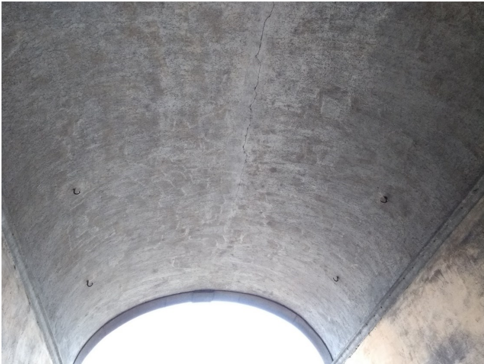
Tunnvalvet i portgången sedd mot öster.
