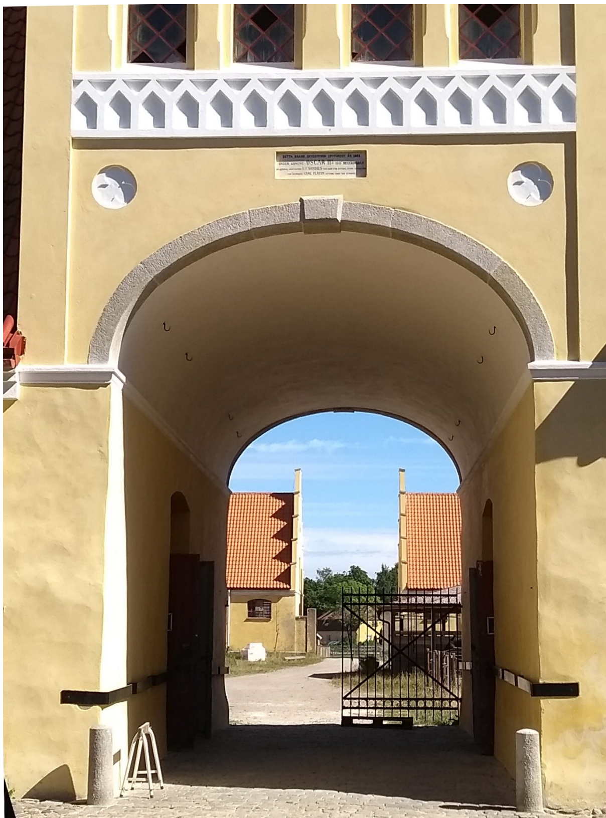
Portvalvet, västra fasaden med framtagna naturstensomfattning.
