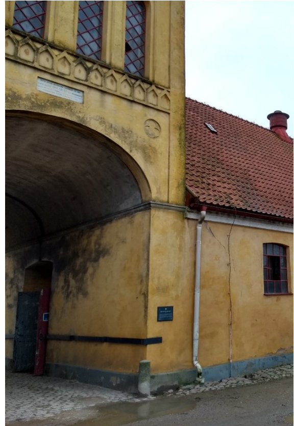
Portvalvet sett från öster och från väster. Notera naturstensvalvet som är överputsat på den högra bilden (mot väster) samt att detaljer är gulmålade.
