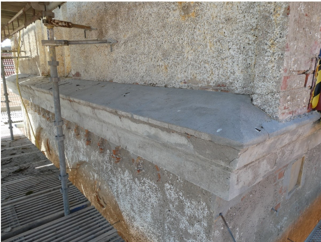
Kalkstensplatta och rödpigmenterad åsfog under tegelstenen. Nordöstra hörnet.
