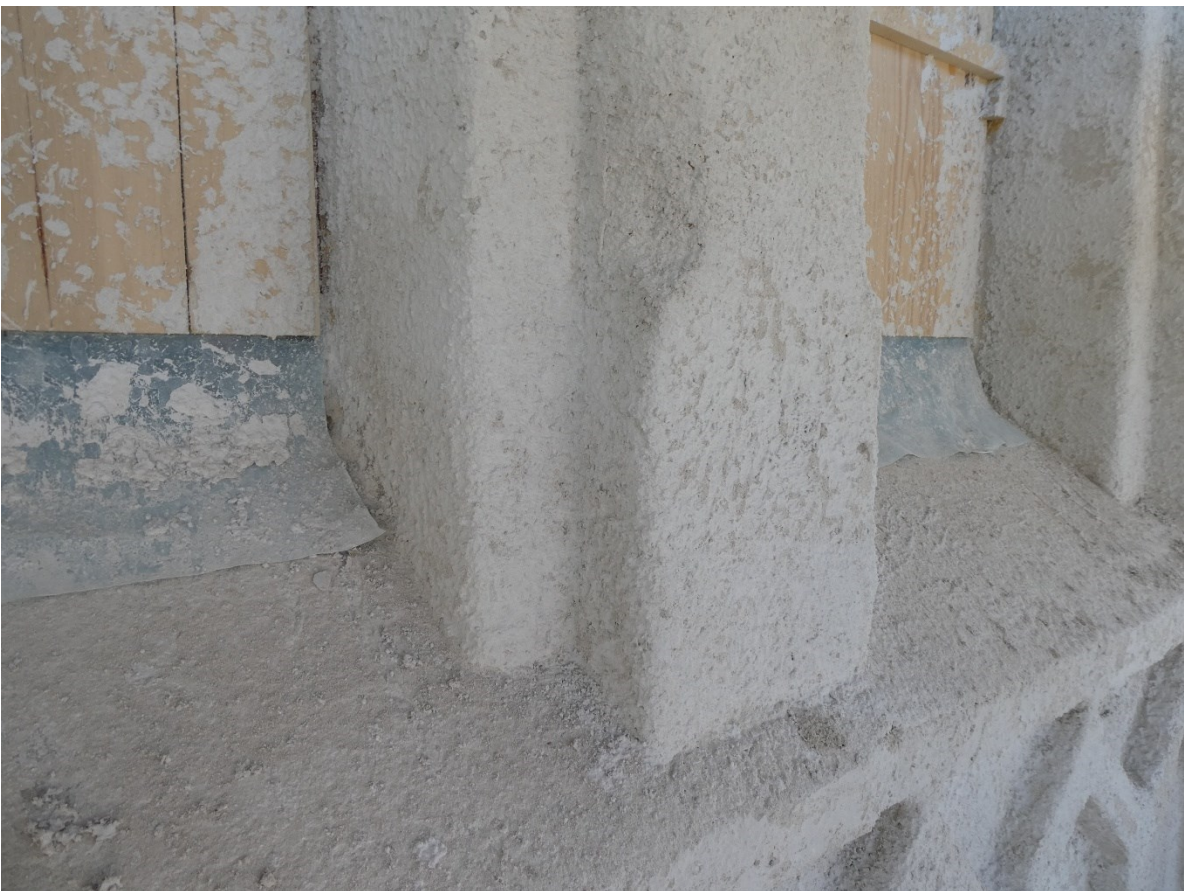
Västra fasaden med ny grundning. Notera detaljer i fasaden, nedre bilden visar detalj av pilaster mellan fönster.
