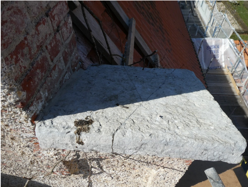
Sprucken kalkstensplatta mot nordost.
