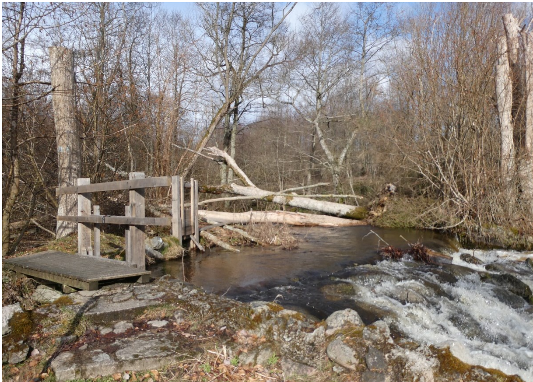
Stormfällda träd har skadat dammens norra kant.
