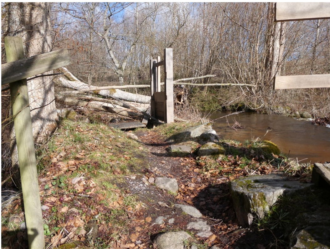
Stormfällda träd har skadat dammens norra kant.
