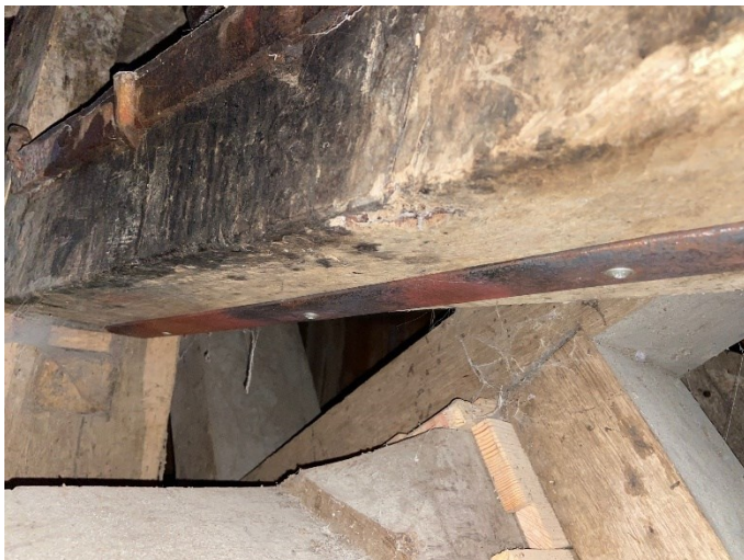
Bjälken i lättverket är förstärkt med järn istället för att bytas ut. Järnet är under bjälken och knappt synligt.
