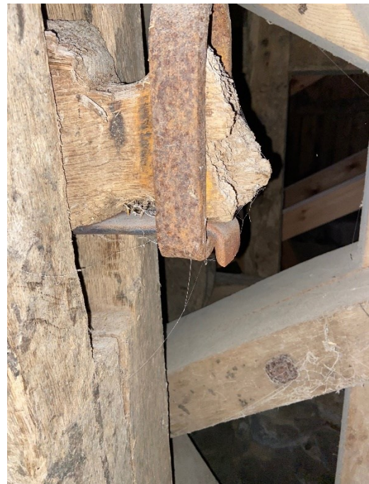
Bjälken i lättverket är förstärkt med järn istället för att bytas ut. Järnet är under bjälken och knappt synligt.
