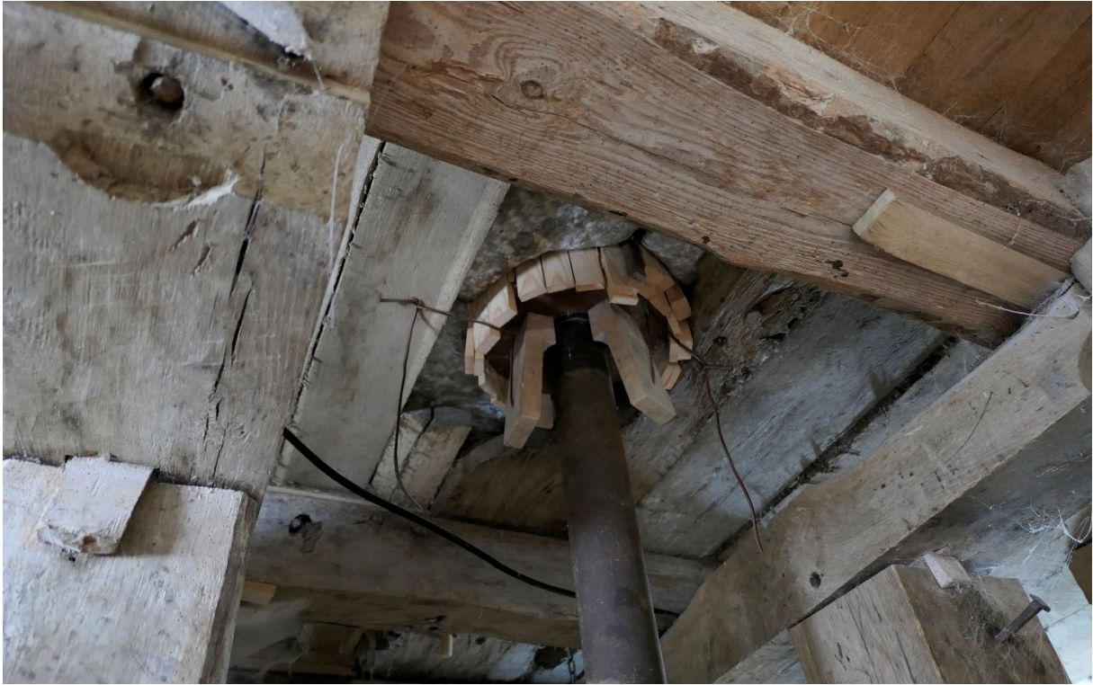
Nya kilar och spronsar (träbitarna som är längre är spronsar), sett underifrån stenparet.
