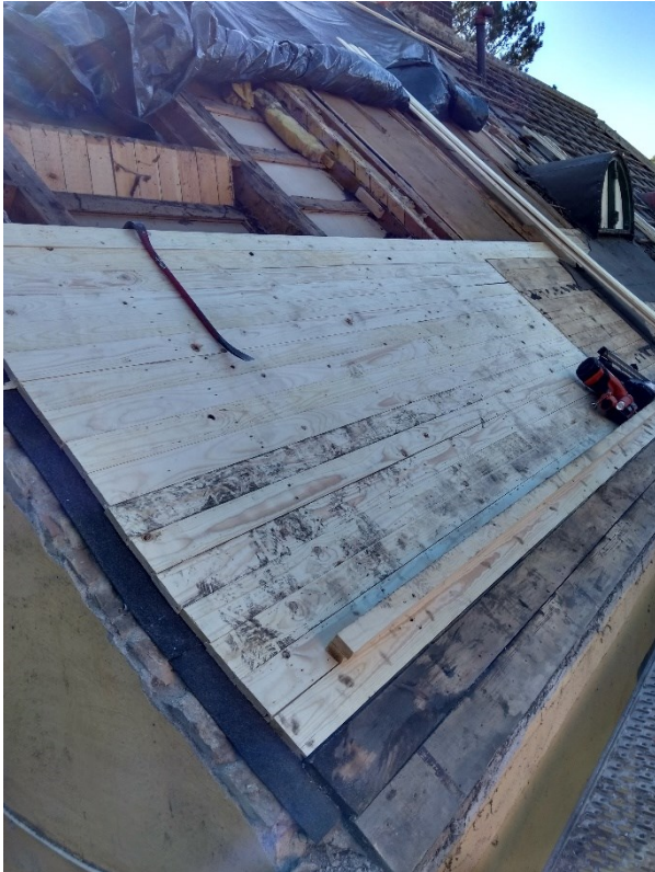
Under arbete. Norra takfallet. Höger: ny råspont läggs, här saknades masonite och isolering. Vänster: takpannorna har demonterats.
