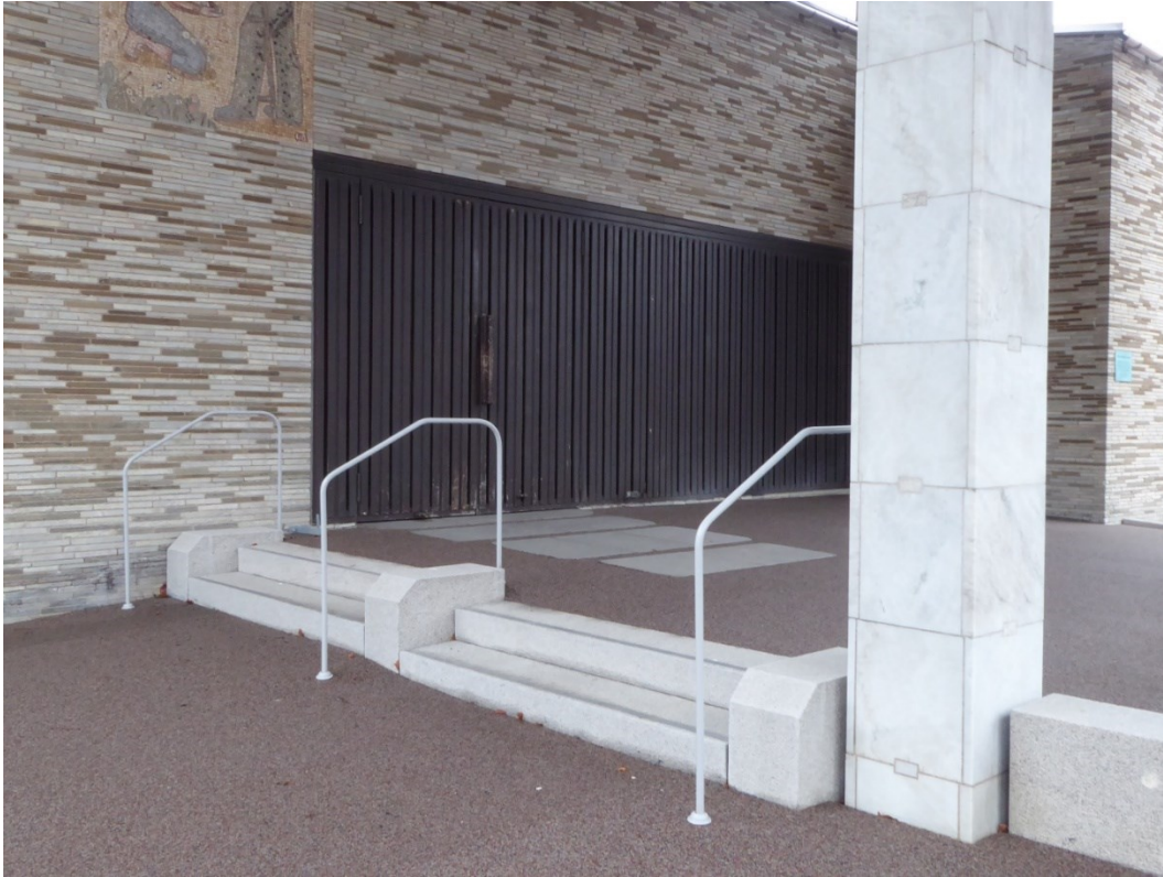
Ny trappa med räcken och limmat grus, bevarade stenhällar framför porten.
