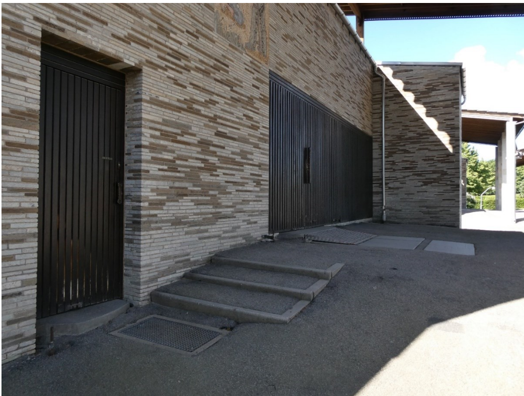
Asfalt, granithällar framför portar med ramp, trappor och skrapgaller.
