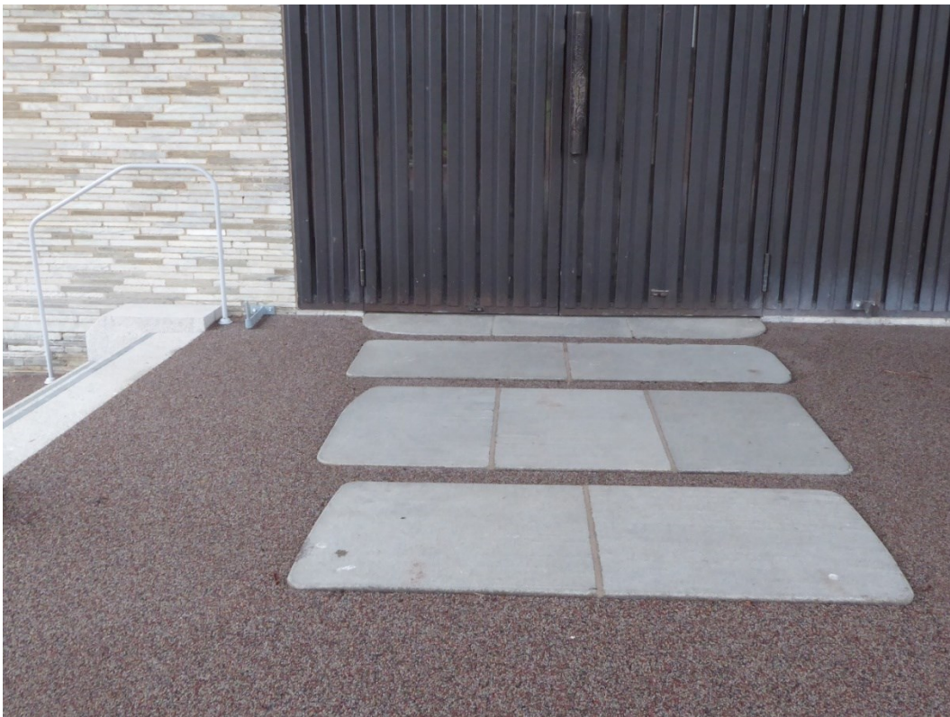
Nytt limmat grus och bevarade stenhällar som justerats.
