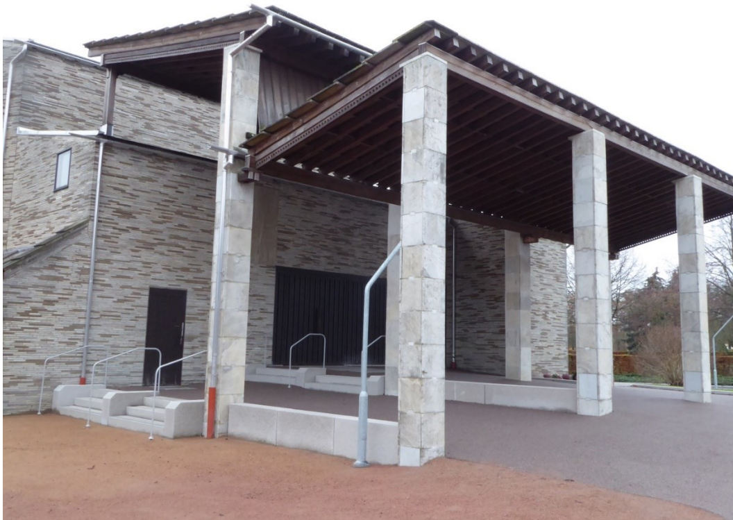
S:ta Gertruds kapell, ny markbeläggning Surestone och nya trappor och stödmurar.
