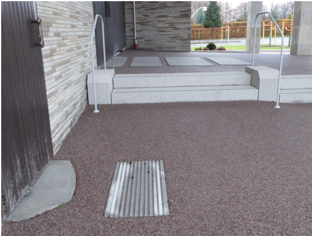
Ny trappa med räcken, bevarade stenhällar och nytt skrapgaller.
