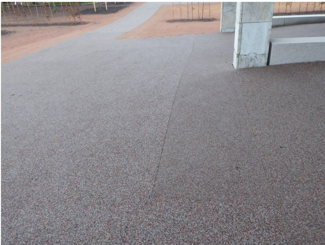
I Surestone finns vissa skarvar och skillnad i fraktion och färgnyans. Detta syns inte på håll.
