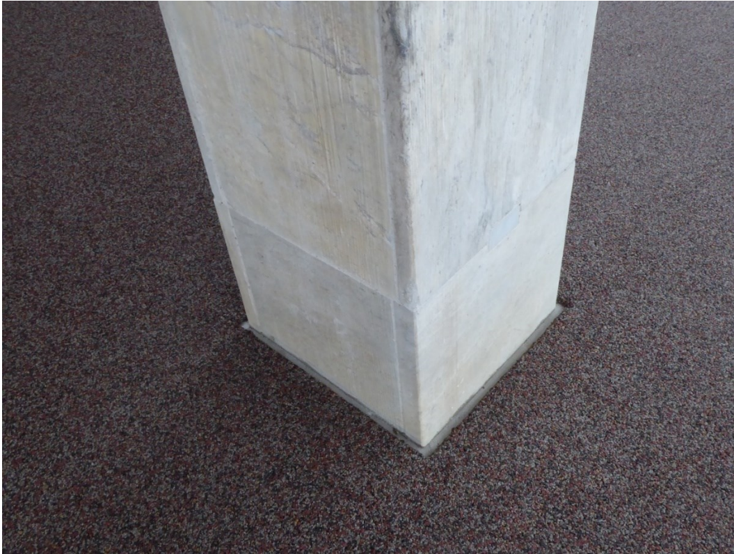
Möte mellan marmorklädd stolpe och limmat grus, återstår att fylla utrymmet med löst grus i nyans lika Surestone.
