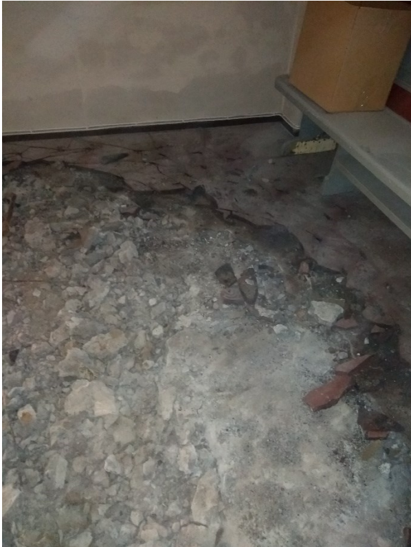
Under arbete. Dافةولمگولف och betongplatta bilas bort. Underliggande tegelgolv behölls.
