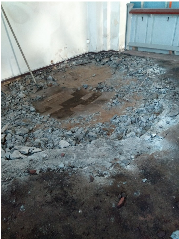
Dافةولمگولف och betongplatta bilas bort.
