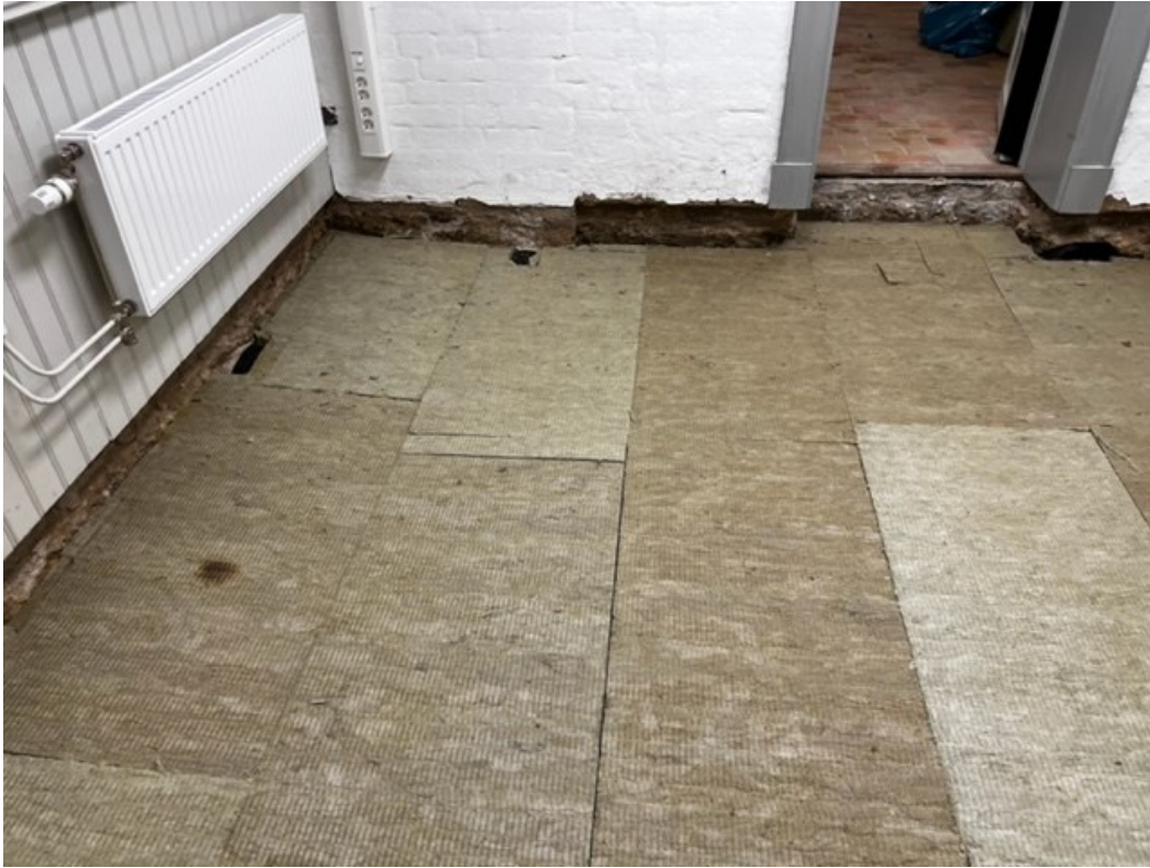
Isolering har lagts in, vy mot norr.
