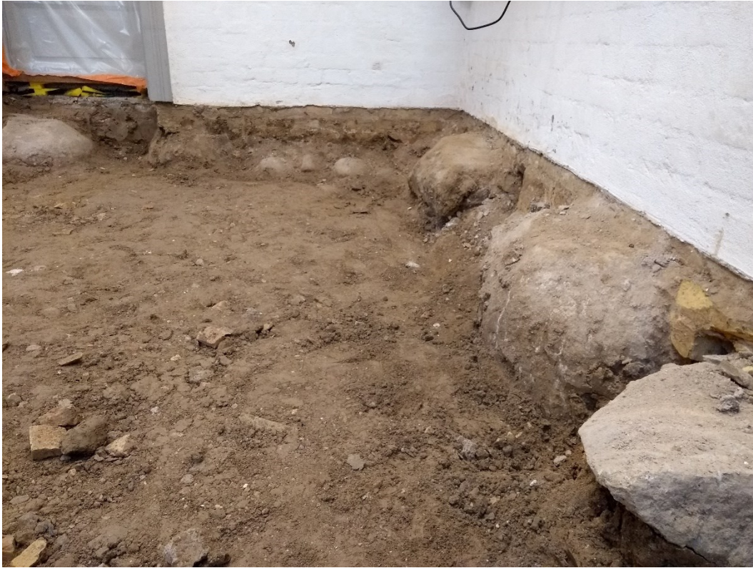
Södra väggen och grundstenar till höger i bild.
