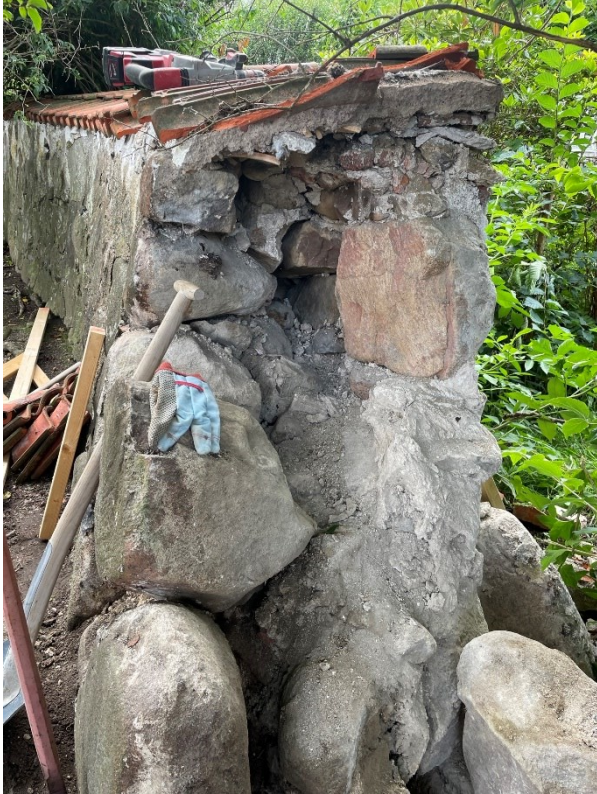
Vänster: Muren mot väster så långt som den plockades ner. Höger: Stenar och skärv tillvaratagna.
