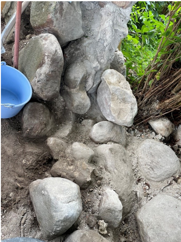
Vänster: Muren mot väster så långt som den plockades ner. Höger: Stenar och skärv tillvaratagna.
