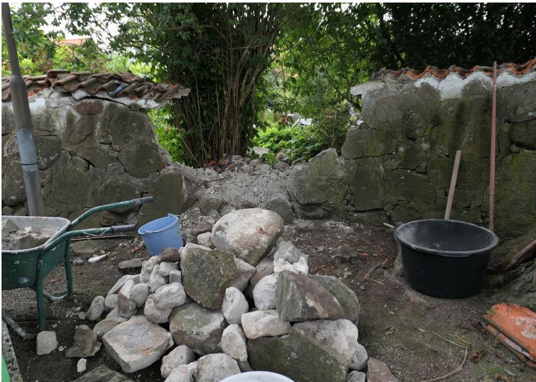
Nedplockning av muren har påbörjats, sett från kyrkogården.
