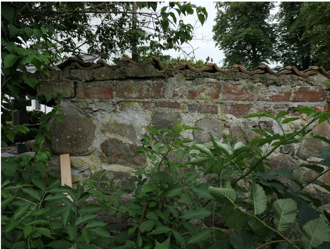
Murens utsida innan den plockats ner i slutgiltig omfattning.
