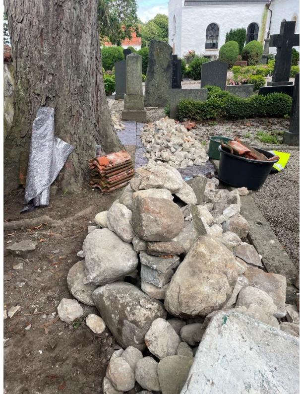
Vänster: Muren mot väster så långt som den plockades ner. Höger: Stenar och skärv tillvaratagna.
