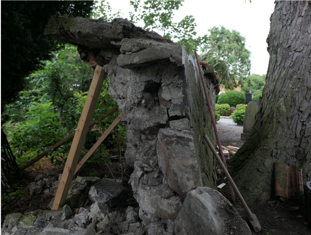
Murkonstruktionen sedd mot öster.
