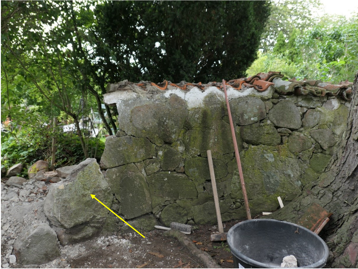
Murparitet under nedplockning. Pilen visar på en flat obearbetad sandsten.
