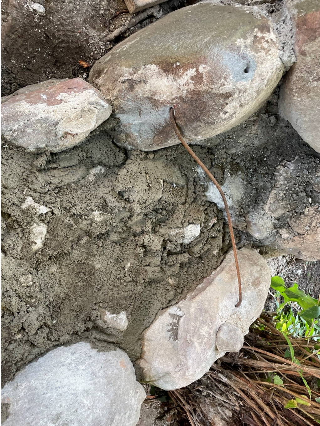
Armeringsjärn håller ihop murens stenar i utsida och insida. Bilden är tagen uppifrån.
