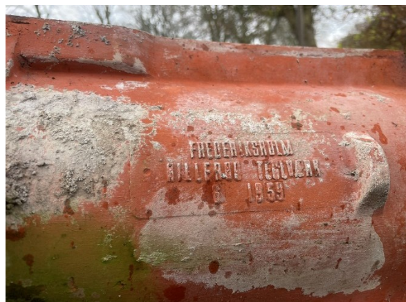
Vänster: Takpannor som fanns på det aktuella murparitet. Fredriksholm Hilleröd tegelverk, G 1959. Höger: Återvunna takpannor av samma fabrikat lades på det ommurade partiet.
