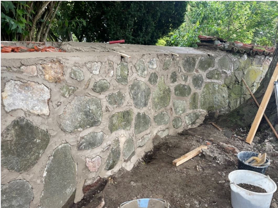
Muren under återuppförande.
