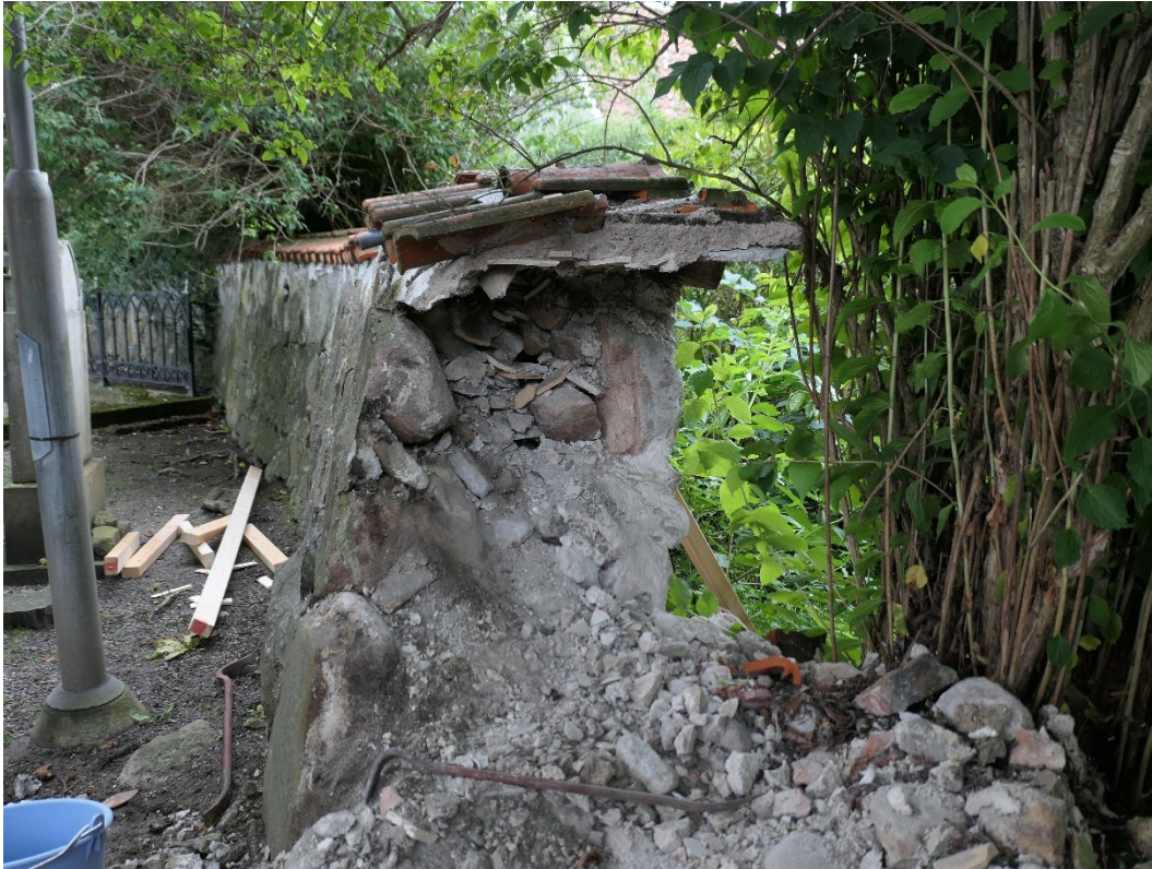
Murparitet när nedplockning påbörjats. På bilden ser man hur muren i det aktuella partiet lutar utåt.
