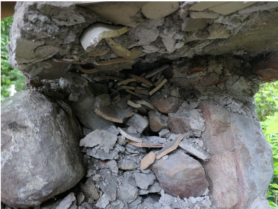
Murkonstruktionen mot väster (samma vy som på bilden ovan).
