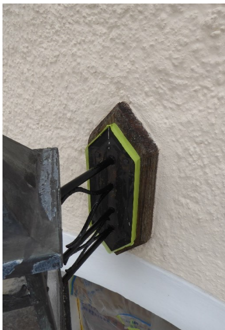
Lykta med rengjord armatursockel, norra korsarmen. Lykta med ny armatursockel. Återstod att ta bort tape och måla in skruvar vid fotograferingstillfället. Höger: gammalt och nya stänger för infästning av lyktan mot väster.
