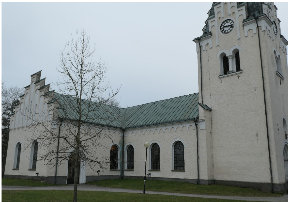
Kyrkan sedd från norr och nordväst.
