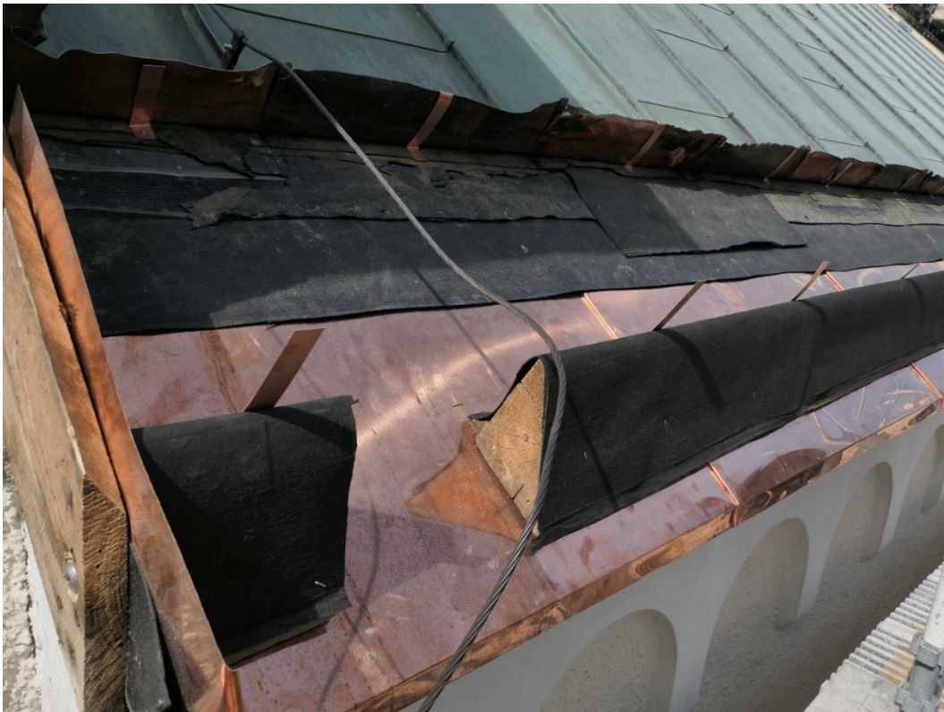
Foträna under återuppbyggnad, exempel från norra korsarmens östra sida.
