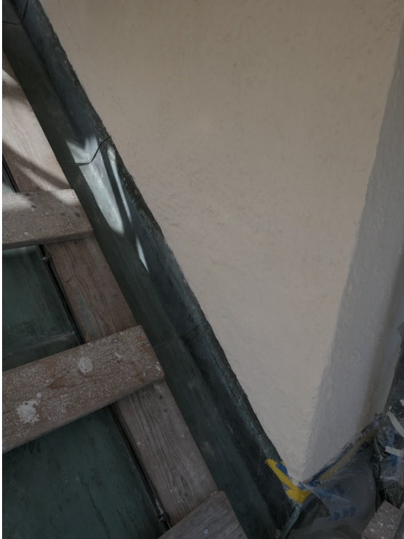
Exempel på anslutning befintlig plåt med putskant mot fasad. Höger: Mjukfog i anslutning mellan puts och plåt.
