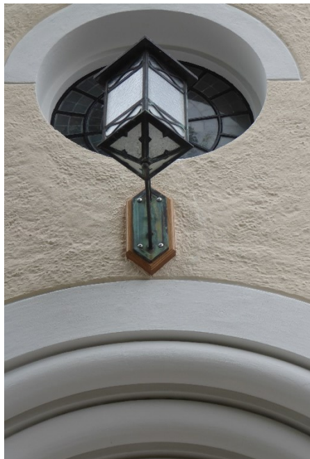
Lykta med rengjord armatursockel, norra korsarmen. Lykta med ny armatursockel. Återstod att ta bort tape och måla in skruvar vid fotograferingstillfället. Höger: gammalt och nya stänger för infästning av lyktan mot väster.
