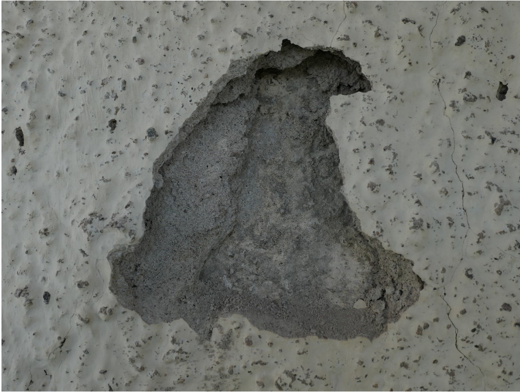
Tornet. Underliggande äldre spritputs.
