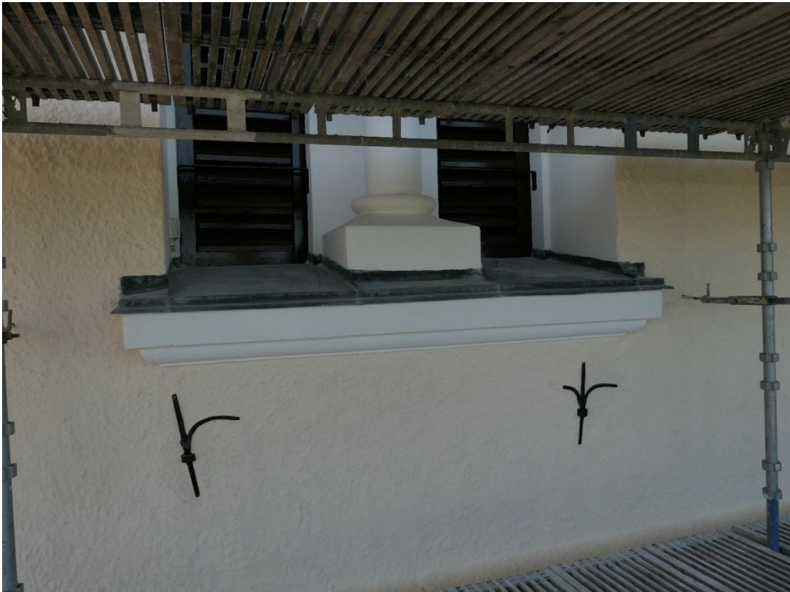
Tornet, exempel på fasad, luckor och ankarjärn.
