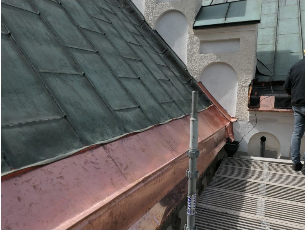
Ny fotränna under uppbyggnad. Notera den gamla plåten som inte är nedbankad vid mötet med den nya plåten eftersom den gamla plåten då riskerar gå sönder.
