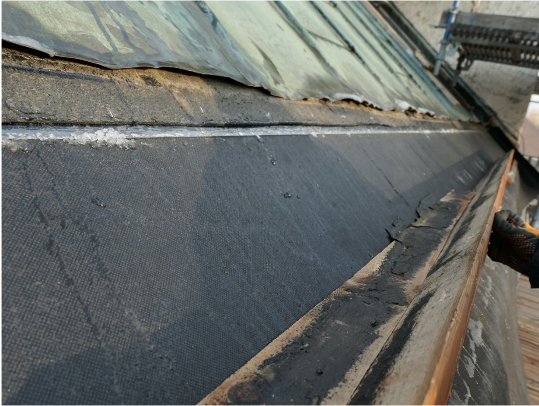
Fotrännan var uppbyggd med för litet fall. I vinkeln var endast lagt en liten kil för att skapa fall.
