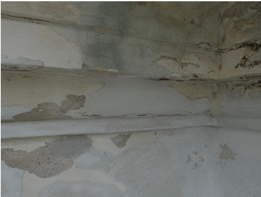
Tornet. Underliggande äldre spritputs.
