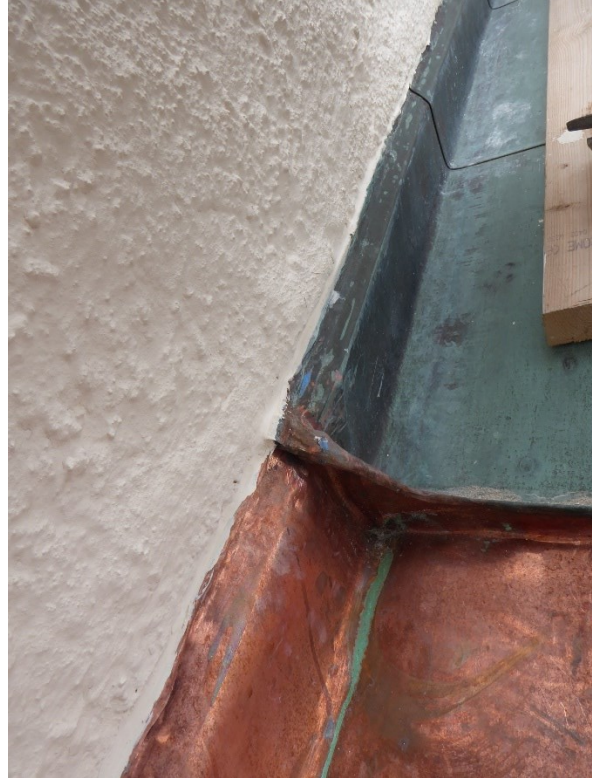
Exempel på anslutning befintlig plåt med putskant mot fasad. Höger: Mjukfog i anslutning mellan puts och plåt.
