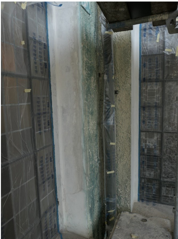
Missfärgningar i hörnen där långhus möter korsarmar.
