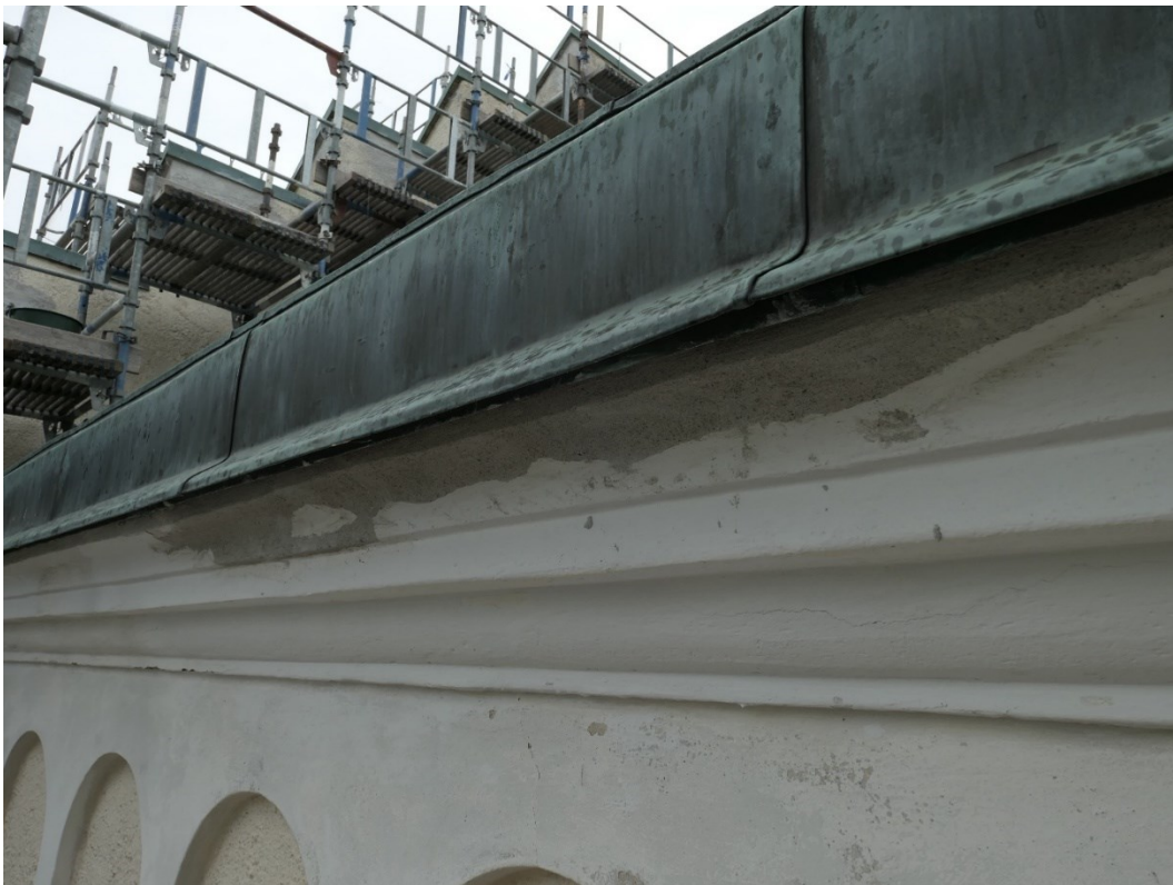
Exempel på lagning av takfotsgesims. Norra korsamen mot väster.
