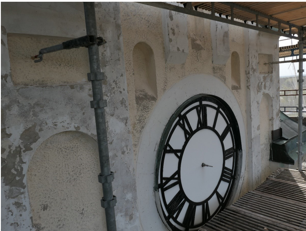
Ny fotränna under uppbyggnad. Notera den gamla plåten som inte är nedbankad vid mötet med den nya plåten eftersom den gamla plåten då riskerar gå sönder.
