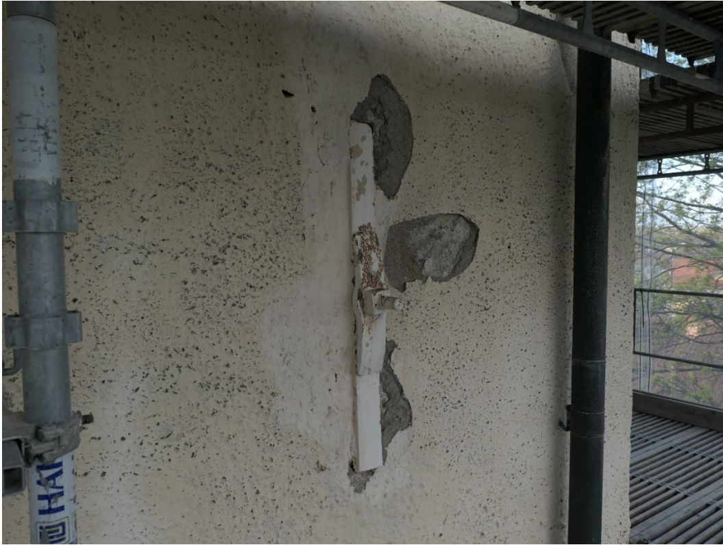
Exempel på fasad och ankarjärn efter tvätt, tornet.
