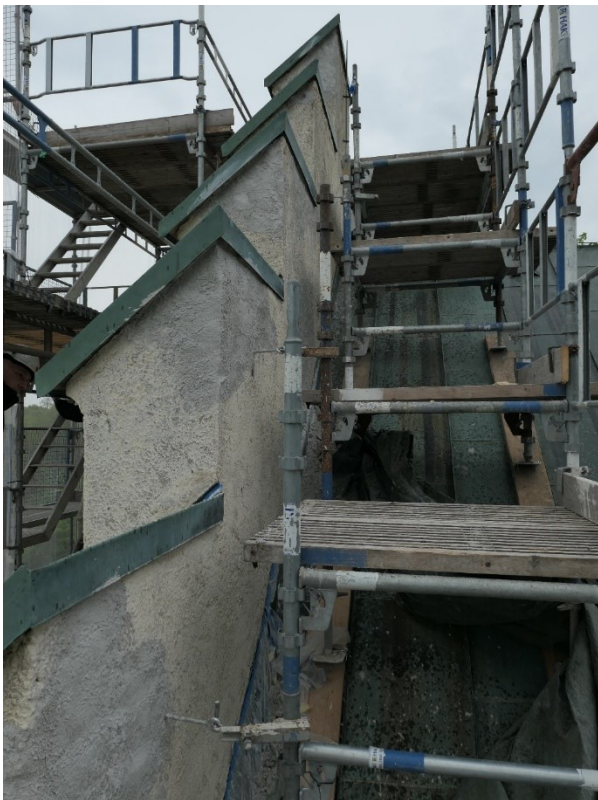
Tinnar efter lagning. Höger: Sandstensblock i tornets västfasad under det runda fönstret
