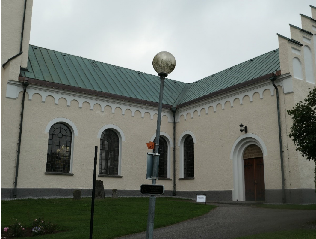
Långhusets södra sida och södra korsarmen.
