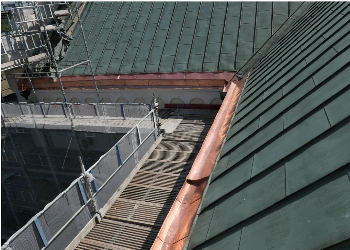
Exempel på anslutning befintlig plåt med putskant mot fasad. Höger: Mjukfog i anslutning mellan puts och plåt.
