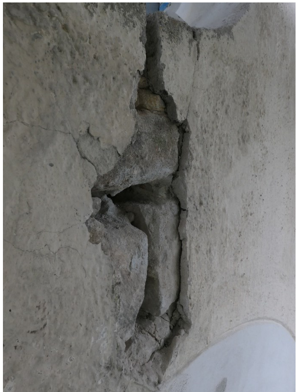
Tinnar efter lagning. Höger: Sandstensblock i tornets västfasad under det runda fönstret
