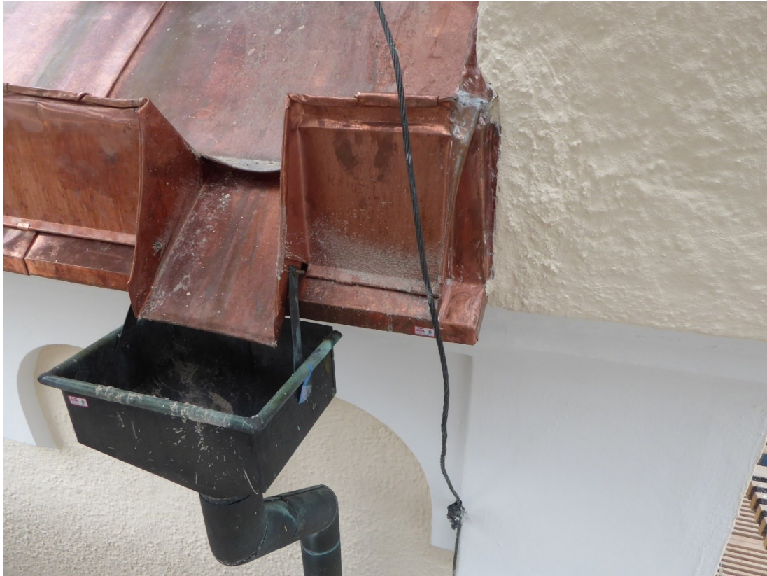
Exempel på avvattning, vattkuporna behövs eftersom de bedömdes som tillräckliga.
