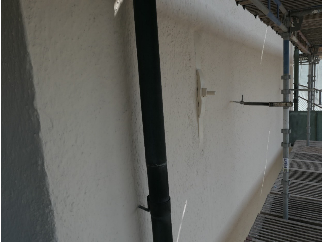
Tornet, exempel på fasad med ankarjärn.
