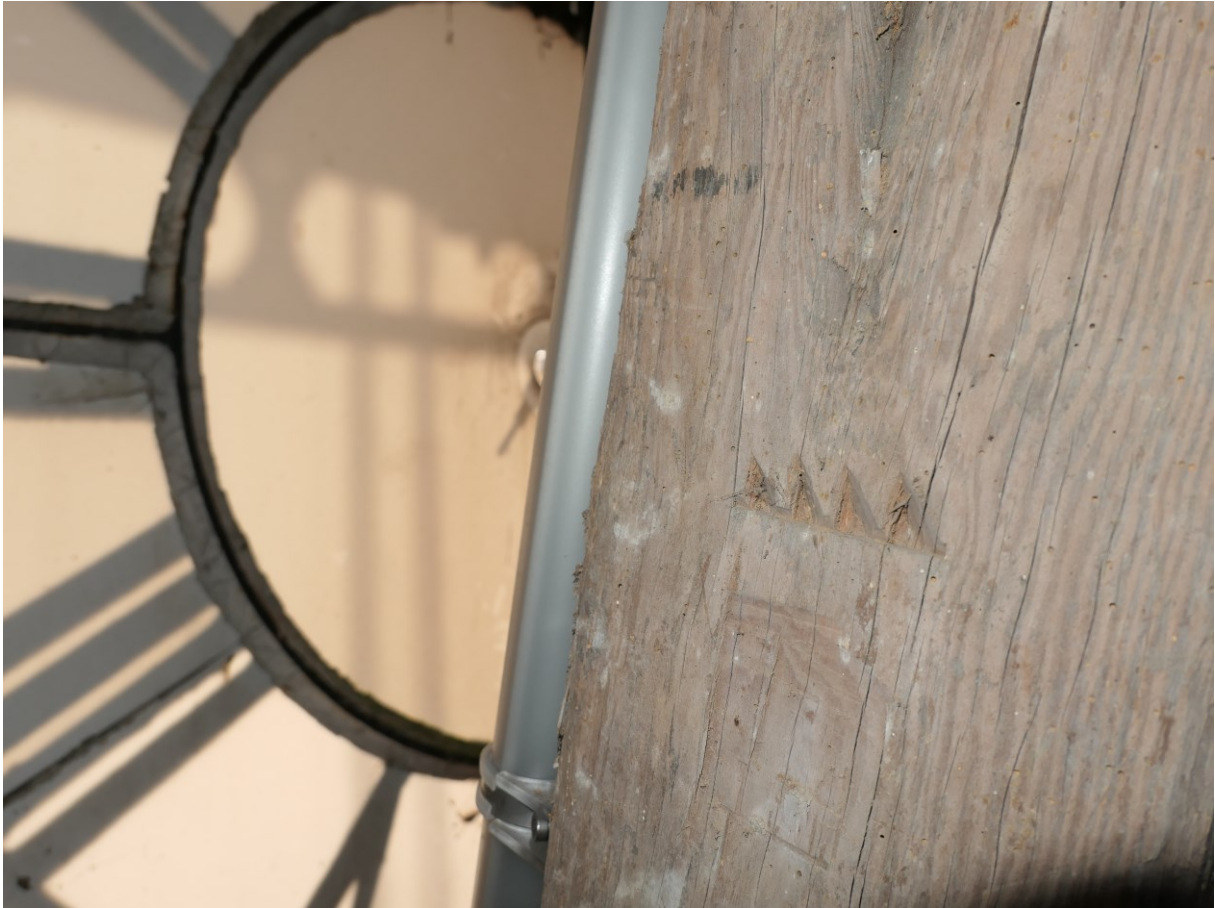
Klockvåningen, timmermansmärkning på sparrar.
