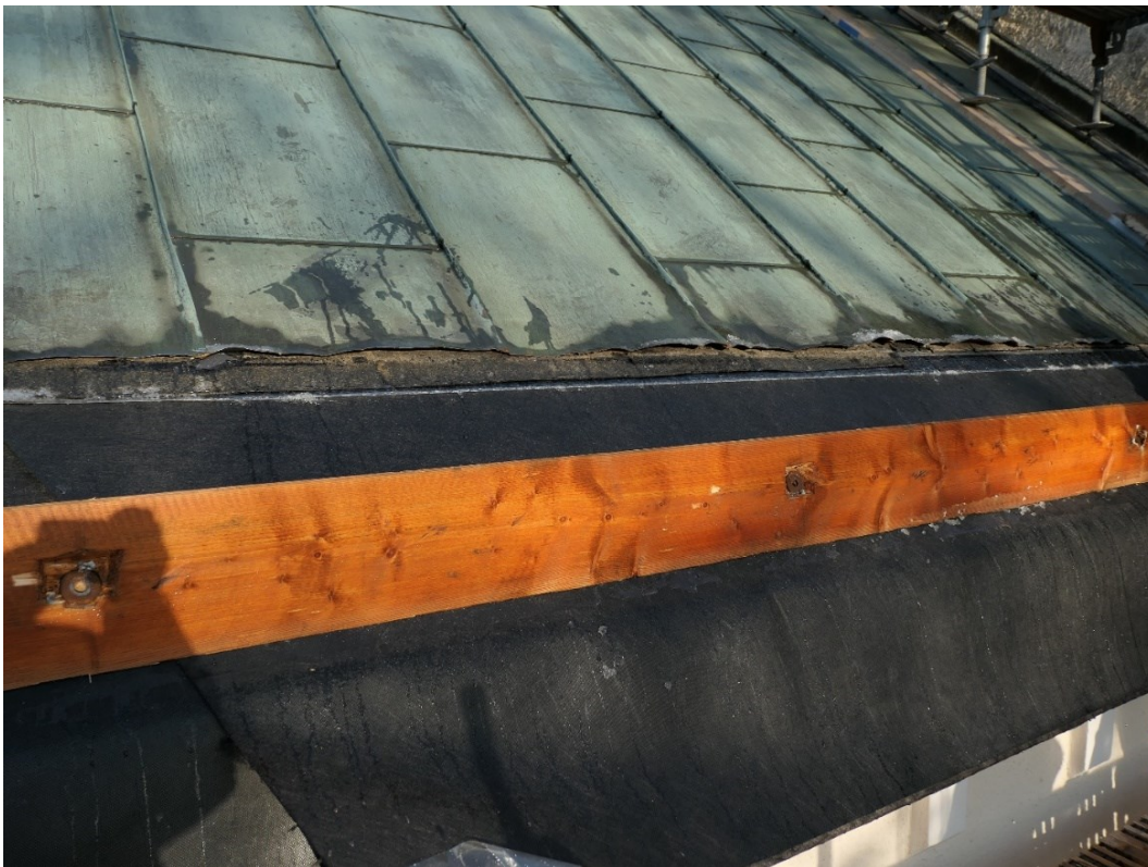
Fotrännan var uppbyggd med för litet fall. I vinkeln var endast lagt en liten kil för att skapa fall.
