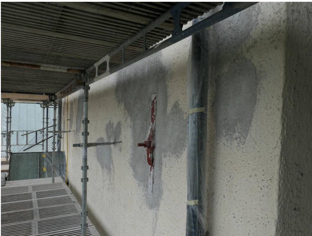
Exempel på fasad och ankarjärn efter tvätt, tornet.
