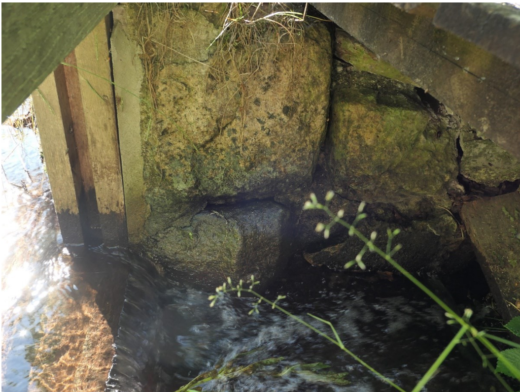
Muren vid utskovet och by-passluckan är lagd i cement, södra sidan.
