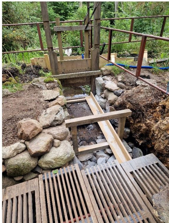
Delen norr om utskovet, vy mot kvarnen. Utskovets ränna kläs in med brädor. Foto Gunnar Zackrisson.
