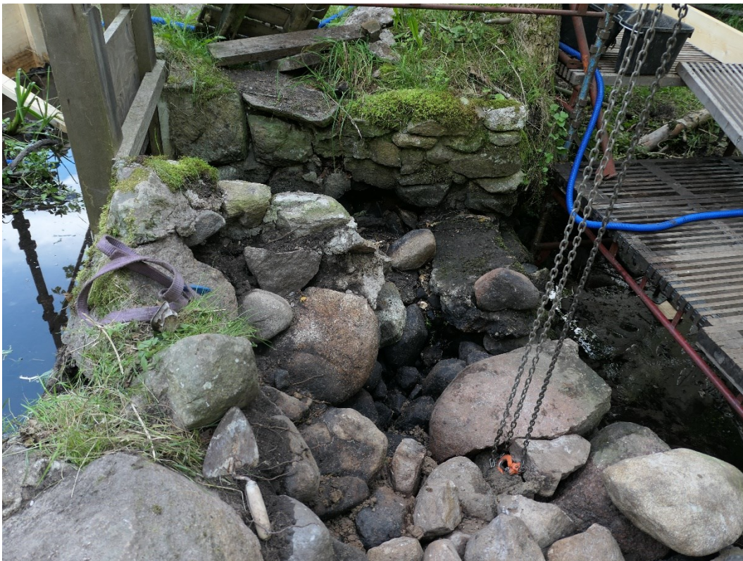
Stenarna i mitten läggs i lera.
