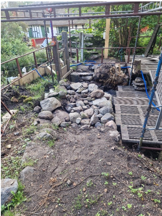
Delen norr om utskovet, vy mot kvarnen. Utskovets ränna kläs in med brädor. Foto Gunnar Zackrisson.
