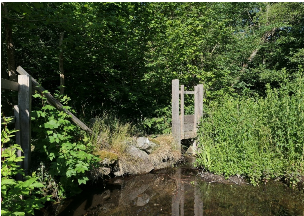
Hålldammen med by-passlucka sedd från kvarnen. Denna sida av muren som vetter mot dammen har inte plockats ner.
