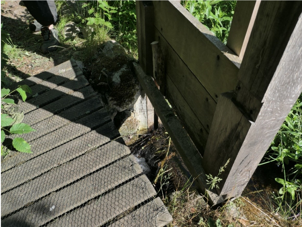
Muren vid utskovet och by-passluckan, norra sidan, lagd i cement.
