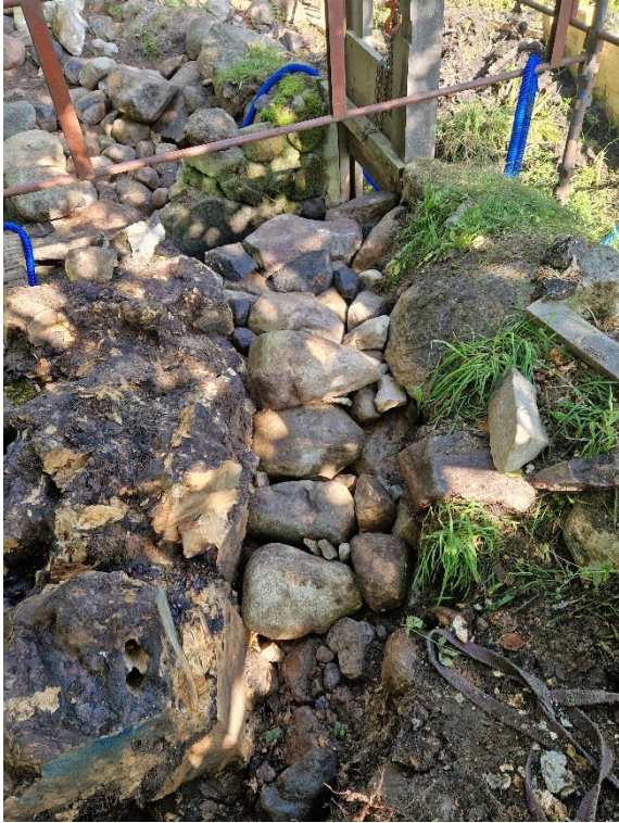
Delen söder om utskovet läggs om. Foto Gunnar Zackrisson.
