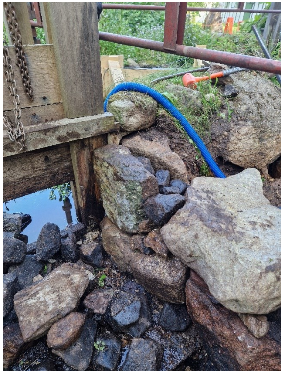
Söder om utskovet stenar lyfts upp, cement tas bort, och stenar återplaceras. Foto Gunnar Zackrisson.
