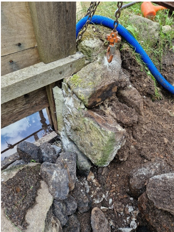
Söder om utskovet stenar lyfts upp, cement tas bort, och stenar återplaceras. Foto Gunnar Zackrisson.
