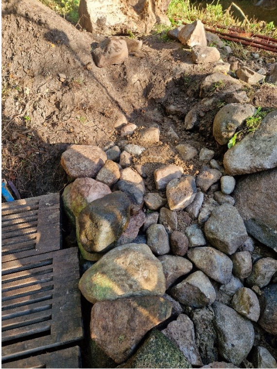
Delen norr om utskovet läggs om. Foto Gunnar Zackrisson.
