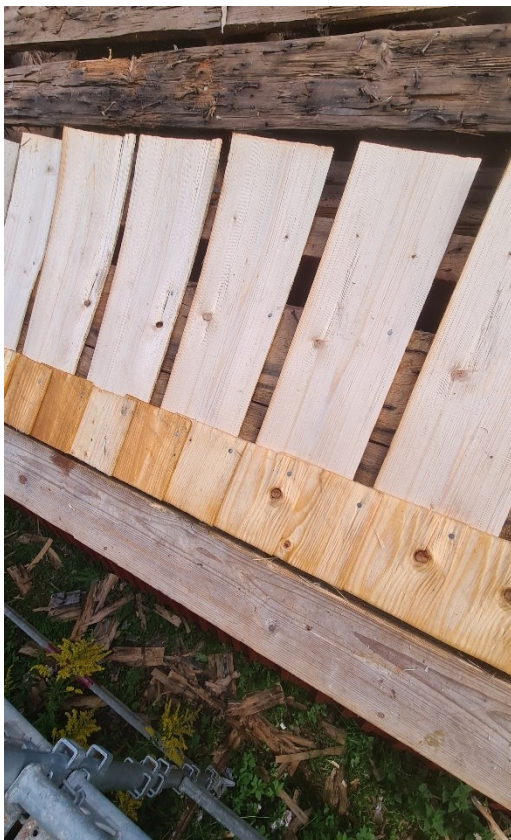
Under arbete. Spånen rivs och nya läggs med förskalning och nya täckande spån. Foto Henrik Englund
