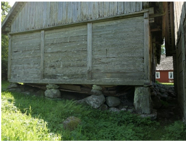
Före åtgärder. Golvbjälke som brutit i befintlig skarv.
