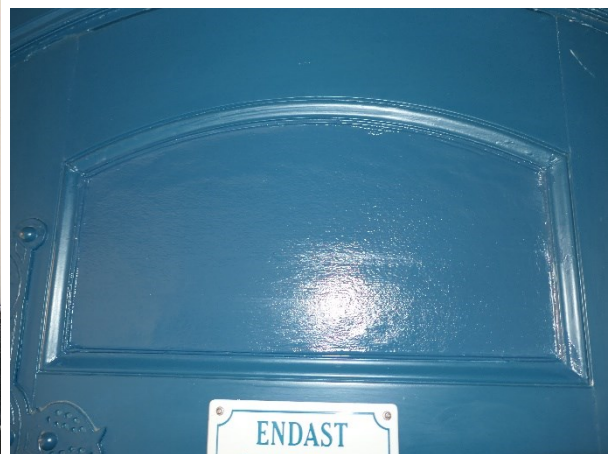
Dörr 18. Brandskyddsfilm har målats med brandskyddsfärg. Höger: färdigmålad yta i spegeln, det syns viss skillnad i strukturen på brandskyddsfilm och trätor.
