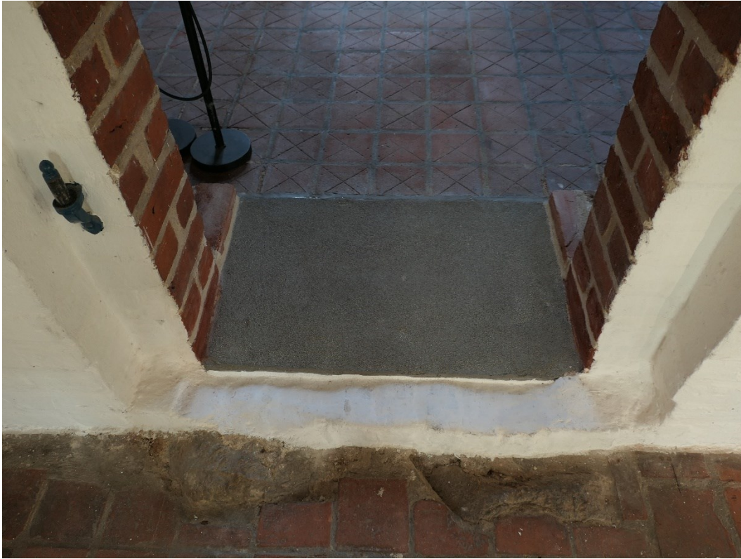
Tröskel har tagits bort mellan korsgången och kapitelsal/utställning och nygjutning på befintligt underlag, innan ny ramp monterats.
