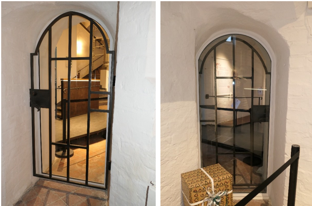
Nytt glas i öppningen, vid fotograferingstillfället återstod att måla in stålramens skruvar i vit färg.
