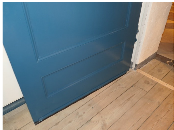
Dörr 8 kompletterad med svällist i karm, gummlist i dörrbladets nedkant samt brandskyddsfilm och målad med linoljefärg.
