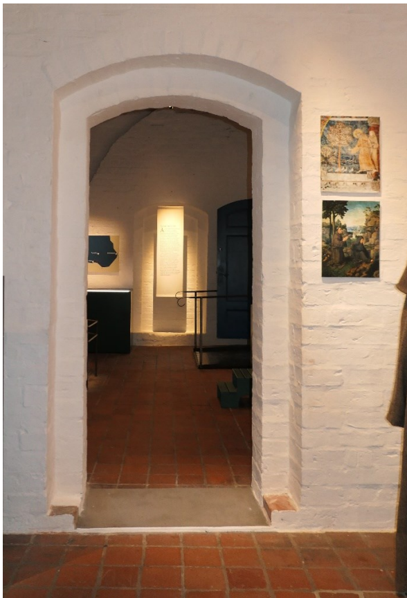
Efter åtgärder. Tröskel som sänkts mellan kapitalsal och refektorium (utställningsrum).
