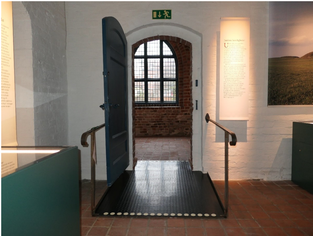
Ramp som byggts om mellan korsgången och kapitelsal/utställning.
