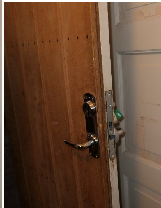
Dörr 5B, före åtgärder samt efter åtgärder med nytt trycke på båda sidorna samt el till lås.
