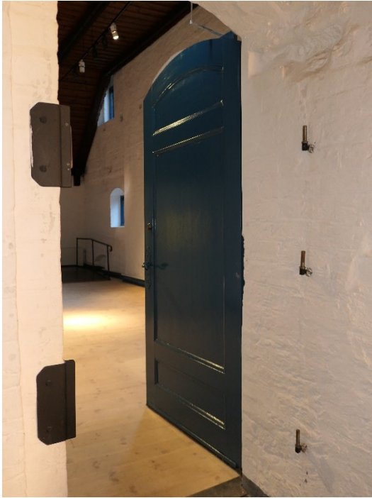
Dörr 7 efter åtgärder. Häger: detalj på svällist som klippts för att följa öppningens form.
