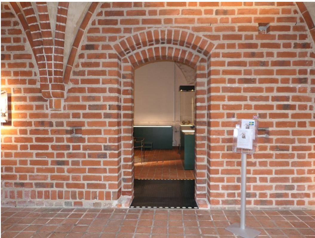
Tröskel har tagits bort mellan korsgången och kapitelsal/utställning och nygjutning på befintligt underlag, innan ny ramp monterats.
