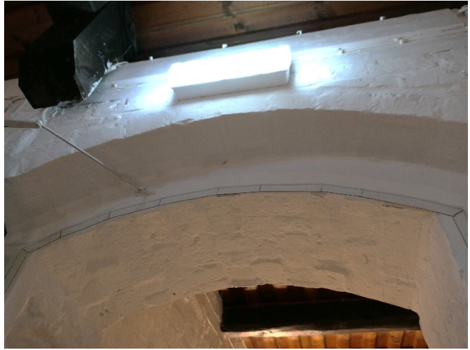
Dörr 7 efter åtgärder. Häger: detalj på svällist som klippts för att följa öppningens form.
