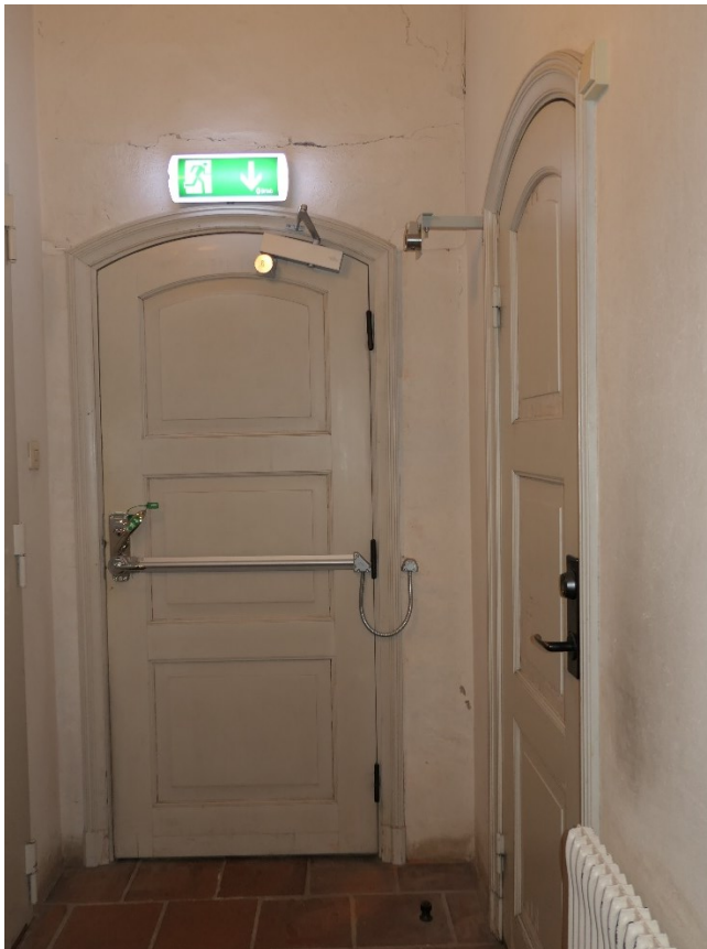
Dörr 5B, före åtgärder samt efter åtgärder med nytt trycke på båda sidorna samt el till lås.
