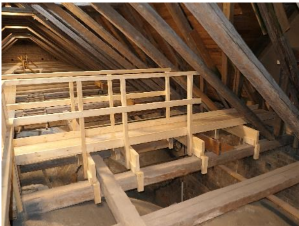
Nybyggd landgång som leder från klostret/museet över kyrkvinden och fram till spiraltrappan i kyrkan.
