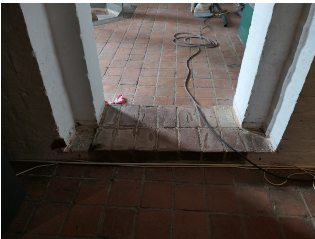
Ramp har demonterats mellan korsgången och kapitelsal/utställning. Tröskel byggd 1912 är synlig.
