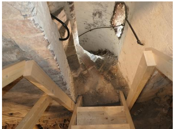
Nybyggd landgång som leder från klostret/museet över kyrkvinden och fram till spiraltrappan i kyrkan.
