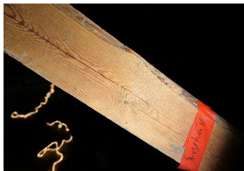
Klostrets vind. Provytor isblästring, ångtvätt och slipning.
