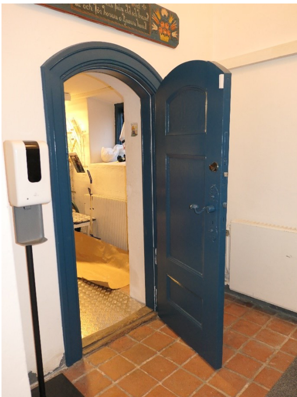
Dörr 1a före åtgärder, när brandskyddsfilm är monterad samt efter att dörren målats klart.
