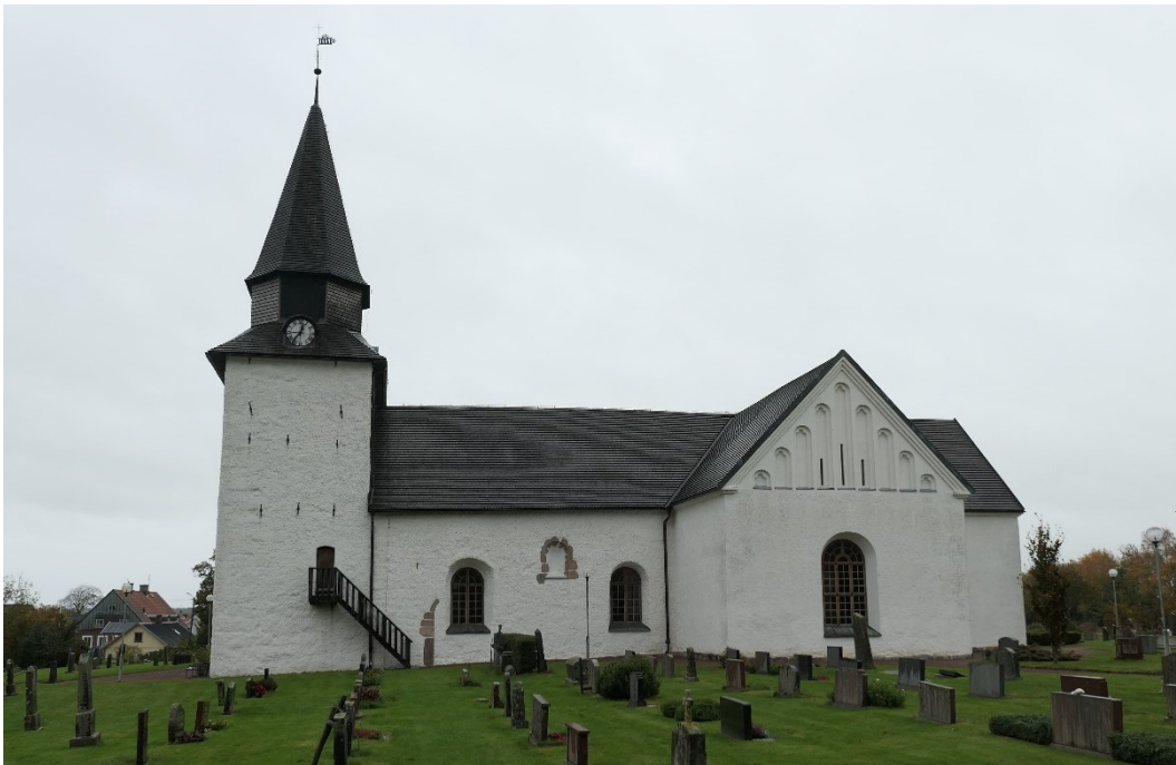
Före åtgärder. Kyrkan sedd från söder.
