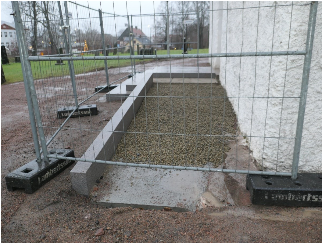
Under arbete. Notera grundstenen vid kyrkans sydvästra hörn.
