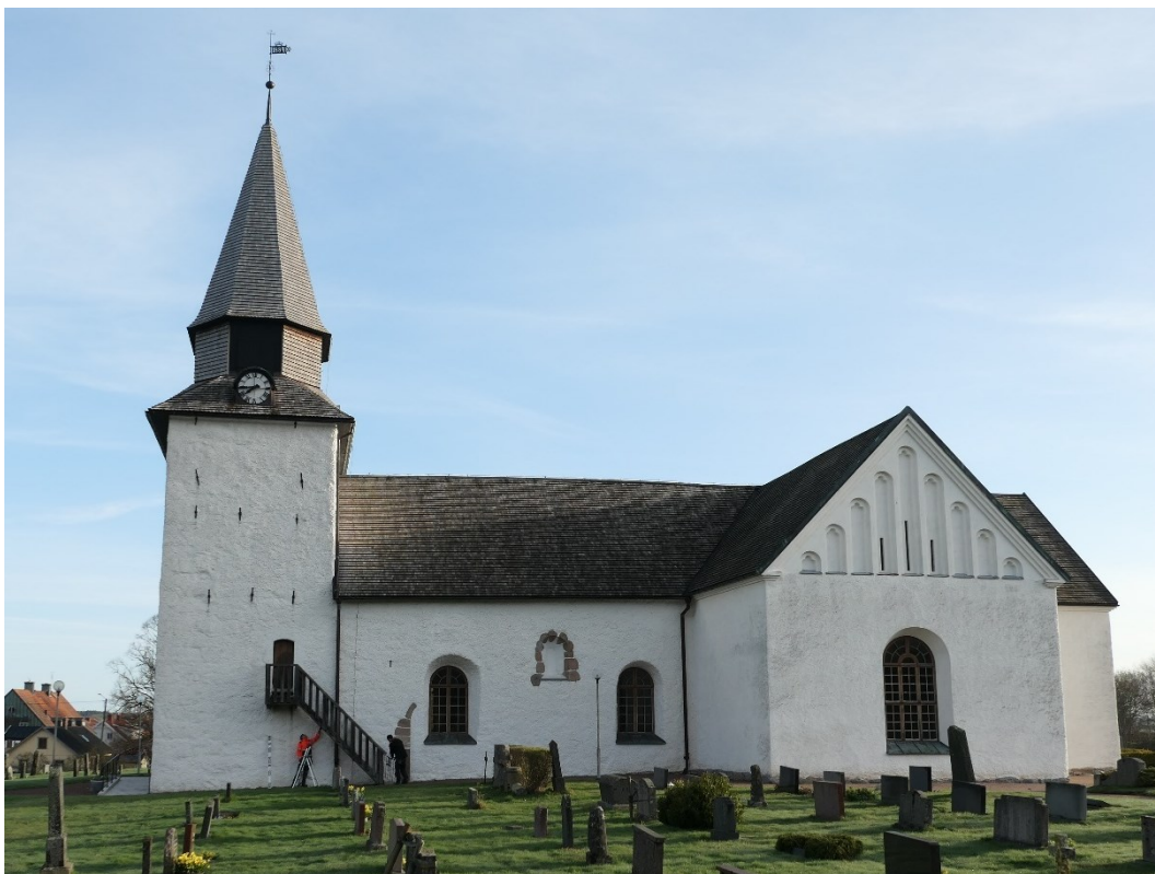
Efter åtgärder. Den nya rampen finns vid tornets västra fasad.
