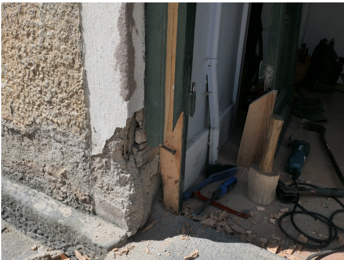
Under arbete. Lagning av den södra dörrkarmen.
