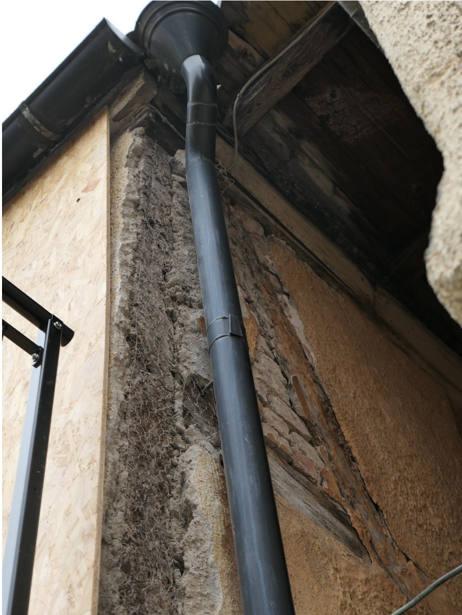
Under arbete, sydvästra hörnet innan lagningar av korsvirket.
