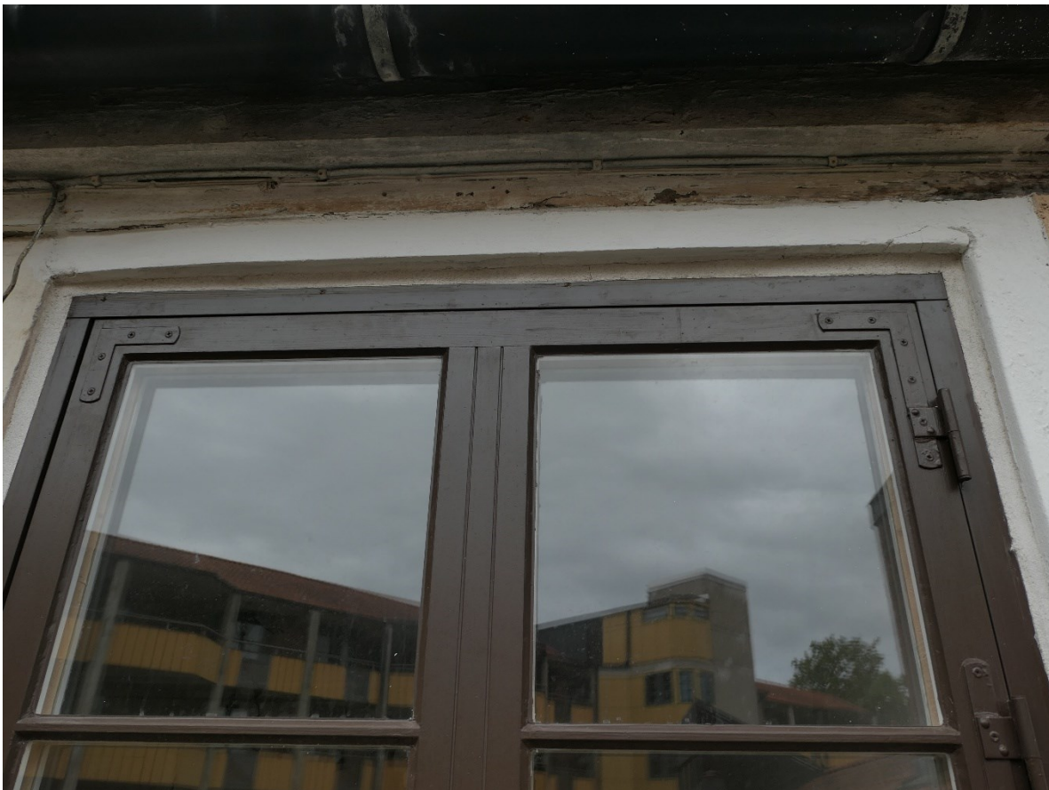
Detalj av nya branddörren utvändigt.
