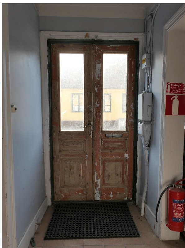
Under arbete. Dörren är vänd i slagriktning. Trälagningar på dörren syns som omålade delar.
