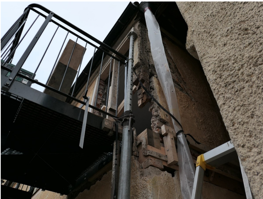
Under arbete, sydvästra hörnet.
