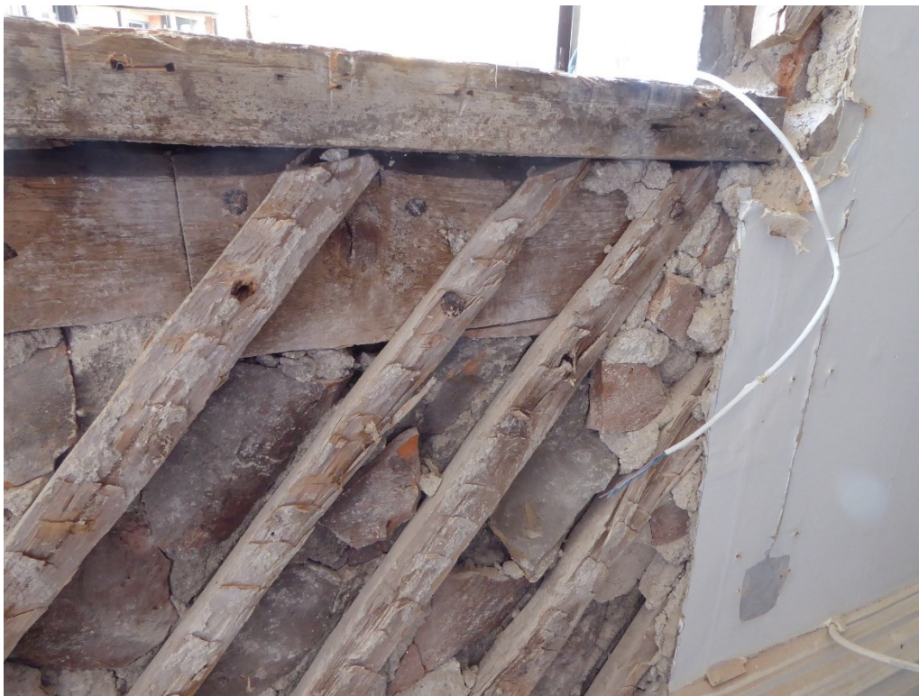
Påbörjad öppning under fönstret som ändrades till dörr. Spräckpanel och fyllning av tegelskärv, skärv av enkupiga tegelpanor och kalkbruk.
