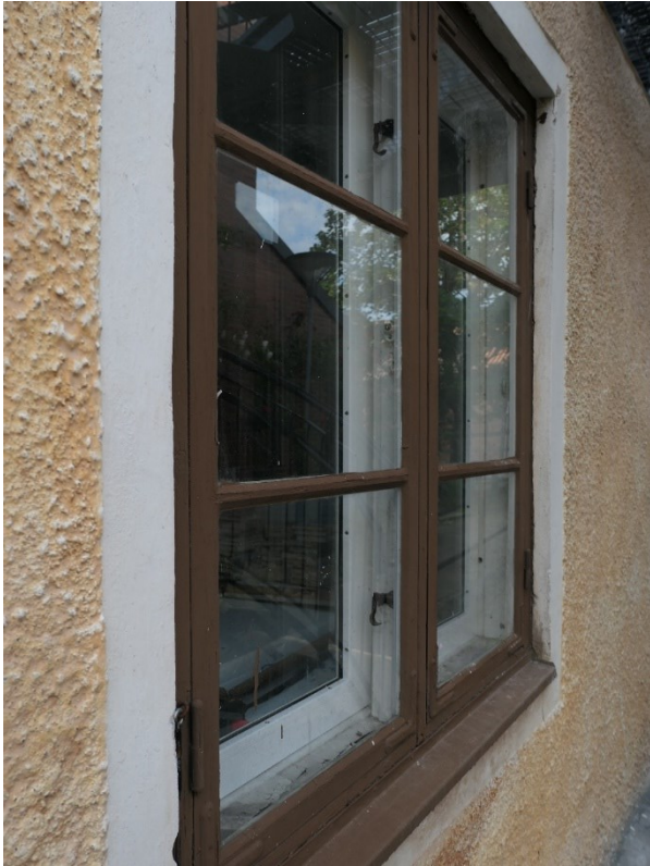
Fönster mot innergården där en ny båge med brandklassat glas monterats. Höger: nya branddörren invändigt. putsad innervägg, återmonterad golvlister, ny brandskylt. Återstod vid fotograferingstillfället att måla väggen med diffusionsöppen vit färg.
