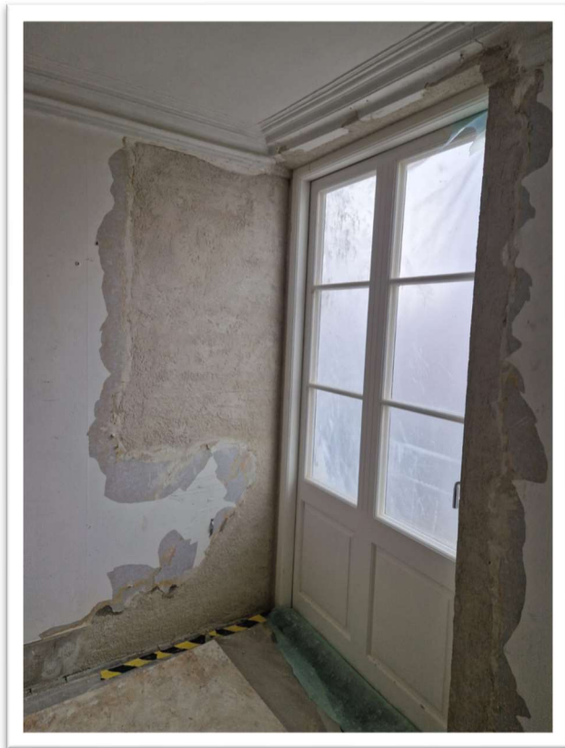
Efter. Färdigputsad smyg och invändig väggyta.
