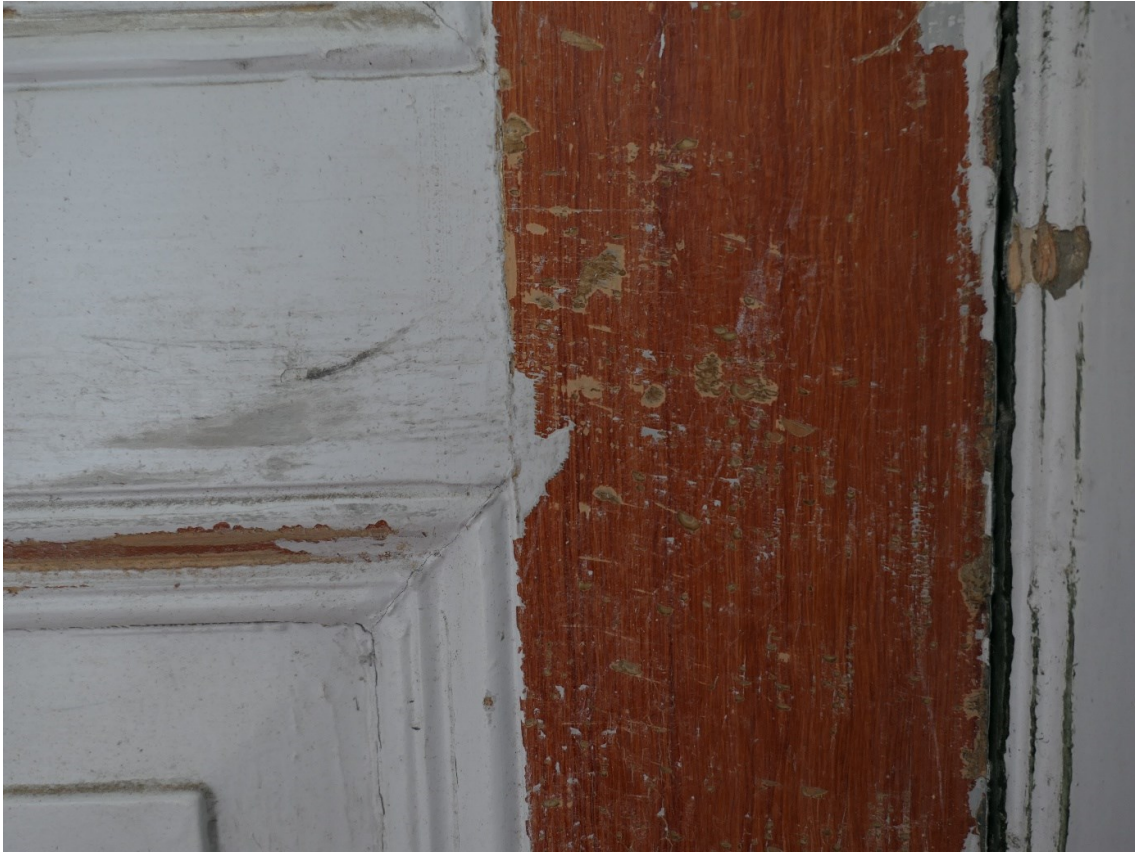
På pardörren mot Bredgatan finns ådringsmålat färgskikt under den gråvita färgen.
