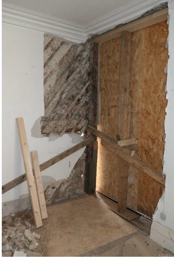
Under arbete. Rötskadad hörnstolpe invändigt, i sydvästra hörnet på ovanvåningen. Invändigt ytskikt är nedtaget på innerväggen mot söder.
