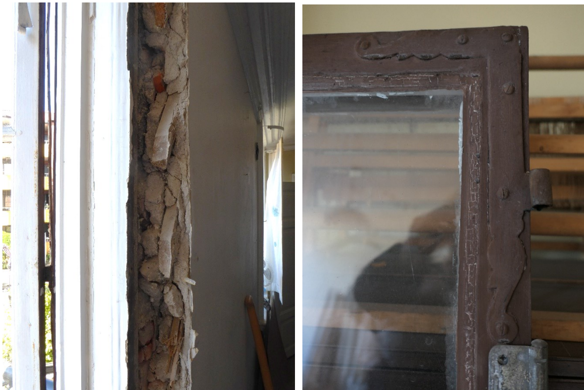
Innervägg som finns kvar mot väster. Fönstret som monterades bort, hörnjärn.
