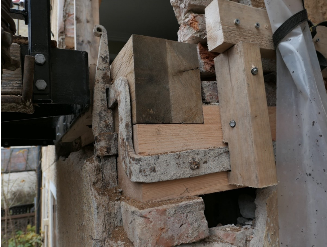
Murremmarna i sydvästra hörnet byttes ut och befintligt järn återmonterades.
