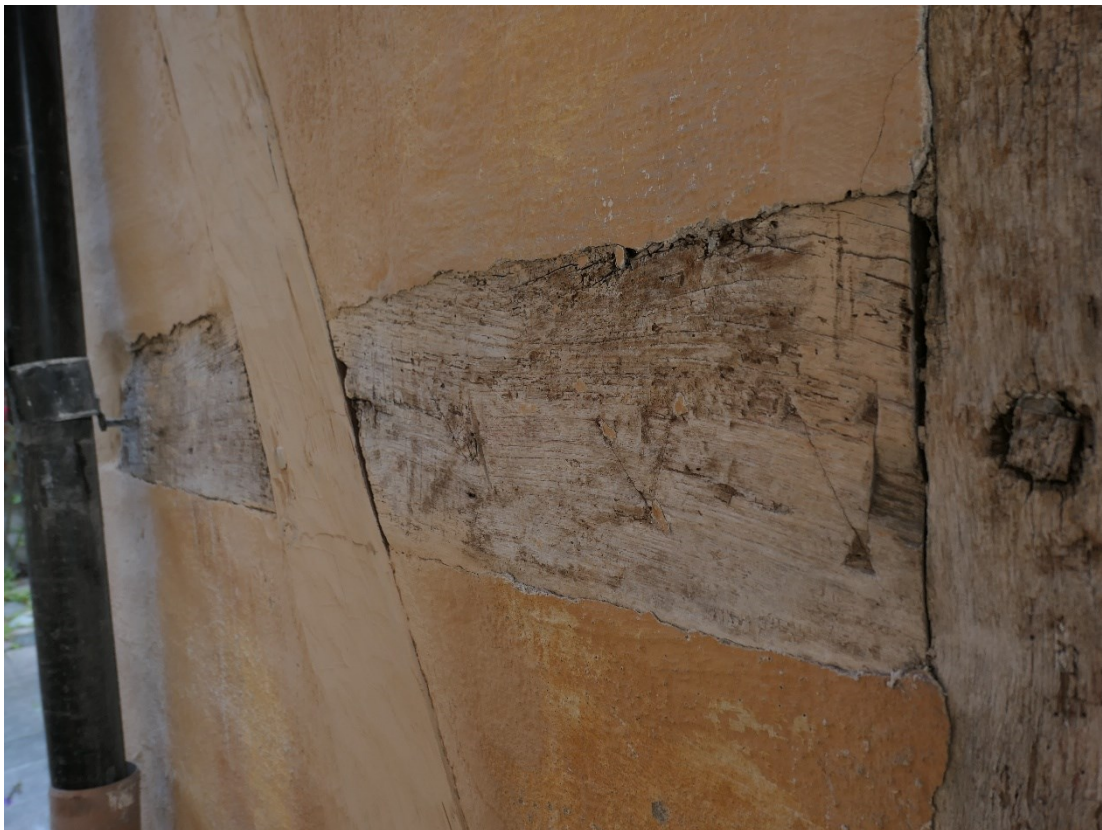
Efter åtgärder. Södra gavelväggen. Skarvad snedsträva. Bevarad löshult med hantverksmarkering som bevarats.
