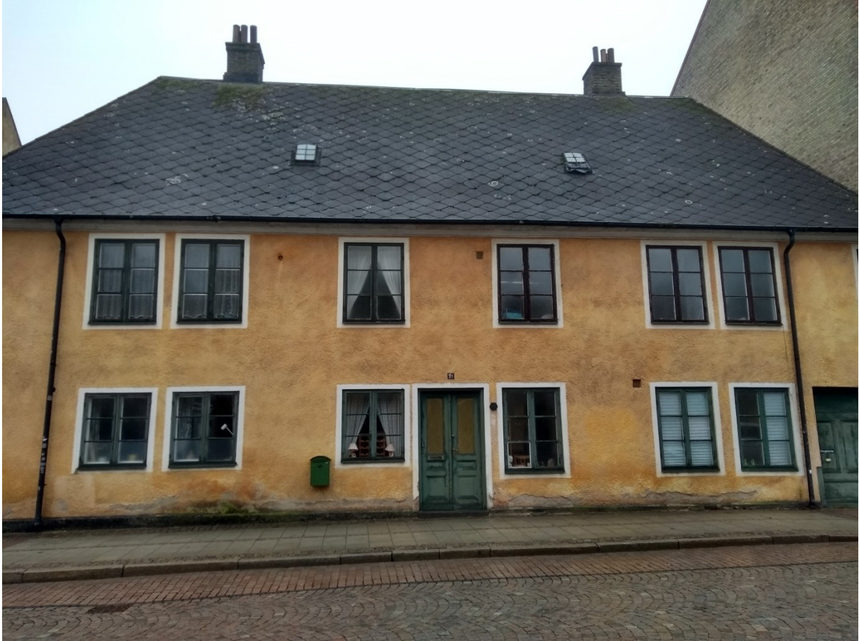
Före åtgärder. Gatufasad mot Bredgatan.
