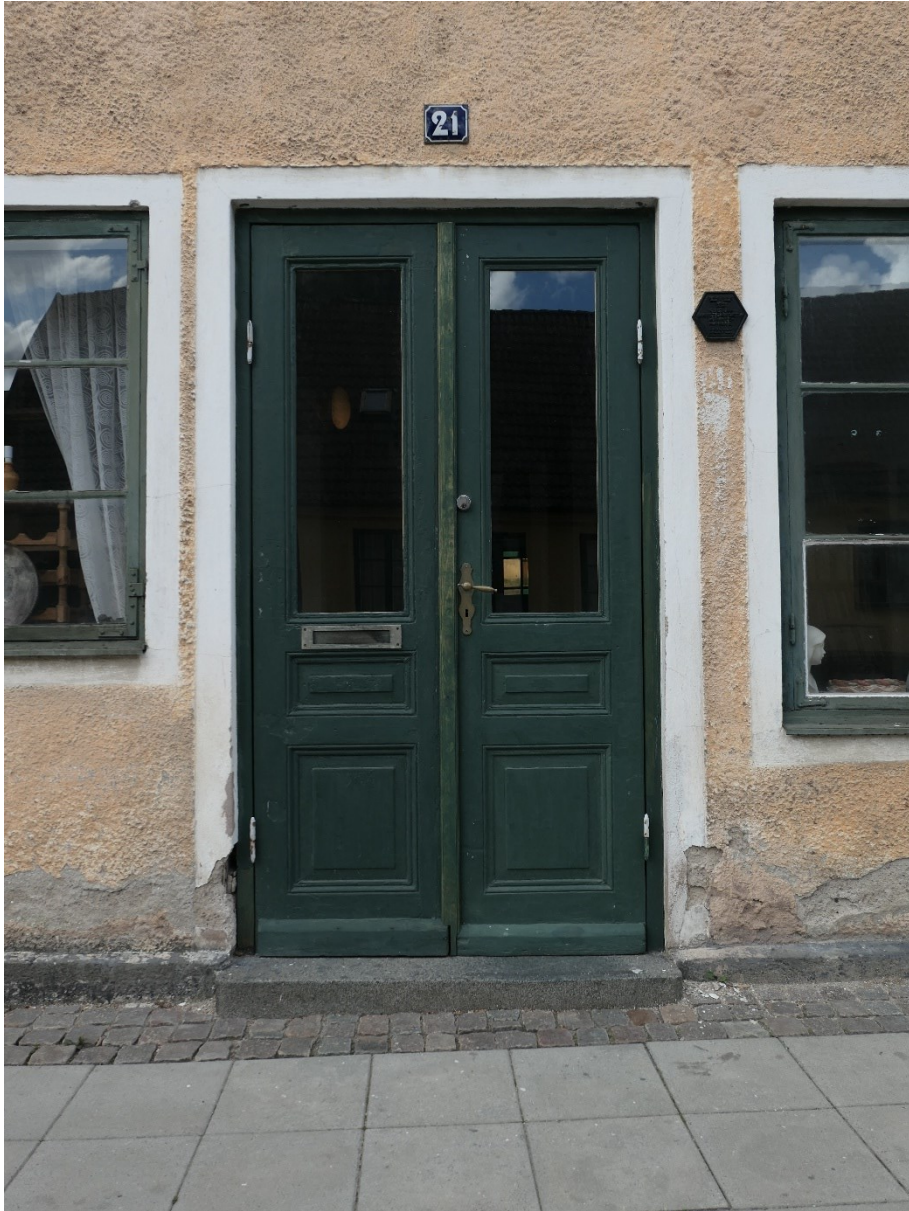
Ytterdörren mot Bredgatan efter åtgärder. Återstod att måla slaglisten och gångjärnen.
