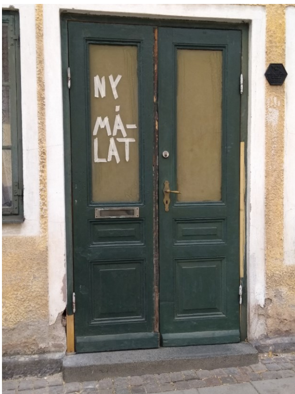
Under arbete. Dörren är vänd i slagriktning. Trälagningar på dörren syns som omålade delar.
