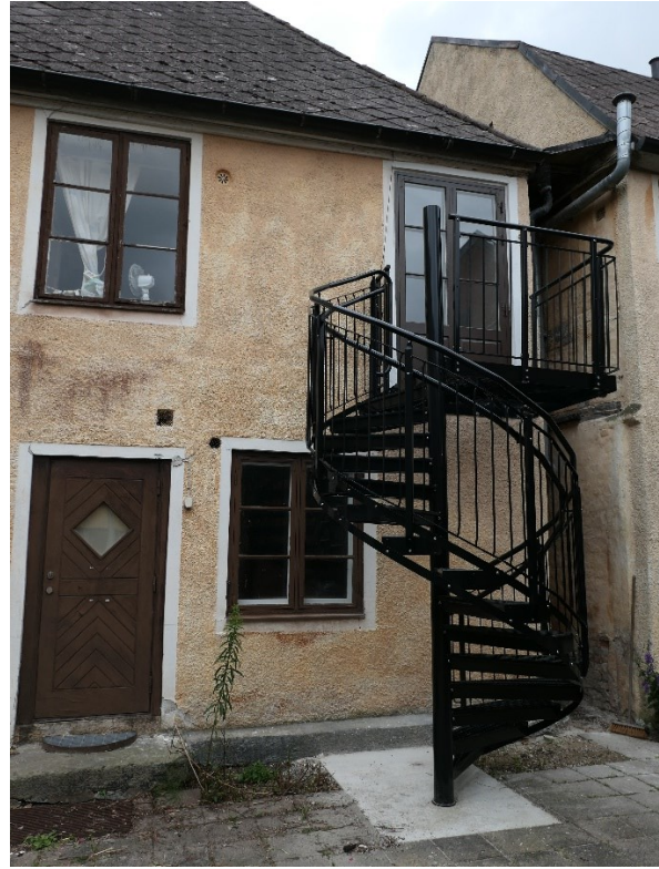
Gårdsfasad. Före och efter åtgärder, ny brandtrappa och utrymningsdörr.
