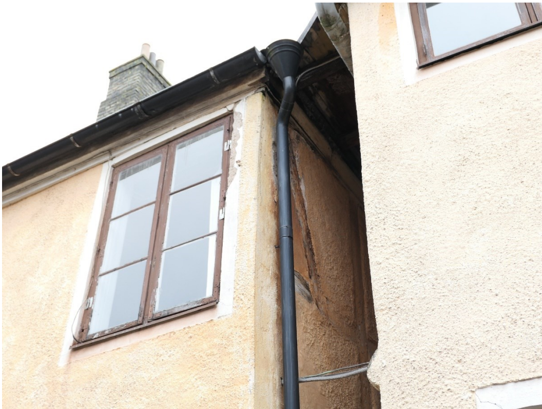
Före åtgärder. Sydvästra hörnet med synligt korsvirke i gaveln.
