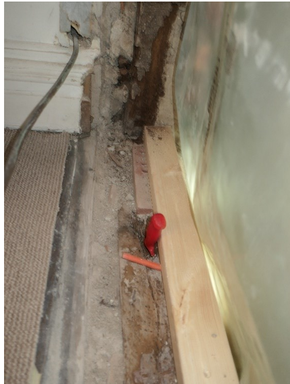
Under arbete. Rötskadad hörnstolpe invändigt, i sydvästra hörnet på ovanvåningen. Invändigt ytskikt är nedtaget på innerväggen mot söder.
