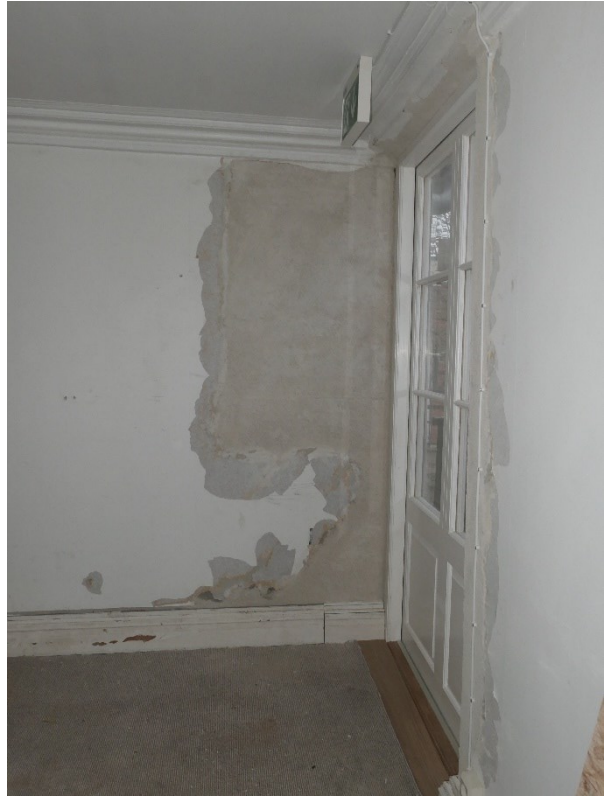
Fönster mot innergården där en ny båge med brandklassat glas monterats. Höger: nya branddörren invändigt. putsad innervägg, återmonterad golvlister, ny brandskylt. Återstod vid fotograferingstillfället att måla väggen med diffusionsöppen vit färg.
