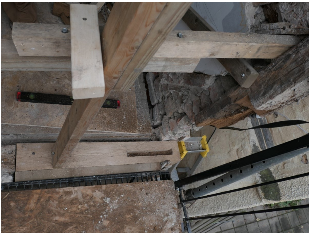
Lagning av västra murremman. Foto taget uppifrån ner mot murremman. Se ytterligare fotografier i bilaga.
