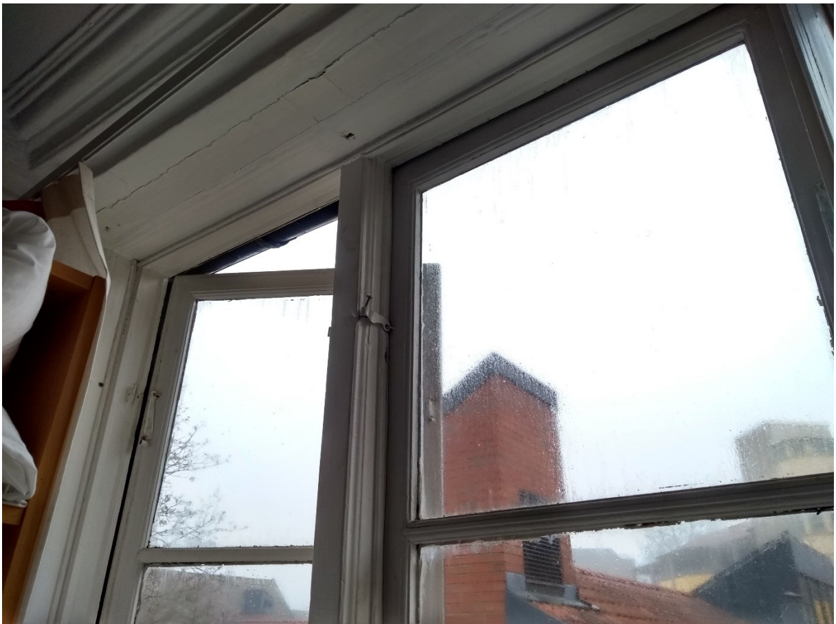
Före åtgärder. Plan 2, fönster som ersatts med ny utrymningsdörr.
