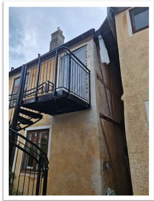
Färdigputsad fasad, juni 2024
