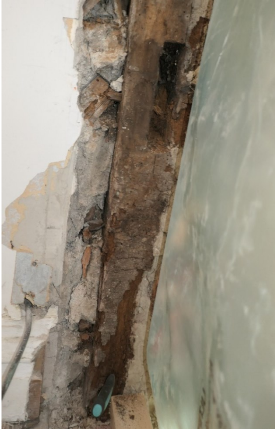
Under arbete. Rötskadad hörnstolpe invändigt, i sydvästra hörnet på ovanvåningen. Invändigt ytskikt är nedtaget på innerväggen mot söder.
