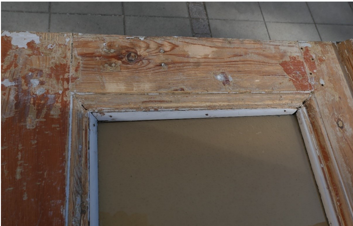
Dörrbladets insida där ådringsmålning skrapades bort. Dörren hade plexiglas före åtgärderna.
